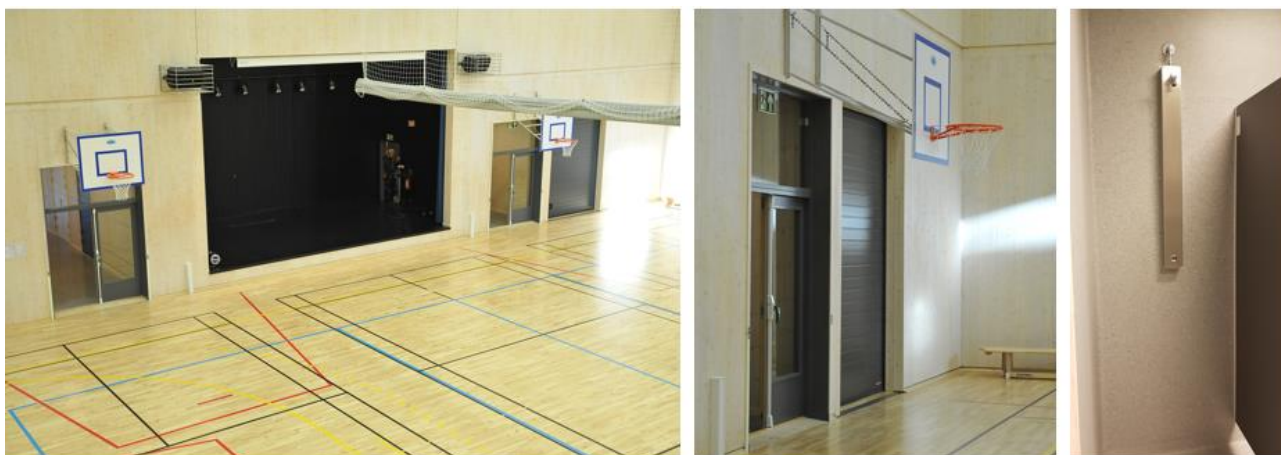
Bilder 39, fra venstre: Idrettshall med scene- Skillevegg med heve- og senkefunksjon. Utstyrslager med garasjeåpning. Til høyre: dusjrom med skjermvegg. Ulsmåg skole.
