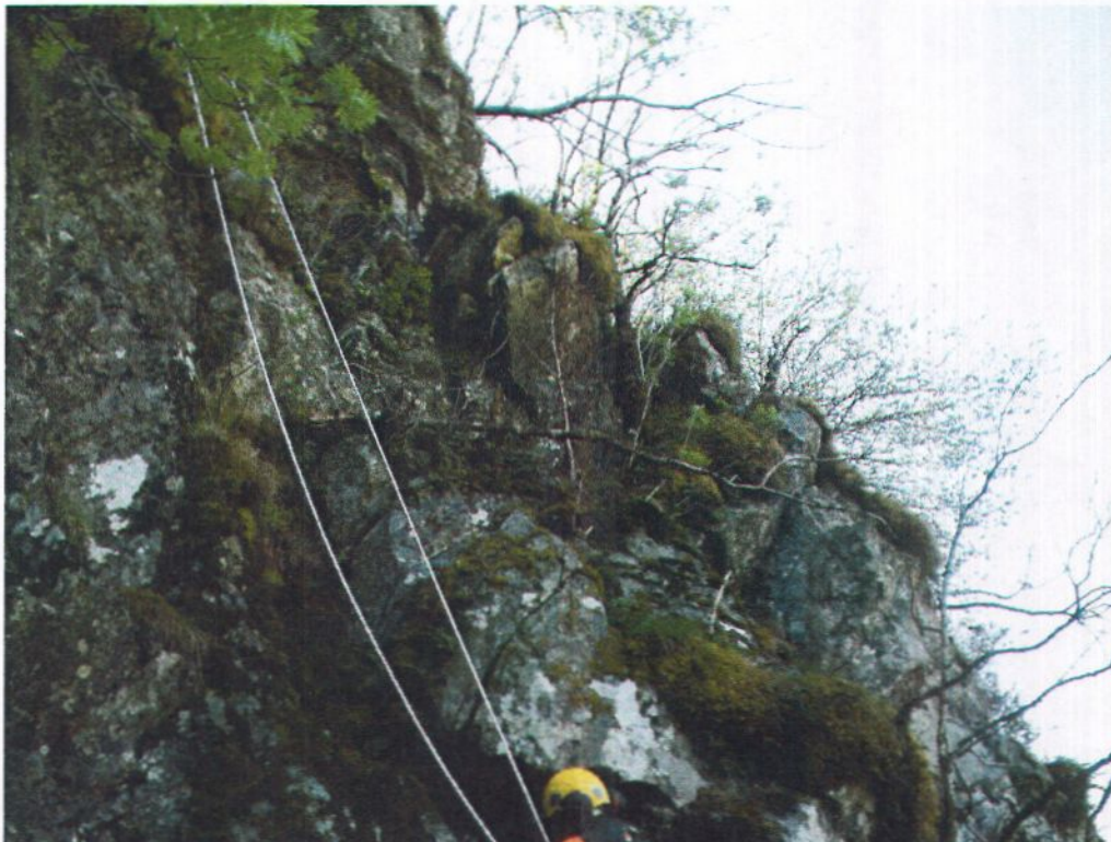
Bilde 3: Viser løse blokker i bergveggen.
