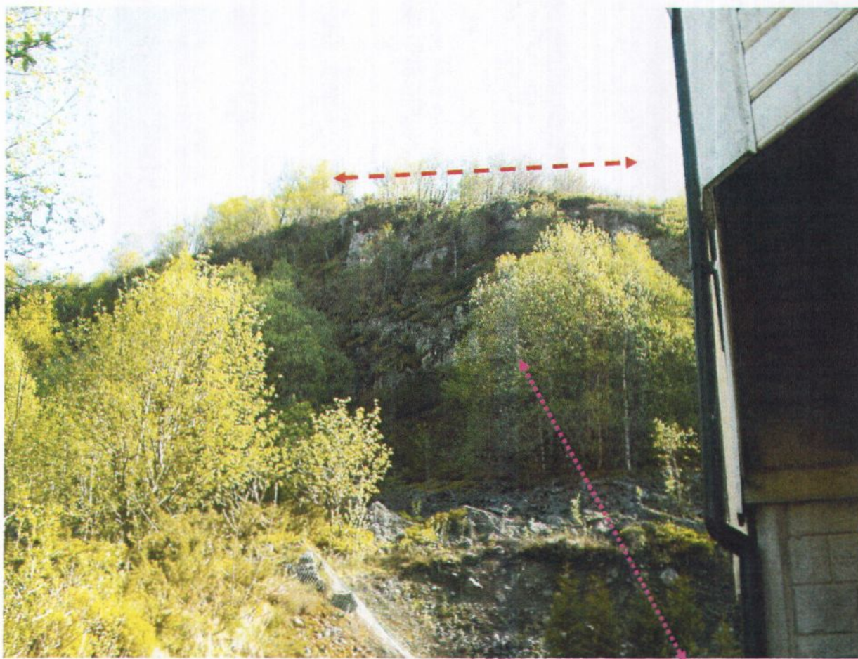
Bilde 1: Viser bergpartiet og ura. Det er gjort betydelige inngrep i foten av ura uten at løsmassene her i etterkant er blitt sikret. Bergpartiet hvor det er observert løse blokker er merket med rødstiplot linje, og profilet som framkommer på figurene 2 og 3 er markert med lilla prikkstiplot linje.
