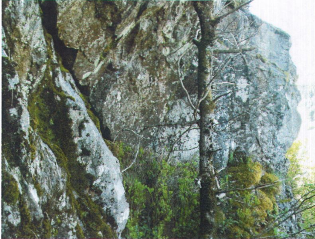
Bilde 4: Viser blokk i bergveggen som det er tegn til bevegelse i.
