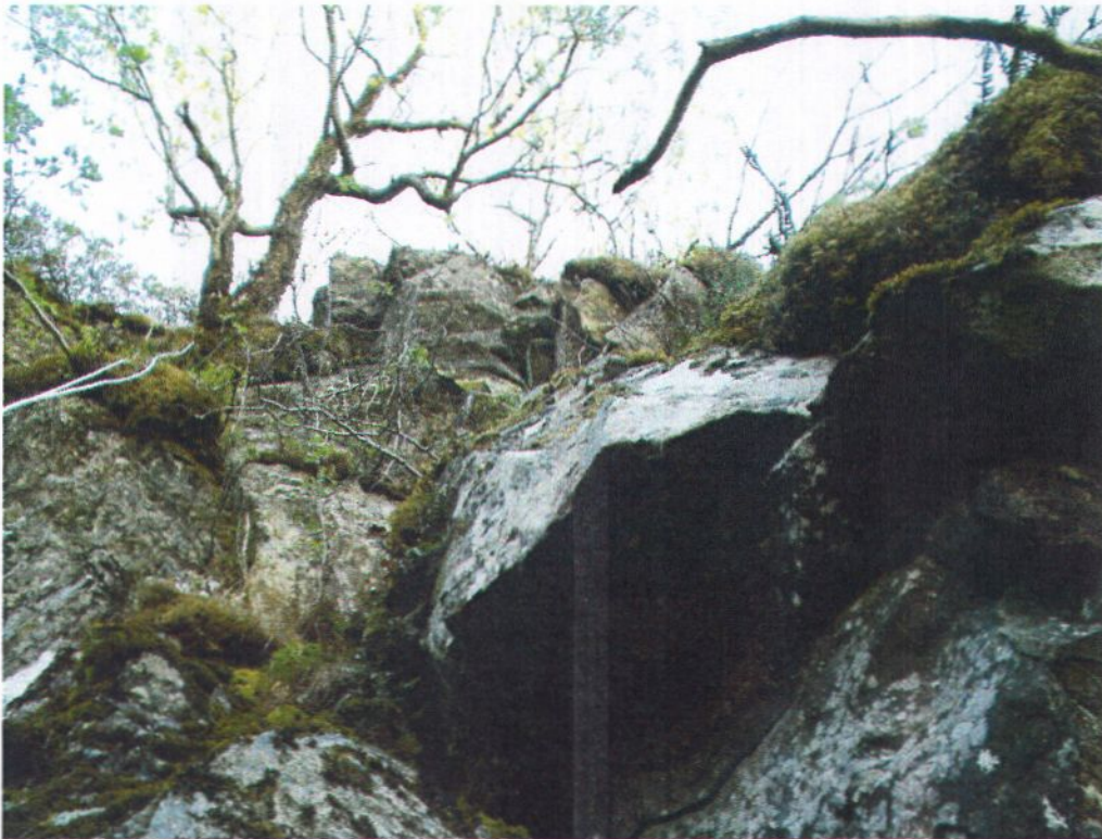
Bilde 5: Viser løse blokker i bergveggen.
