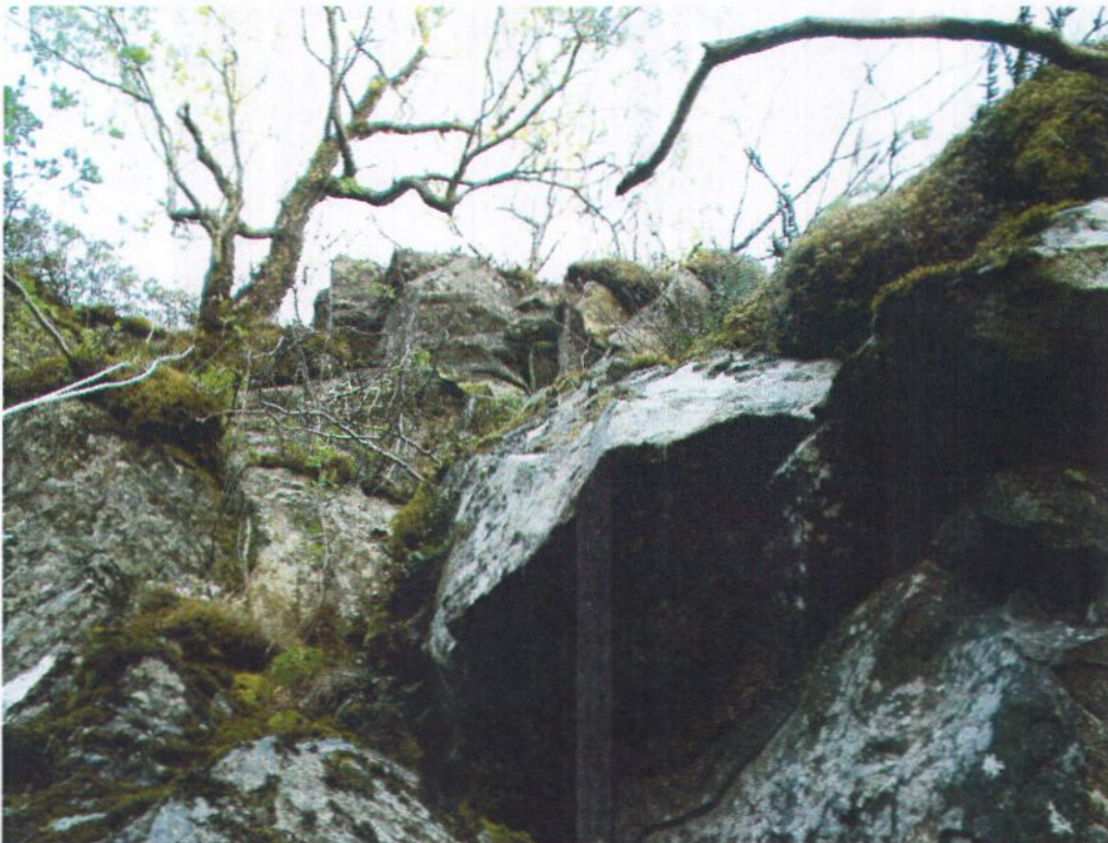
Bilde 5: Viser løse blokker i bergveggen.
