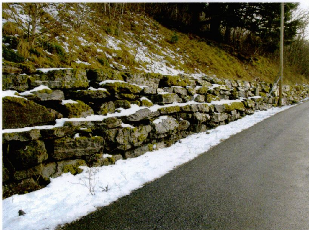
Bilde 4: Støttemur i skråning ned mot vegen i øvre del av Teigane.
