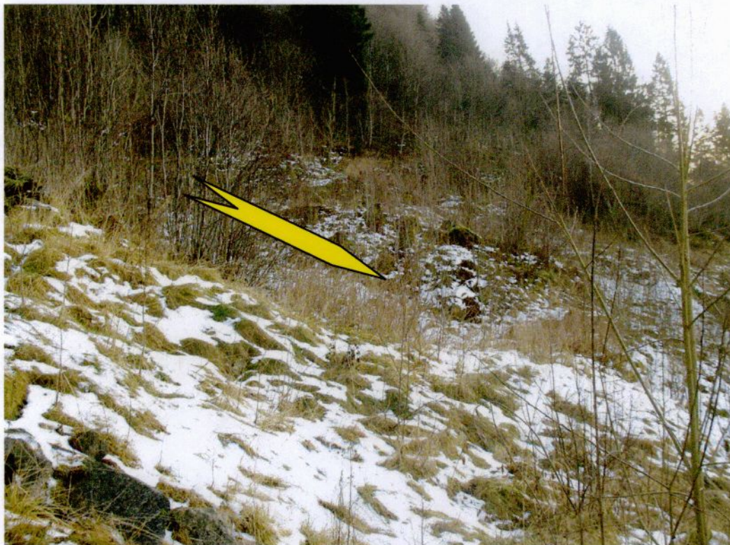
Bilde 2: Tatt mot sør. Terrenget ovenfor samme husrekke. Forsenkninger i terrenget (pil) danner dreneringsløp for overflatevann og vann i urmasser.
