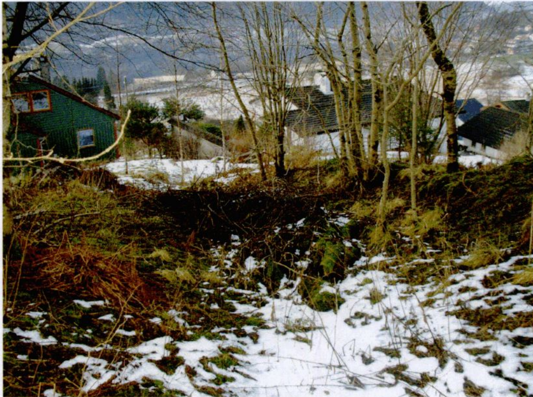
Bilde 6: Tatt fra øvre del av Teiganevegen. Teigane 25 og 27 fra venstre. Lite søkk i terrenget ned mot husene kan fungere som flomløp dersom det renner mye overvann i selve veien.
