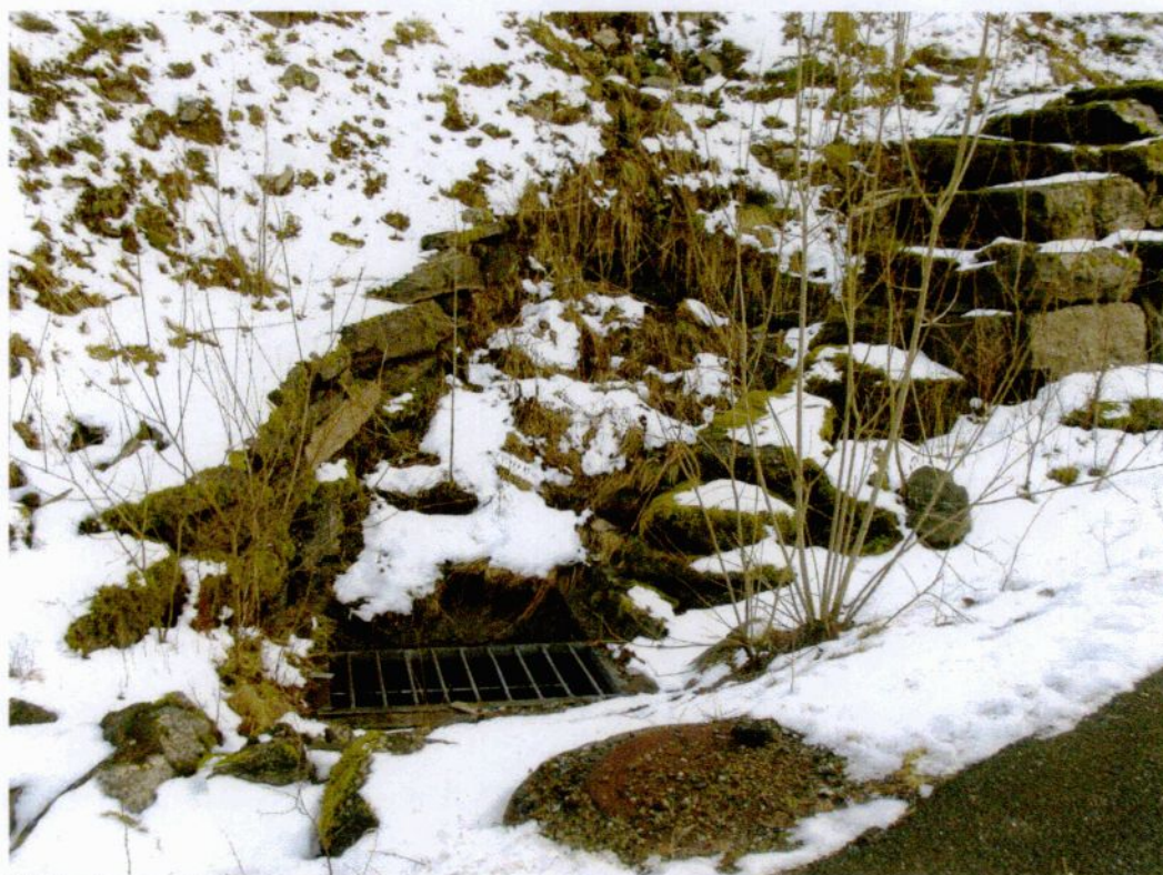
Bilde 5: Vanninntak ved enden av støttemuren. Liten bekk i terreng samt sannsynligvis dreneringsvann bak mur.
