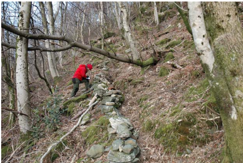
Foto: Dreneringskanal over Øvre Kolstien 28
