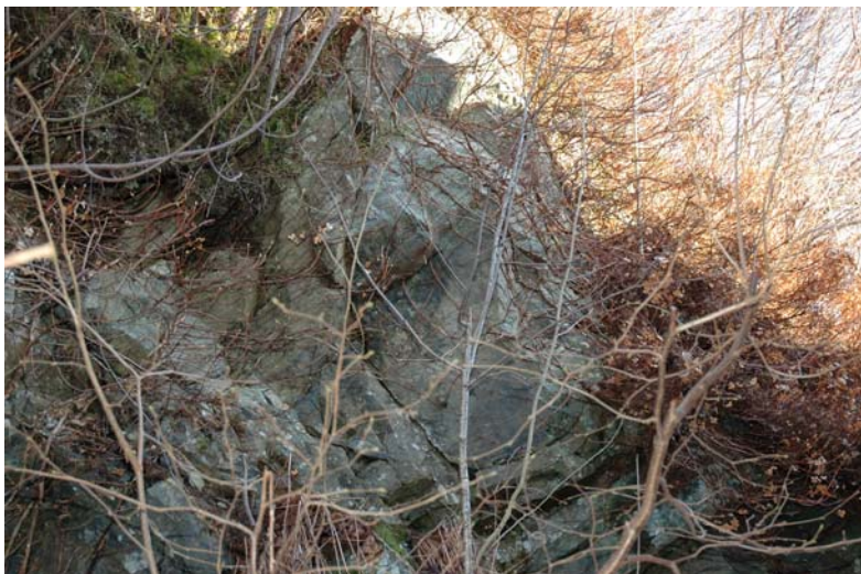
Foto: Oppsprukket fjell bak Vestre Fantoftåsen 5
