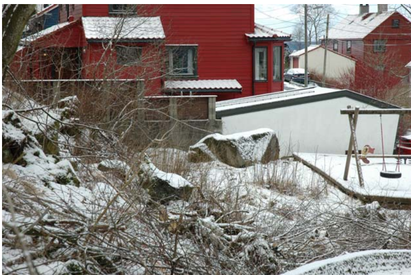
Foto: Skråningen mellom Kolstien 77 og 73. Blokk helt ned mot lekepass ved nr 73.
