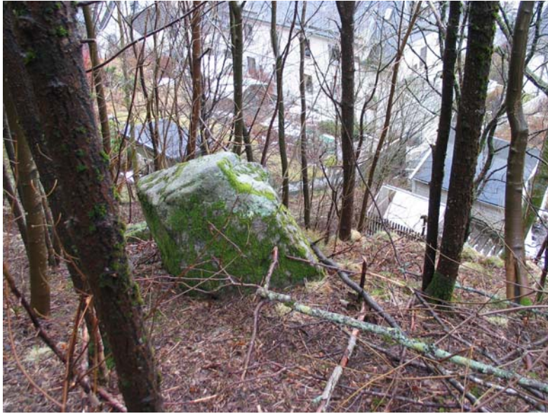
Foto: Nordre Skansemyren. Steinsprangblokk i lia ovenfor boligene.
