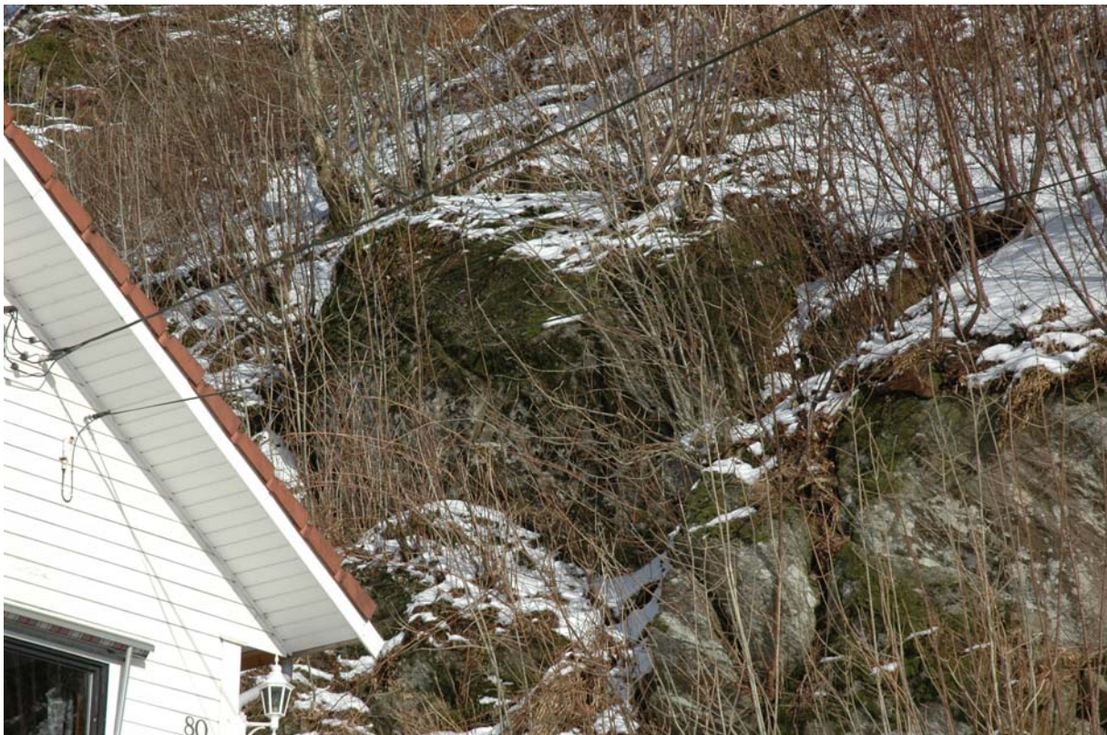
Foto: Skråningen bak Sædalsveien 80.
