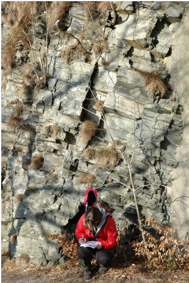
Foto: Sprekker i fjell ved Vognstølen.
