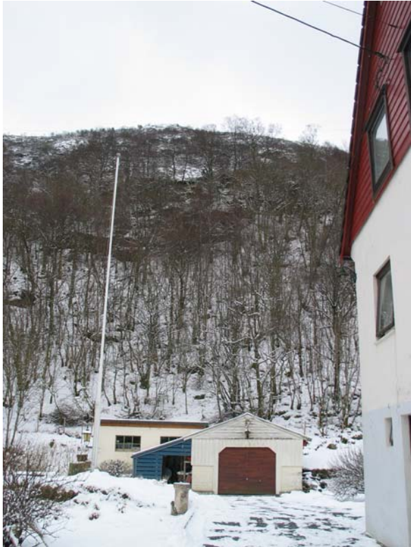
Foto: Arnatveitvegen 45. Steinsprangblokk ligger helt ned til de øverste bygningene.
