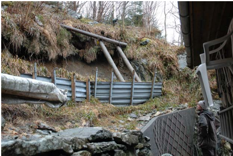
Foto: Jordskråningen med sikring ved Kistebakkane 6.
