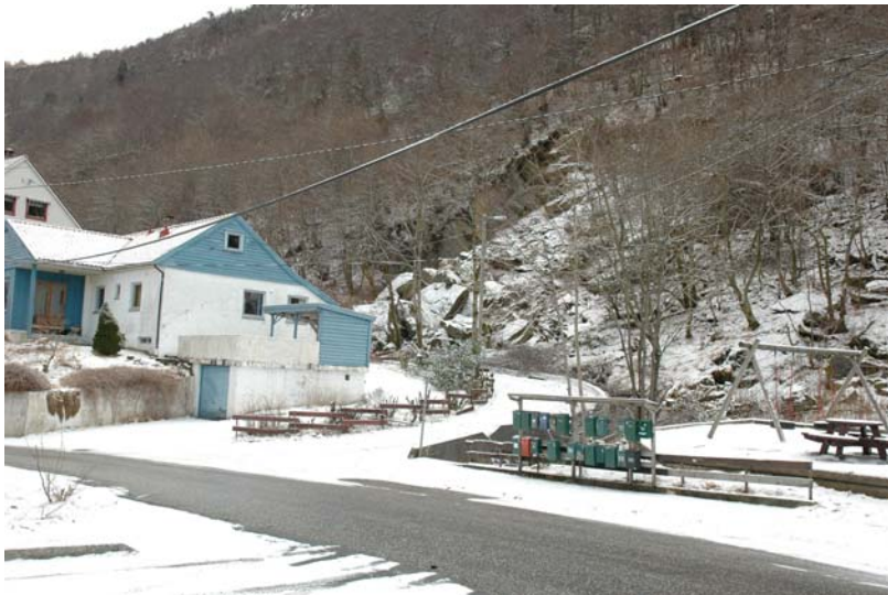
Foto: Skredet fra 1998 bak Kolstien 77.
