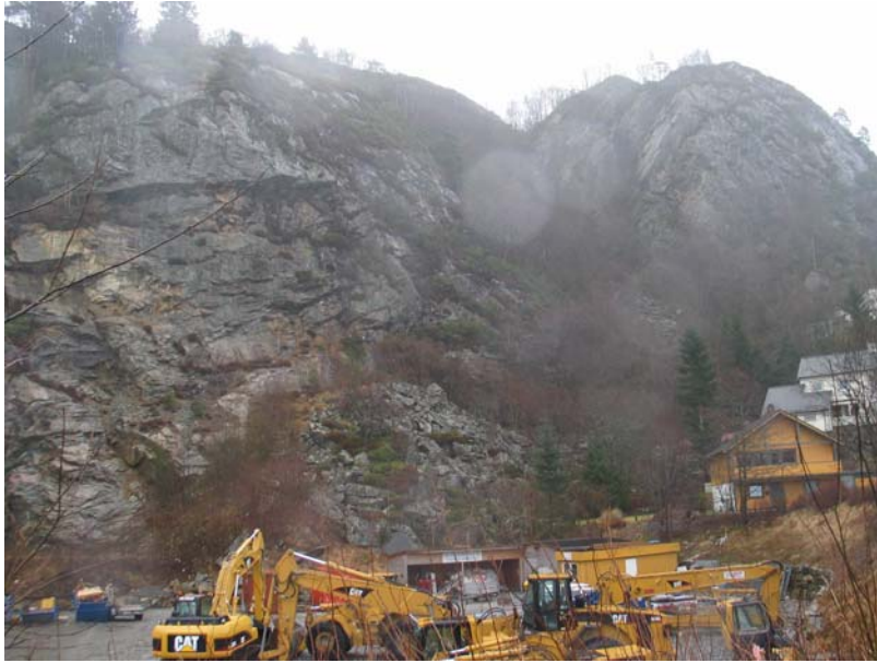
Foto: Næringsområde i Storbotn. Skredmateriale ved foten av skrentene.
