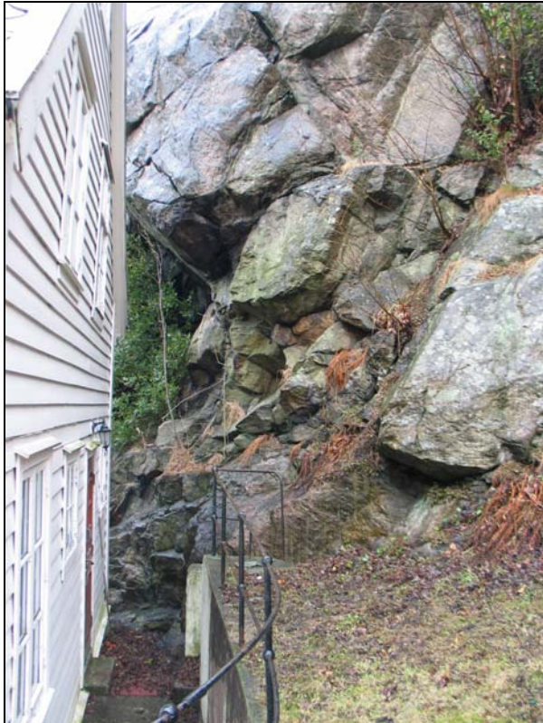
Foto: Fjellveggen bak Sandviksveien 205 er oppsprukket og blokkfall må forventes. Foto BAF.
