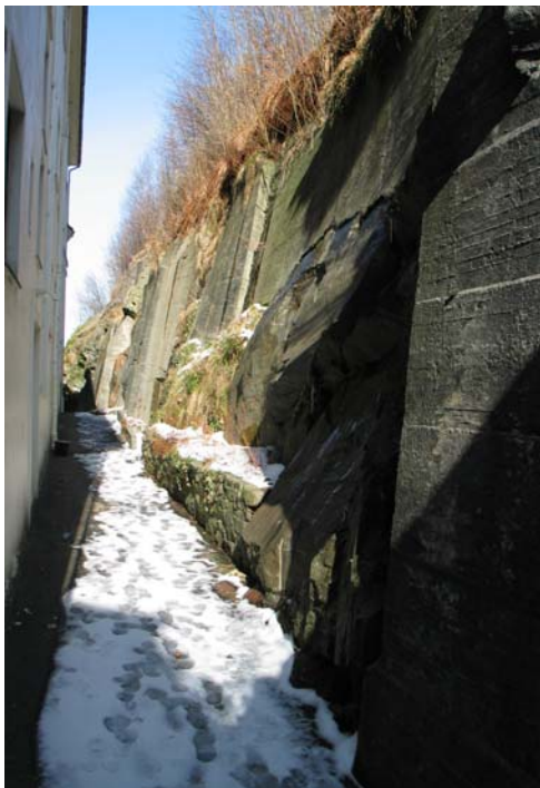
Foto: Sikringsarbeider er utført langs fjellsidene bak Skanselien 34-22. Foto BaF.
