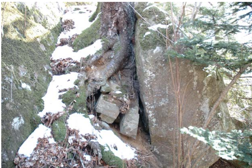
Foto: Løs blokk over parkeringsplassen til Natlandslia 11.
