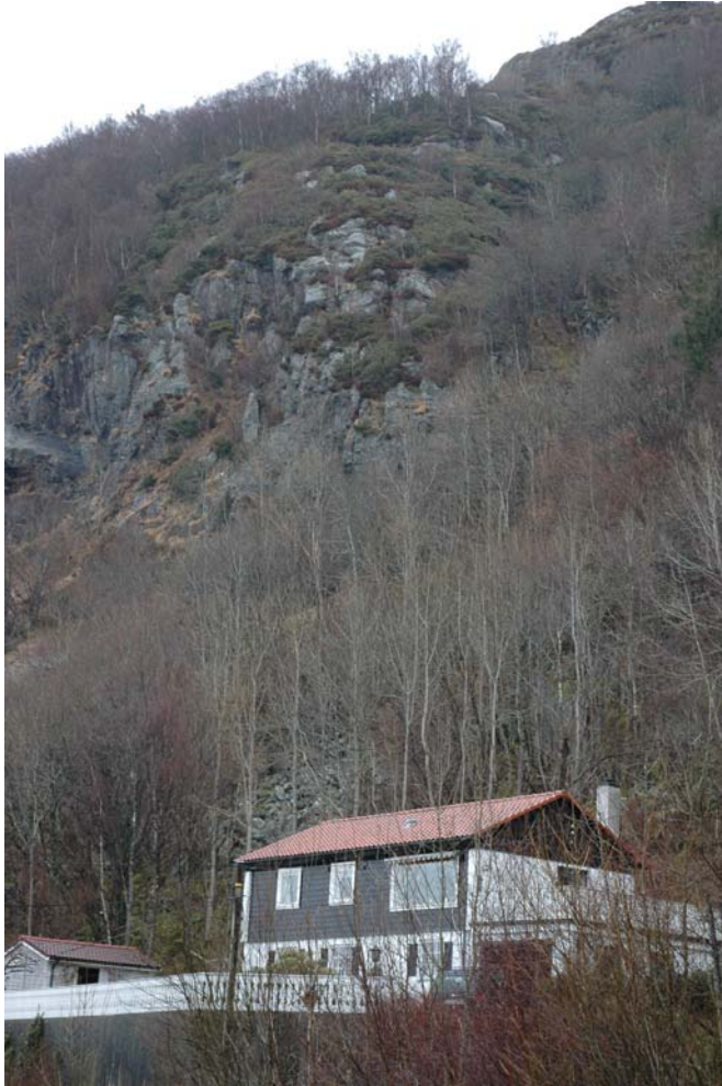
Foto: Nordgårdsleitet 61 med bratt fjellskrent og steinsprangvifte bak.
