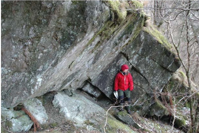
Foto: Oppsprukket fjellframspring et stykke oppe i lia over terrassehus 40-54.
