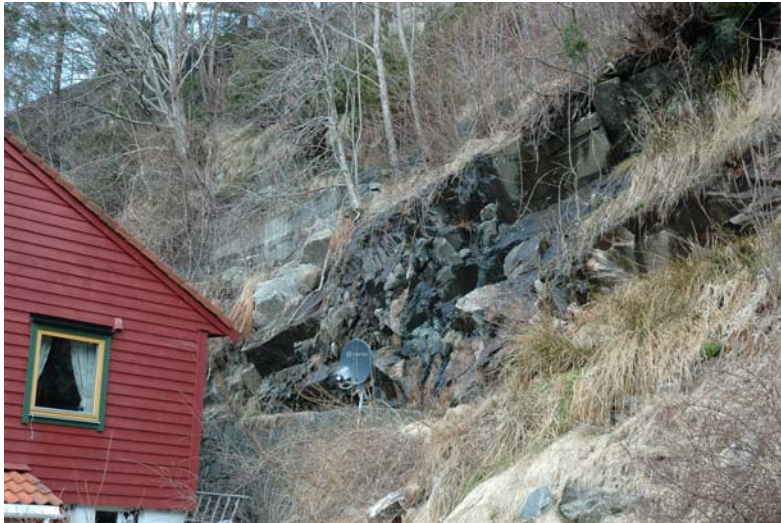
Foto: Oppsprukket fjell ved Kolbudalen 23 og 25.
