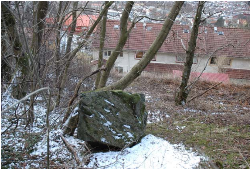
Foto: Steinsprangblokk over rekkehuset Øvre Sollien 73-83.
