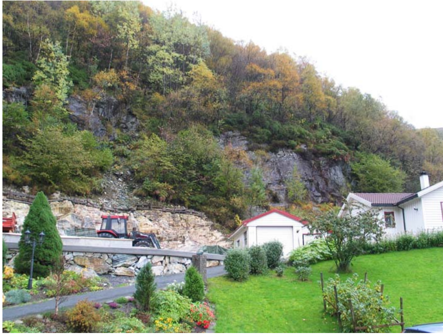
Foto: Skrent brattere enn 45° bak Gullfjellveien 217.
