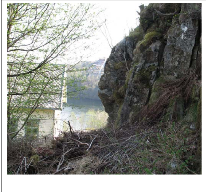
Foto: Fjellskråning med heng og oppsprukket fjell ved Steinsvikveien 125.
