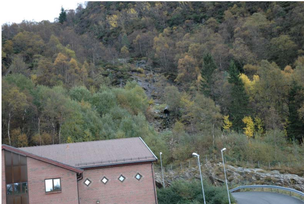
Foto: Sædalen vannbehandlingsanlegg, Sædalsvingene 99.
