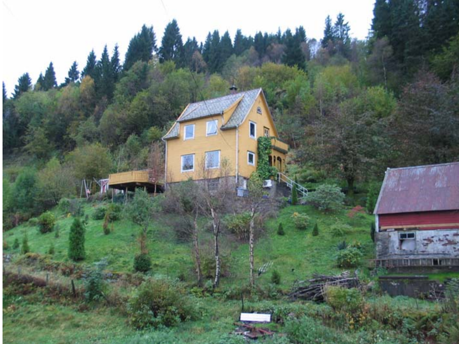
Foto: Kalihaugen 50 med skråningen bak.
