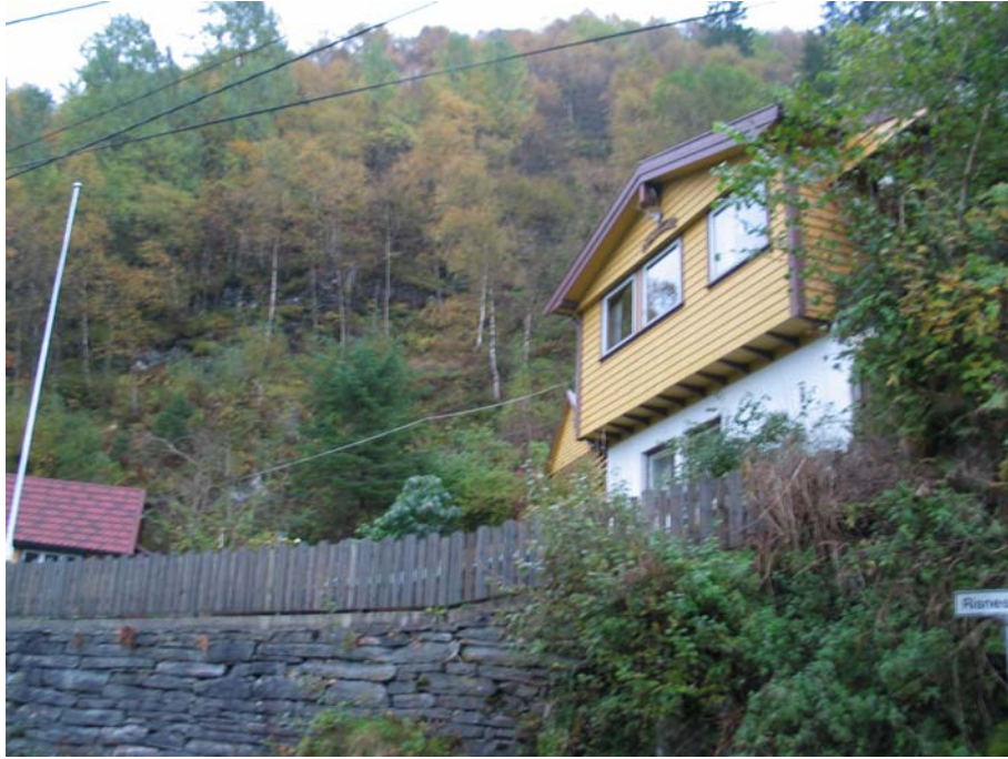
Foto: Risnesveien 51 med skråningen bak.
