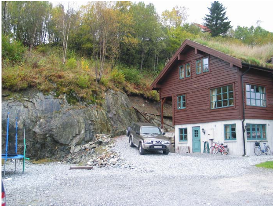
Foto: Løsmasseskråning bak Lonaleitet 147.
