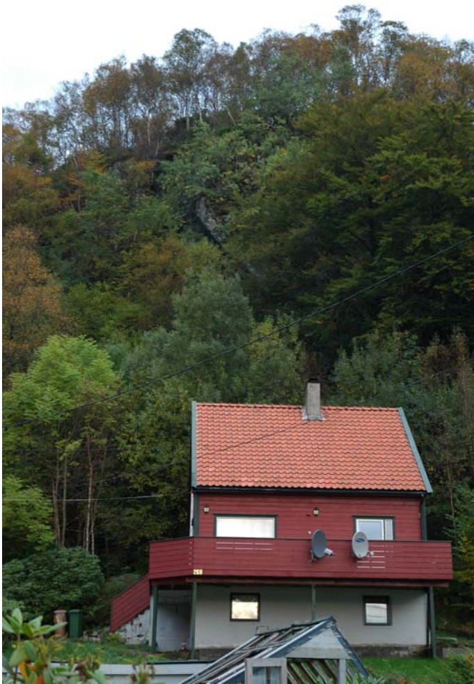
Foto: Hardangerveien 268 under bratt skrent.
