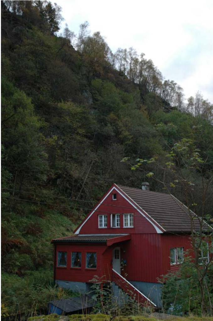
Foto: En mer enn 100 m høg skråning brattere enn 45° ved Erdalsveien 41.
