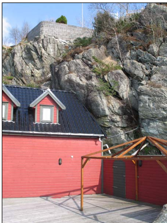
Foto: Oppsprukket fjellframsprang bak naust/fritidsbolig ved Kvituren 138.
