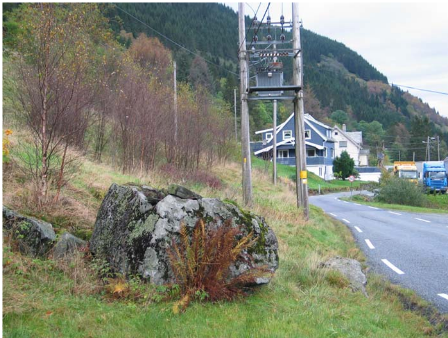
Foto: Steinsprangblokk ned mot veien ved Rødland. (Dalsiden fra nord).
