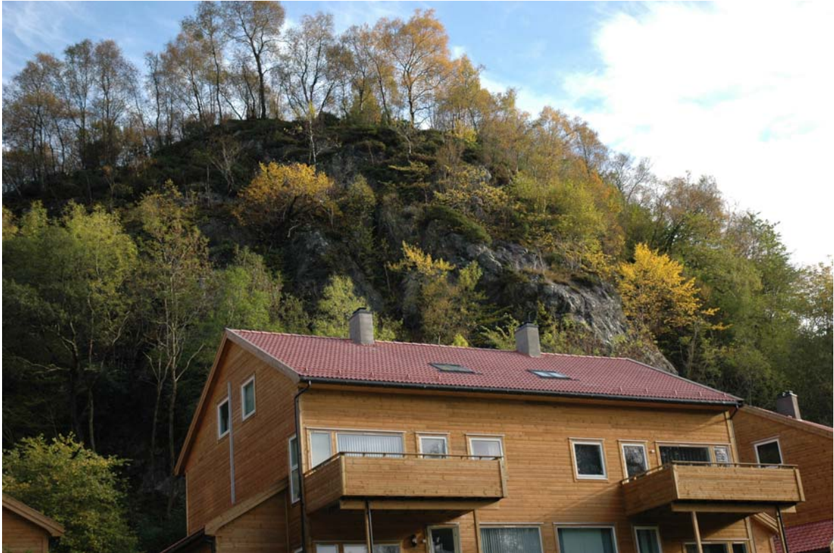
Foto: Skrent bak husene i Helldalsneset 30 og 22.
