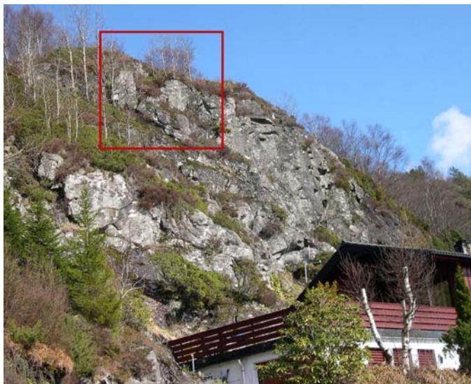
Foto: Nedberget 35, foto mot øst. Ramme viser de to omtalte blokkene.
