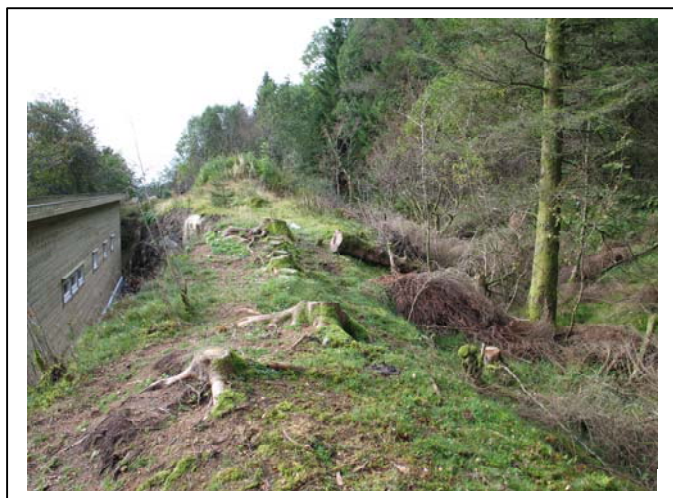
Foto: Nyoppført generasjonsbolig med en naturlig blokkfanger (skiferrygg) for steinsprang fra fjellskråning til høyre.
