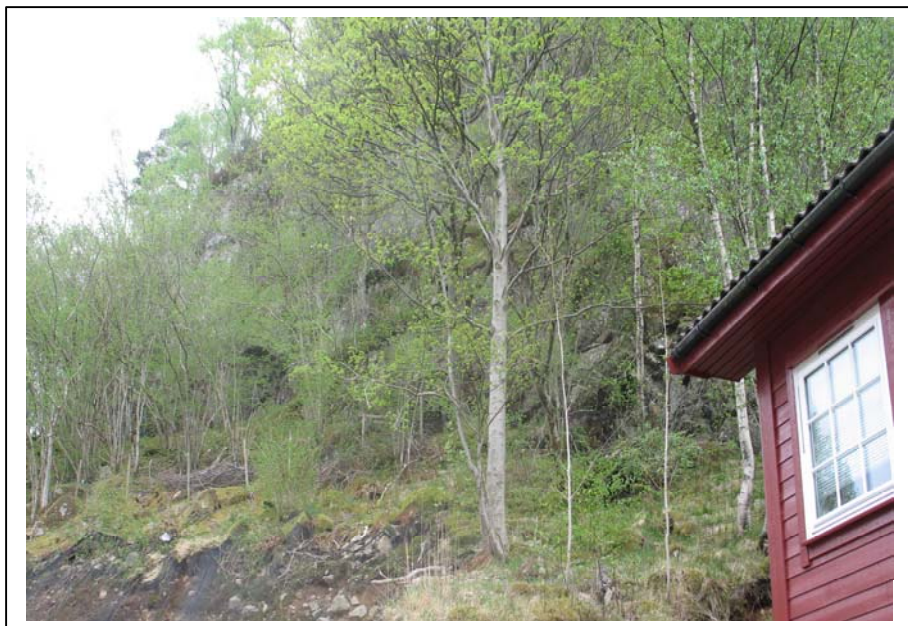
Foto: Skjæring bak Bergen sykehjem med morenemateriale og steinsprangblokker.
