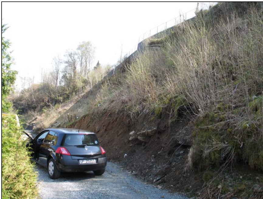
Foto: Skråning med løsmasser ved vei og hus (Ekerdalen 94).
