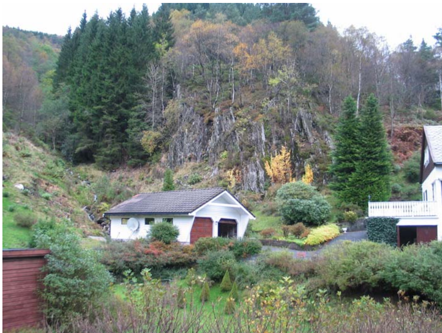
Foto: Hardangervegen 184 der bygningene ligger ved munningen av en kløft.
