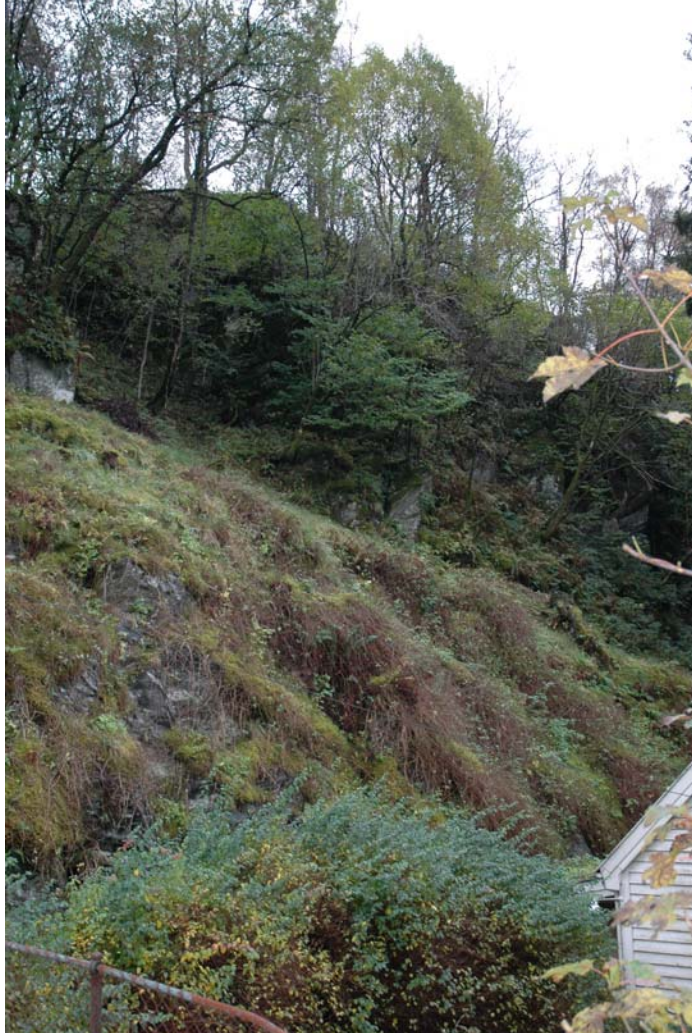
Foto: Bratt skråning bak Dyngelandsvegen 196.
