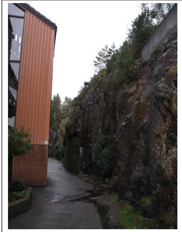
Foto: Tomten til J.L. Mowinckels vei 5-31 er delvis skutt ut i gneisgranittiske bergarter. Dette har gitt en steiltstående fjellside hvor sikringsarbeider er foretatt.
