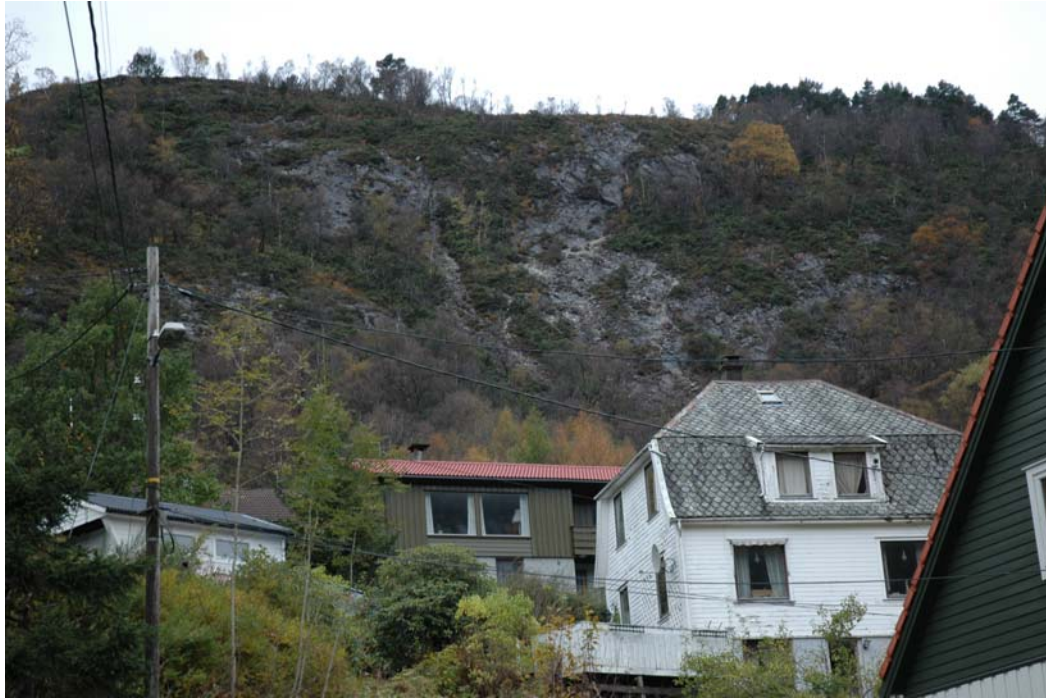
Foto: Husene ligger på østsiden av en ca. 100 m høy og bratt fjellside i Stephansens veg.
