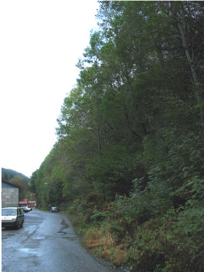
Foto: Skråningen over bilforretningene i Helldalshaugen 12.
