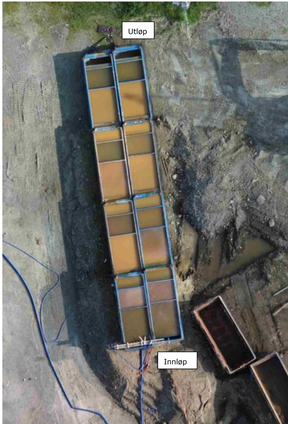
Figur 3: Dronefoto av sedimentasjonsanlegg.
