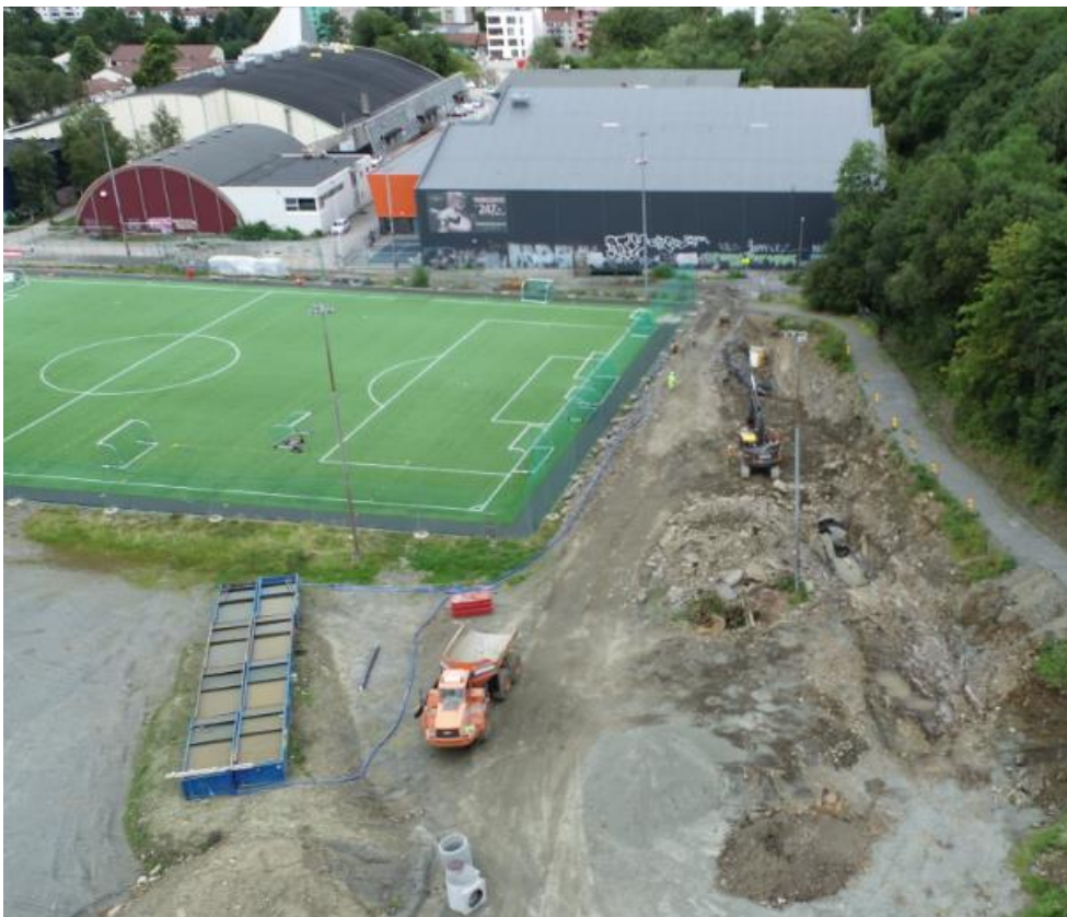
Figur 3 Anleggsområdet på Slettebakken. Grøftene som ble fylt med vann ligger til høyre for kunstgressbanen. Sedimentasjonsanlegget ligger nede til venstre i bilde.
