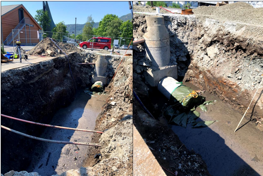
Figur 2 Grøften med vann etter at røret var tettet med ballong og presenning.
