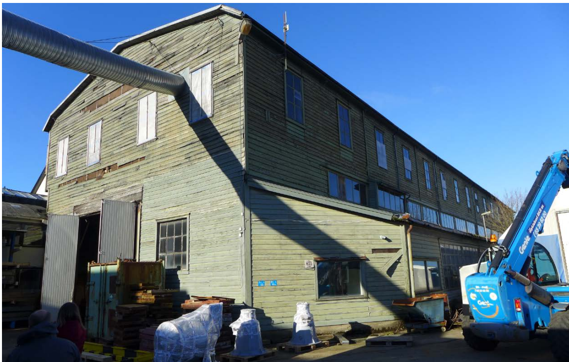
Figur 27. Maskinverkstedet som er en av de eldste bygningene i verftsområdet, har høy verneverdi (Foto: Byantikvaren 2017).
