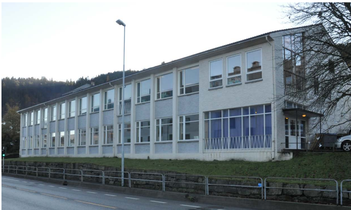
Figur 78. Hovedfasaden til 1959-anlegget mot Kringsjøveien, bygg 2A. Karakteristisk fasade med vinduer i rastergrid og brystning i tegl, typisk for skolearkitekturen rundt 1960-tallet. Tidsriktig rekkverk i metall med trekant (Foto: Byantikvaren 2017).
