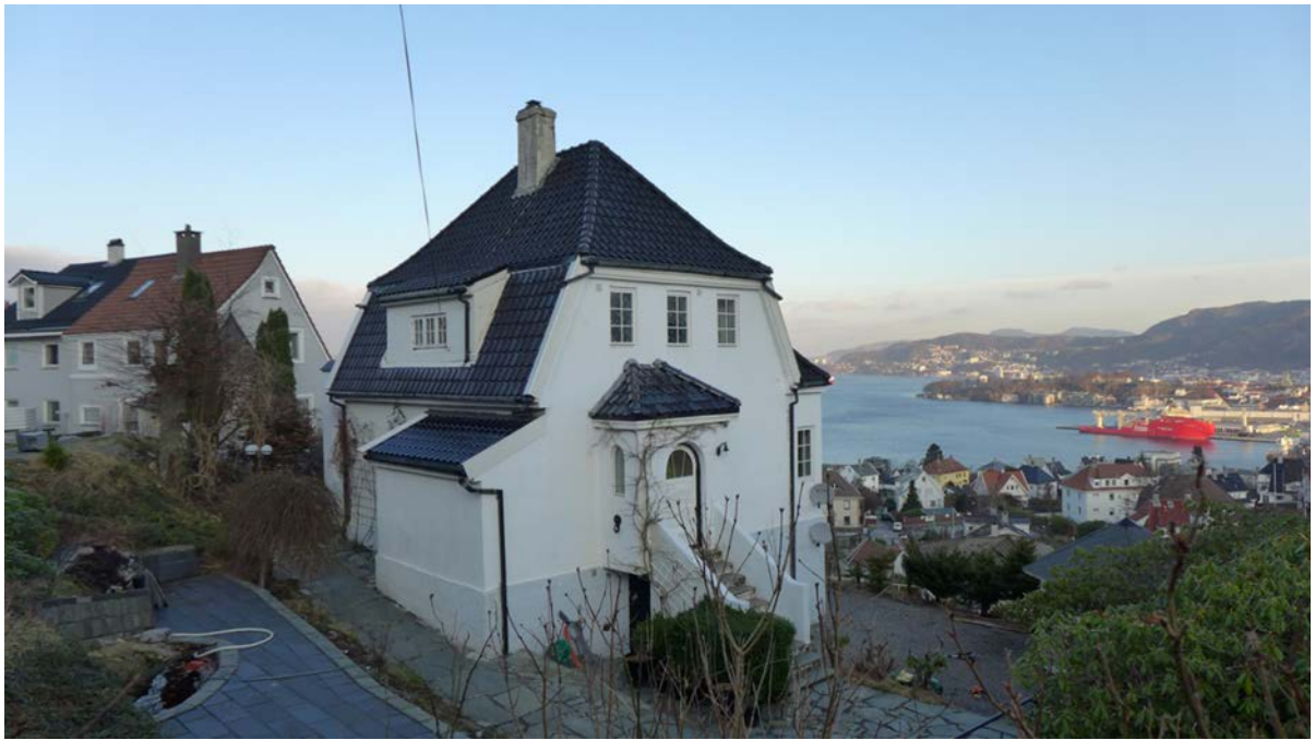
Figur 50. Arkitekt ikke oppgitt i kommunens byggesaksregister. Kaptein Amlandsvei 18 (Foto: Byantikvaren 2017).
