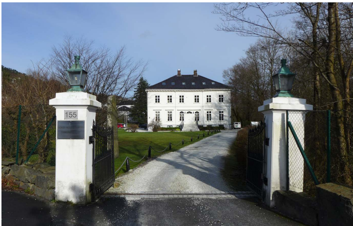
Figur 17. Kommandantboligen i Gravdal har svært høy verneverdi men har ikke fredningsstatus etter Kulturminneloven (Foto: Byantikvaren 2016).
