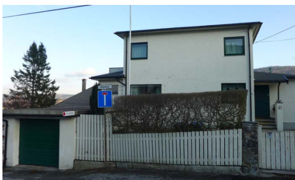
Figur 59. Solveien 10 tegnet for en fabrikkeier av arkitekt Ole Olsen i 1938 (Foto: Byantikvaren 2017).
