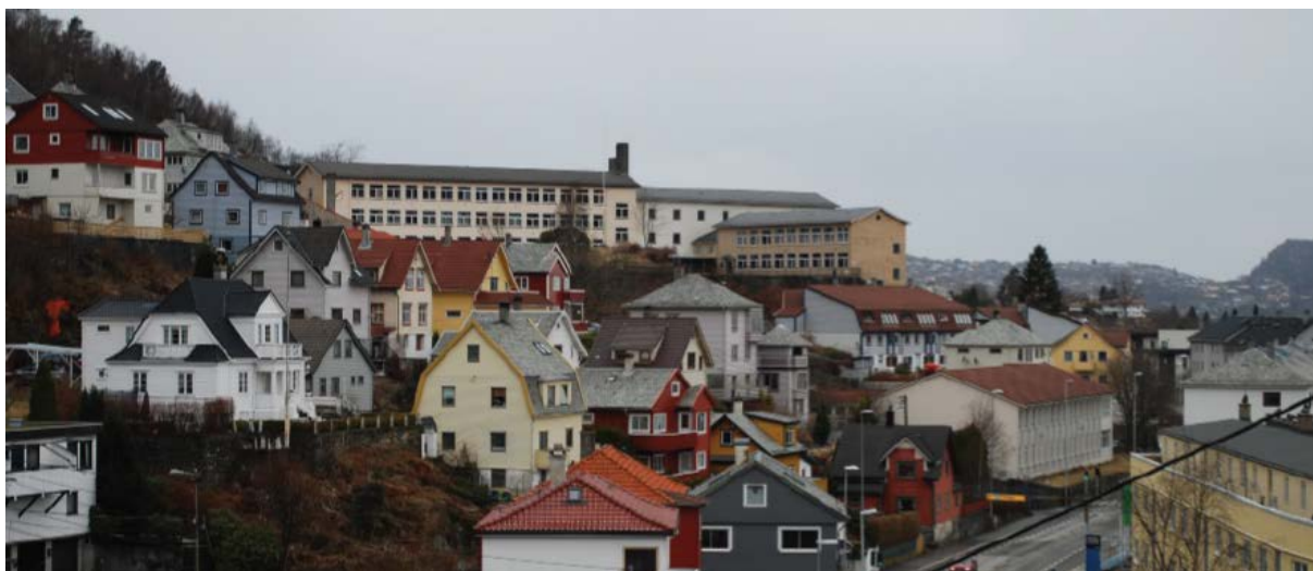
Figur 77. Holen skole sett fra øst. 1954-anlegget har en monumental beliggenhet på toppen av høydedraget. 1959-anlegget ligger nedenfor, med hovedfasaden mot Kringsjøåveien (Foto: Byantikvaren 2013).
