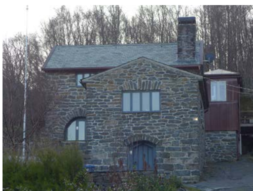
Figur 58. «Villa Steinstuen», Utsikten 20, tegnet av arkitekt Kristian Bjerknes i 1935. (Foto: Byantikvaren 2017).
