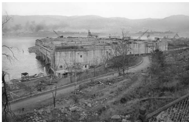
Figur 100. Samme perspektiv som forrige bilde. Ubåtbasen «Bruno» under oppføring (Foto: Nedrebø og Sedal 2012:).
