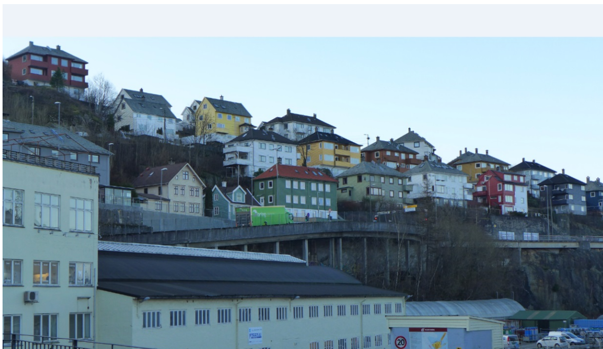
Figur 63. Arbeiderboliger ovenfor verftsområdet i Sørvestvågen (Foto: Byantikvaren 2017).
