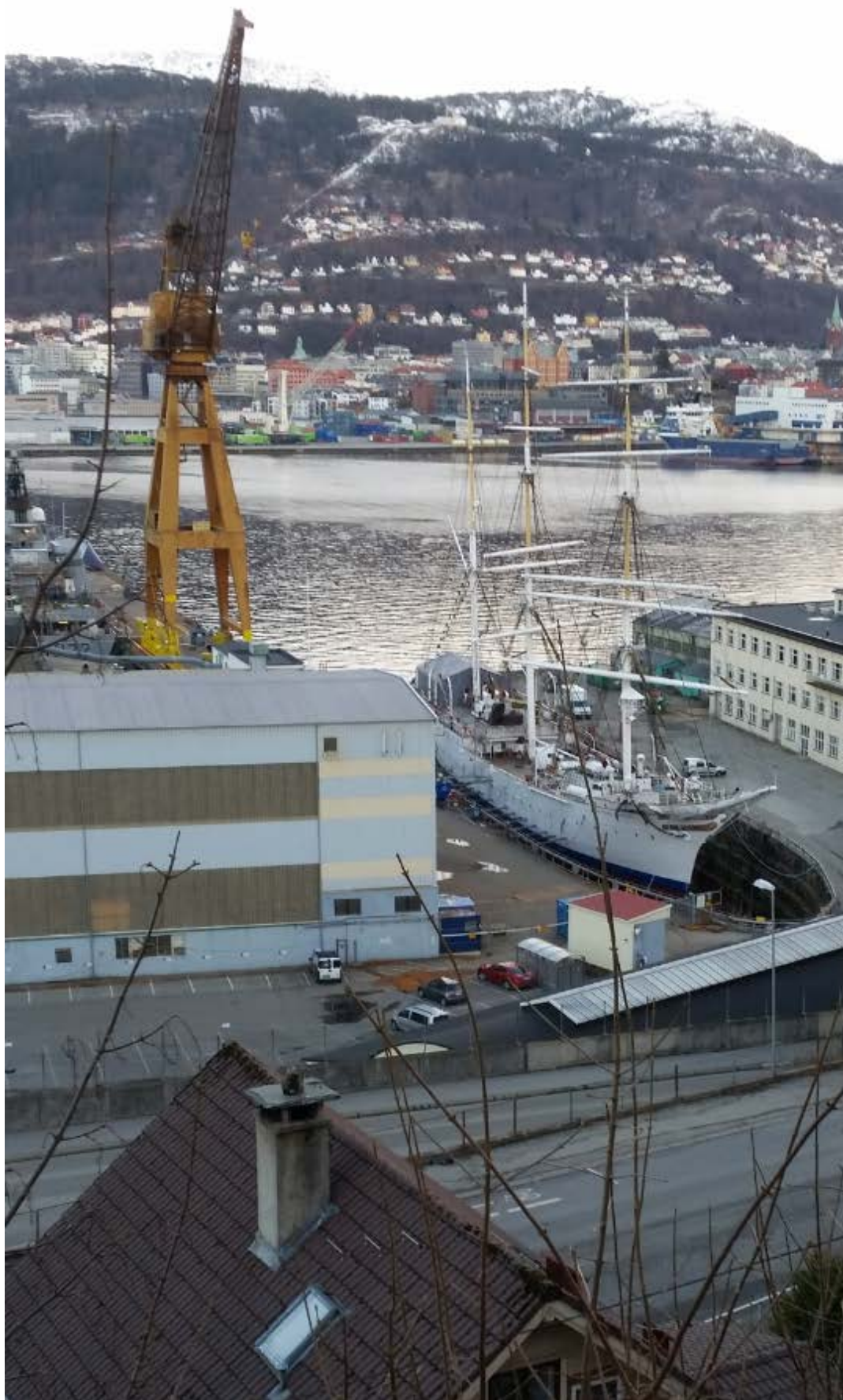
Figur 31. Portalkranen og tørrdokken har verneverdi både som enkeltobjekter og som deler av et helhetlig industrielt kulturmiljø. Dokken ble bygget i 1872 og utvidet i 1898 (Foto: Byantikvaren 2016).
