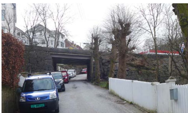
Figur 13. Kringsjåveien ble ført over den gamle alleen til Damsgård hovedgård via en viadukt (Foto: Byantikvaren 2017).
