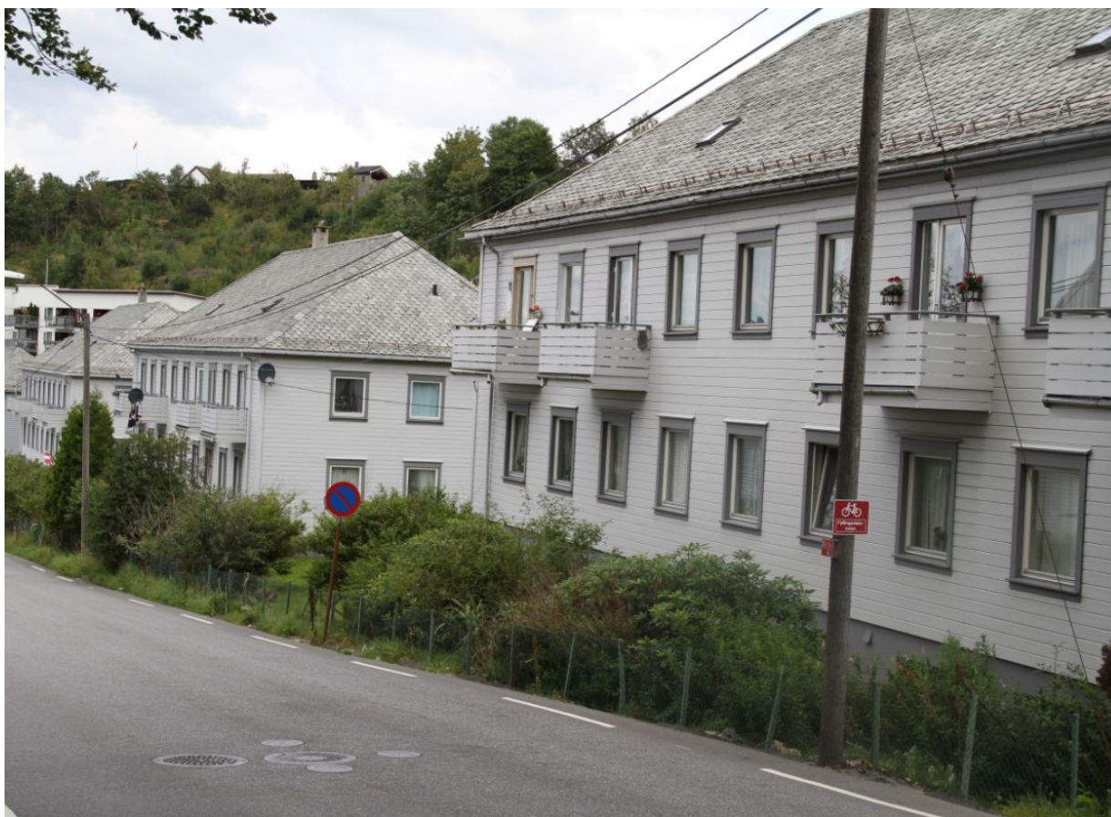
Figur 116. Bevarte mannskapsbrakker langs Fyllingsveien. Brakkene er i dag leilighetsbygg eiet av Bergen kommune (Foto: Byantikvaren 20016).
