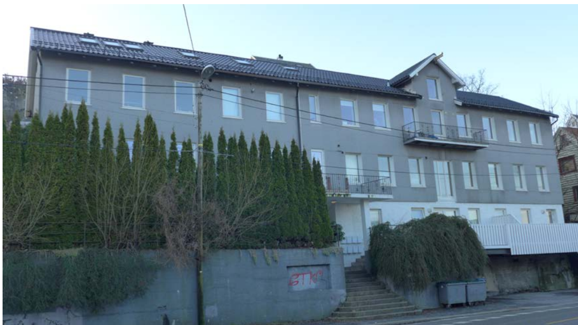
Figur 84. Laksevåg kino har vært en viktig kulturinstitusjon på Laksevåg. Kinoen ble innredet i 1923 i en tidligere møbelfabrikk (Foto: Byantikvaren 2016).
