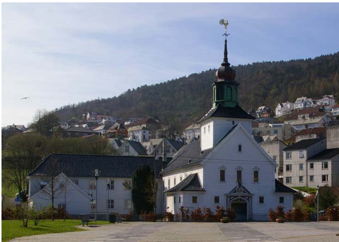
Figur 85. Laksevåg kirke stod ferdig 1875 og førte til at den strabasiøse kirkeferden til Strusshamn på Askøy endelig var over. Kirken ble bygget om med et menighetshus i mellomkrigstiden (Foto: Byantikvaren 2017).
