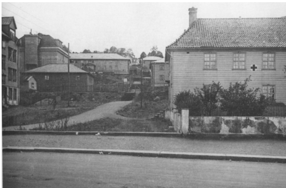
Figur 112. På Jansonmarken nedenfor Damsgård hovedgård bygget tyskerne en stor bunker og flere brakker. Laksevåg menighetshus til høyre i bildet (Kilde:Nedrebø og Sedal 2012).
