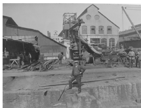
Figur 25. Kjele og tynnplateverkstedet i 1920-årene (Kilde: Marcus, UiB, ubb-kk-n-279-053). 28
