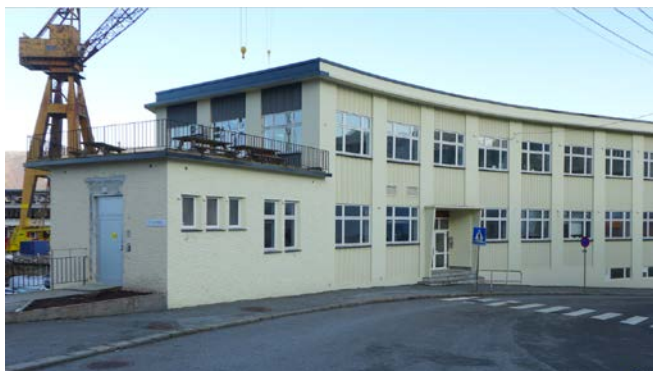
Figur 33. Personalbygningen følger gateløpet og danner sammen med administrasjonsbygningen på motsatt side av gaten, en monumental portal inn til verkstedsområdet (Foto: Byantikvaren 2016).
