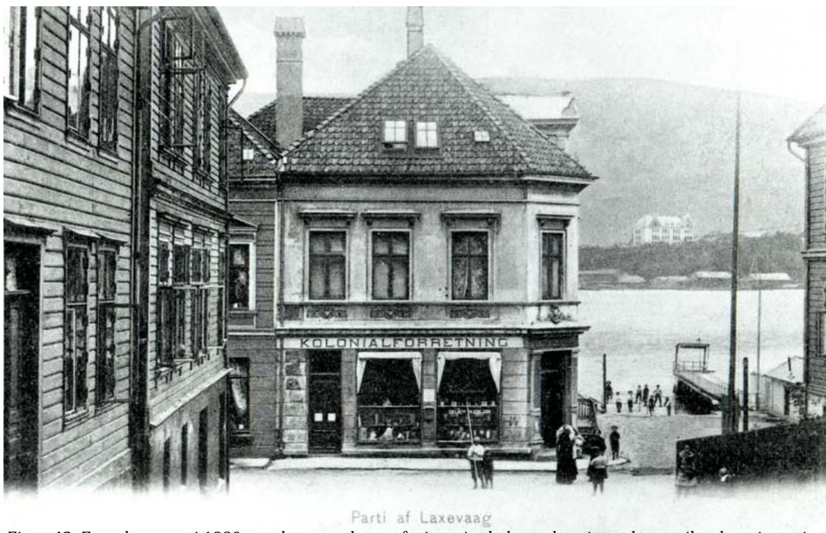
Figur 43. Etter brannen i 1889 var det et ønske om å gjenreise bebyggelsen i mer brannsikre bygninger i mur. Men kun ett murhus ble oppført, kjøpmann Larsens murgård i ny-renessanse, ved den nyetablerte Damsgårdalmenningen. Huset ble fra 1916 benyttet som rådhus for Laksevåg. Bygningen ble revet da nye Laksevåg rådhus ble oppført i slutten av 1950-årene (Kilde: http://www.touristphoto.no/glaksevaag1.htm ).
