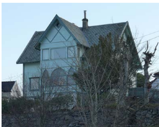
Figur 56. Stor sveitersvilla i Øvre Kaptein Amlandsvei 10. Arkitekt og byggeår er ikke kjent (Foto: Byantikvaren 2017).
