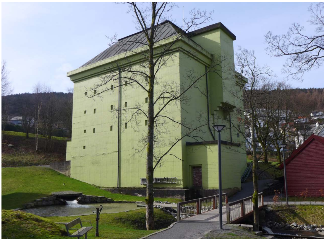
Figur 118. Bunkeren "Trappehuset" på Jansonmarken nedenfor Damsgård hovedgård er i dag en del av Laksevåg Lokalmuseum, drevet av Laksevåg Kulturhistoriske Forening (Foto: Byantikvaren 2017).
