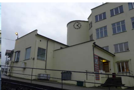
Figur 34. Administrasjonsbygningen er modernistisk arkitektur av høy kvalitet, med et stiluttrykk av sammensatte geometriske volumer (Foto: Byantikvaren 2016).
