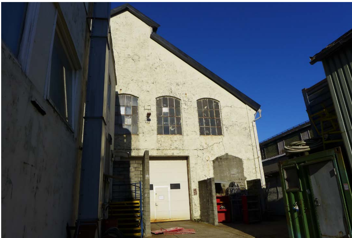
Figur 30. Sørgavlen til Kjele- og tynnplateverkstedet. På fasaden har det tidligere vært to sirkulære vinduer som nå er murt igjen. Bygningen representerer områdets eldste periode, og har høy historisk kildeverdi (Foto: Byantikvaren 2017).
