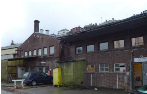
Figur 106. Verksteder langs sørevågen (Foto: Byantikvaren 2016).
