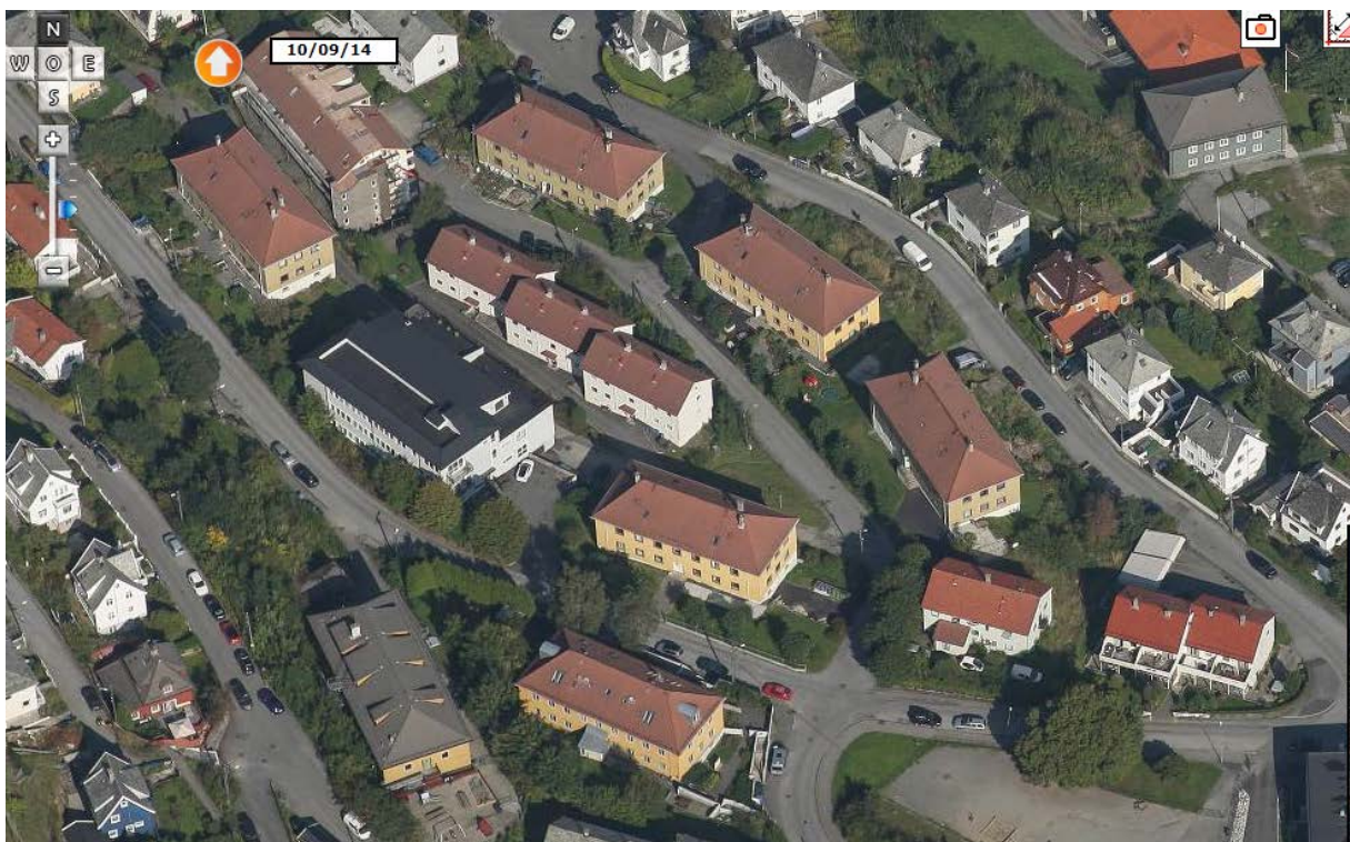
Figur 109. Sju mannskapsbrakker fra den tyske forlegningen i Stadionveien/Herman Gransvei er bevart og eies av Bergen kommune (Foto: Blom Urban Explorer).
