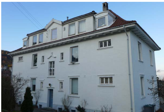
Figur 51. Flermannsbolig Voldene 7 tegnet av arkitekt Ole Halvorsen, 1927 (Foto: Byantikvaren 2017).
