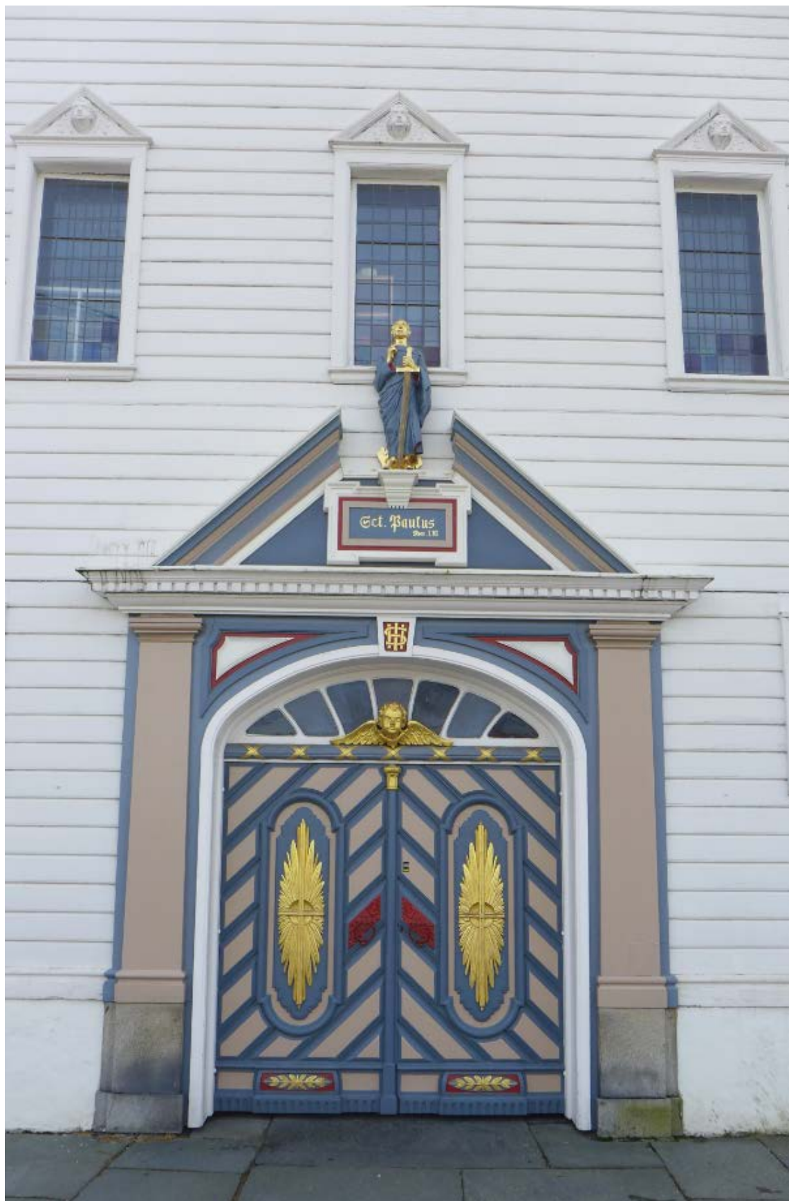
Figur 86. Laksevåg kirkes hovedinngangsdør er utformet som en ny-barokk portal med enkelte klassisistiske detaljer (Foto: Byantikvaren 2017).
