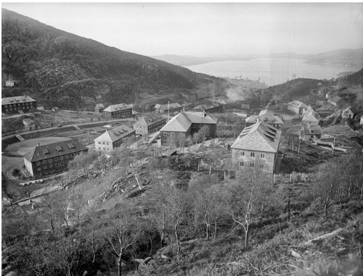
Figur 117. Forlegningen på Melkeplassen. Byggingen av forlegningsområdet ble trolig iverksatt parallelt med byggingen av ubåtverftet i Nordrevågen i 1941 (Kilde: http://www.touristphoto.no/glaksevaag1.htm ).
