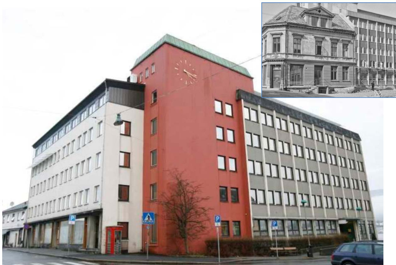
Figur 80. Laksevåg rådhus før ombygginger til leiligheter som nå pågår. Rådhuset ble oppført i flere etapper mellom 1958-61, og er en monumental sen-modernistisk bygning.
