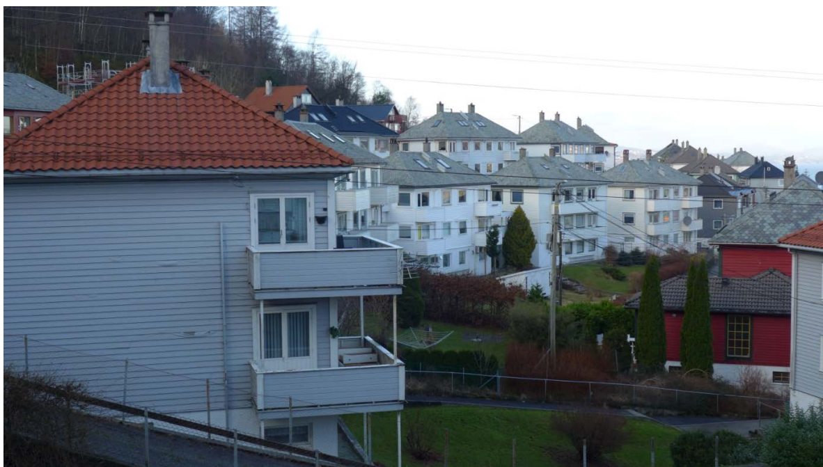
Figur 64. Arbeiderboliger oppført like etter krigen i Herman Grans vei. Arkitekt O. Halseth tegnet mange av arbeiderboligene i bygningsmiljøet (Foto: Byantikvaren 2016).
