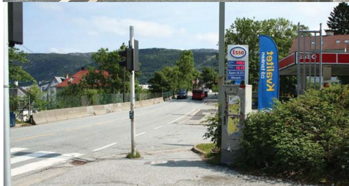
Elever som kommer fra Fyllingsveien og som skal krysse Kringsjøveien (31) ved fotgjengerovergangen ved Esso-stasjonen eller busstoppet rett overfor, må gå i veibanen på grunn av manglende fortau på sørsiden av Kringsjøveien.
