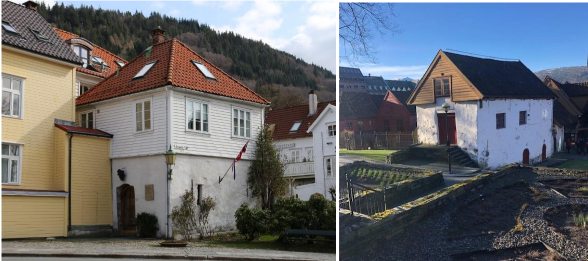
Figur 13. Steinkjelleren i Øvregaten 49 er trolig en svært gammel vinkjeller for Mariakirken. Til høyre en av steinkjellerne inne på Bryggen. Foto Byantikvaren 2019
