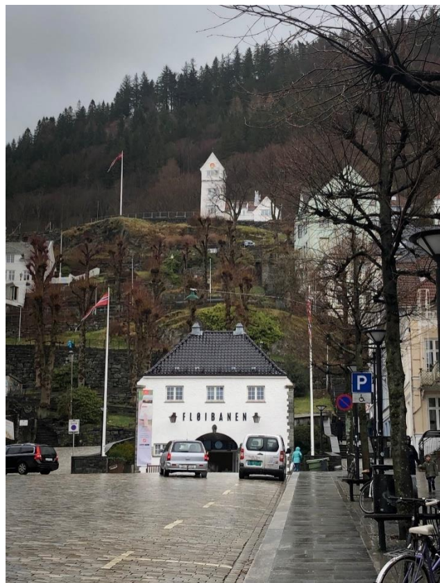
Figur 25. Nedre stasjon er et landemerke i Bergen sentrum. Foto Byantikvaren 2019.
