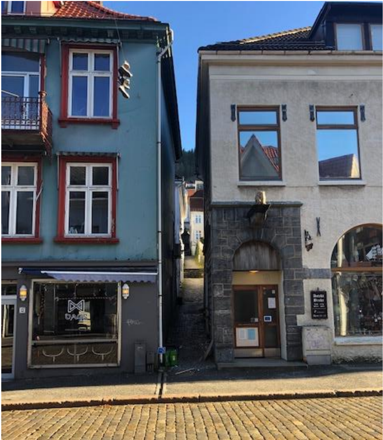
Figur 21. Øvregaten 11 og 13, begge forblendet mot gaten. Nr. 11 fikk denne fasaden i 1908 da første etasje ble innredet til Elefantapoteket. Elefanten kan fremdeles sees over det steinsatte inngangspartiet. Den staselige døren er skiftet ut og også vinduene er nyere. Foto Byantikvaren 2019.
