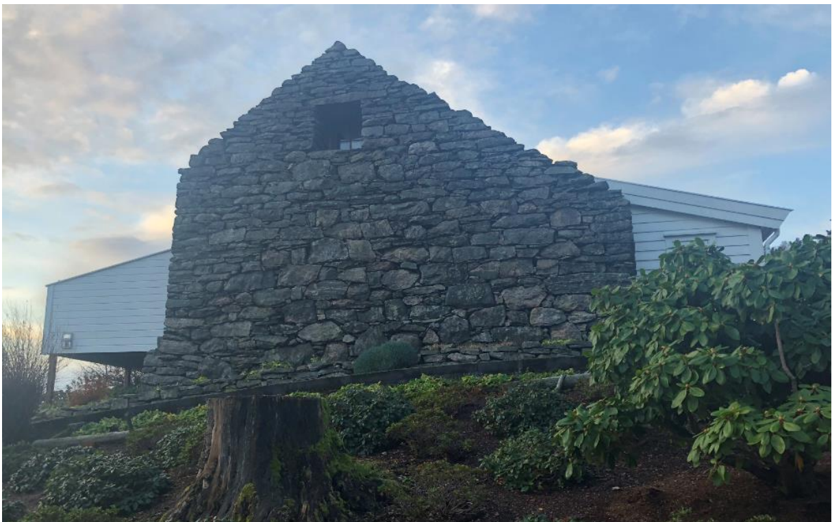
Figur 42. Det gamle våningshuset på gården Søre Øyjord, i Øyordsveien 34. Foto Byantikvaren 2018.
