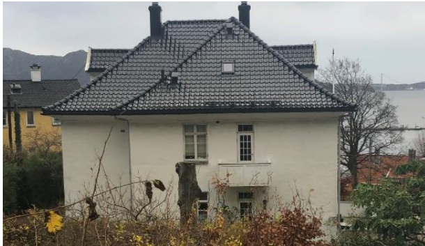
Figur 8. Sett fra øst. Foto Byantikvaren 2018
