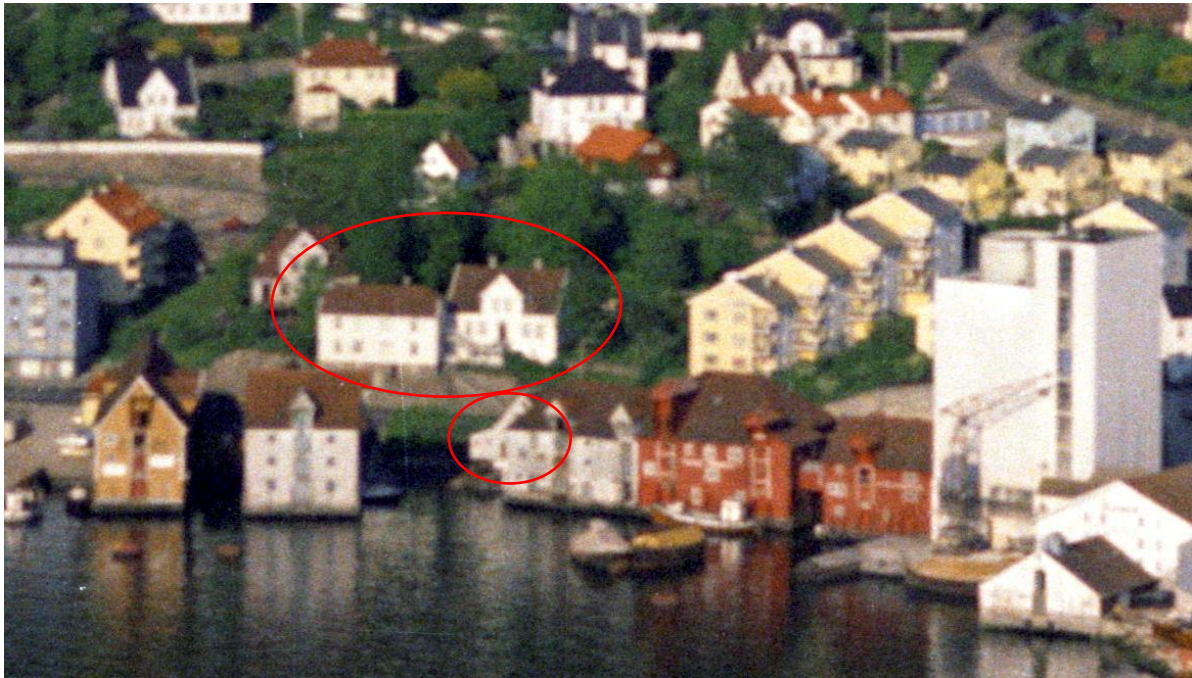
Figur 65. Skråfoto fra 1963 viser Møllesalen med tilhørende naust. UiB/Fjellanger Widerøe
