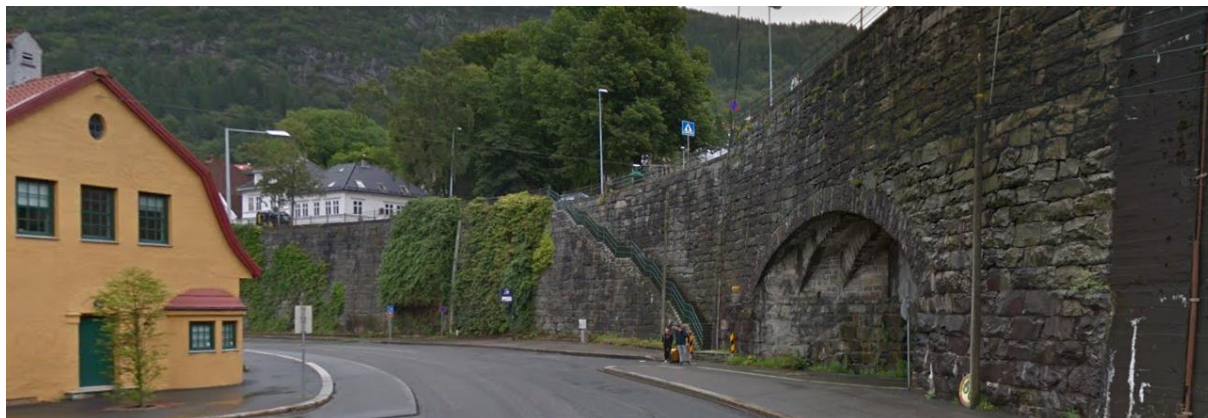
Figur 58. Sjøgaten sett mot Sandviken kirke i nord/øst (bak treet), med Slaktehuset til venstre. Google Earth 2018.
