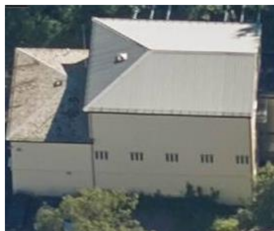
Figur 36. Trafo fra 1958. Skråfoto fra Blom Urbex
