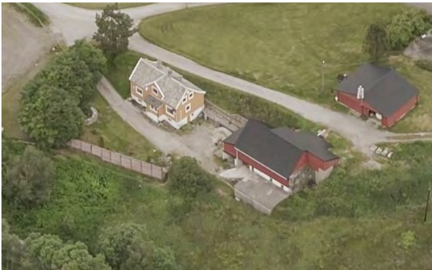
Figur 82: Steinestøvegen 5. Gårdsbebyggelse på Eikås. Avmerket som nr. 2 på figur 78 (Foto: Bergen kommune 2017).
