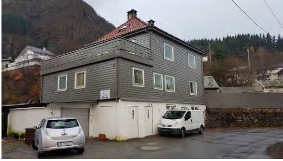
Figur 25: Eidsvågveien 42 fra 1933 (Foto: Byantikvaren 2018).
