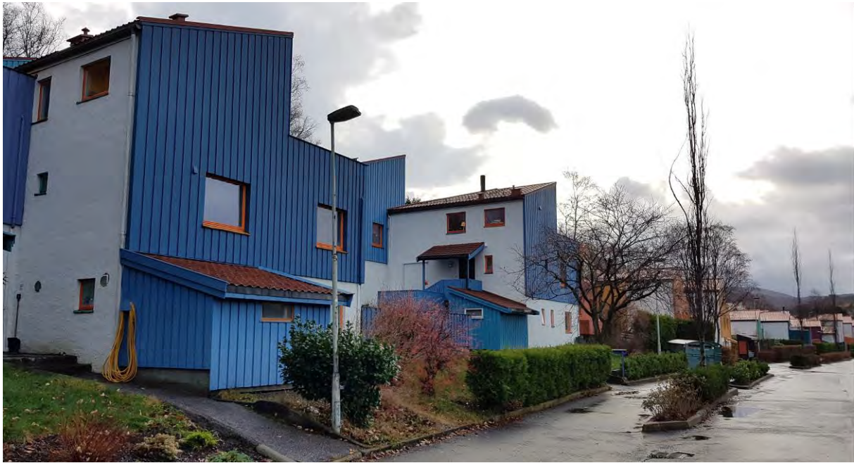
Figur 57: Selegrend er et spesielt byggeprosjekt fra midten av 1970-årene, som i dag er vernet med hensynssone for kulturmiljø i gjeldende KPA. Avmerket som nr. 4 på figur 53 (Foto: Byantikvaren 2018).
