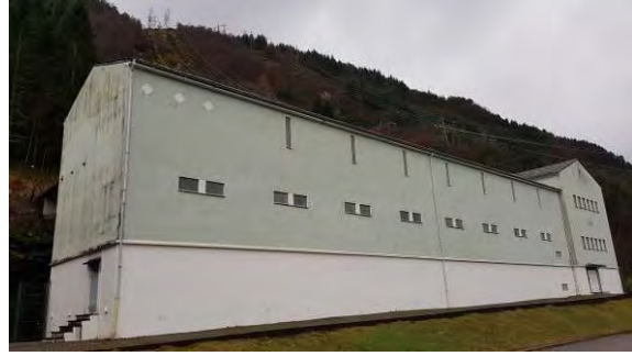
Figur 26: Jordalsveien 52, strømstasjon fra 1960 (Foto: Byantikvaren 2018).
