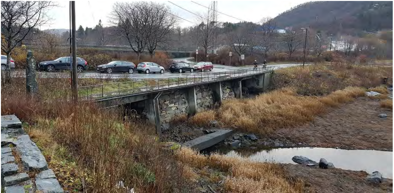
Figur 17: I dag går vannføringen fra Jordalsvannet til Eidsvåg gjennom en kulvert under E39 (Foto: Byantikvaren 2018).
