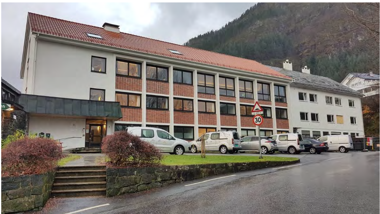
Figur 7: Jordalsveien 1, tidligere Eidsvåg kommunehus. Bygningen påbegynt i 1950, men er bygd på i flere omganger (Foto: Byantikvaren 2018).
