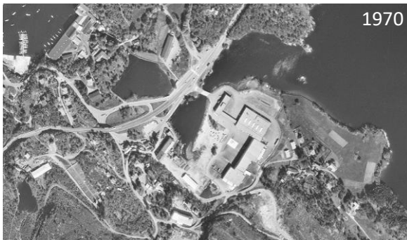
Figur 14: Ortofoto fra 1970 viser utfyllinger for næringseiendommer og større veianlegg (Illustrasjon: Bergen kommune 2018).
