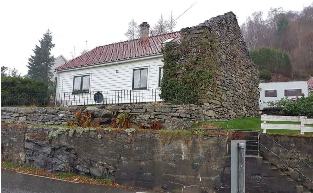
Figur 33: Selvikveien 6, avmerket som nr. 4 på figur 28. Våningshuset har en svært markant tørrmurt gavlvegg mot øst (Foto: Byantikvaren 2018).
