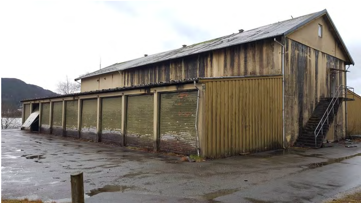
Figur 76: Bergen Sivilforsvars Magasin og Alarmplass, som ble reist i 1966. Bygningen er gass og trykksikker, avmerket som nr. 3 på figur 70 (Foto: Byantikvaren 2018).
