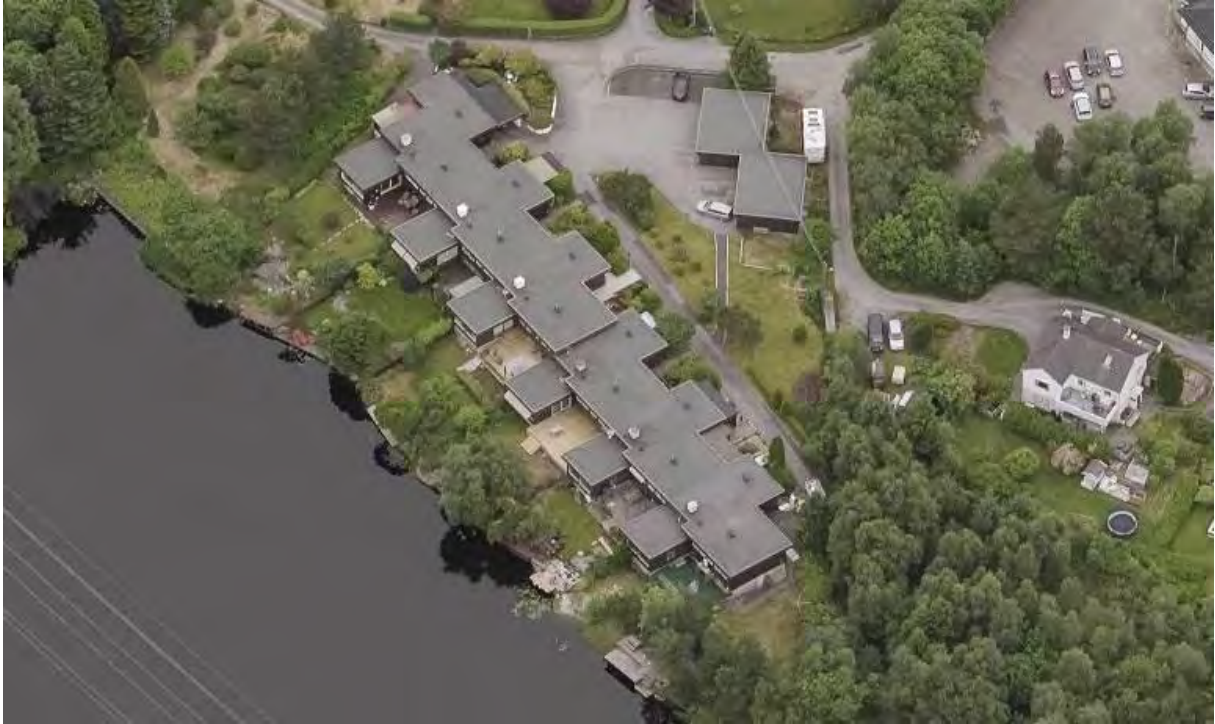
Figur 65: Atriumhuset på Saurås fra 1970. Avmerket som nr. 5 på figur 59 (Foto: Bergen kommune 2018).
