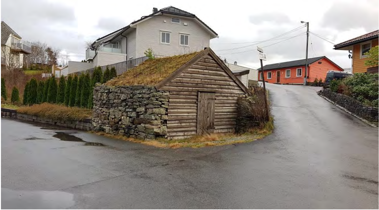
Figur 61: Steinhus med sørgavl i tre, avmerket som nr. 1 på figur 59. Løa står i dag midt i et veikryss, mellom et byggefelt og kjøpesenteret Horisont (Foto: Byantikvaren 2018).
