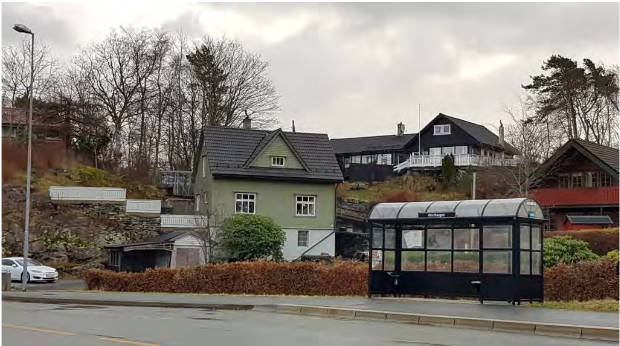
Figur 56: Åsamyrane 6 er eksempel på eldre bygning (1926) ved Hesthaugen, markert som nr. 3 på figur 53 (Foto: Byantikvaren 2018).
