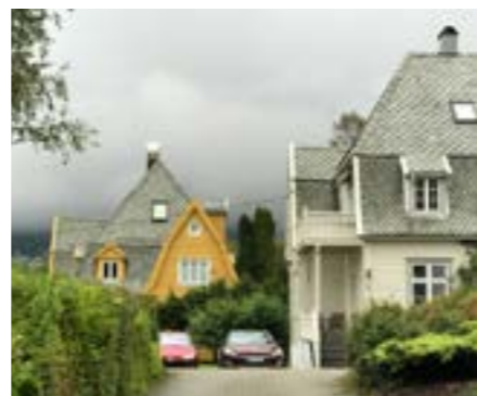
Parti fra Storetveitåsen. Her representert ved to villaer i nybarokk stil. Nybarokken kjennetegnes av blant annet en rektangulær sluttet bygningskropp og høye dominerende tak som er valmet, med halvvalm eller med pyramidetak.
