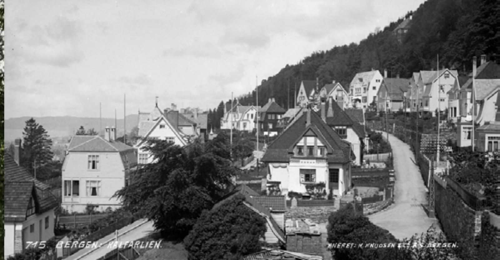
Parti fra Kalfaret. Foto tatt i 1913. En tur gjennom villastrøket på Kalfaret, er som en arkitekturhistorisk vandring. Store deler av bebyggelsen er bevart og området fremstår nesten som for hundre år siden. Foto: uib/marcus/ubb-kk-pk-0715
