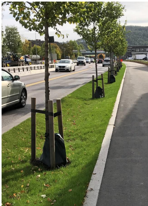
Figur 30 Eksempel på nedsenket grøntrabatt for lokal infiltrasjon og rensing av overvann fra gate. Innløpet fra gate skjer via et gjennomløpssluk montert i kantsteinen. (Bjørnstjerne Bjørnsonsgate i Drammen) (Foto: Svein Ole Åstebøl, COWI AS).
