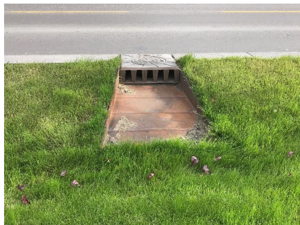
Figur 30 Eksempel på nedsenket grøntrabatt for lokal infiltrasjon og rensing av overvann fra gate. Innløpet fra gate skjer via et gjennomløpssluk montert i kantsteinen. (Bjørnstjerne Bjørnsonsgate i Drammen) (Foto: Svein Ole Åstebøl, COWI AS).
