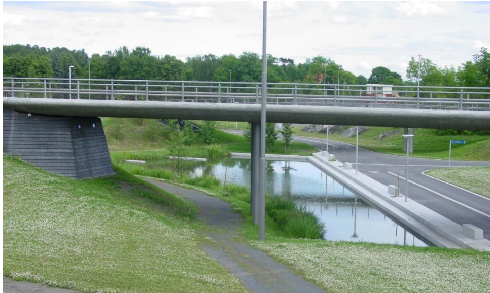
Figur 29 Eksempel på sedimentasjonsdam for rensing av overvann i et byområde (Fornebu, Bærum kommune) (Foto: Svein Ole Åstebøl, COWI AS).
