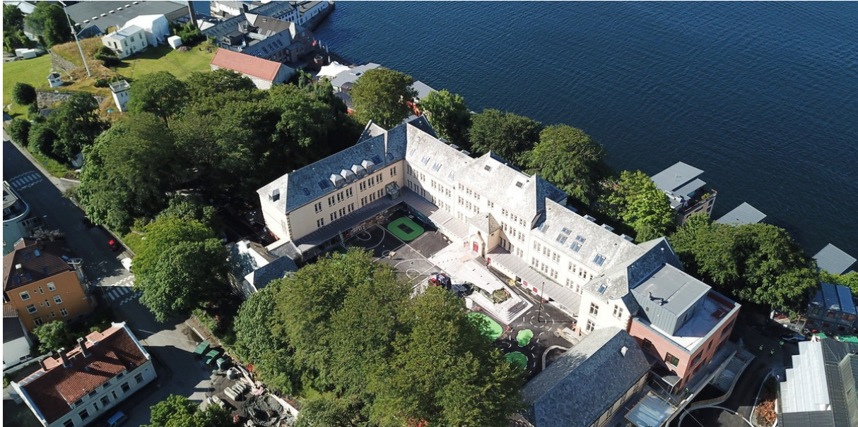
Dronefoto av Nordnes skolegård som stod ferdig høsten 2020. Foto: Structura entreprenør
