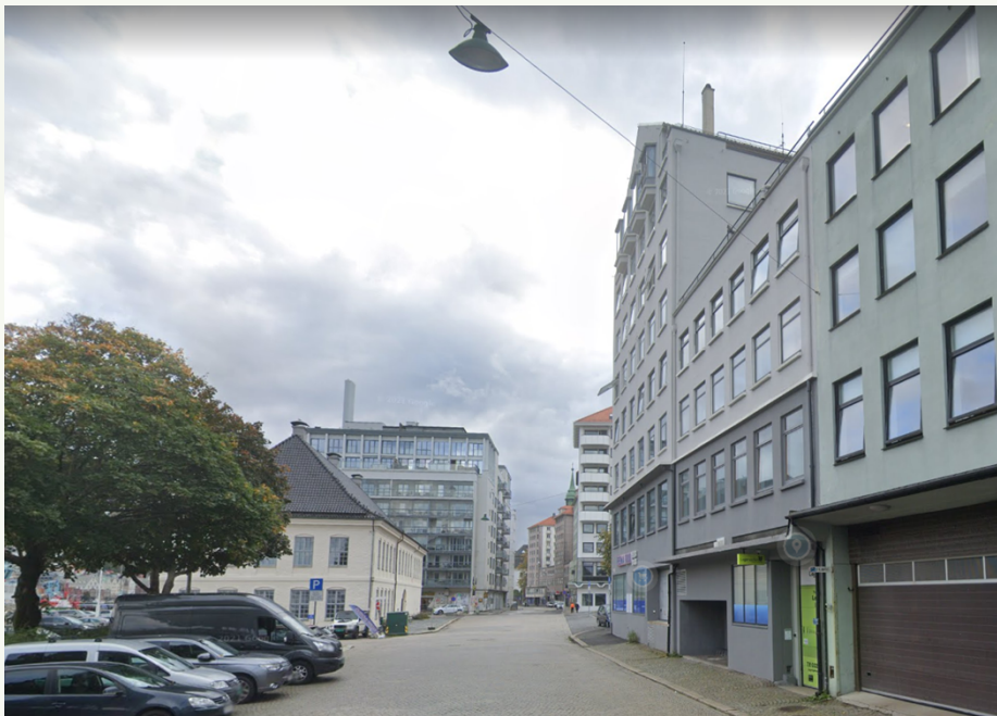
Figur 20: C. Sundts gate fra nr 10 sett mot Tollboden og videre sørover.
