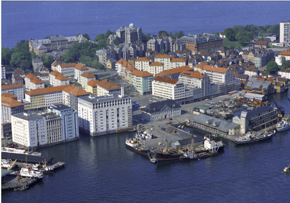
Figur 19 Flyfoto fra 1962 viser etterkrigsbebyggelsen langs Tollbodallmenningen og C. Sundts gate. Foto: Widerøe's Flyveselskap AS, 1963. Kilde: Marcus, uib.no.
