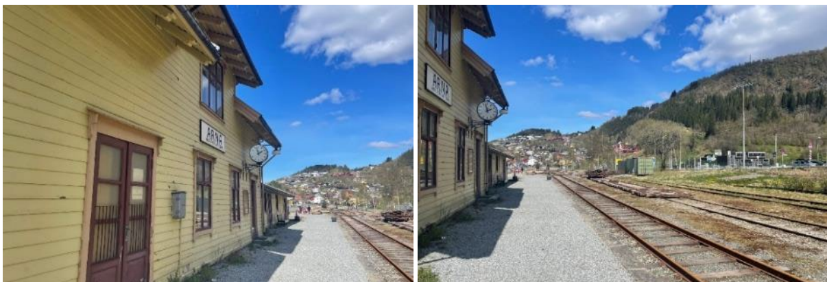
Figur 6-29 Stasjonsbygning Gamle Arna stasjon, Vossabane. Foto tatt ved befaring våren 2022.
