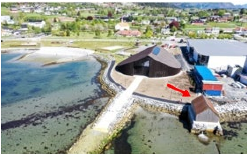
Figur 5-21: Eksempel på at en varmesentral kan innpasses på en god måte som tar hensyn til strandsonen. Vikinghuset Sagastad i Nordfjordeid i bakgrunnen, varmesentral for store deler av Nordfjordeid i forgrunnen (jfr rød pil). I Teknisk ukeblad (20.09.19) opplyses om at over 90 bygg er knyttet til systemet. Foto: Jørn- Arne Tomasgaard.
