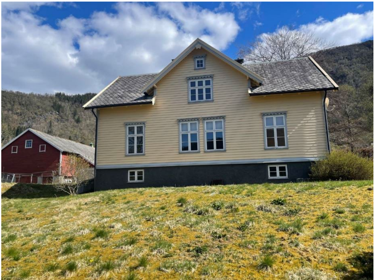
Figur 6-34 Våningshuset med driftsbygning. Bilder tatt på befaring våren 2022.
