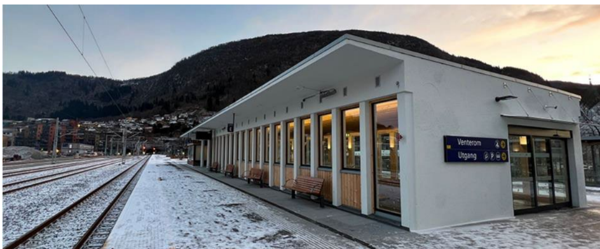
Figur 6-41: Arna stasjon etter ombygging og modernisering. Ytterveggene er bevart og byggets funksjonalistiske uttrykk er godt ivaretatt. Foto BaneNor.no
