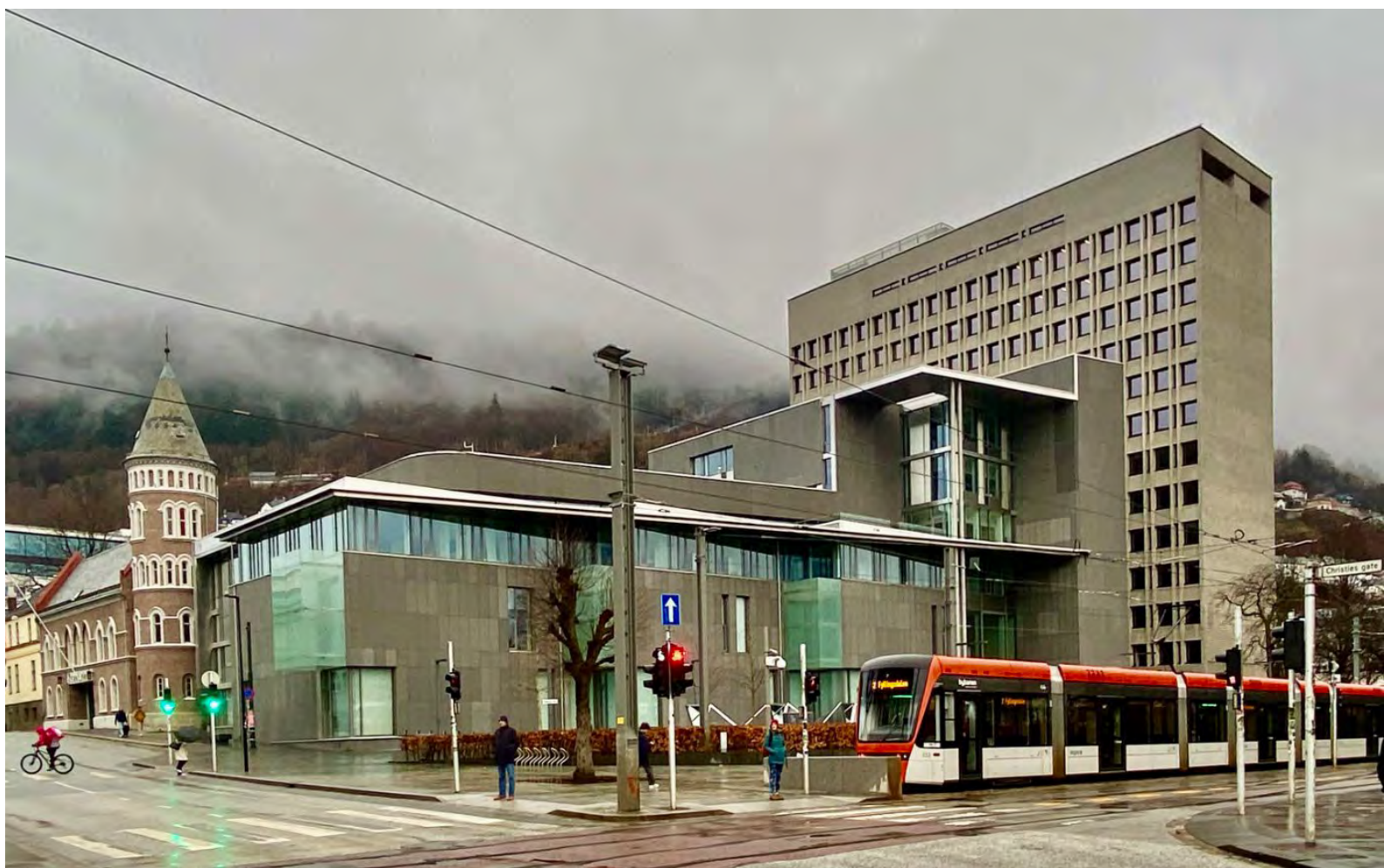
Figur 130: Det nye rådhuset og Gulating-bygget ligger side ved side og representerer hver for seg typiske eksempler på etterkrigsarkitekturen i Bergen. Foto: Byantikvaren 2023
