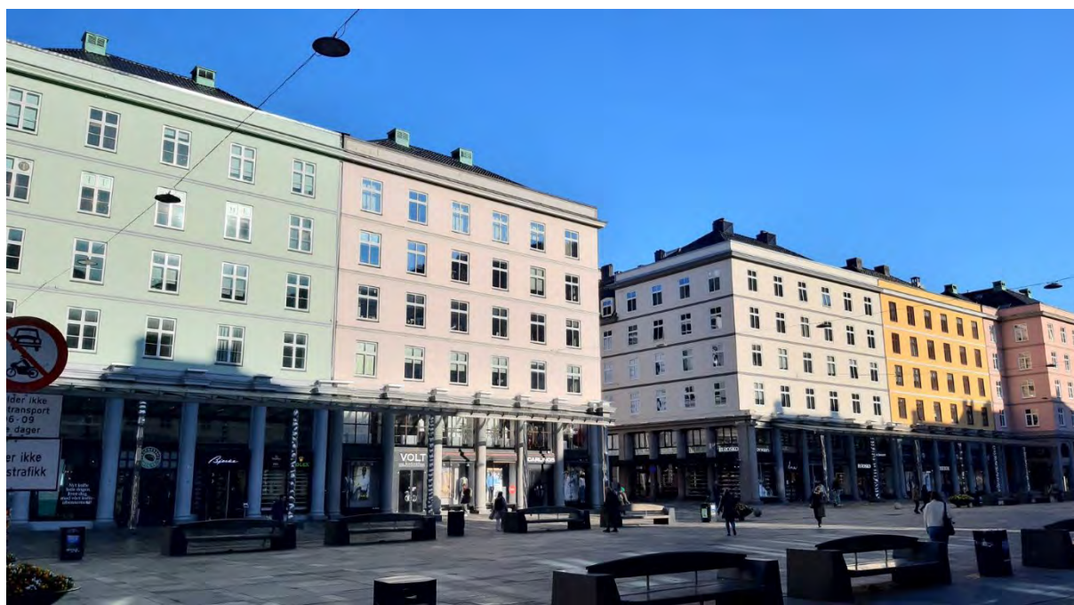
Figur 90: Flere av husene på Torgallmenningen, spesielt de to til høyre i bildet, er i dag fargesatt i kraftige farger. Dette fører til et brudd i helhetsuttrykket og Berners ønske for fasadene og for Torgallmenningen, at det skulle oppfattes som ett rom. Foto Byantikvaren 2023
