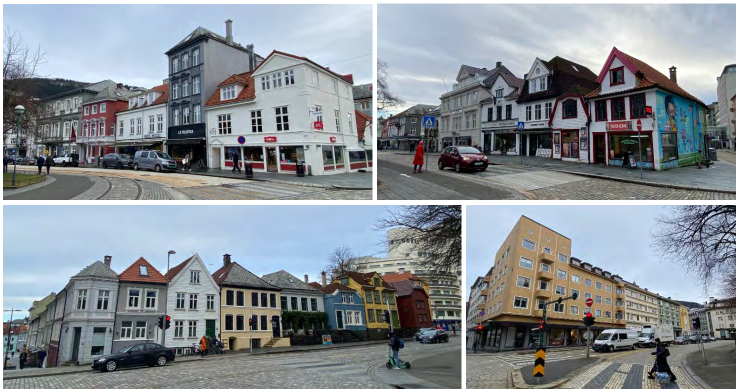
Figur 78-81: Fasaderekkene ved Engen og Christian Michelsens gate slik de fremstår i dag. Alle foto: Byantikvaren 2023
