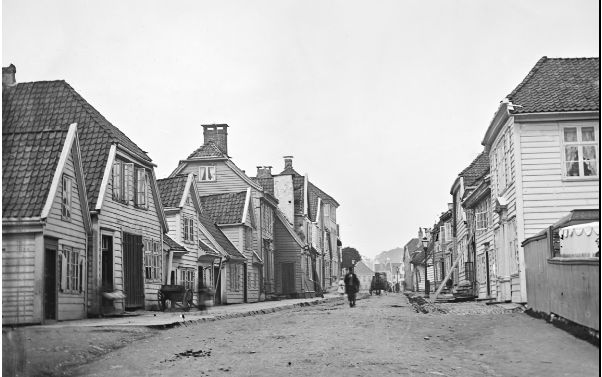
Figur 23: Vaskerelven fotografert ca. 1865 av Knud Knudsen. I 1830-årene ble Vaskerelven den første gaten i Bergen med såkalt makadamisering . Foto UiB/Marcus ubb-kk-ns-1185
