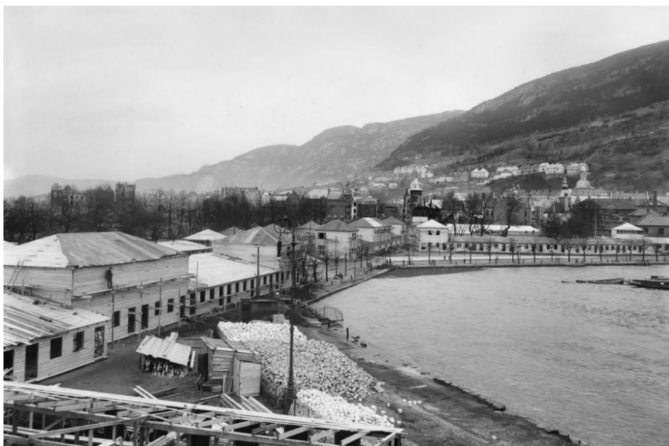
Figur 105: «Nødtørftighetsbarakker» for næringsdrivende under oppføring ved Smålungeren høsten 1916. Kilde: UiB/Marcus ubb-kk-ncx-0394
