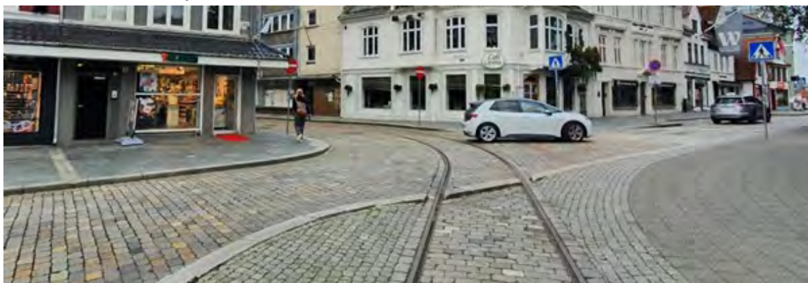
Figur 144: Krysset mellom Engen og Vaskerelven viser ulike "nytolknninger" av tradisjonelt dekke på gater og fortau: Betongheller på fortau var standarden fra 80-tallet, mens faststøpt, skåret skifer (t.v) er en nyere og mer kostbar variant Foto: Byantikvaren, 2023.
