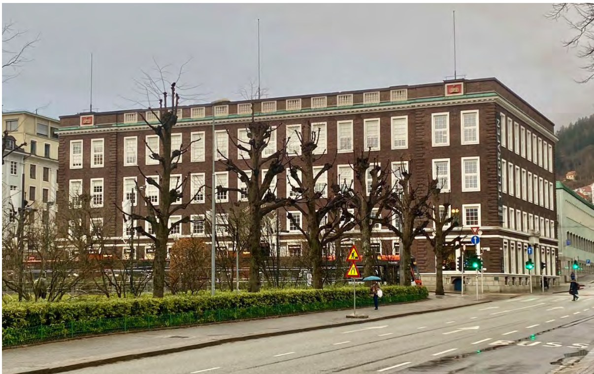
Figur 128: Den monumentale Telegrafbygningen, tegnet av arkitektene Finn Berner og Anton M. Kielland og stod ferdig i 1927. Den er oppført i et nyklassisistisk formspråk, i en variant som kan karakteriseres som ny-georgiansk eller «Colonial Style»-arkitektur. Denne hentet inspirasjon fra engelsk og amerikansk 1700-tallsarkitektur. Bygningen ble vedtaksfredet i 2013. Foto: Byantikvaren, 2023.
