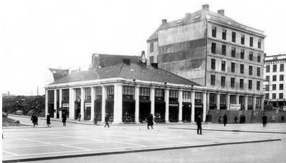
Figur 87: Flere av bygningene rundt Torgallmenningen ble reist i to byggetrinn, der første byggetrinn (1926) ble oppført med provisoriske tak, tekket med takpapp. Torgallmenningen 5 er et eksempel på dette. Først i 1937 ble det utstedt ferdigattest på bygget. Da var de neste 4 etasjene og et innredet loft på plass. Torgallmenningen 3B (t.h.) er oppført i full høyde. Dette er det eneste bygget på Torgallmenningen med hogde søyler i stein - de øvrige har plass-støpte søyler. Foto: Marcus/UiB ubb-kk-n-302a-062
