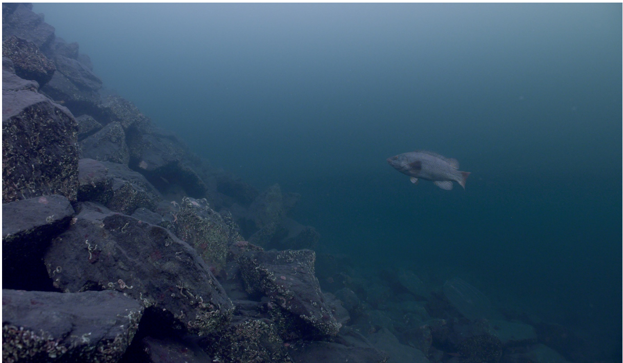
Mange store berggytt langs steinurene. Terrenget her er ganske bratt og blir brattere de neste ca. 50m mot brannstasjonen. Kan hende noe kan rase ut her?
