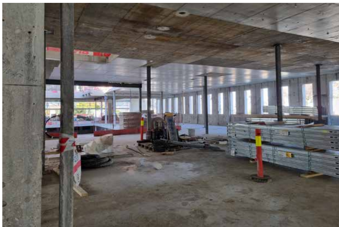
Interiøret under ombygging.
