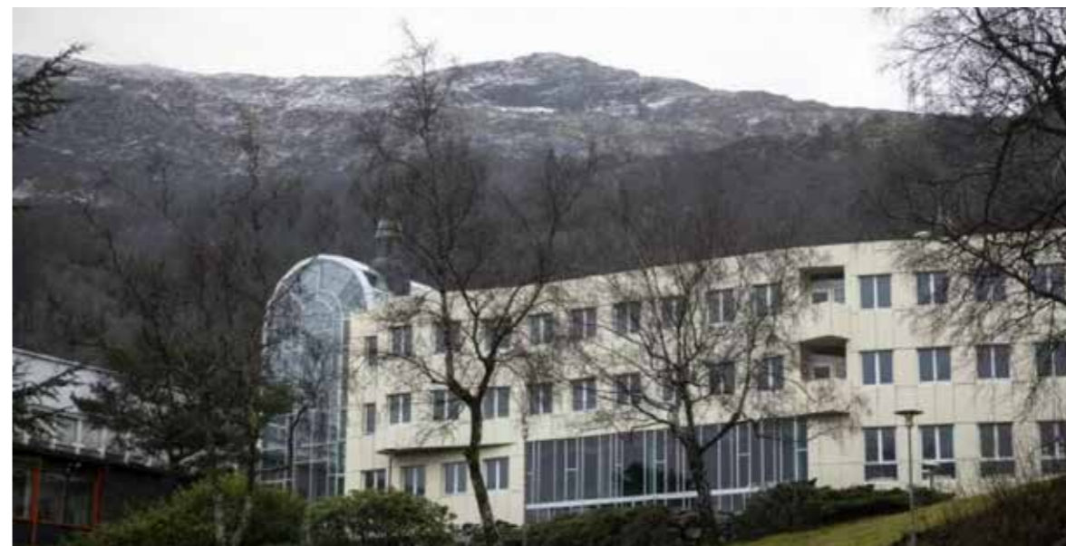
2020 - Den gamle lærerhøyskolen før ombygging
