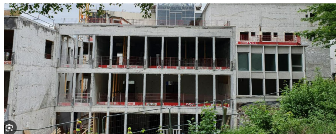
2020 - 2022 Den gamle lærerhøyskolen under ombygging
