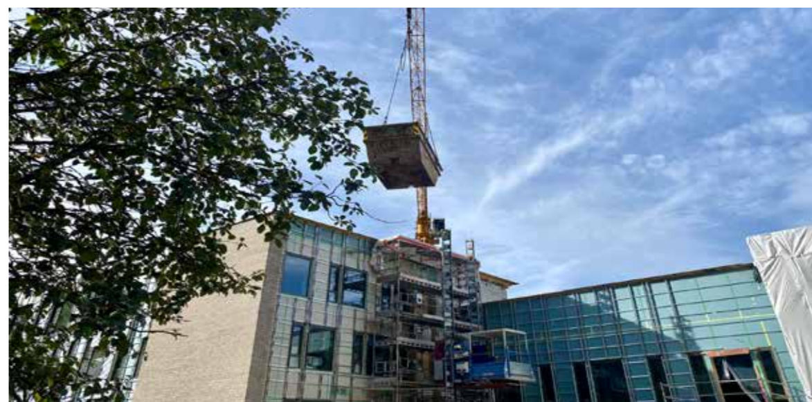
Den gamle lærerhøgskolen under ombygging i 2022.
