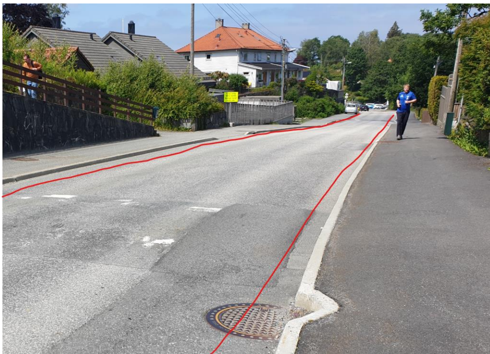
Figur 5-5: Utvide fortauene til 2,5m bredde innenfor dagens totalbredde, ny kantstein.
