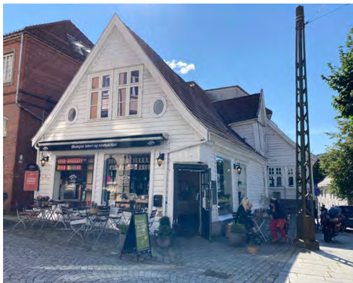
BILDE: Marken 1 i dag. Bygningens hovedform og fasadeuttrykk er godt bevart.
