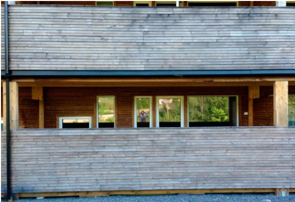
Figur 1: Foto tatt av byggesaksavdelingen under befaring i forbindelse med søknad om ferdigattest.
