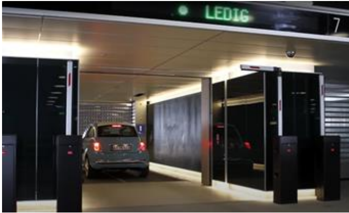
Figur 30. Bilde fra heisanlegget ved Dokk1 i Aarhus. Kilde: Parkering i Aarhus | Dokk1 Parkering - DOKK1 (dokk1-parkering.dk)
