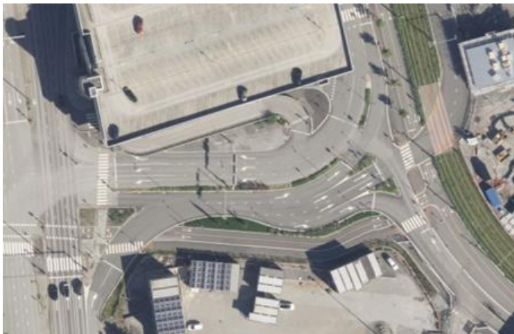
Figur 18. Kryssing av Lungegårdskaien blir en viktig del av gangaksen mellom framtidig byarena og kollektivterminalen/sentrum, og er i dag preget av mange kjørefelt og utflytende, veimessig utforming. Bilde: vegkart.no.
