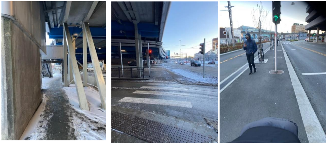
Figur 9. Gangaksene rundt ByGarasjen i dag.
