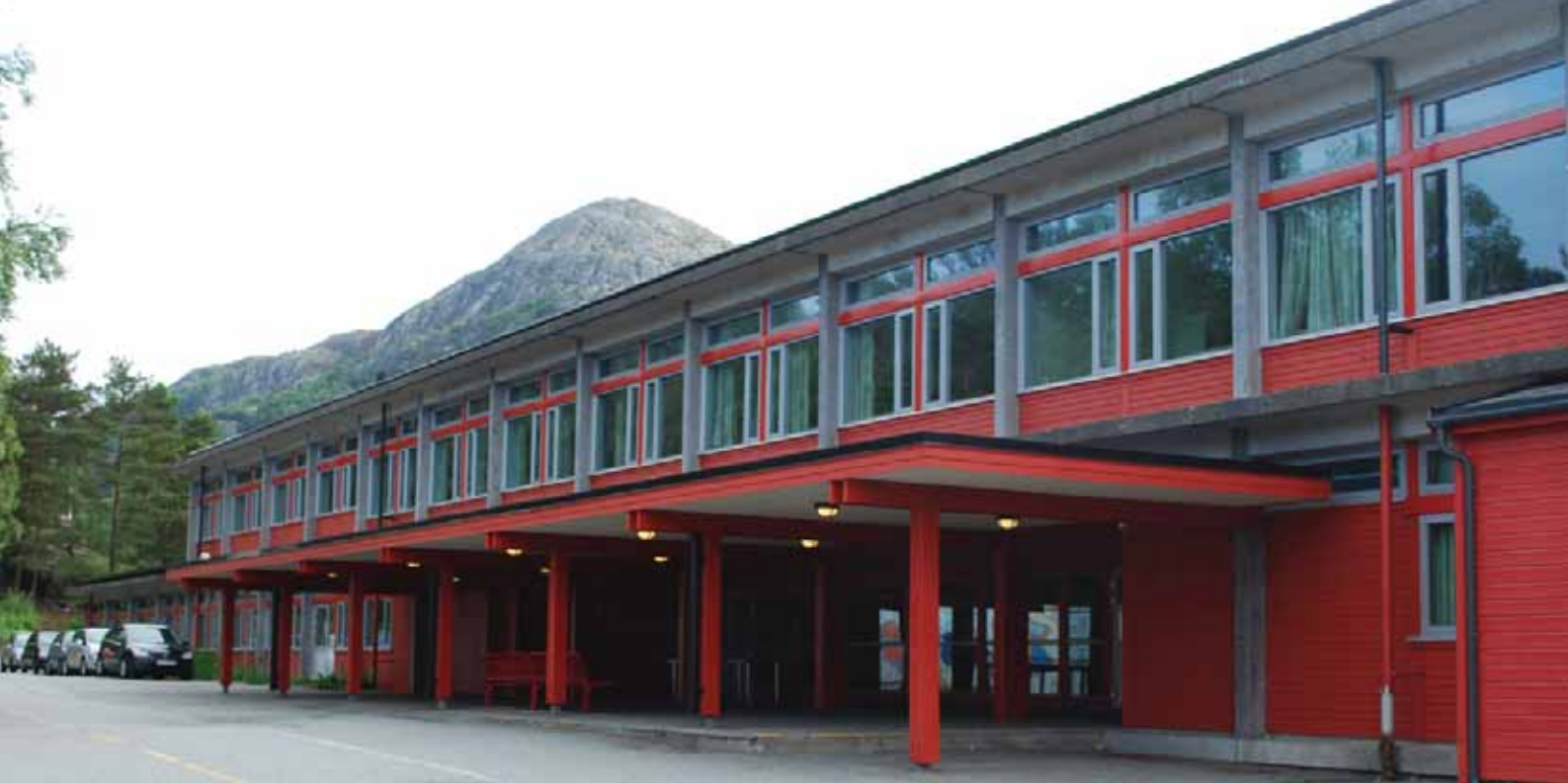
Fasaden mot vest med leskur med hovedinngang sentralt plassert.
