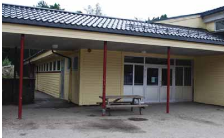
Leskur og garderobene bakenfor hadde opprinnelig flatt tak.
