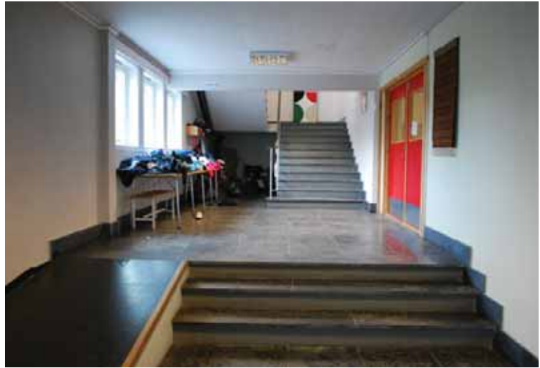
Gymnastikksal og tilskuddsbygg ligger fritt i terrenget. Søndre del av hovedbygget er tatt i bruk til barnehage, i den forbindelse er området rundt gjerdet inn og et lite tilbygg oppført.
