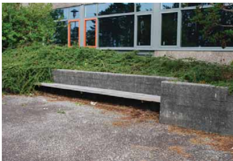
Benker mellom betongrekkverk.
