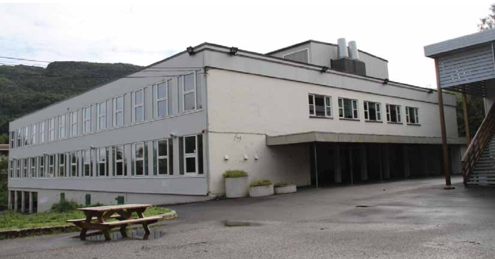
Hovedbyggets fasader mot vest og sør.
