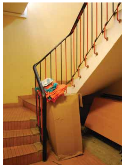
Teglfliser, slipt terrasso og buet trapp i gymnastikkbygget (1966).
