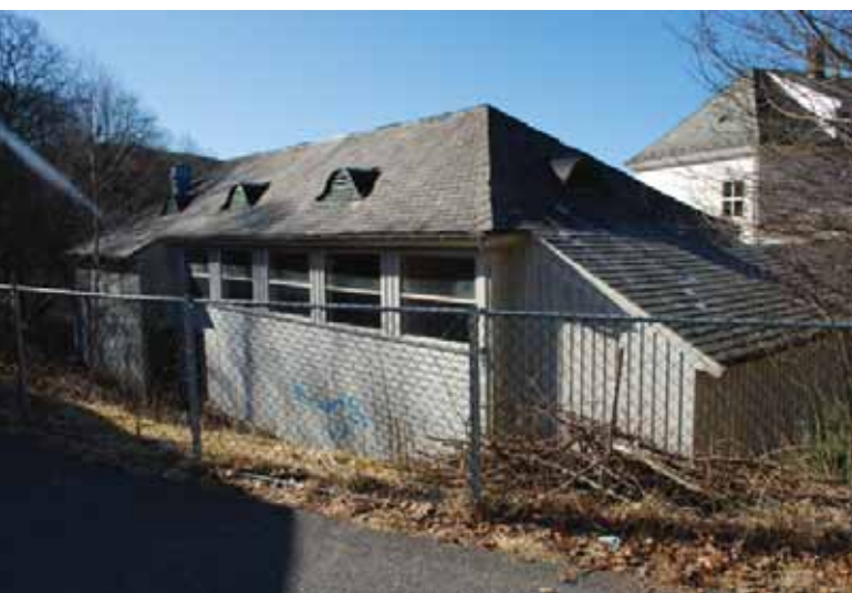
Gymnastikkbygget sett fra nord-øst. Tilbygg og vindusbånd fra 1970-årene. Tak med buede arker bevart.
