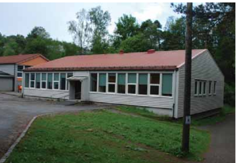
Klasseromspaviljongen. Opprinnelig med tette endevegger i leca og åpne langfasader i tre.
