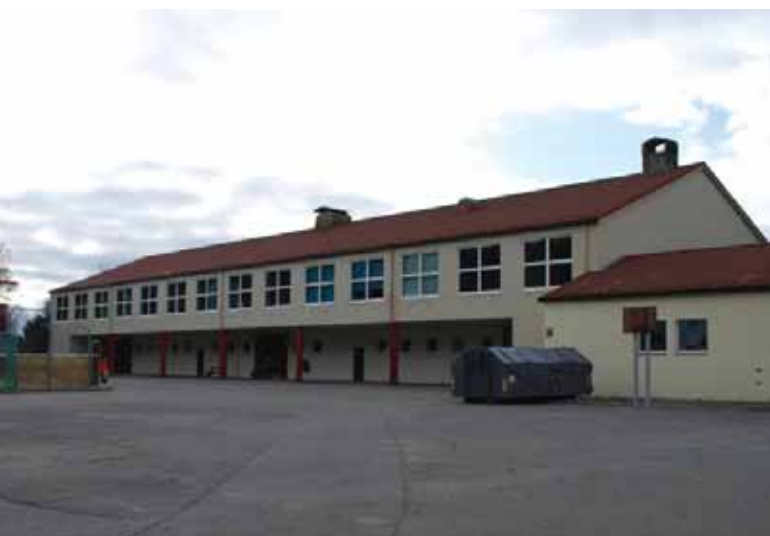
Klasseromsfløy 1a (1961) fra skoleplassen i øst. Sprossvinduer og tilbaketrukket første etasje.
