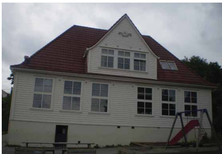
Gamleskolens sørfasade med midstilt takark, krysspostvinduer i ark og første etasje.
