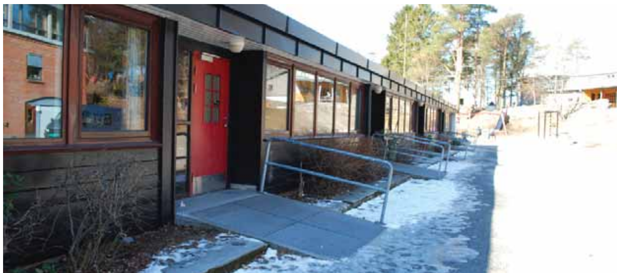
Klasseromsfløyens fasade mot nord. Desentraliserte innganger, én til hvert klasserom.
