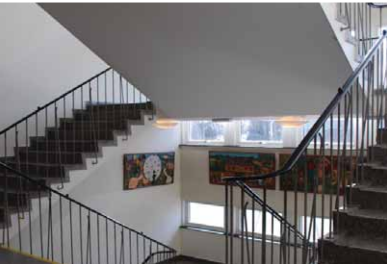
Et flott trapperom med tidsriktig detaljering; enkle ståltrekkverk. Trappene er løsebet fra ytterveggen.
