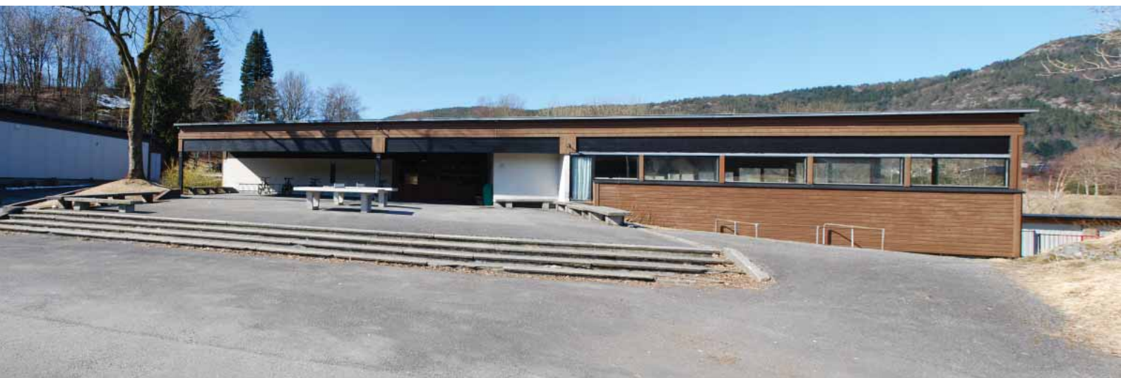
Gymnastikkbygget (3) fremstår fra øst som ett horisontalt volum med horisontale vindusbånd og gesims.
