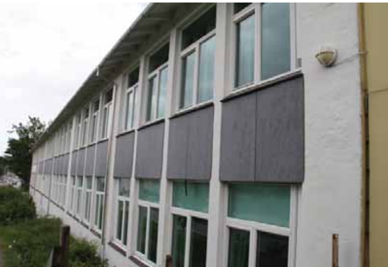
1958-fløyens sørligefasade med markerte etasjer, brystningsfelt, og horisontale vindusbånd som er brutt av tynne søyler.
