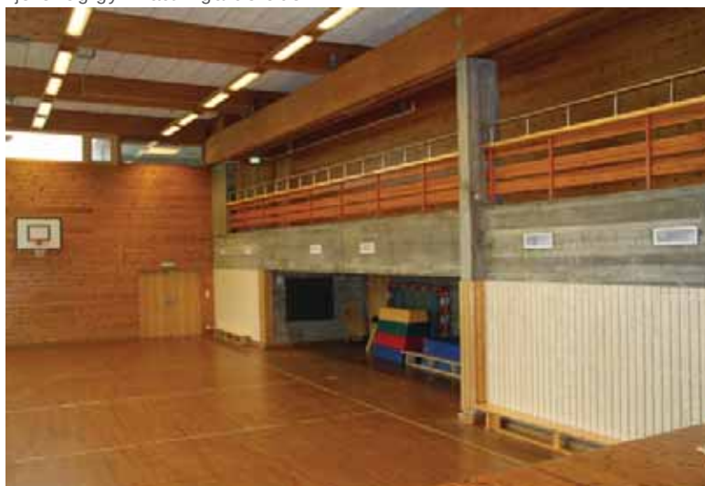
Gymnastikksalen. Ærlige materialer - råbetong og furu - og lesbar konstruksjon. Galleri med inngang til garderober i svømmehall.
