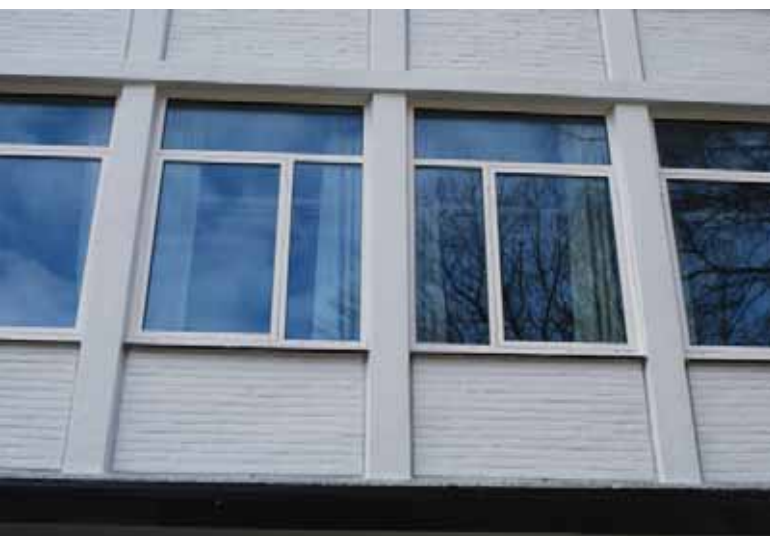
Vindusraster hovedfasade, bygg A. Pilastre mellom vinduene og tegl i brysningsfeltet.
