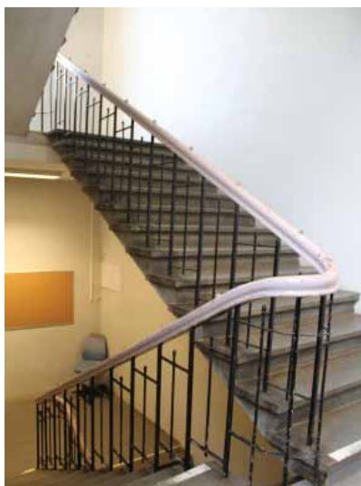
Ett av flere trapperom. Flotte smijernsrekkverk.
