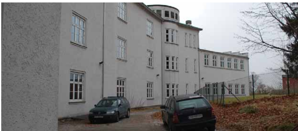
Bakfasaden mot nord-øst, sylindrerformet parti binder sammen fløyene. Helt til venstre i bildet er heissjakt, med lik materialitet og overflatebehandling som fasadene.
