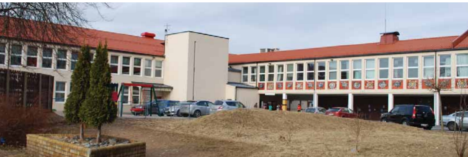
Keramikk i brystning og tilbaketrukket leskur på nordre fløy, høyre, fasader uten utsmykning på vestre fløy til venstre. Tilbygg med trapp og heiser i midten.
