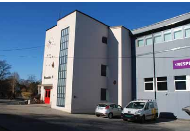
Tilbygget fra 1939 og gymnastikksalen fra samme år med nye fasader.
