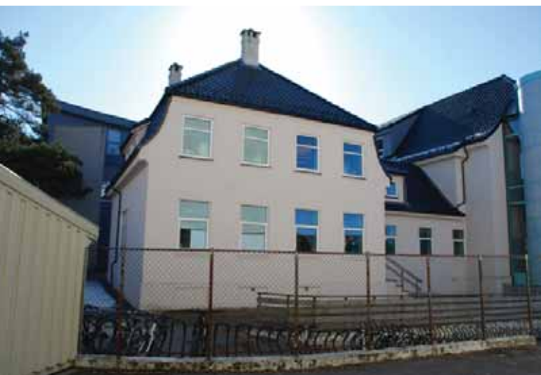
Vaktmesterboligen sett fra vest. Vinduene er skiftet til vinduer med ny inndeling.
