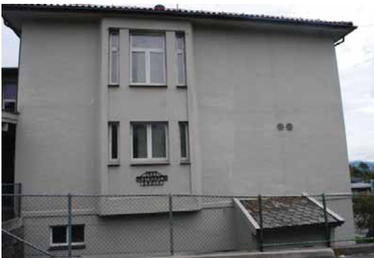
Fasade mot vest. Vindusinndeling i fremtrukket parti endret.
