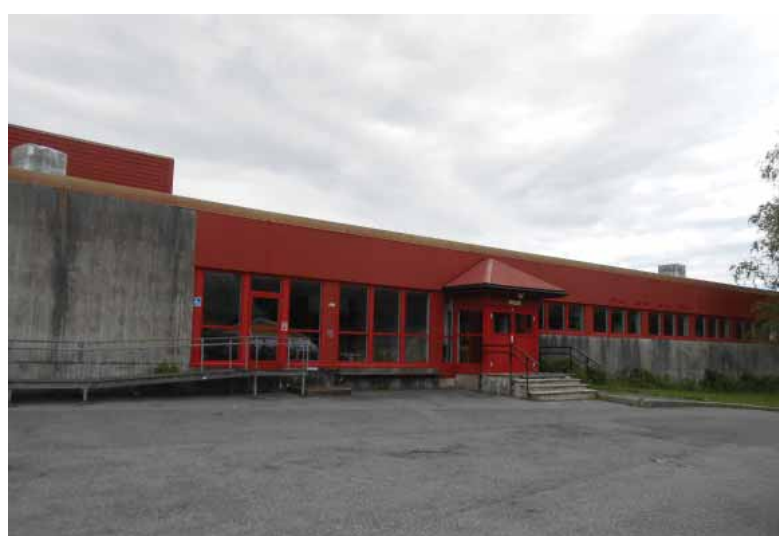
Blokk A: Fasade mot øst. To nye inngangsparti; rampe og karnapp.
