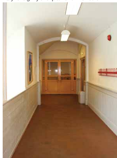
Korridor: Autentisk brystningspanel til høyre og nyere panel til venstre.
