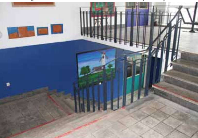
Hovedtrappen i 1958-delen. Med trinn og fliser i skifer, metallrekkverk med buer.
