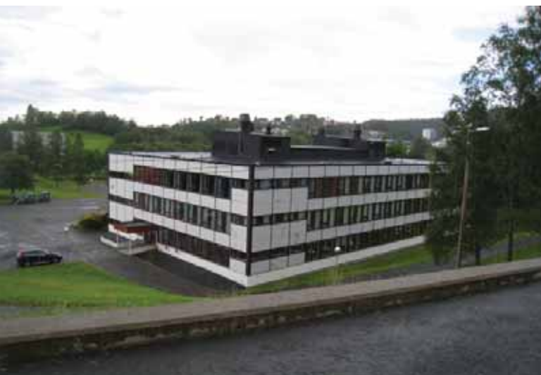
Det største volumet sett fra nord-øst.
