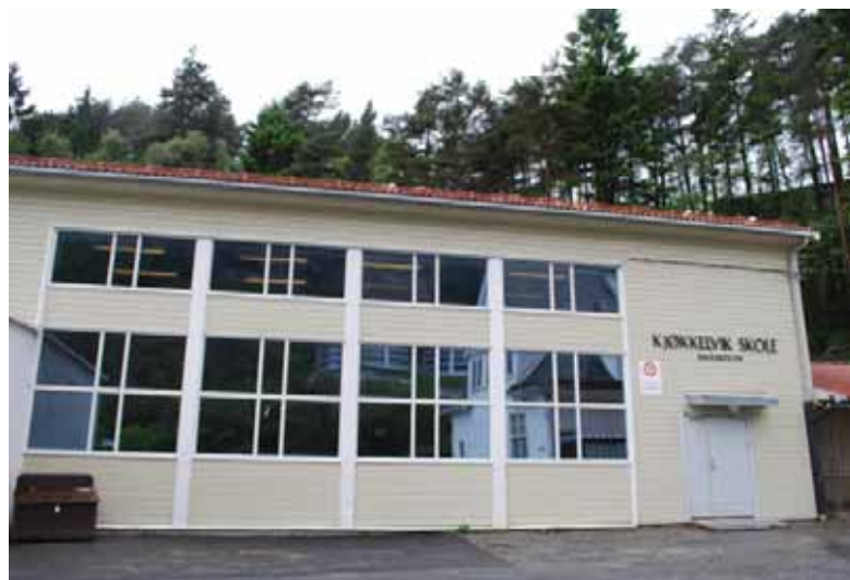
Gymnastikksalen (1960) har store vinduer og eksponerte søyler.
