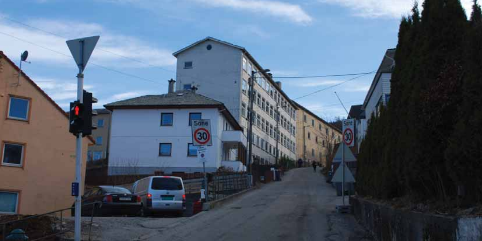
1954-anlegget, bygg 1A lengst bak og bygg 1B foran Klasseromsfløyene er oppført i mur med saltak og har en streng utforming med vinduer jevnt fordelt, uten ornamentering, typisk for skolearkitekturen på 1950-tallet.
