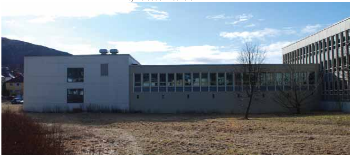
Klasseromsfløyens og mellombygningens fasader mot nord.
