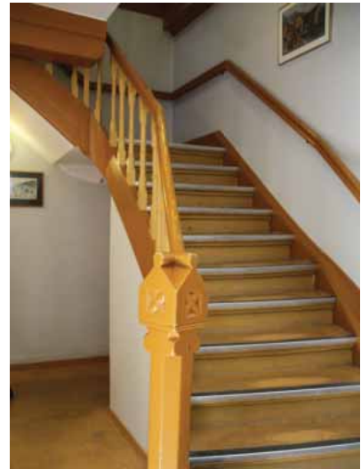
Bygg sør: Bevart rekkverk i nygotikk.
