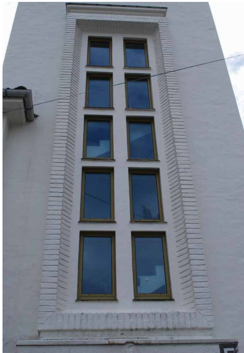
Vertikalt vindusparti over søndre inngang. Omramming i tegl. Trapperom innenfor.
