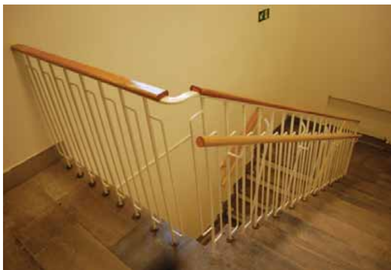
Oppusset trapp; gulv bevart. Rekkverk tilsvarende opprinnelig, men med ekstra håndløper og stag.
