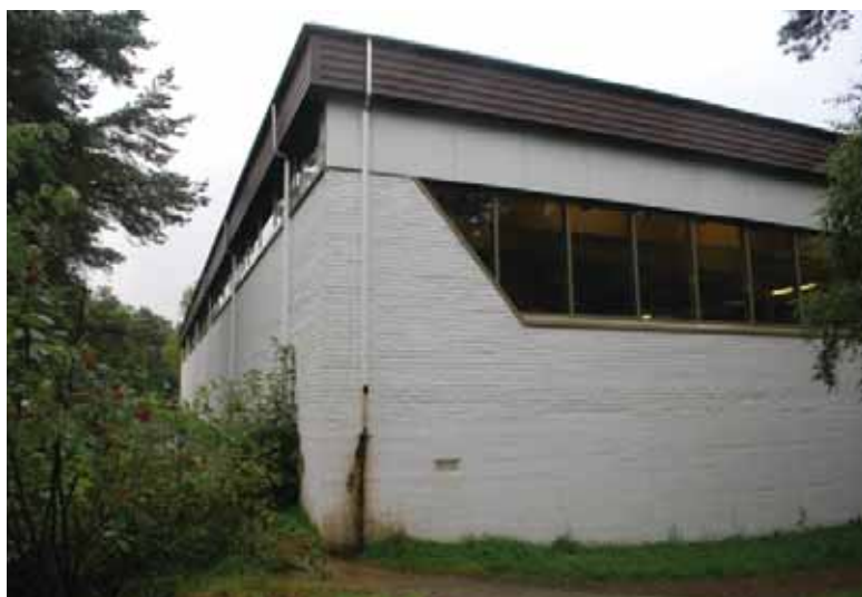
Svømmehallen med teglvegger og vindusbånd. Opprinnelig større vindu i front (til høyre), som kobler seg til vindusbåndet på siden (til venstre).
