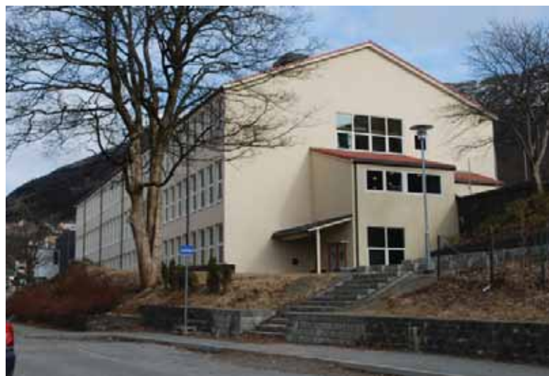
Vestfløyen sett fra sør-vest. Et rigid volum med vinduer jevnt fordelt. Tilbygg med innganger på gavlvegg.
