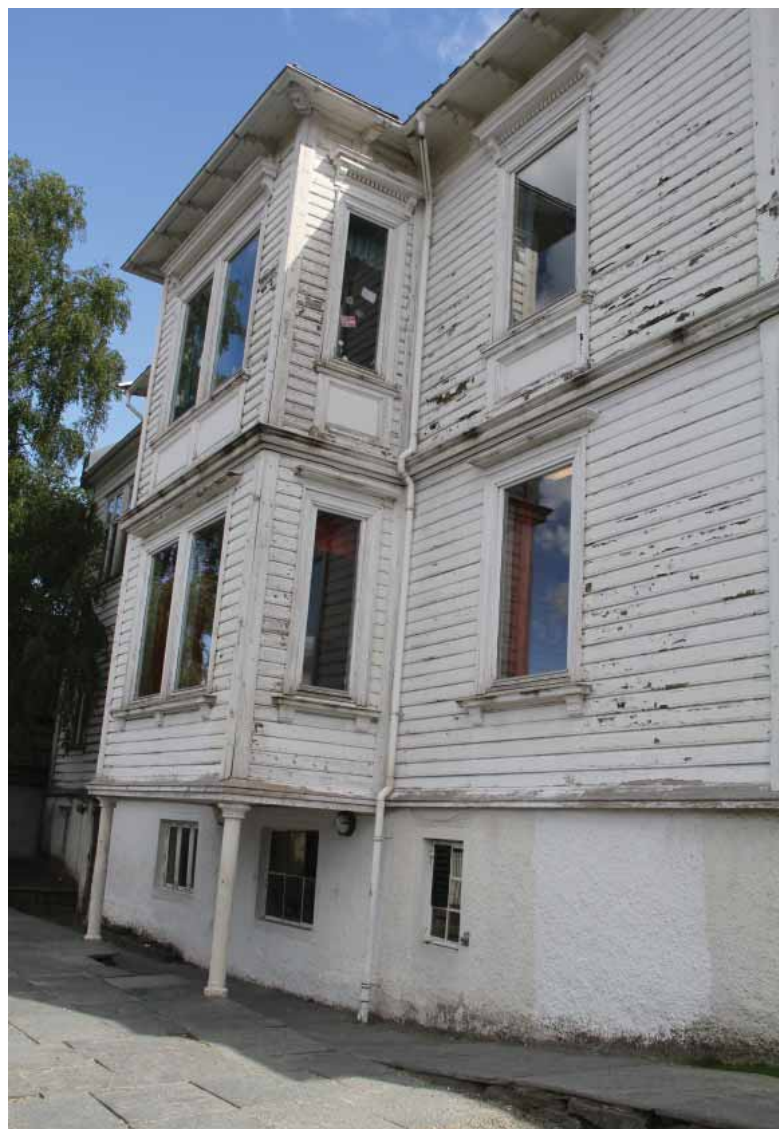
Krybbesmauet 7s fasade mot sør-vest. Karnapp fra 1895 og 1923.
