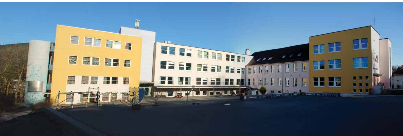
Paradis skole sett fra sør-øst. Anlegget er lite enhetlig med bygningsdeler fra 1910-, 1930-, 1990- og 2000-årene
