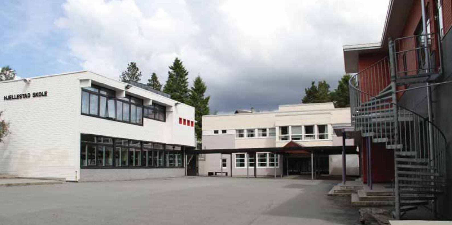
Anlegget er lite helhetlig, med bygg fra 1971, 1995 og 2004.
