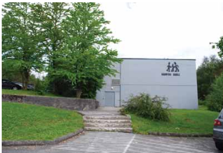
Hovedbygget (1971) fra sør.
