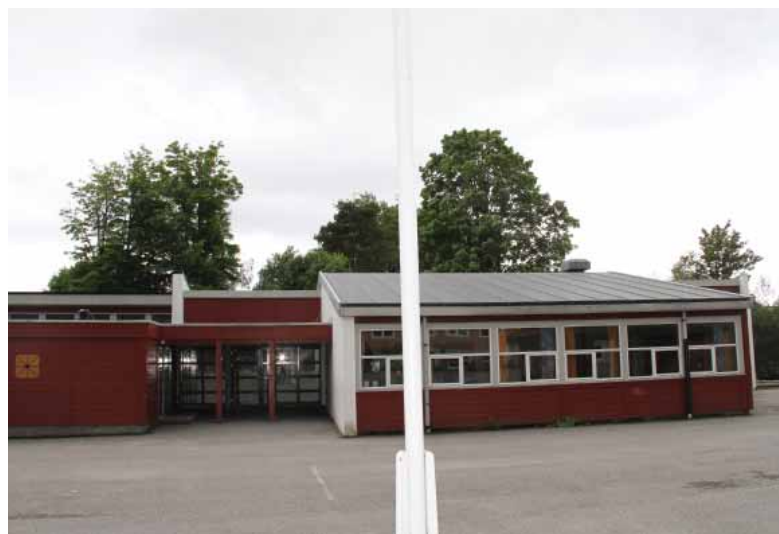
Tilbygg til nye paviljongen, fasade mot nord-øst. Tilbygget foran til høyre er til en viss grad tilpasset 1968-bygningen.
