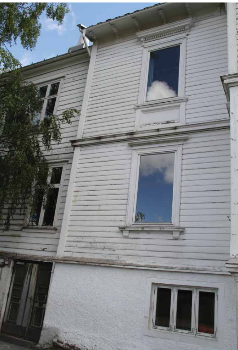
Krybbesmauet 7s fasade mot sør-vest. Tilbygg til venstre.
