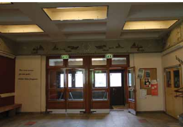
Teakdører og kassetthimling i inngangshallen.
