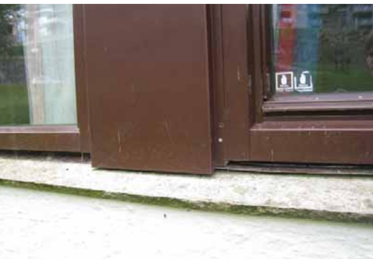
Første etasje: Pusset mur i brystning og stenderverk over.
