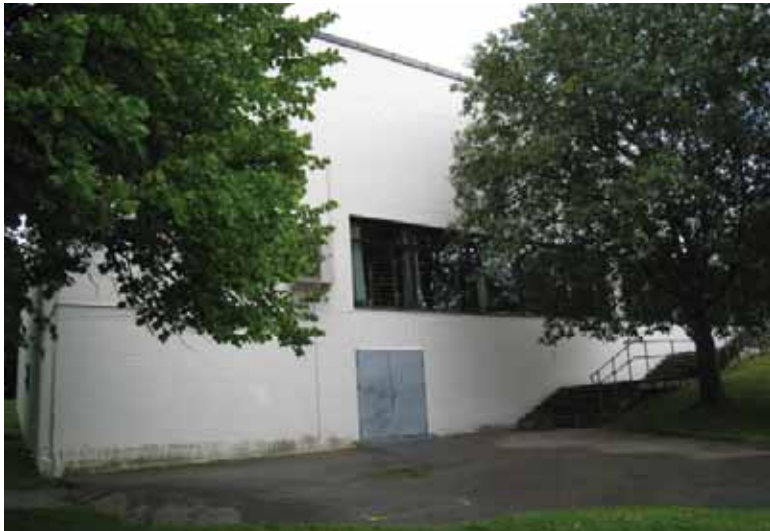
Gymnastikkbygningen er oppført i plaststøpt betong og har relativt tette vegger med få vindusbånd. Søndre fasade.
