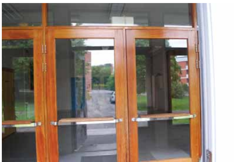
Vindusdører i vindfang i teak.
