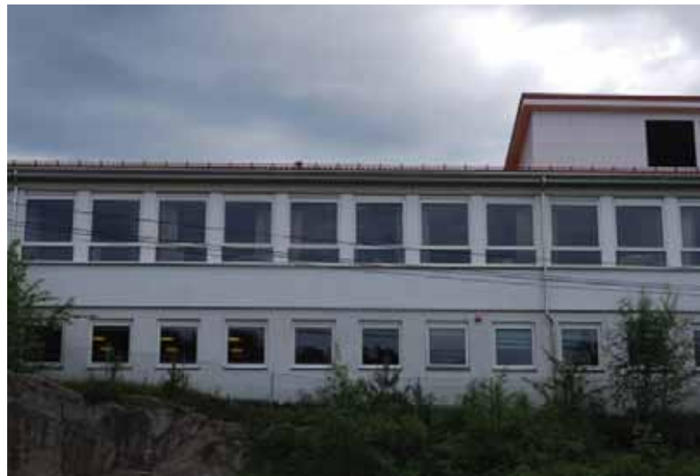
Fasaden mot vest med sokkeletasje. Vinduer jevnt fordelt. Nyere ventilasjonsrom til høyre på taket.
