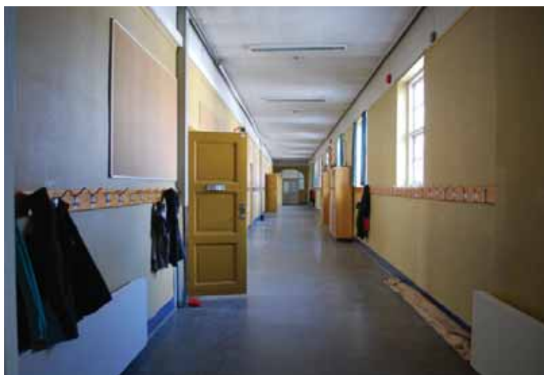
En av tre korridorer i hovedfløyen. Nye overflater, muligens originale fliser nederst på veggen.
