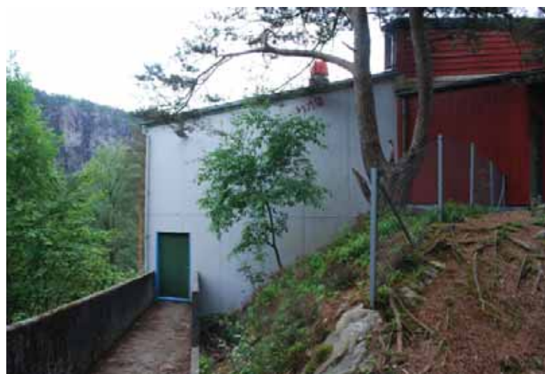
Fasade mot nord er lukket, kledd delvis med plater, delvis med panel.
