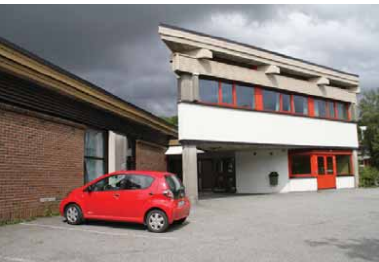
Helsestasjon og klasserom, ved siden av idrettshallen.
