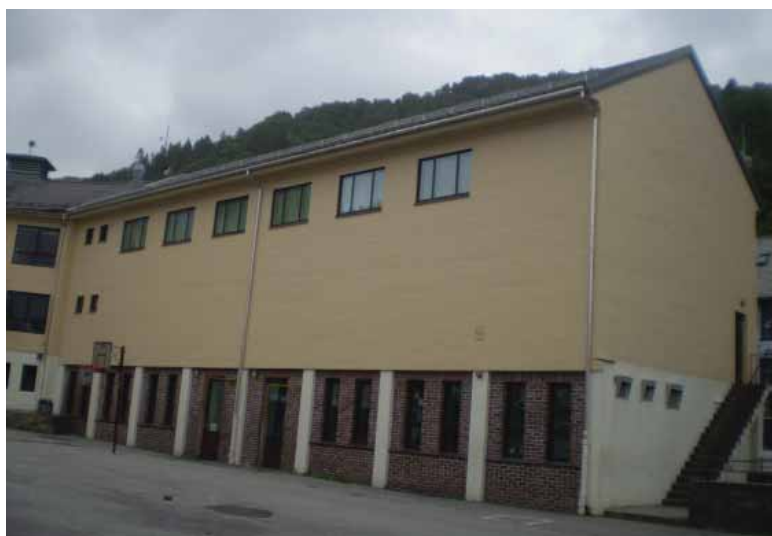
Sørfløyens fasade mot skoleplassen med sokkel i tegl. Den opprinnelige vindusrekken øverst på fasaden gir overlys til gymsal.
