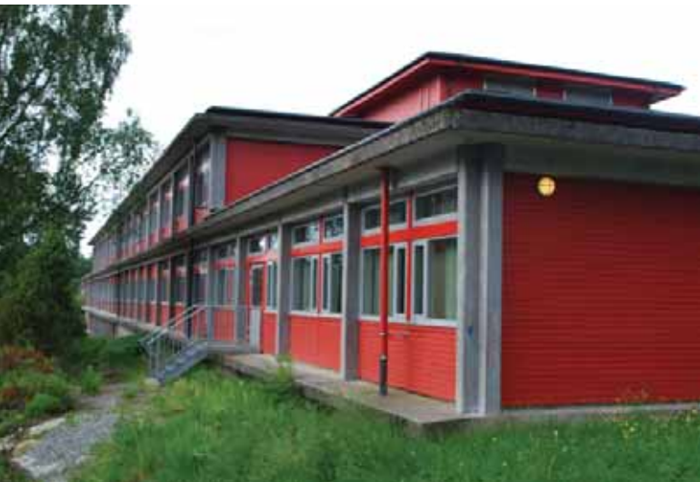
Fasaden mot øst, med vindusbånd, søyler og dekker i grid.
