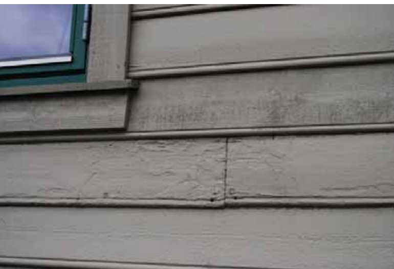
Noen autentiske kledningsbord, staffpanel.
