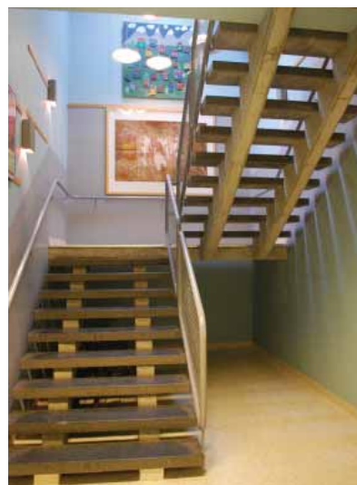
Ett av flere trapperom. Svevende trinn i slipt terrasse, kraftige vanger.
