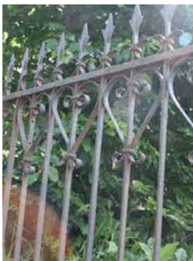
^ Smijersrekkverk på mur ved gymnastikkbygningen.
