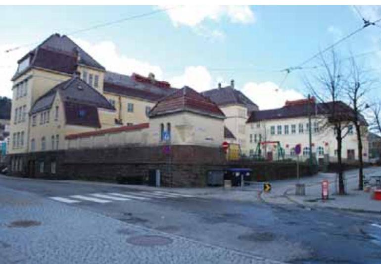
Anlegget sett fra Wolffs gate/Thormøhlens gate. Sydfløyen nærmest.
