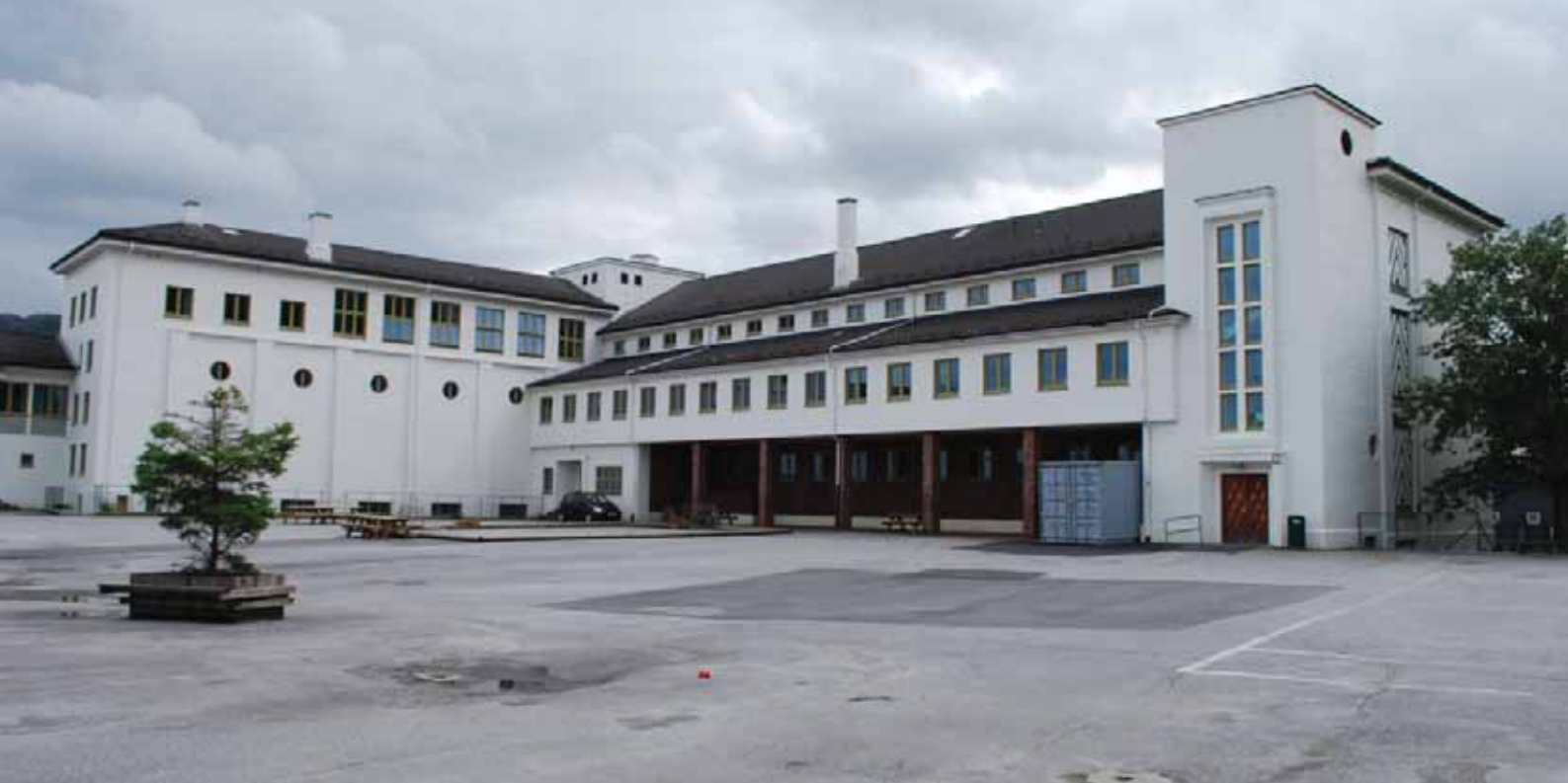
1952-delen sett fra skoleplassen i sør. Gymnastikkfløyen til venstre og klasseromsfløyen til høyre.
