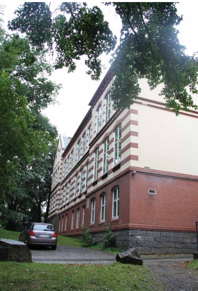
Hovedfasade mot sør-øst. Natursteinsmur i sokkel, tegl i første og dekorativ kombinasjon av puss og tegl i øvrige etasjer.
