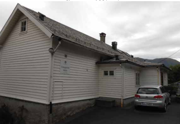
Opprinnelig volum vestfasade med bislag.
