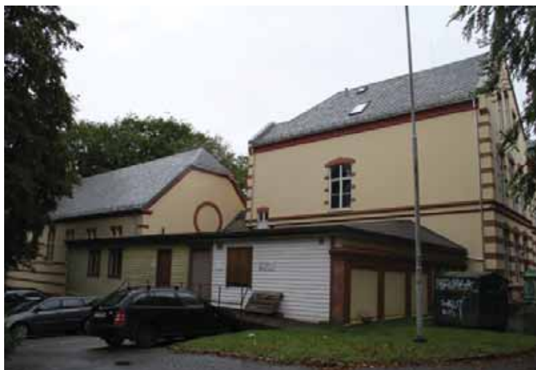
Gymnastikksal og hovedbygg sett fra vest, med tilbygg foran.
