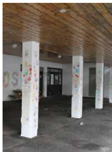
Leskur sør. Søyler i betong, himling i lakkett treverk.
