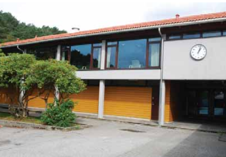
Fløy B, fasade mot sør. Intrukket leskur.
