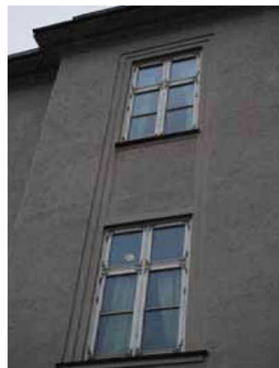
Over biinngang i sidefløy, vertikal detaljering i pussstruktur.
