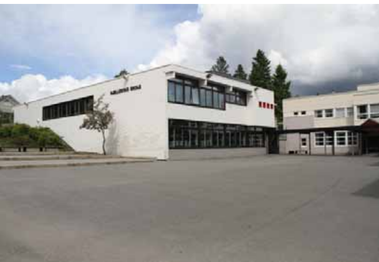
Undervisningsblokken (1971), fasade mot sør og øst.
