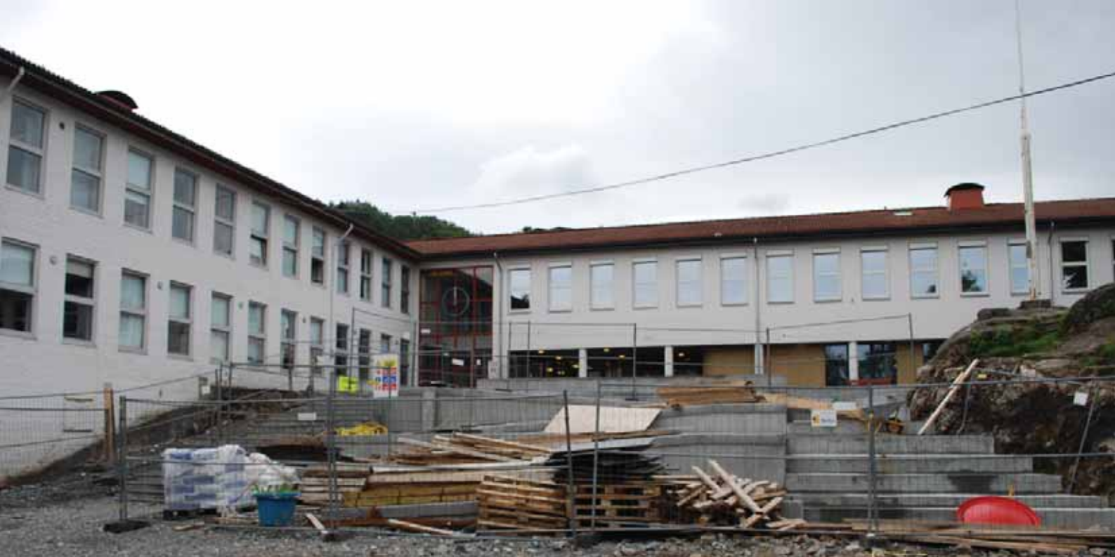
Skolegården har fra begynnelsen hatt to nivåer. Fløyene bindes sammen med en vesibyle med vertikalt glassfelt i fasaden.
