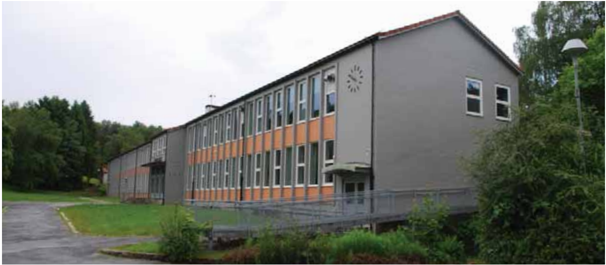
Fløy 1A: Hovedfasade mot veien. Vinduer i rastergrid med eksponerte søyler.
