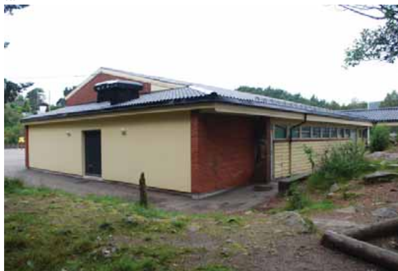
Garderobene (med vindusbånd) har fått pulptak som en forlengelse av saltaket på Gymnastikksalen. Tilbygg til venstre.
