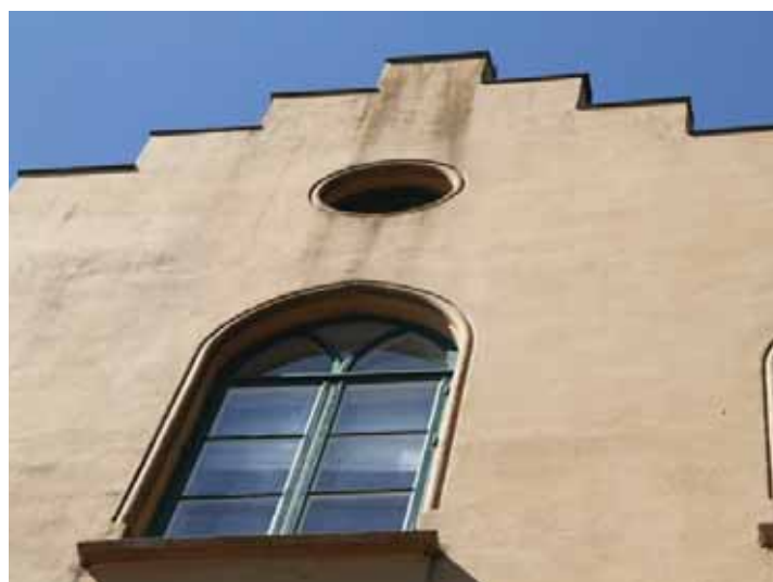
Detalj bygg sør. Trappegavl og spissbuevinduer fra ombyggingen ca. 1874.
