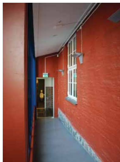
Ny rampe anlagt på utsiden av fasaden.
