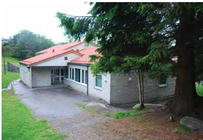
Vaktmesterboligen sett fra øst med gymnastikksalen i bakkant. Tilbygg fra 1997 midt på.
