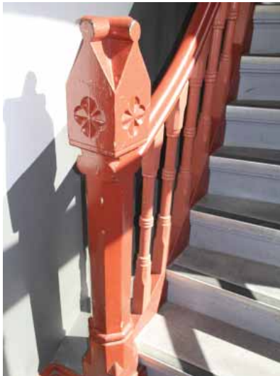
Bygg nord: Rekkverk i nygotikk.
