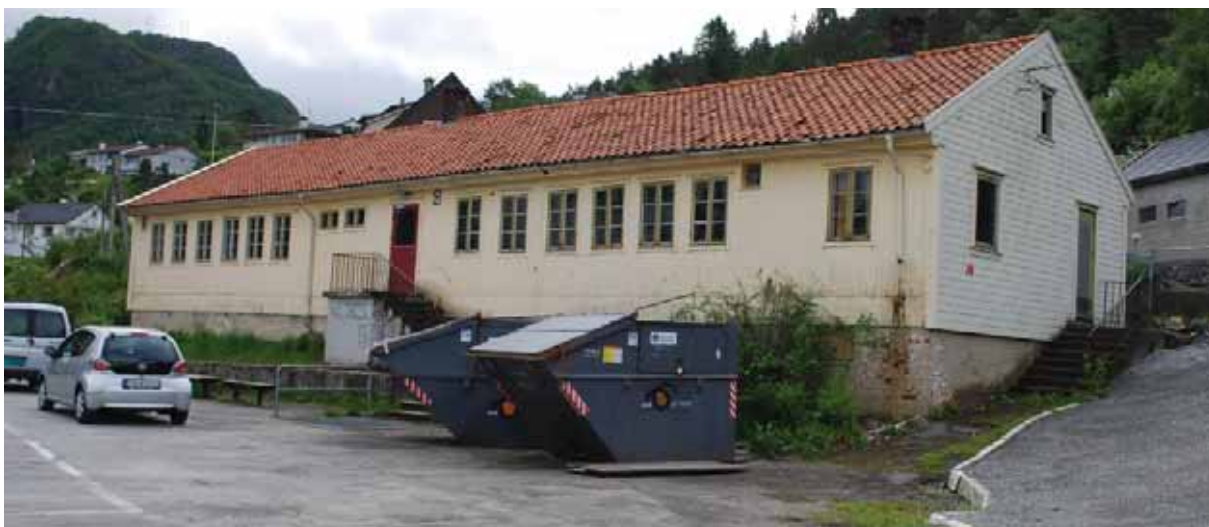
Tyskerbrakken fra 1940. Stor grad av autenticitet i fasader.
