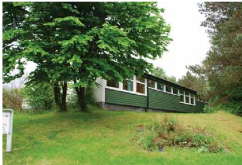
Administrasjonsfløyen sett fra nord-øst.
