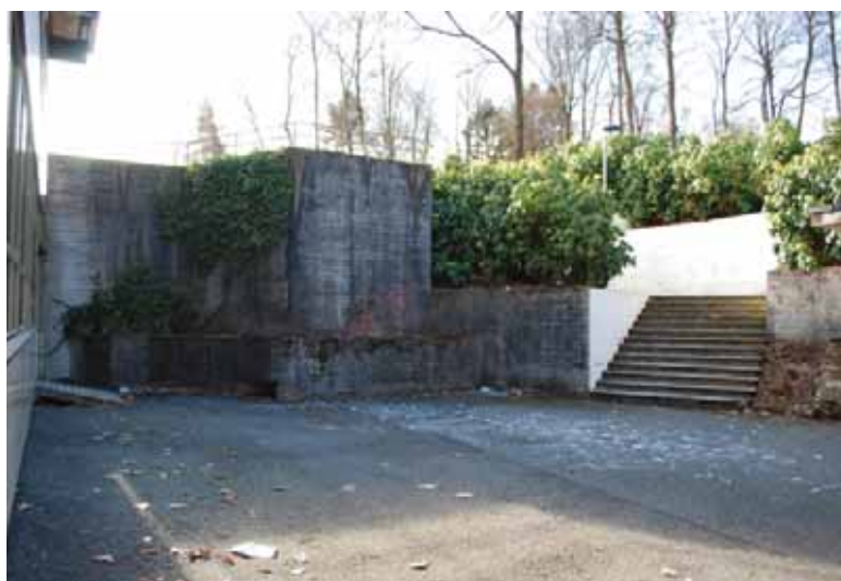
Fundamenter "kommer ut" fra skolebygningen og bearbeider høydeforskjellene med murer og trapper.
