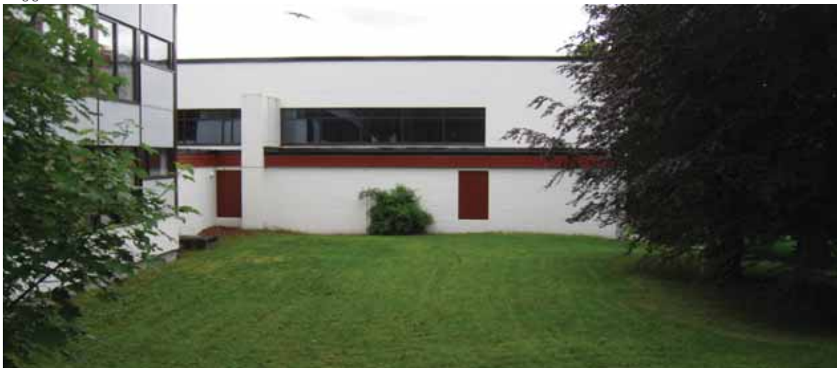
Gymnastikkbygningens fasade mot nord, med lavere del med lagerrom.
