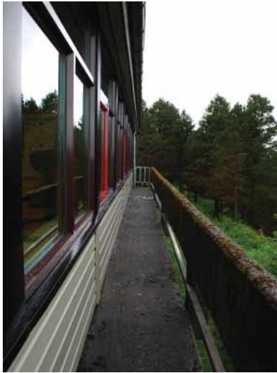
Utkragende betongdekker som balkonger. Rekkverk i råbetong.
