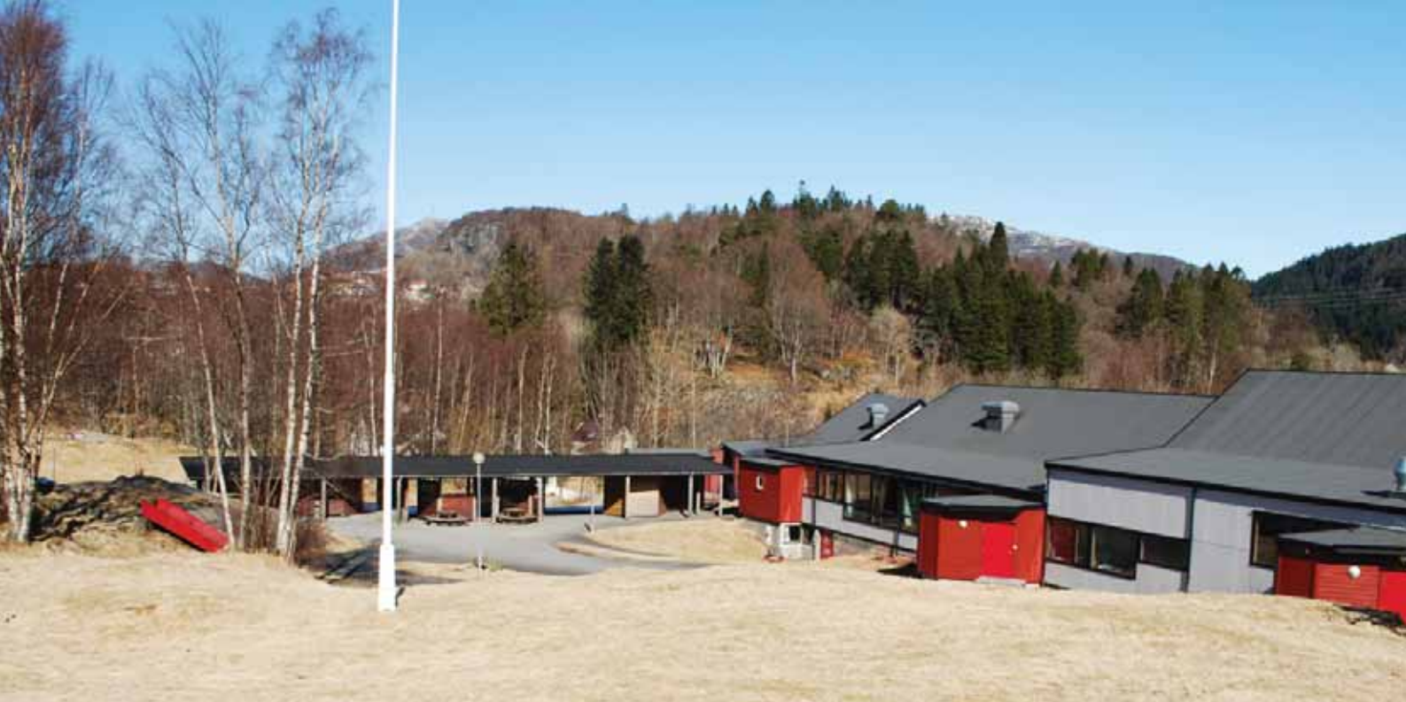
Leskuret til venstre og deler av hovedbygget til høyre sett fra marken i sør-øst.
