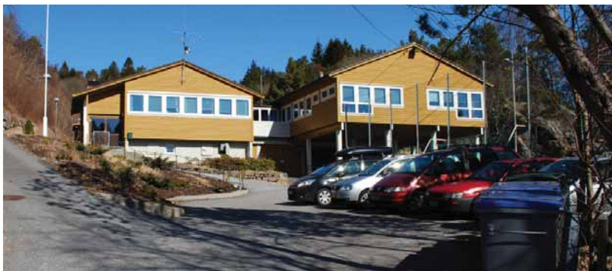
Fasader mot sør. Opprinnelig klasseromsfløy til venstre med vindusbånd. Administrasjonsfløy fra 1990 til høyre, formlik men med mer varierte vindusutforming.
