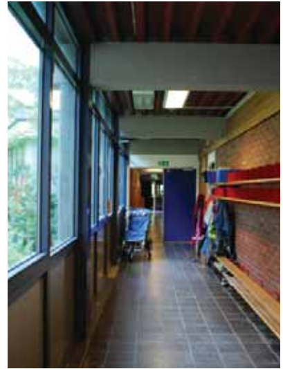
Synlig drager i taket og søyler gjennom glassfelt, i korridoren.
