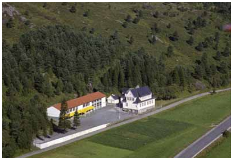
1961: Ny fløy ble oppført i 1960, typisk for sin tid: Langstrakt, terrengtilpasset volum, med saltak og vindusbånd. Området er fremdeles landlig. (Fotonr: 051318)
