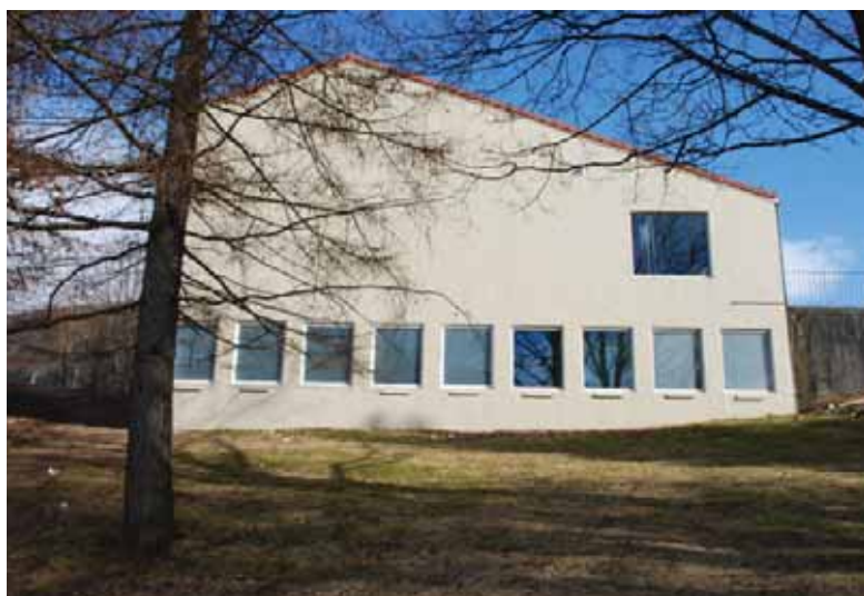
Gymnastikkbygningen (1965) fra vest.
