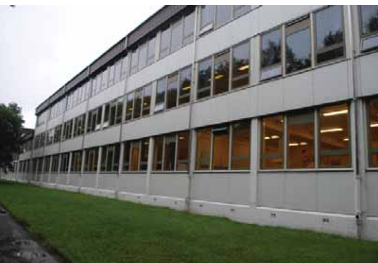
Klasseromsfløyens østre fasade er i tre fulle etasjer med søyler og vindusbånd.
