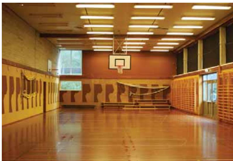
Råbetong med akustikkplater nederst. Synlig søylekonstruksjon i sørvegg.
