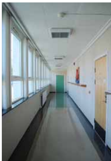
Korridor 2. etasje, kl.fløy (1966). Sløydslsal i midten, grønn dør.
