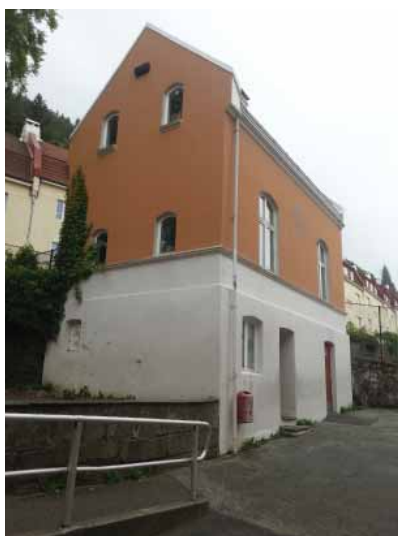
^ Vaktmesterboligen (1894) sett fra vest, øvre skoleplass.
