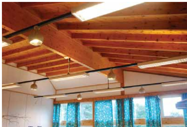
Synlig takkonstruksjon i interiør.
