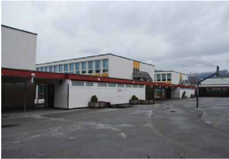
Toalettbyggene under leskuret skjerner atriumene i hovedbygningen.
