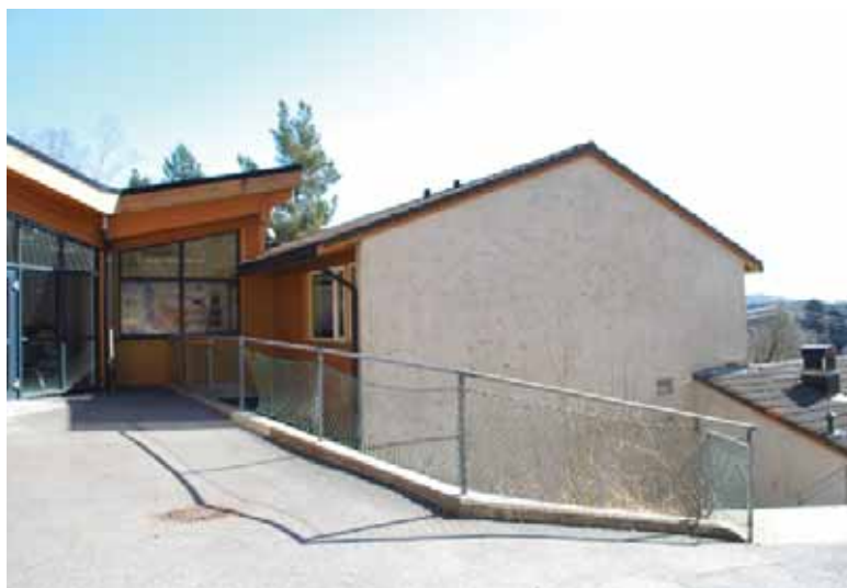
Idrettsbygget (2004) bygger inn deler av aktivitetsromfløyens fasade mot nord. Øvrige fasader er godt bevart.
