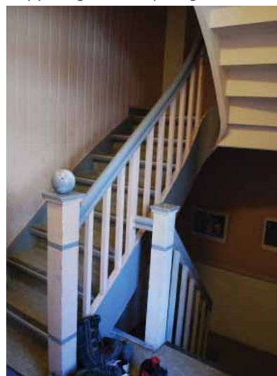
Den ene av to trappeopp ganger.
