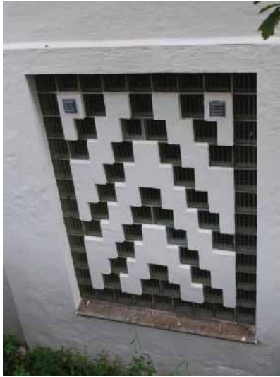
Glassbyggersteinsvindu i fasade sør-vest. Klasseromsfløy (1952).
