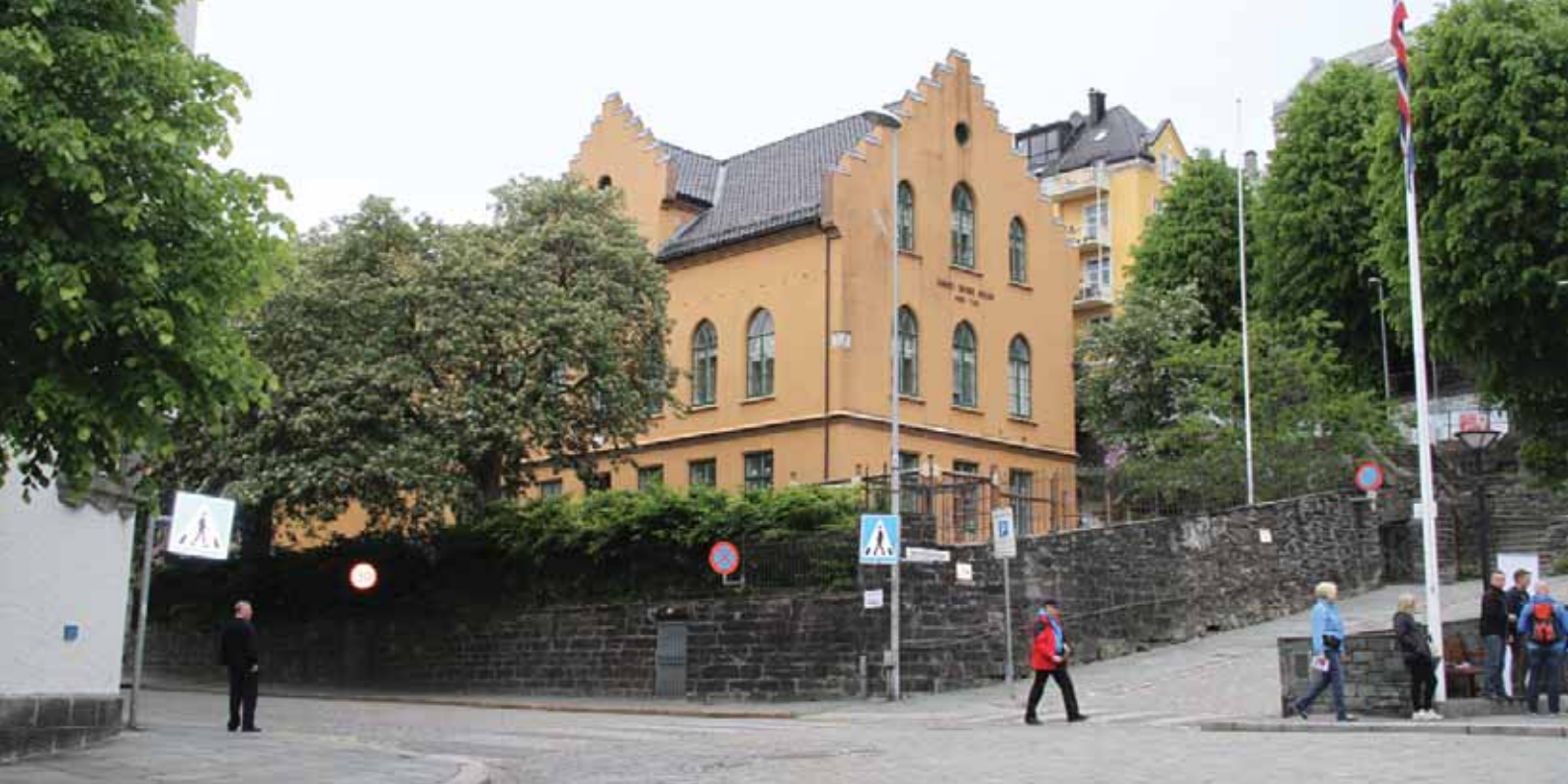
Bygg sør (1740) sett fra sør.
