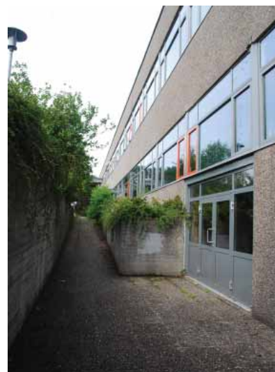
Rampe ned til kjelleretasjen.
