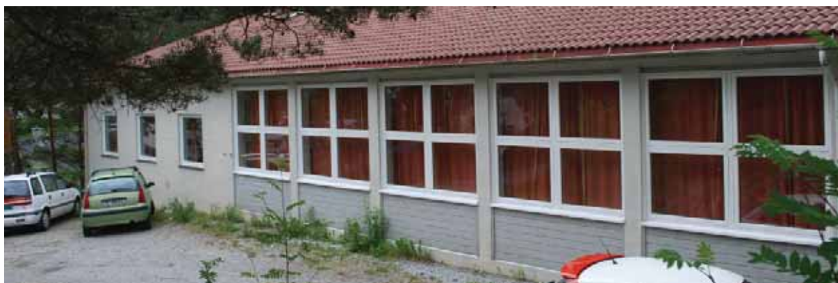
Klasseromsfløyen (1963) mot øst. Betongsøyler i fasaden. Vinduer og brystning er skiftet, ny inndeling.
