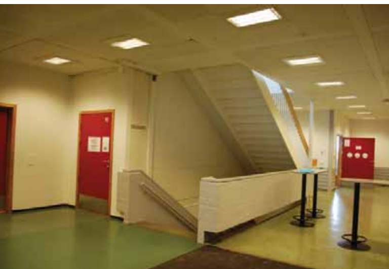
En av to trapper i hovedbygget (1971). Utført i plasstøpt betong. Trapp opp nyere i enklere materialer.
