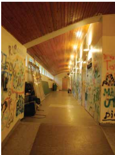
Korridor. Buet himling i tre. Overgang mellom 1956-fløy og 1968-fløy, trapper erstattet med ramper.
