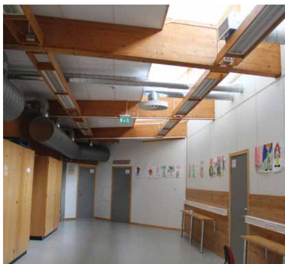
Korridor, bygget inn. Eksponert konstruksjon og ventilasjon.
