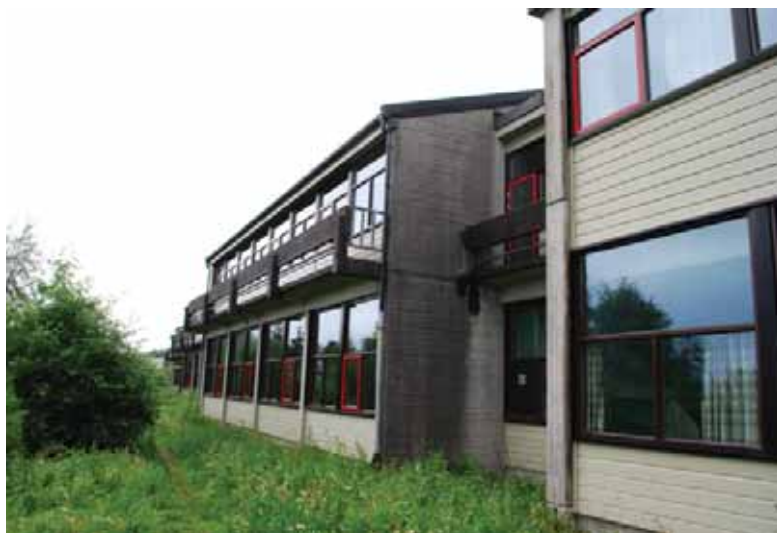
Anleggets fasade mot nord og vest har utragende balkonger med kraftige rekkverk i betong.
