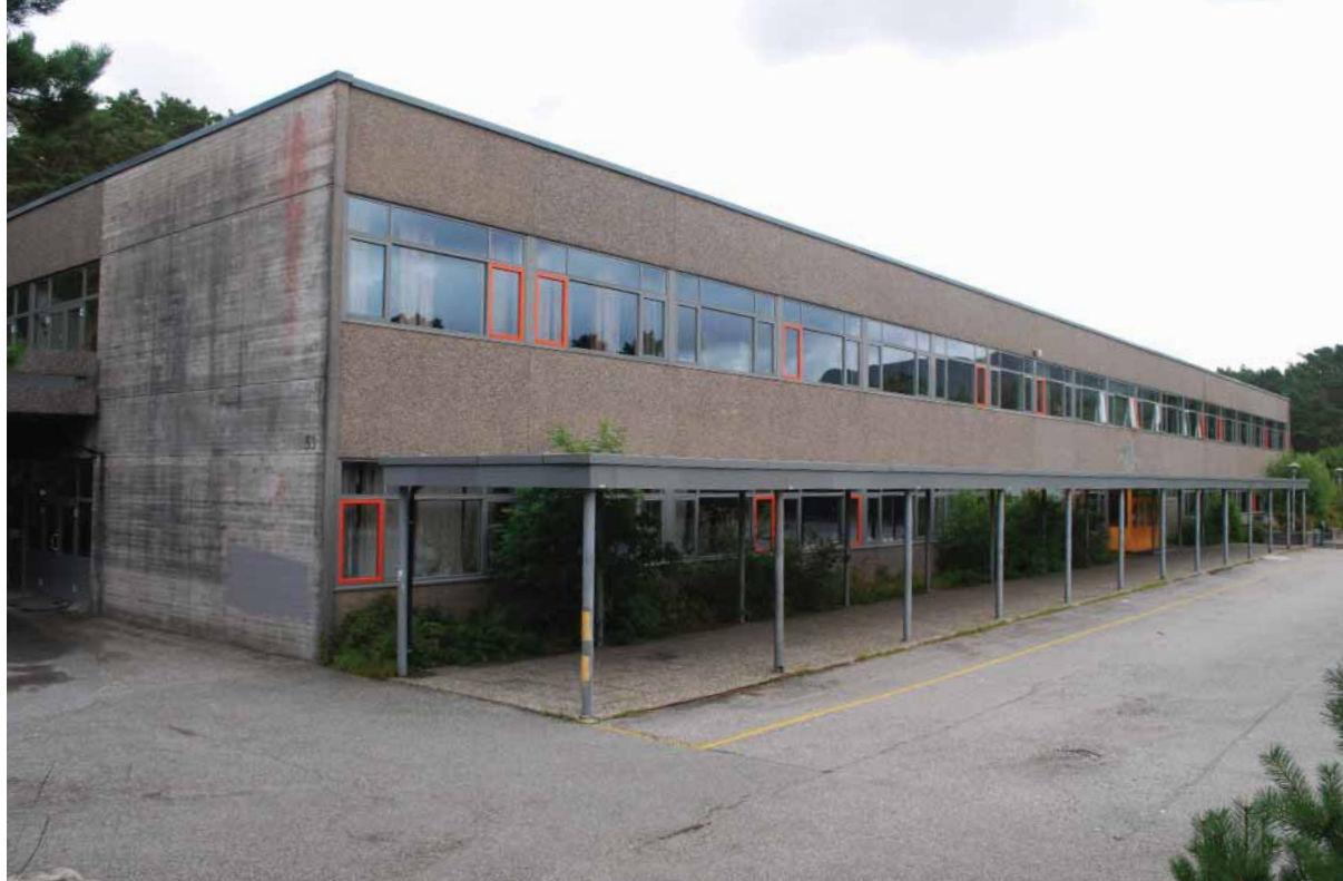
Strengt, rektangulært volum med vindusbånd. Umalt betong og steinplater er viktige for fasadeuttrykket. Frittstående leskur langs hovedfasaden mot skoleplassen i sør.
