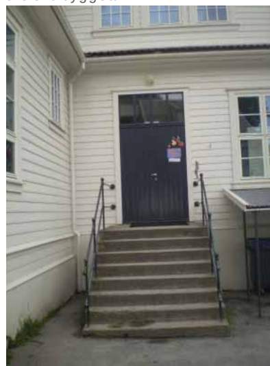
Utvendig steintrapp i Gamleskolen.
