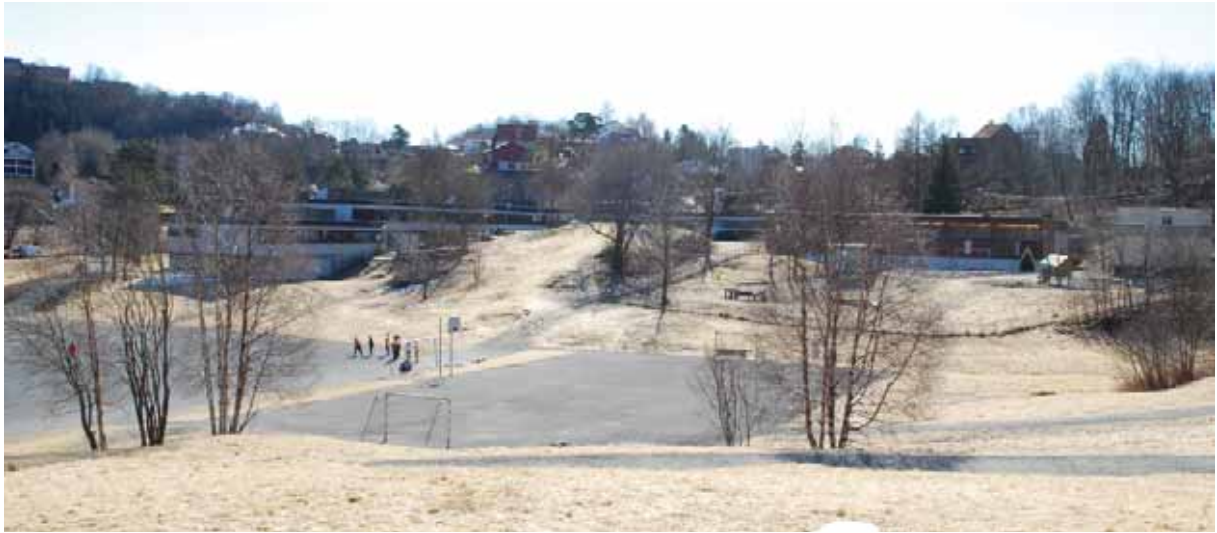
Skoleanlegget, sett fra nord-vest, tilpasser seg det kupperte landskapet med horisontale, overlappende volumer.
