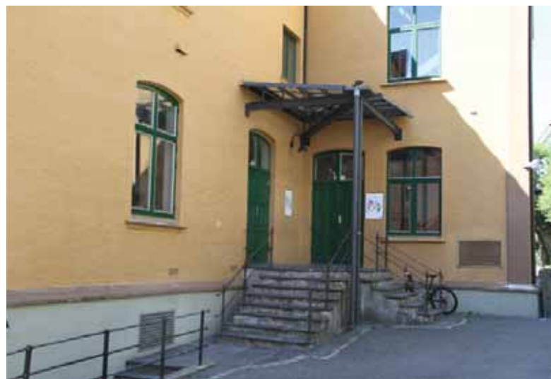
Fasade mot nord-øst: Inngangsparti med to dører og trapper med skiferstein og smijersrekkverk. Nyere overbygg.
