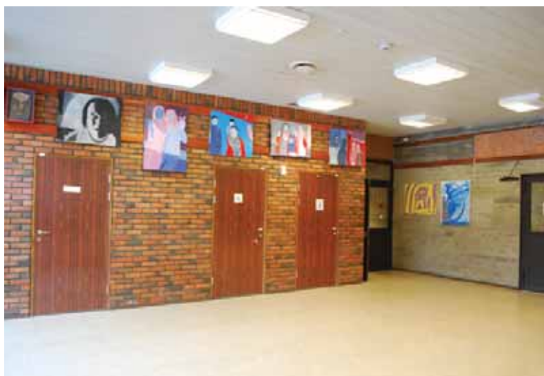
Vegger i tegl, råbetong. Foaje 1.etg.
