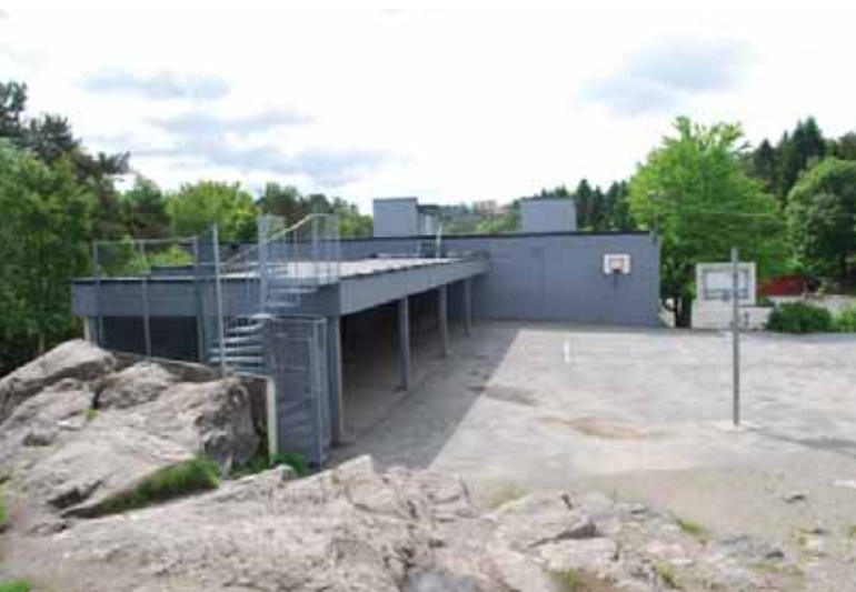
Hovedbygget (1971) fra nord, leskur.
