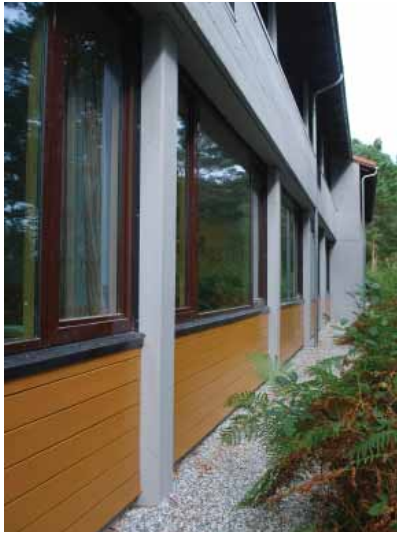
^ Fløy A, fasade mot øst. Lesbar konstruksjon, vindusbånd og panel i brystning.
