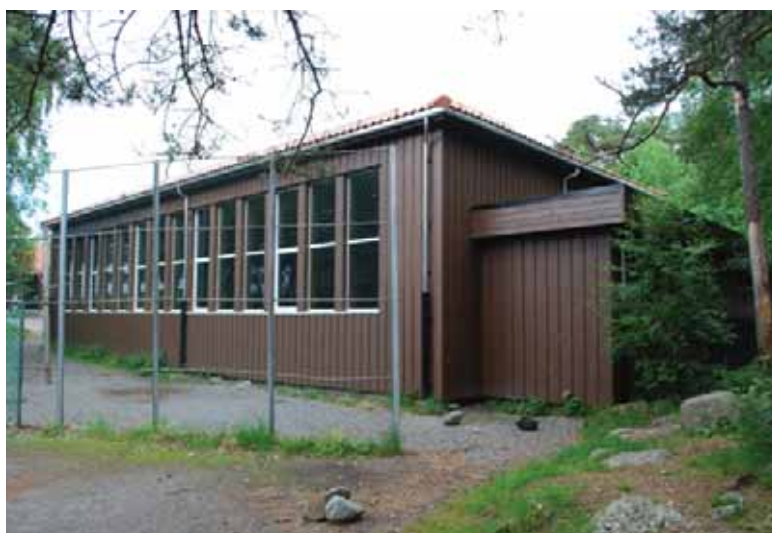
Gymnastikkbygningen. Høye vinduer i gymsal.
