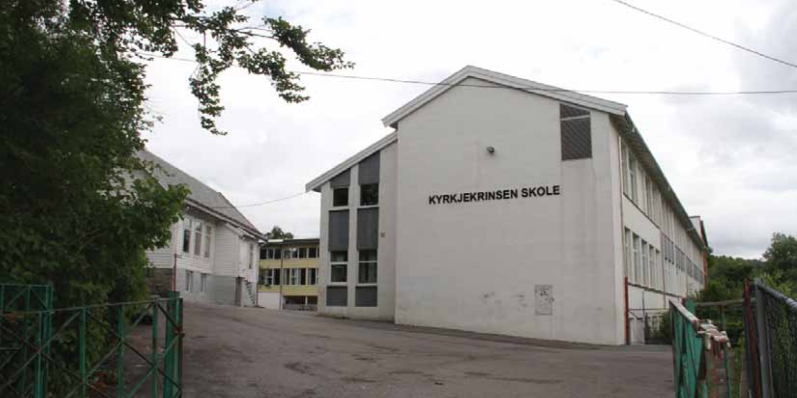
Sett fra vest. Gamleskolen(venstre), 1958-fløyen(høyre), deler av nyere tilbygg ses i mellom.
