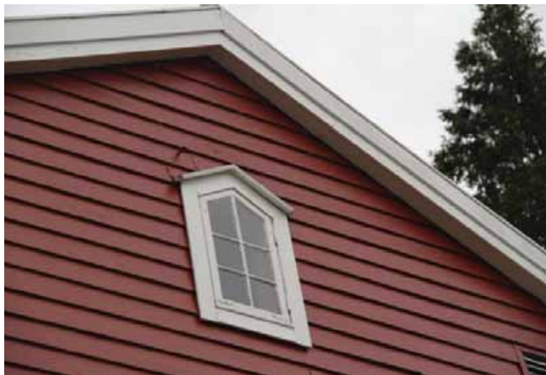
1952-delen: Opprinnelig vindui gavl mot nord.
