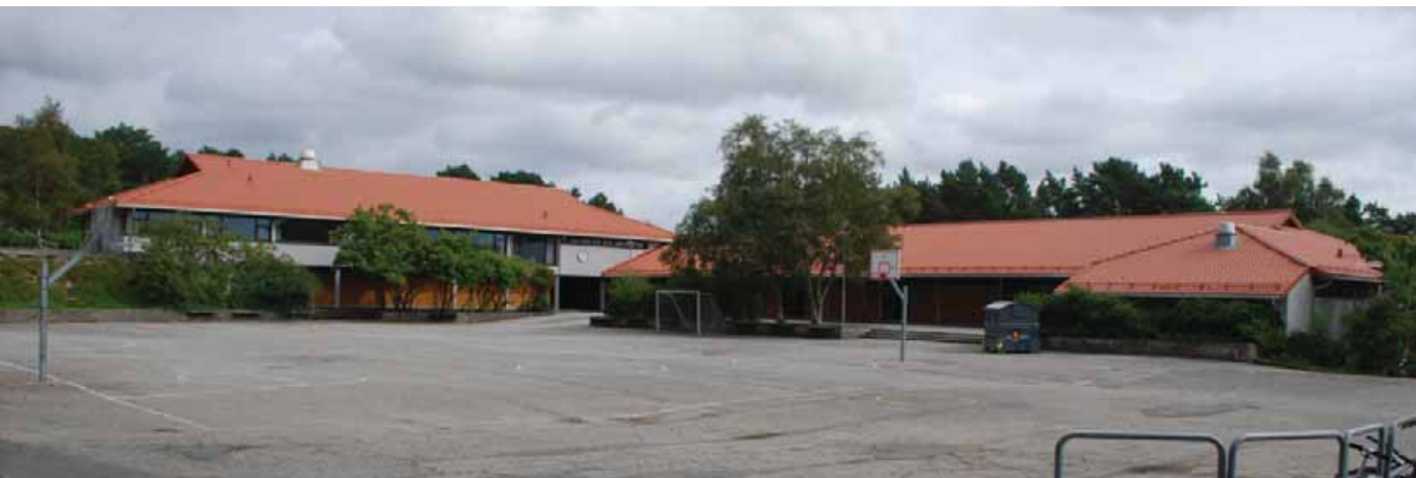
Fløy B og A sett fra søndre skoleplass. Svært god terrengtilpasning og menneskelig skala, i én etasje med lave valmtak og sokkel.
