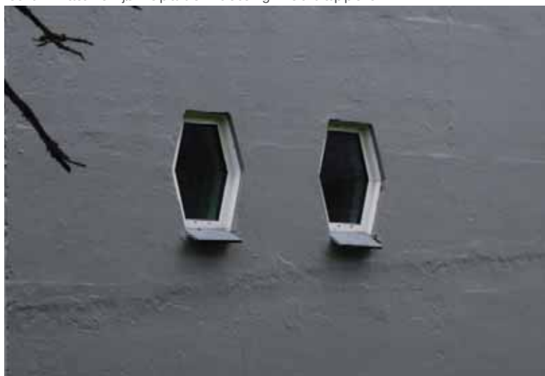
Fløy 1A: Sekskantede vinduer i fasaden mot skogen i vest.
