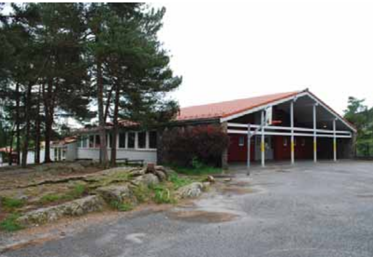
Nordre fløy har tilbaketrukkede vegger som danner et leskur.
