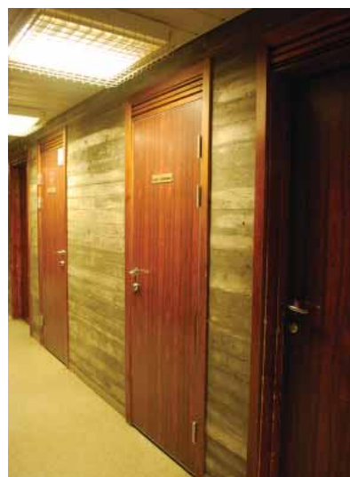
Råbetong og laminatdører i korridor.
