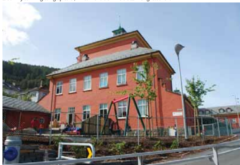
Sidefløy i øst sett fra øst.
