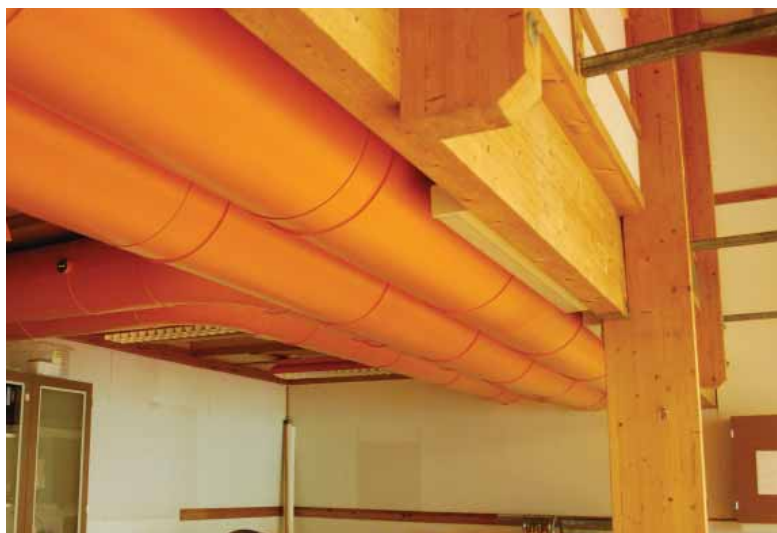
Ekspoonerte ventilasjonsrør.
