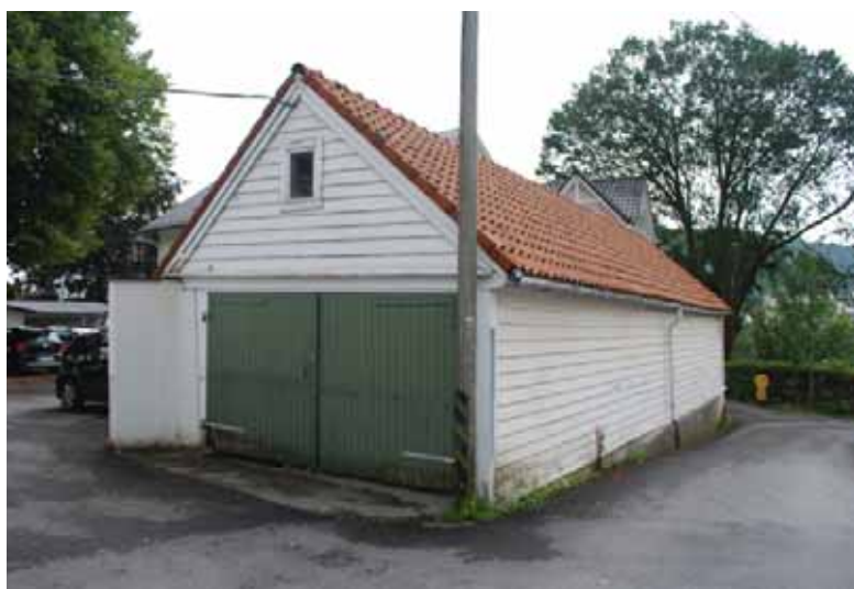
Vognhuset sett fra nord-øst.
