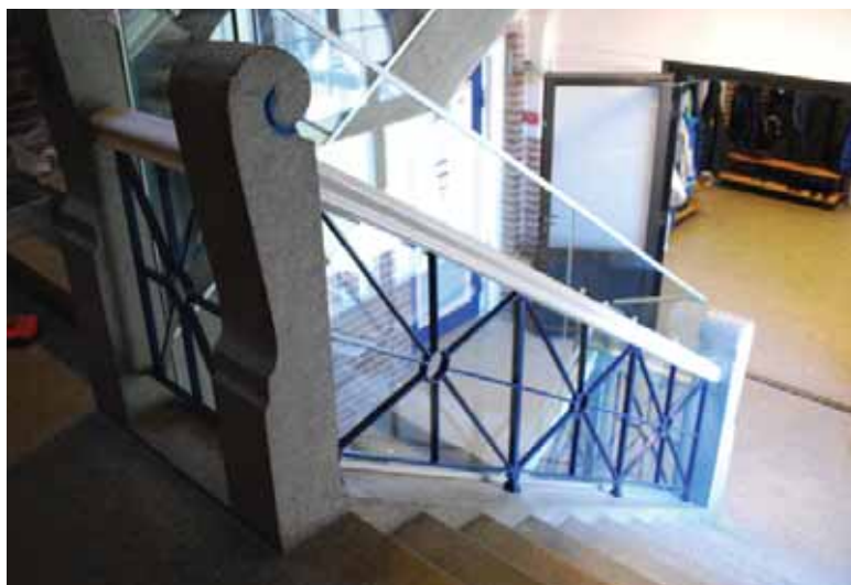
Rekkverket er i smijern med håndløper i tre. med nyere helglass som ekstra sikring festet på utsiden.
