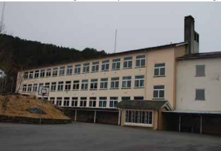
1954-anlegget, bygg 1A.
