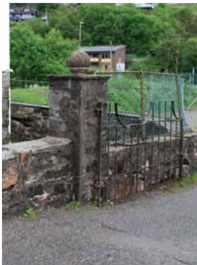
Murt gjerdestolpe med kule. Jernport inn til skoleplassen.
