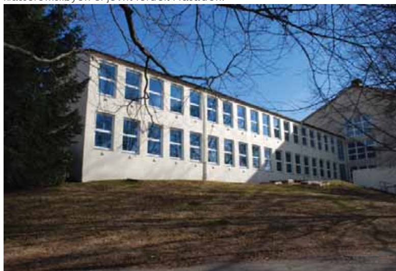
Klasseromsfløy 1b (1971): Vinduer mot tveitevannet i vest.
