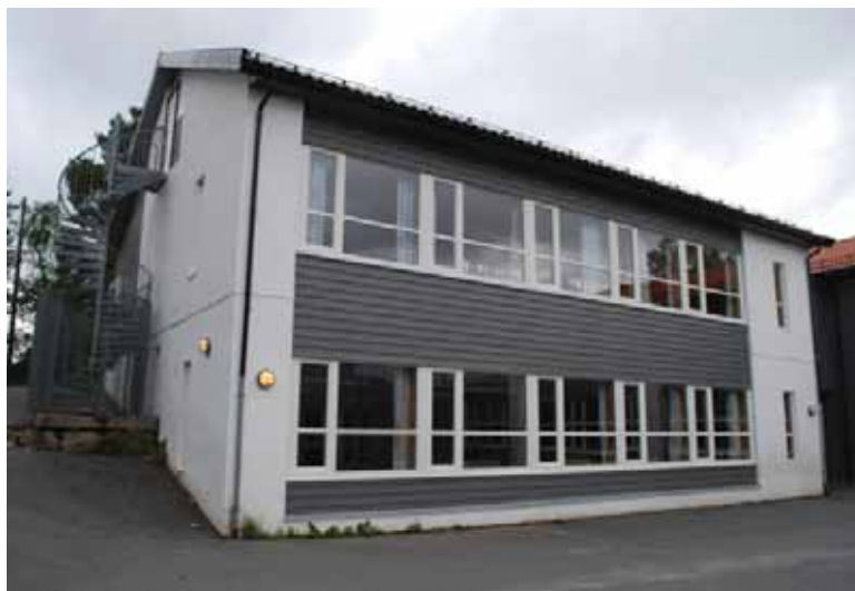
Ny fløy (2004). Fasade mot sør-øst. Fløyen tar opp den opprinnelige delens fasadeuttrykk.
