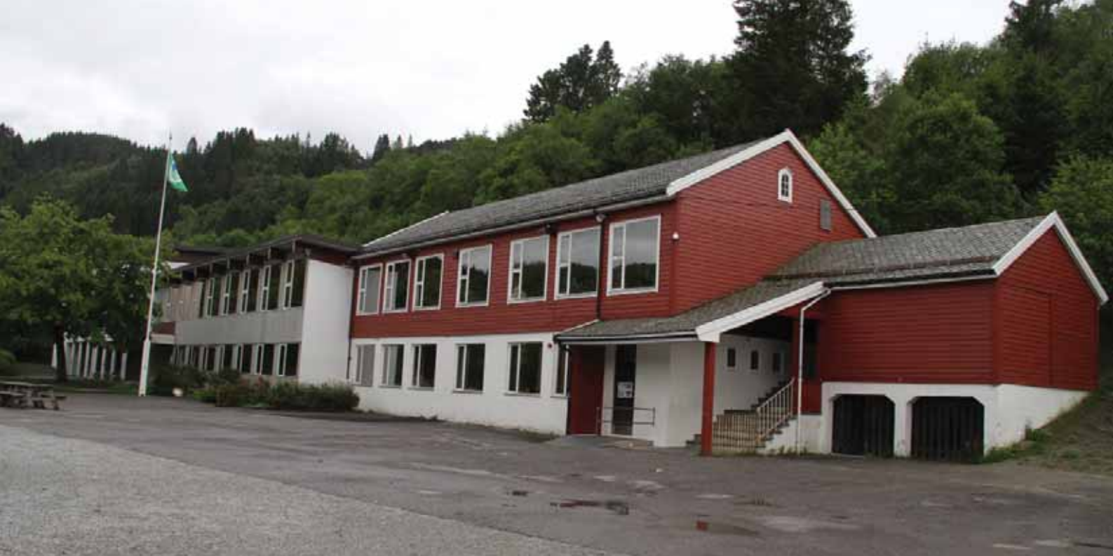
Anlegget sett fra nord-øst: 1952-delen med skifertekket tak, rødmalte fasader og pusset sokkel. 1919-delen med flate tak, utkragende gesims og platekledning.
