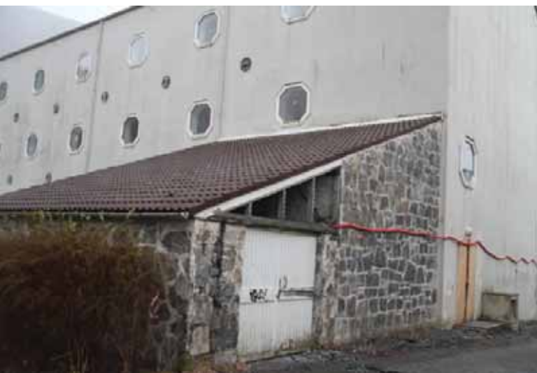
Opprinnelig bodtilbygg på nordfasaden.
