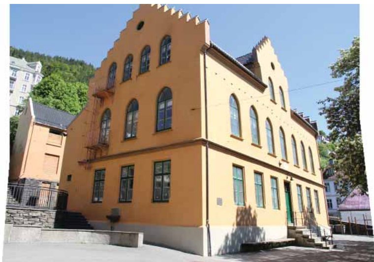
Bygg sør sett fra vest.
