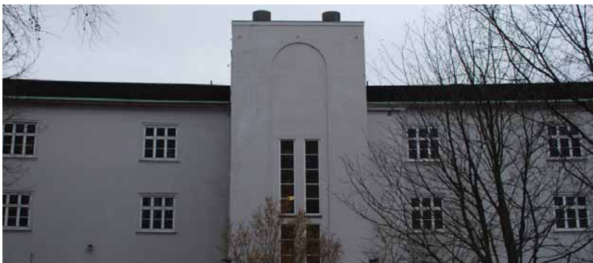
Hovedfløyens midtparti, her fra baksiden mot nord-øst, er fremskutt i fasaden. Innenfor er det trapperom.
