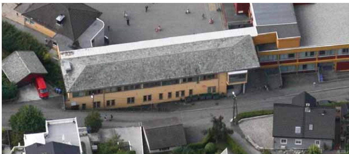
Tilbygg (2002) sett fra øst. Muligens bevarte bygningsdeler eller gjenbruk av skifer fra gymnastikkbygningen (1941).
