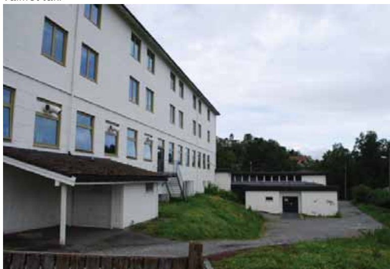
1958-fløyens fasade mot nord har vinduer rytmisk fordelt. Kvadersteinsimitasjon i sokkeletasje. Gymnastikkbygg (1970) og garderobebygg (2007) som lavere volum. kolebygg fra 1724 til 1979
