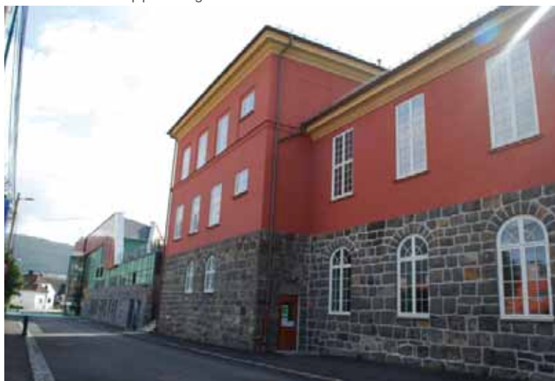
Anleggets fasader mot Rogagaten i nord. Gråsteinsmur og buede vinduer i sokkel.
