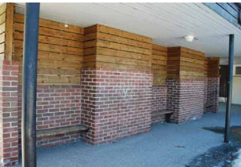
Opprinnelige teglvegger og benker i leskur.
