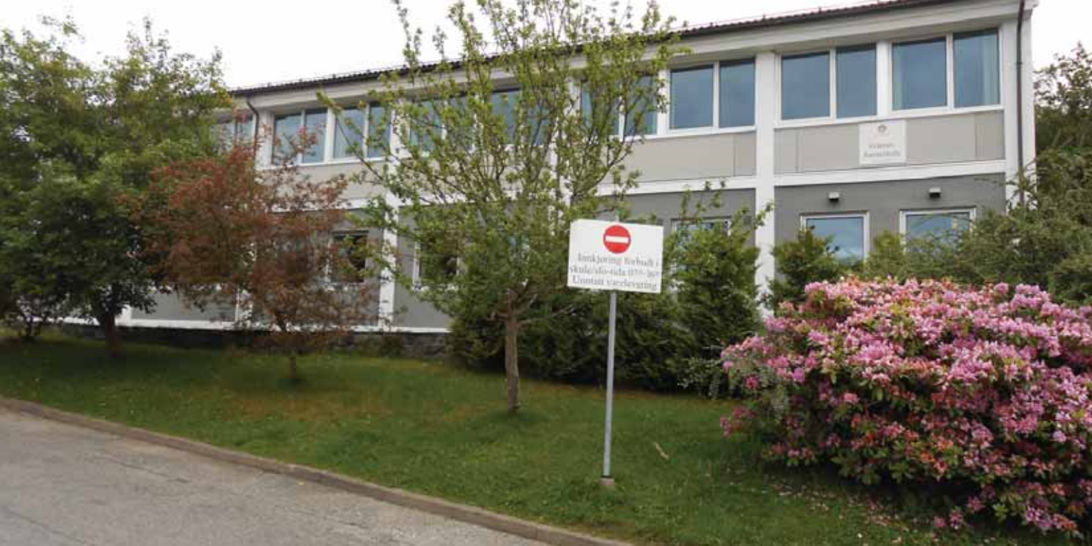
Bygg sør (1961): Sasade mot veien i vest med rastergrid, horisontale vindusbånd i første og andre etasje, platet brystning.
