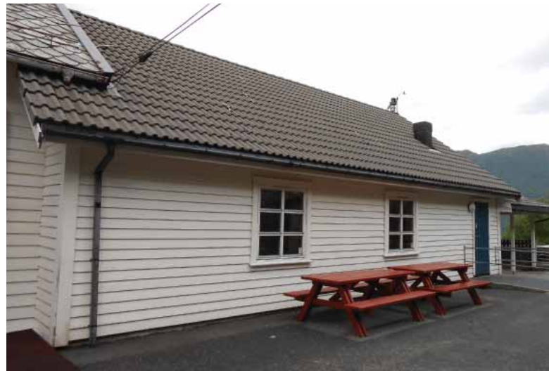
Tilbygg 1988 vestfasade. Samme type vinduer og kledning som opprinnelig volum, men annen taktekkning og breiere hovedform.
