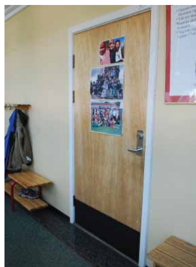
Autentiske enkeltdører i hele anlegget.
