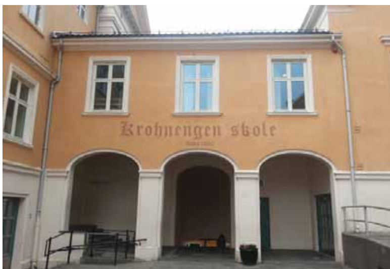
Tilbyggets mellomvolum (1933) med bueganger og trapp til nedre skoleplass.
