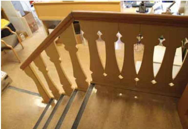
Bygg sør: Bevart rekkverk.
