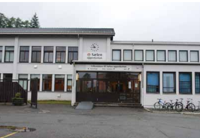
Inngangsparti. 1954-fløyen til venstre, med lesbar konstruksjon.
