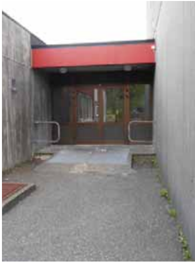
Inngang mellom blokk B og C.
