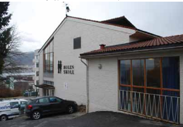
1959-anleggets fasade mot vest, bygg 2A og 2B. Autentiske vinduer, faste felt med karmen i tre. 1960-talls rekkverk.
