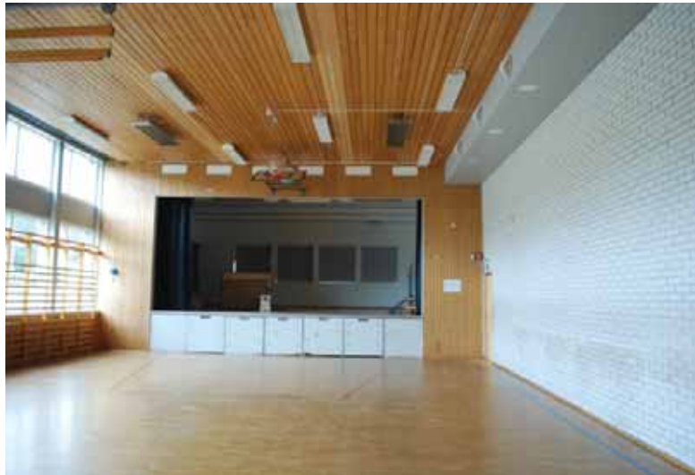
^> Gymnastikksalen (1970) er typisk for sin tid, med furupanel, scene og parkettgulv.
