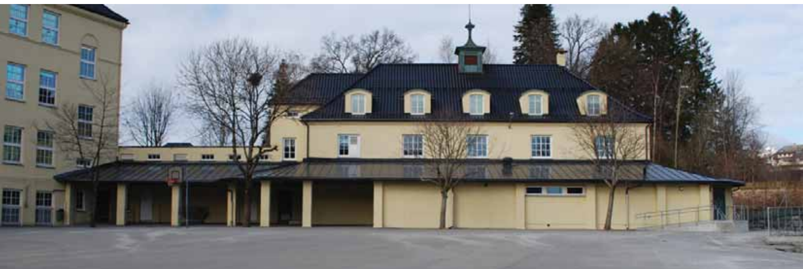
Gymnastikkfløyen fra skoleplassen i sør. Leskuret går fra klasseromsfløyen og rundt gymnastikkfløyen. Tilbygg under deler av leskuret.
