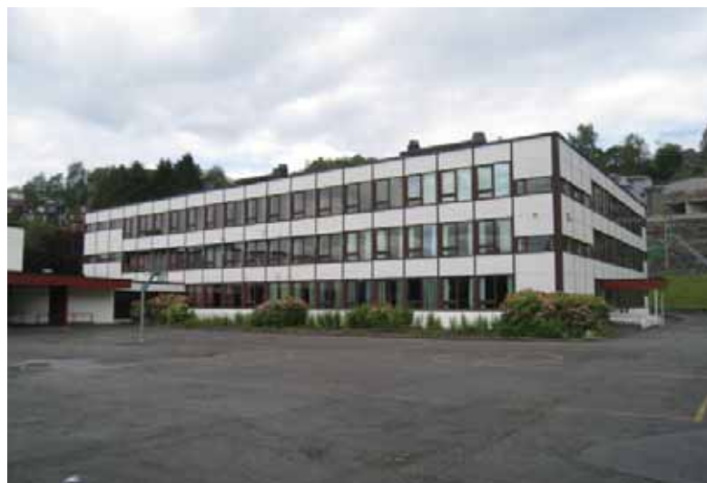
Det største volumet sett fra skoleplassen i sør.
