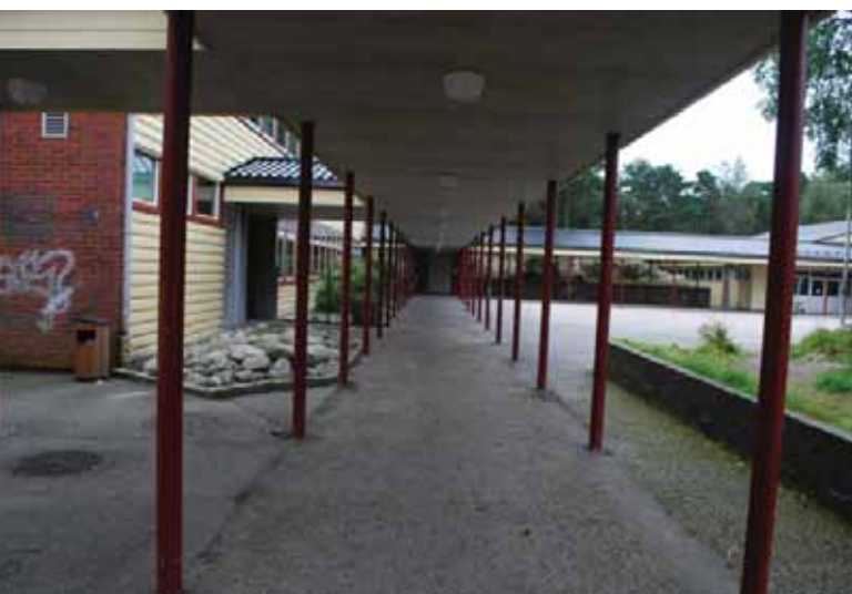
Leskuret er trukket ut fra fasadenene, og kobler sammen alle bygningene.
