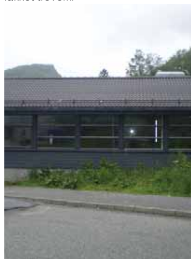
Vindusbånd på tilskuddsbygg.
