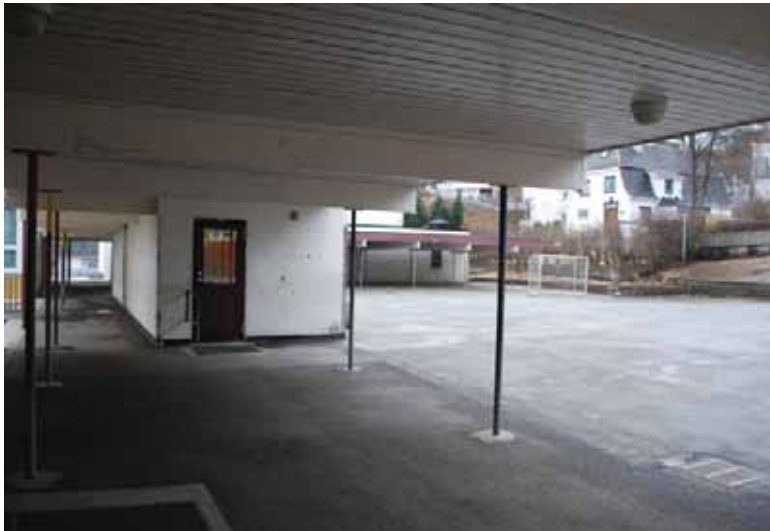
Leskuret er opplagret på tynne søyler og kraftige dragere.
