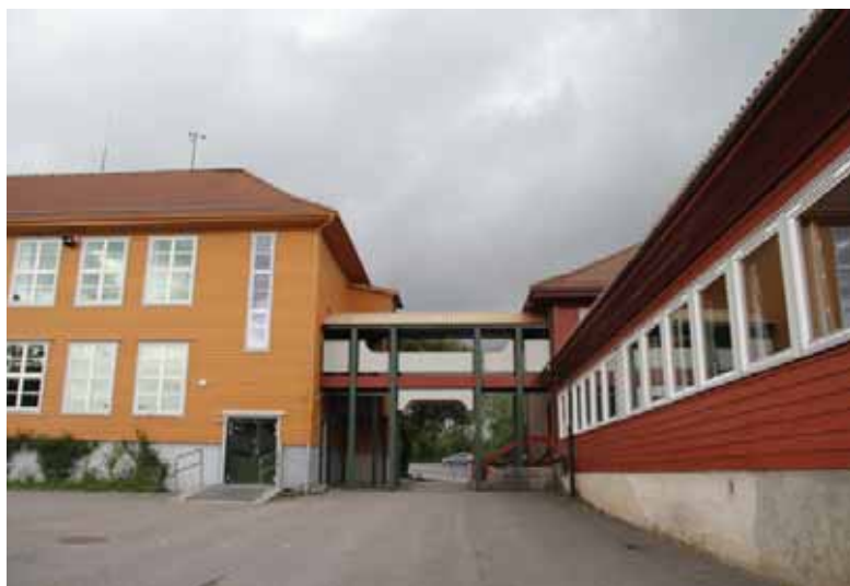
Gangbro mellom gamleskolen og tilbygg til gamlepaviljongen.
