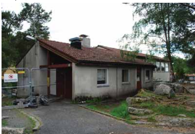
Vaktmesterboligen i nord, gymsalen i bakkant. Tilbaketrukket inngangsparti.
