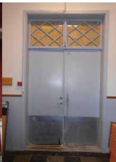
Døren sett fra innsiden. Forblendet overflys med autentiske sprosser.
