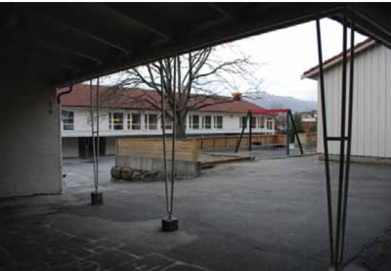
1959-anleggets hovedbygg 2A til venstre og paviljong 2D sett fra leskuret i paviljong 2C.
