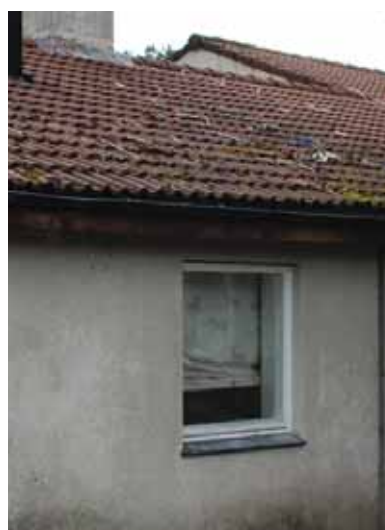
Vindu med skiferplate.
