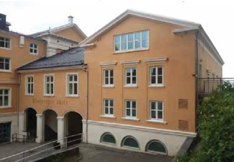
1933-fløyen sett fra øst. Fløyen har stilkopierende trekk som passer godt til hovedbygget.
