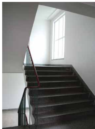
Ett av to trapperom i 1958-fløyen. Trinn i slipt terrasso og enkle metallrekkverk.
