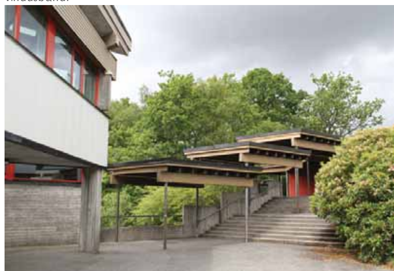
Leskur, flate tak understøttet av trebjelker og søyler, trapper seg opp mot hovedbygget.
