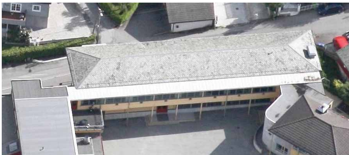
Tilbygg (2002) sett fra vest. Langsgående påbygg med flatt tak kobler tilbygget til hovedbyggets administrasjonsdel.
