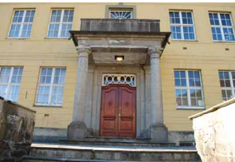
Inngangsparti med søyler i granitt. Horisontale trekninger i pussen i sokkeletasje.
