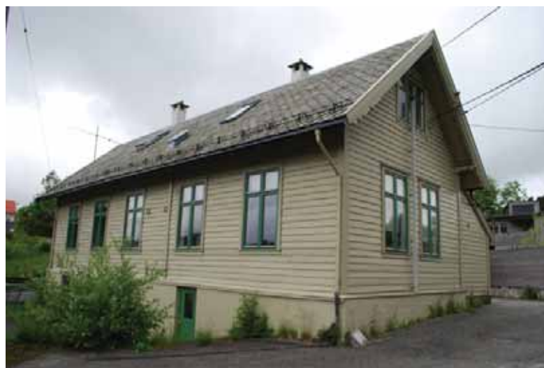
Fra veien i sør fremstår skolen som opprinnelig.
