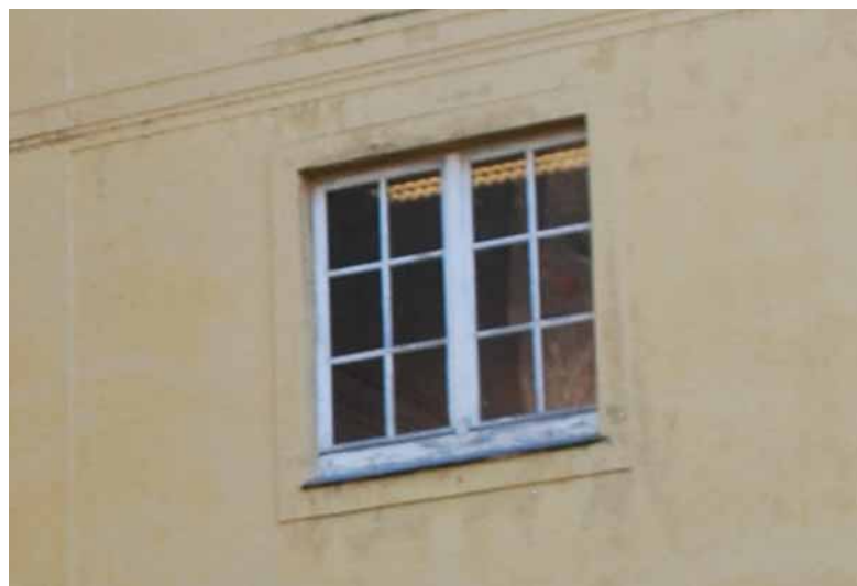
Gamle vinduer i fasaden mot skoleplassen. Pussvariasjoner artikulere vinduer og gesimser.
