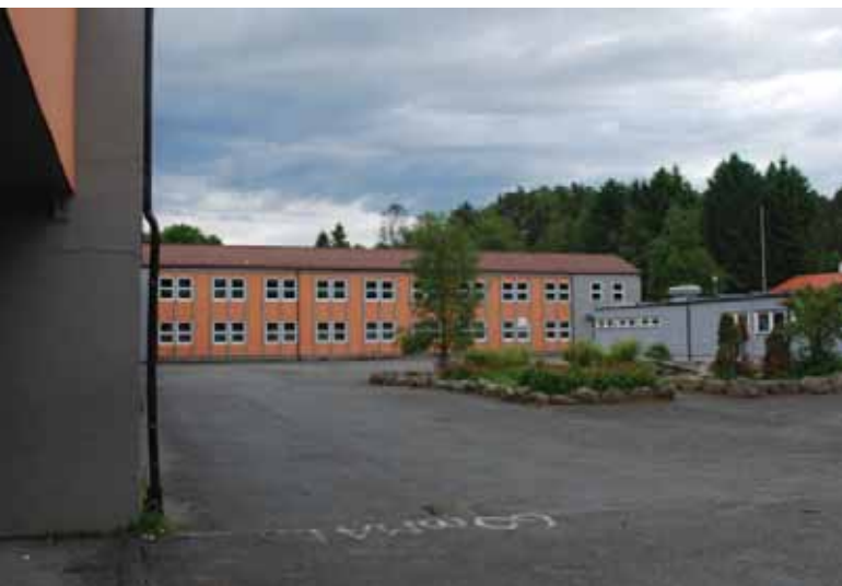
Fløy 1A: Fasade mot skoleplassen i øst, betongsøyler.
