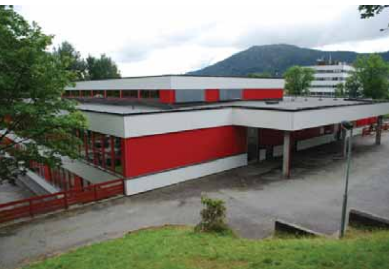
Hovedbyggets nordfasade. Inngang under leskur.
