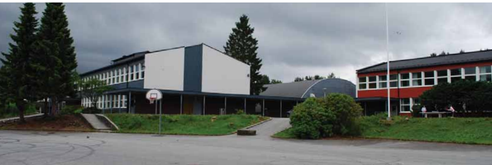
Nøye avstemt helhet, med vertikale felt i gavler og horisontale leskur og vindusbånd. Opparbeidet grøntareal bevart etter arkitektens tegninger.
