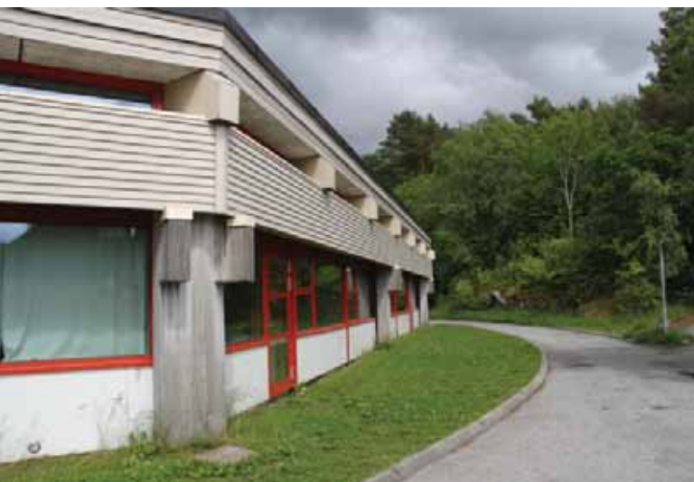
Hovedbyggets østre fasade. Konstruksjonen er viktig for fasadeuttrykket. Dragerne og bjelkene er kledd inn.
