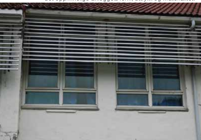
Gamle vinduer i det østre tilbygget (1968).
