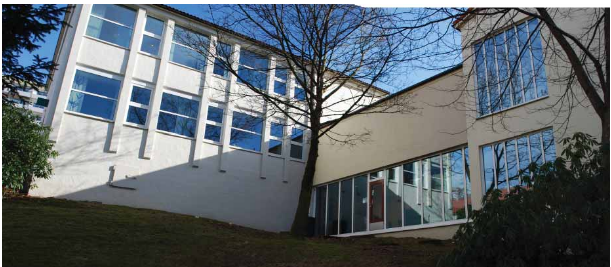
Mellombygning (1971) som kobler sammen administrasjonsbygg og klasseromsfløy (1971). Vindusbånd kontrasterer med de mer lukkede fasadene ellers i anlegget.
