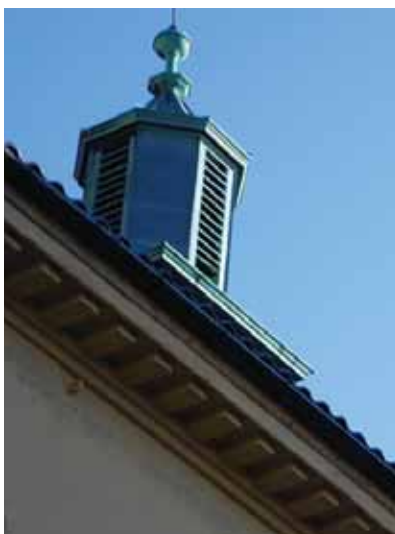
Klasseromsfløyen har koppertekket tårnhjelm med spir og tannsnittbord.
