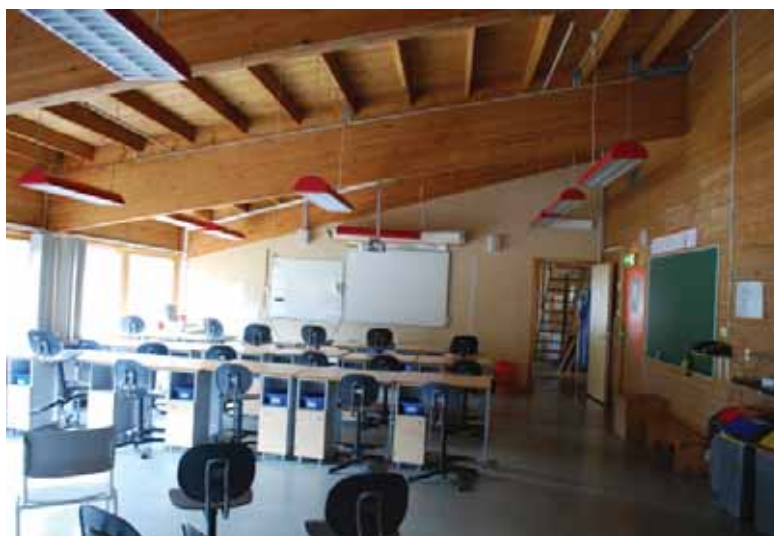
Bjelker i taket i klasserom.
