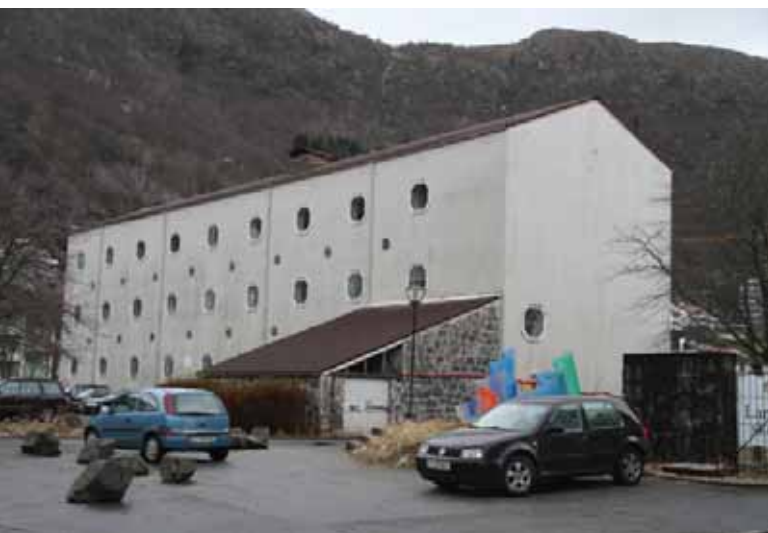
Høyblokkens fasader mot nord og vest.
