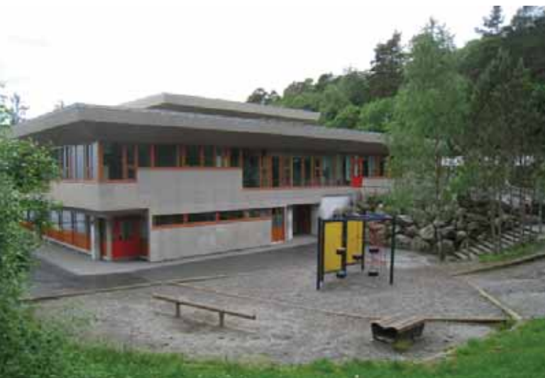
Hovedbyggets fasader mot øst og nord.
