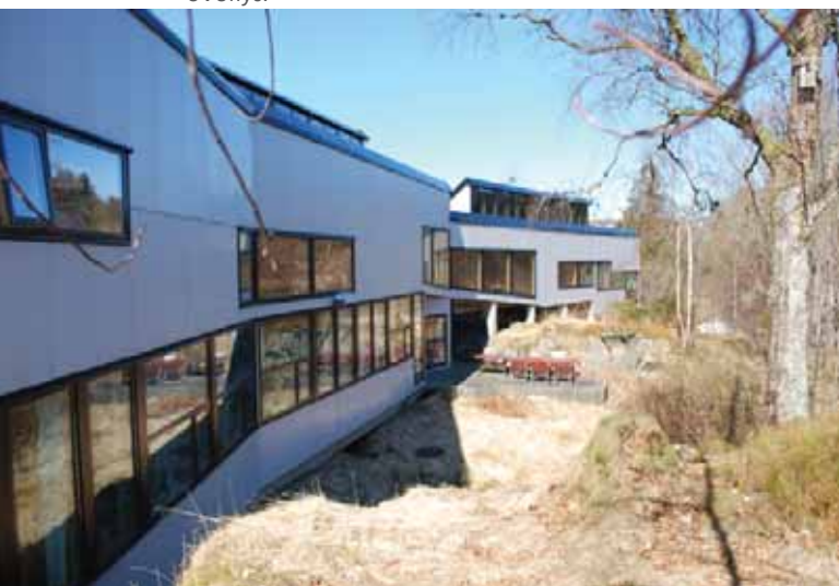
Skoleanleggets fasade mot øst. Irregulær fasade i to hovedetasjer.
