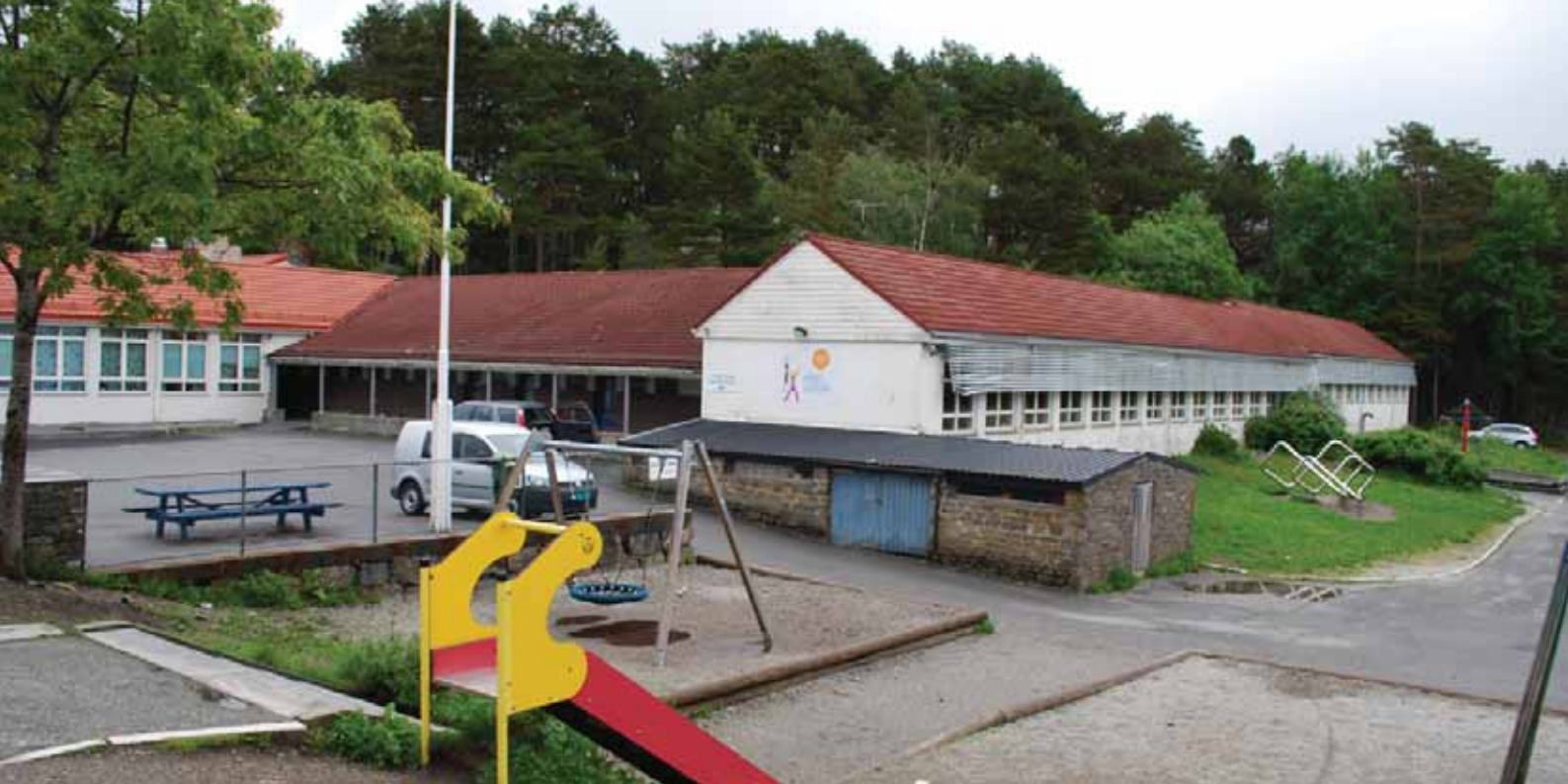
Deler av hovedbygningen (1956). Midtfløyen med tilbaketrukket leskur. Østre fløy til høyre med forlengelse (1968).
