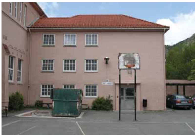
Garderobetilbygg fra 1960-årene. Fasadenes materialitet og takform blir videreført, men vindusplassering og format er mer typisk for 1960-årene.
