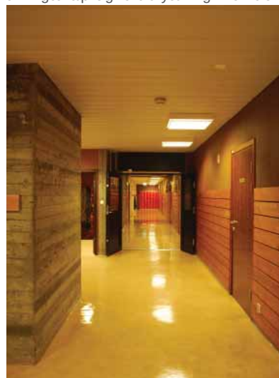
Korridor med kjerne i råbetong og øvrige vegger i gips med brun tapet og furubrystning.
