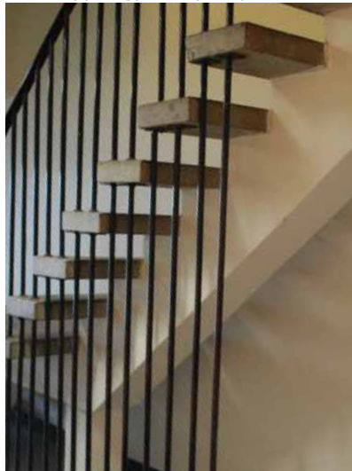
^ Bitrapp på ungdomsskolen med stålslag som går fra gulv og tilsynelatende igjennom trappetrinnene, som henger fritt.
