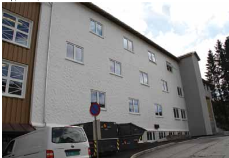
Fasade sett fra veien i nord-vest. Vinduene er jevnt fordelt, forskjøvet i forhold til hverandre.
