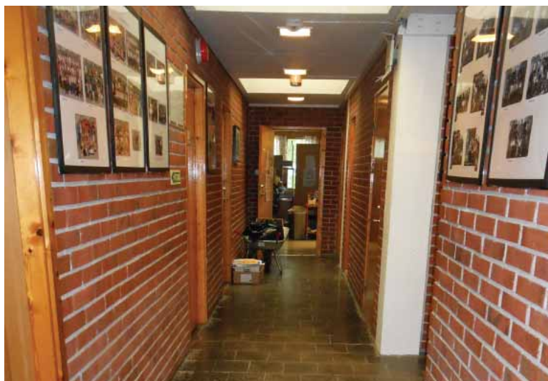
Korridor med gode materialkvaliteter: skiferfliser og teglvegger, samt enkelte furudører som er godt bevart.
