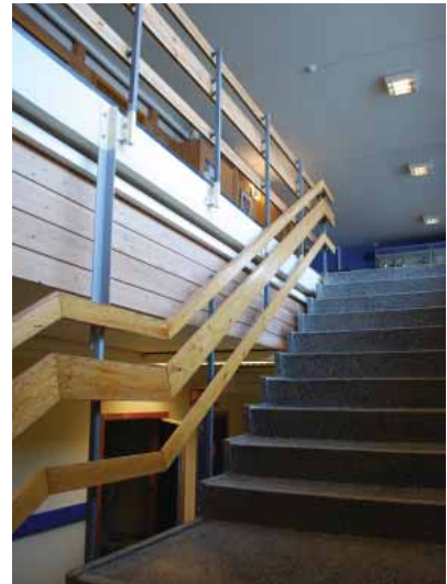
Enkel og tidstypisk trapp i slipt terrasso med håndløper i tre.
