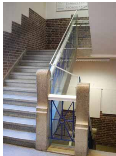
Trappeløpene har brystning i tegl, trapper og endestolper i granitt.
