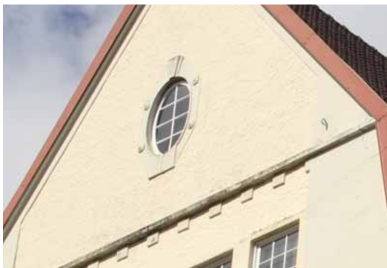
Ovalt vindu med dekor i gavl på hovedfasaden.
