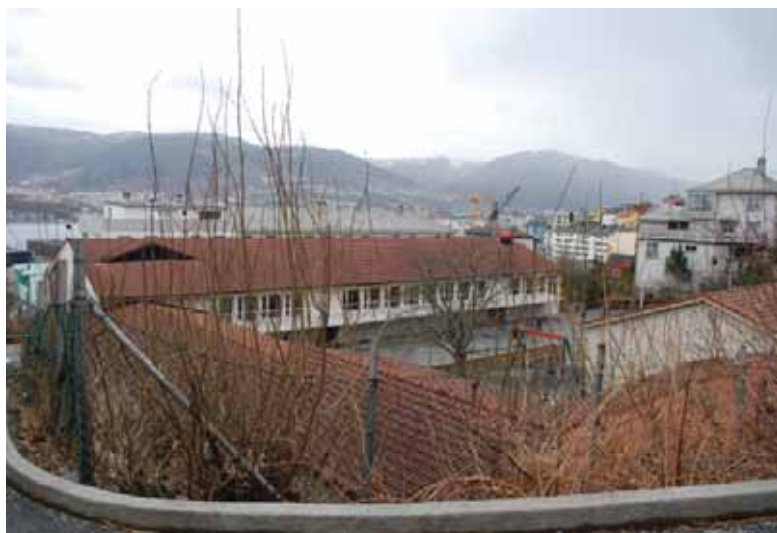
1959-anlegget sett fra sør-vest. Hovedbygg og paviljonger rammer inn skoleplassen.
