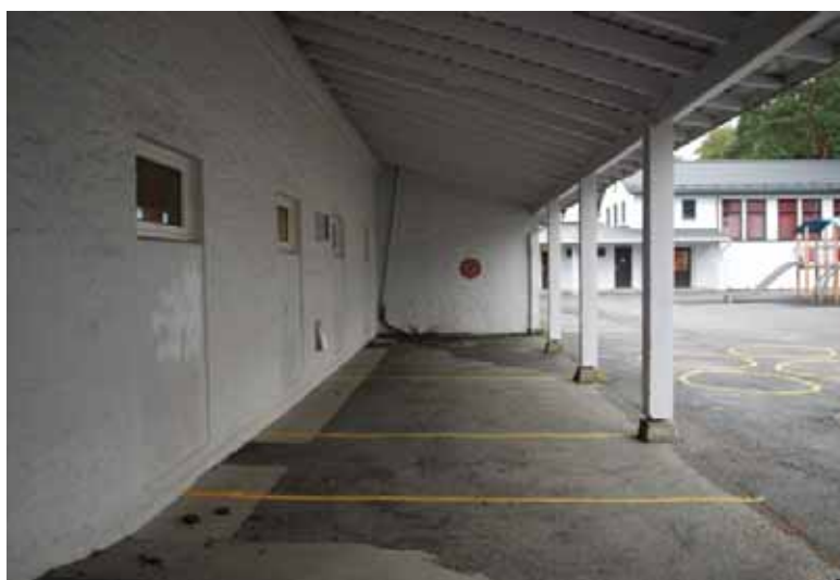
Leskur i trekonstruksjoner i 1954-delen.
