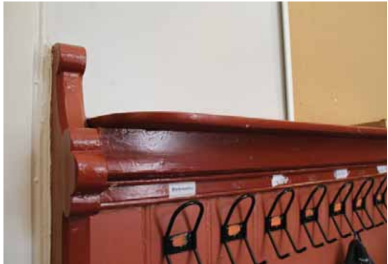
Bygg nord: Brystning i nygotikk.
