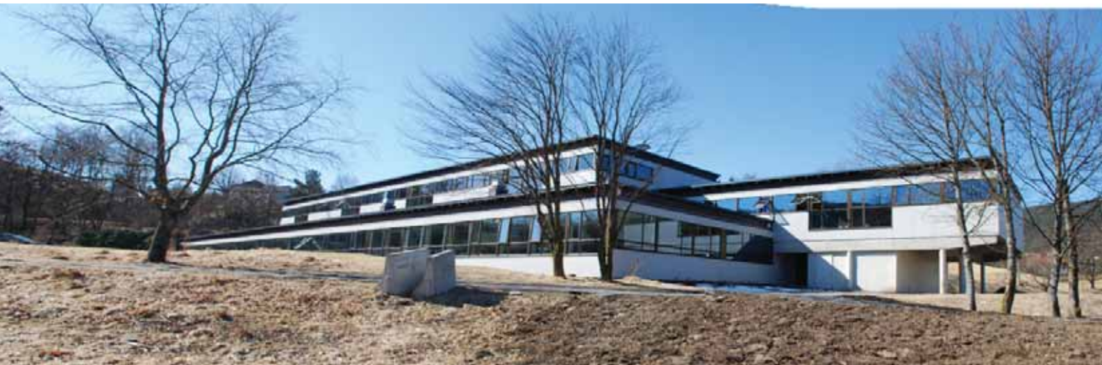
Hovedbyggets østre fløy (1) sett fra nord-øst. Bygningsmassen tilpasser seg landskapet med horisontale volumer.
