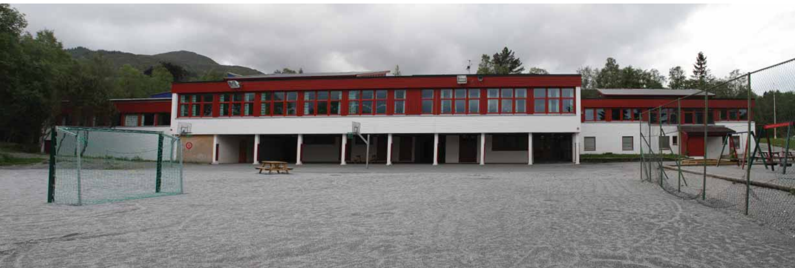
Hovedbygningens fasader mot nord-øst. Bygningsmassen er fordelt i tre hovedvolumer. Fasadene har et horisontalt preg med vindusbånd, kraftig gesims, todeling av material og farger, og inntrukket leskur.
