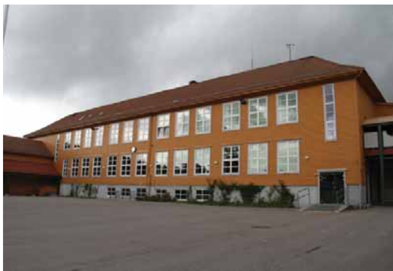
Gamleskolen: Hovedfløyens fasade mot sør-vest. Vinduene er fordelt i grupper.
