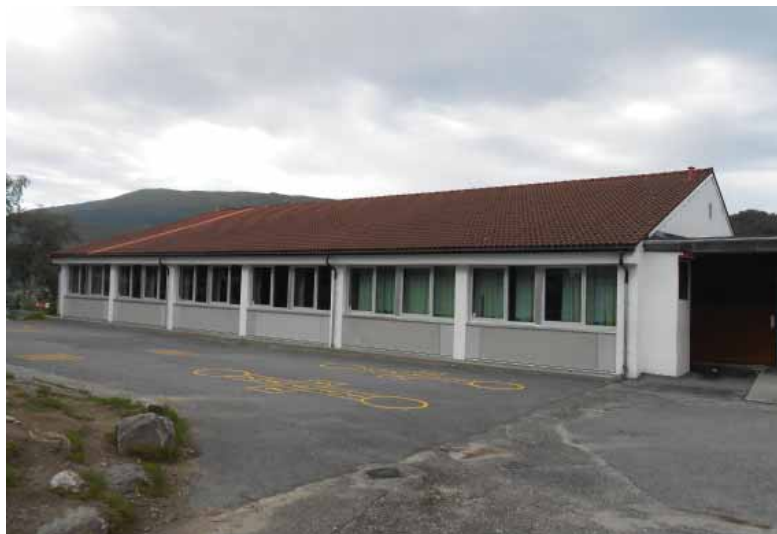
Bygg sør (1961): Øst-fasaden er godt bevart.
