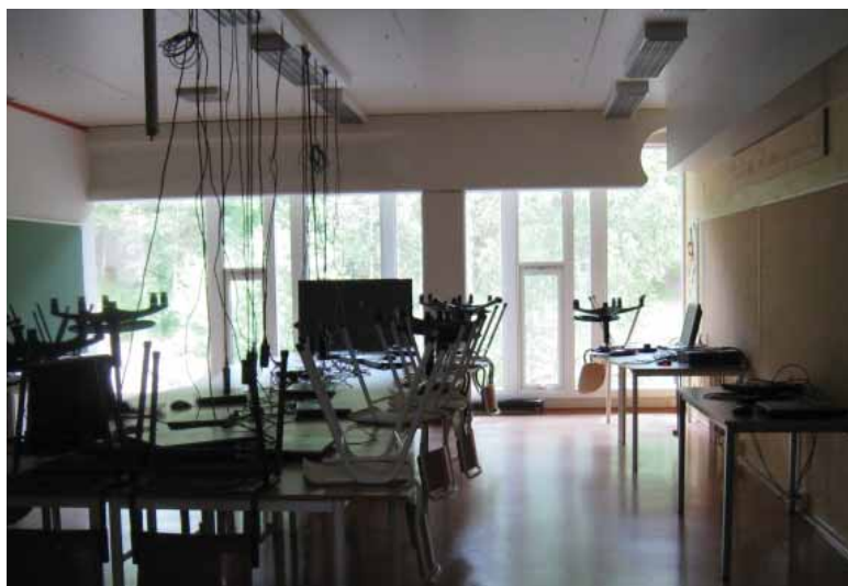
Et klasserom med eksponert betongsøyle og -drager. Fasaden ligger utenpå, i avstand fra konstruksjonen.
