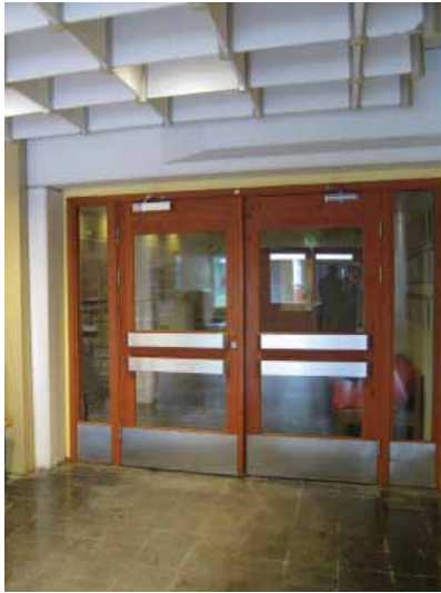
Originale dører i vindfang.
