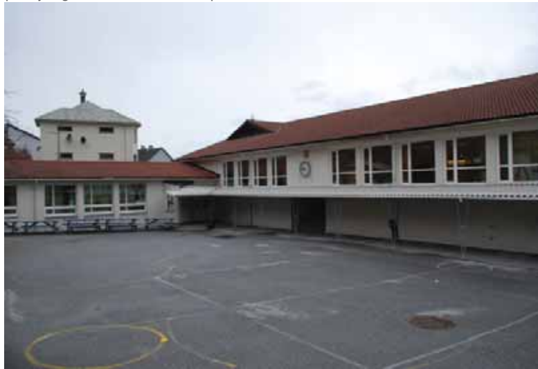
1959-anleggets hovedbygg (2A) til høyre og lavere paviljongbygg (2B) til venstre sett fra skoleplassen.
