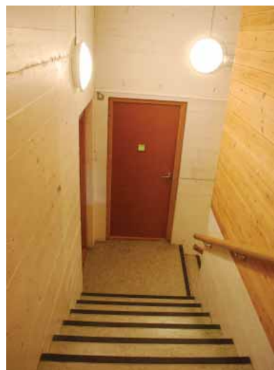
Trapperommene er mange og små, i betong og danner en vinkel.
