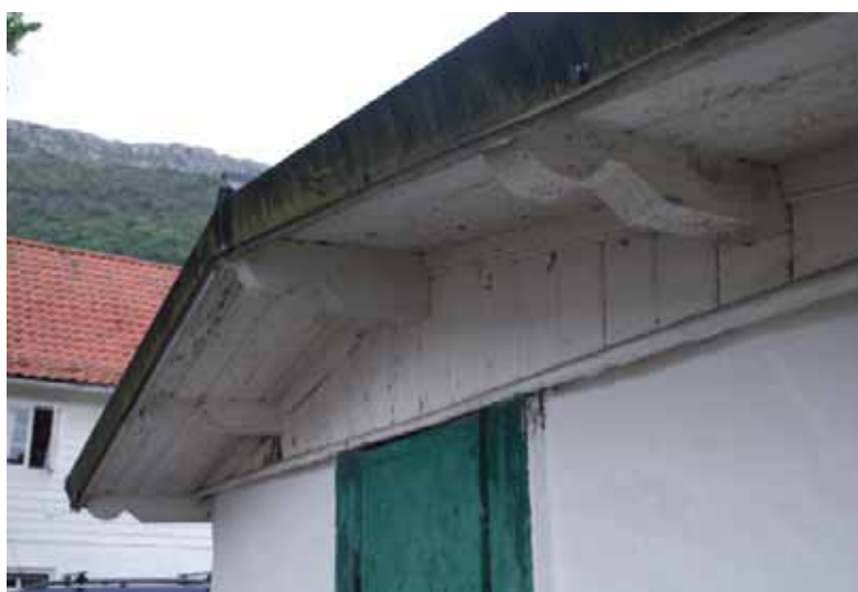
Detalj kjeller/skur, autentisk panel og utskårne taksperrer.
