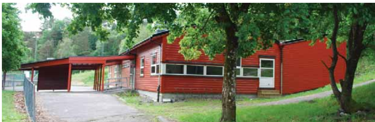
Tilskuddsbygg II (1977): Ligger på tomten sør for hovedbygget.
