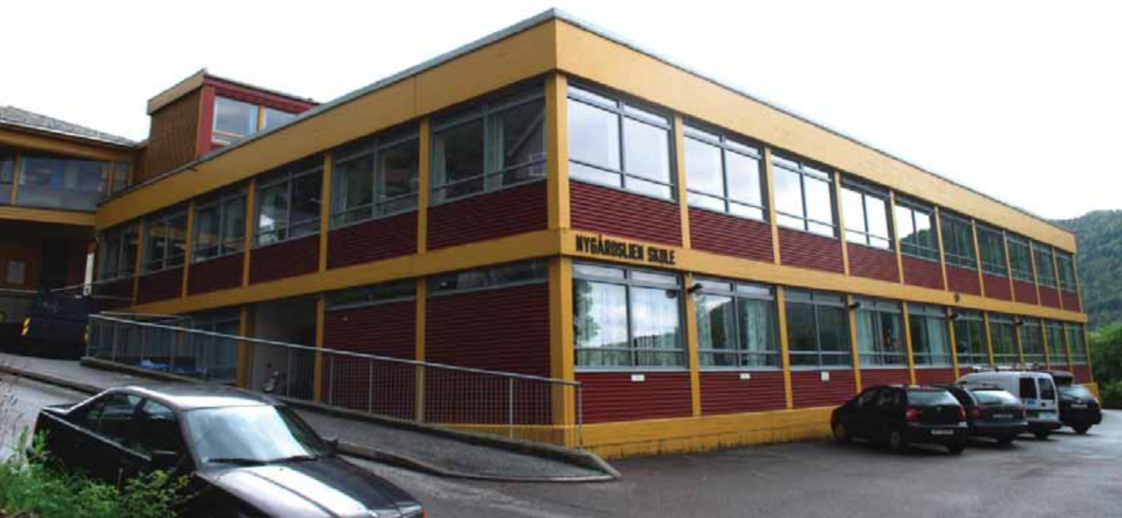
Hovedbygget (1971) fra nord-øst. Lesbar konstruksjon, eksponerte søyler og dekker danner et rutenett.
