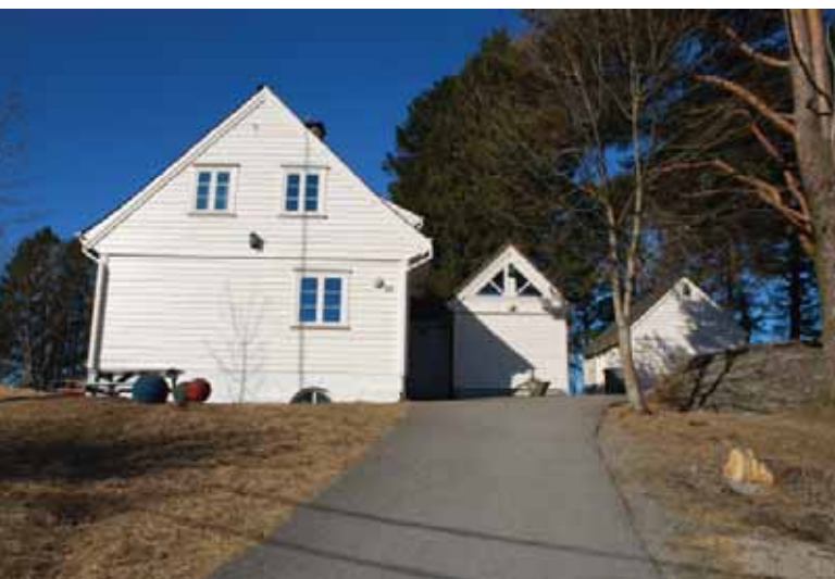
Tre hus, lærerbolig, tilbygg og vedskjul.
