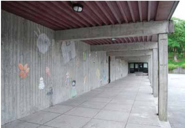
Leskuret har betong søyler og dragere, bakvegg i råbetong.
