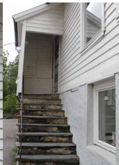
Utvendig steintrapp med skiferheller og smijersrekkverk.
