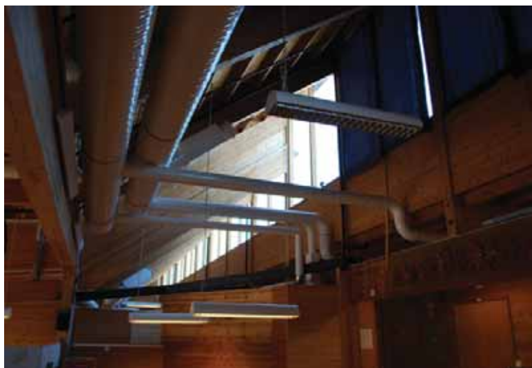
Overlys til oppholdssone. Synlig konstruksjon og ventilasjonsanlegg.
