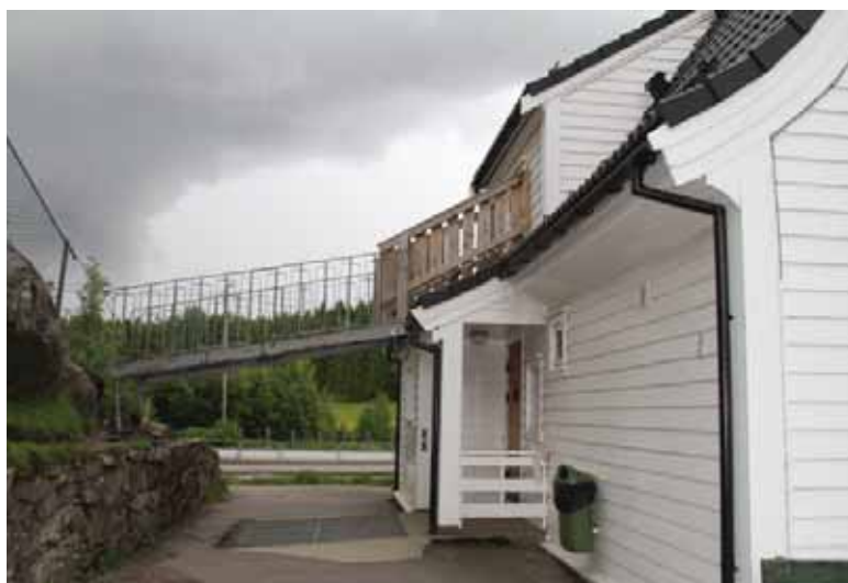
Lærerboligens fasade mot nord-vest.
