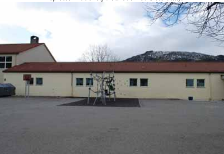
Klasseromsfløy 1b (1971): Lukket fasade mot skoleplassen i øst.
