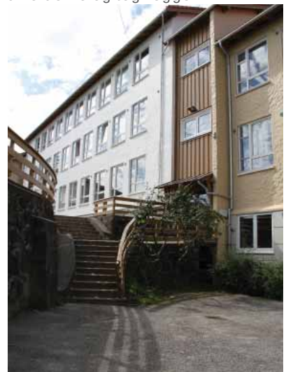
Avtrapping mot det nordligste volumet.
