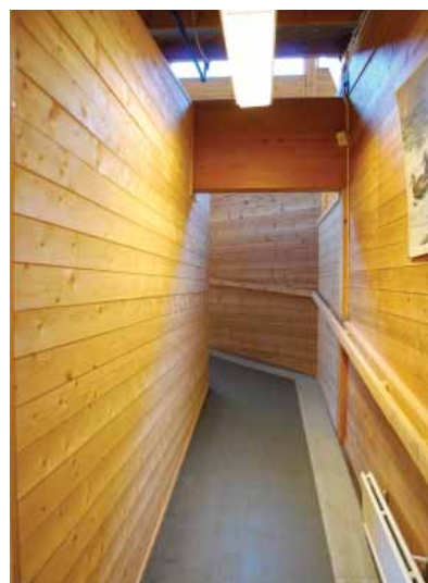
Rampe fra (nå avdelt) klasserom til hovedsirkulasjon.
