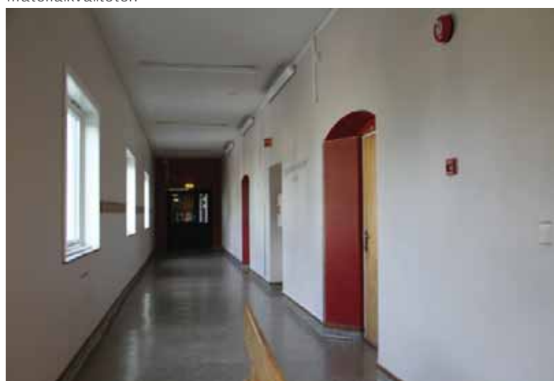
Sidekorridor med dør til klasserom i nisjer.
