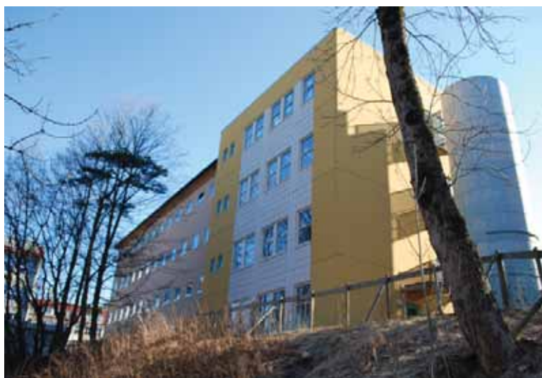
Spesialromsfløyen (1939) og tilbygg (1997) sett fra sør-vest.
