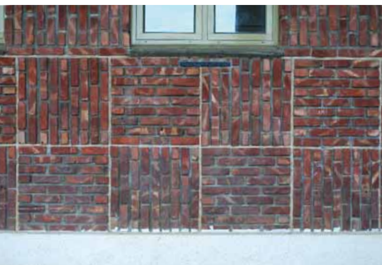
Vertikal og horisontal teglforbandt danner et mønster.
