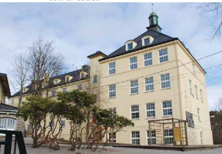
Klasseromsfløyen fra sør-vest. Midt i bildet sees et heistårn bygget på slutten av 1990-tallet.
