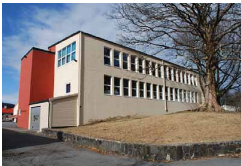
Østfløyen sett fra sør-øst.
