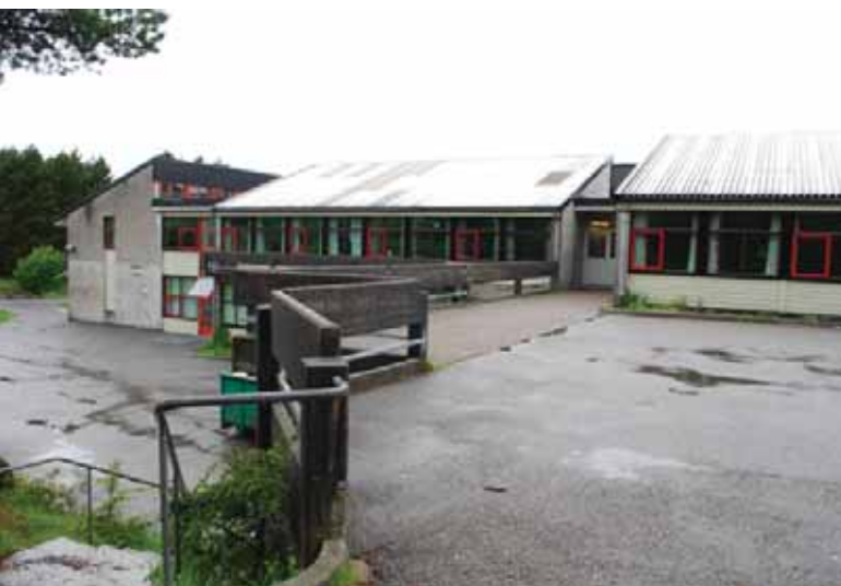
Anleggets fasade mot sør og øst er i én etasje. Betongrekkverk sikrer et sprang på én etasje. Tilbaketrukkede inngangsparti. Tilbygg helt til venstre føyer seg relativt godt til hovedbygget.
