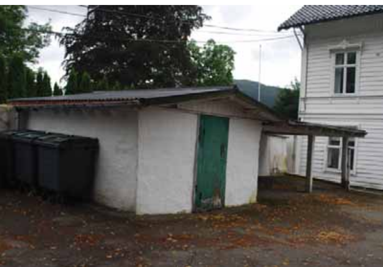
Kjeller/skur sett fra nord-øst.
