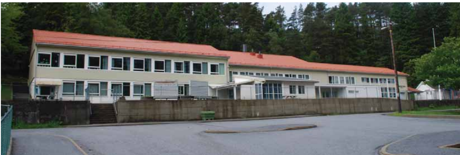
Barneskolen: 1960-fløyen til høyre og utvidelsen fra 1967 til venstre, noe fremtrukket.
