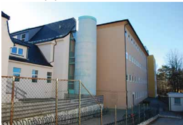
Del av vaktmesterbolig, klasseromsfløy og spesialromsfløy, samt sylinderformet trapperom. Uryddig fasade mot vest.
