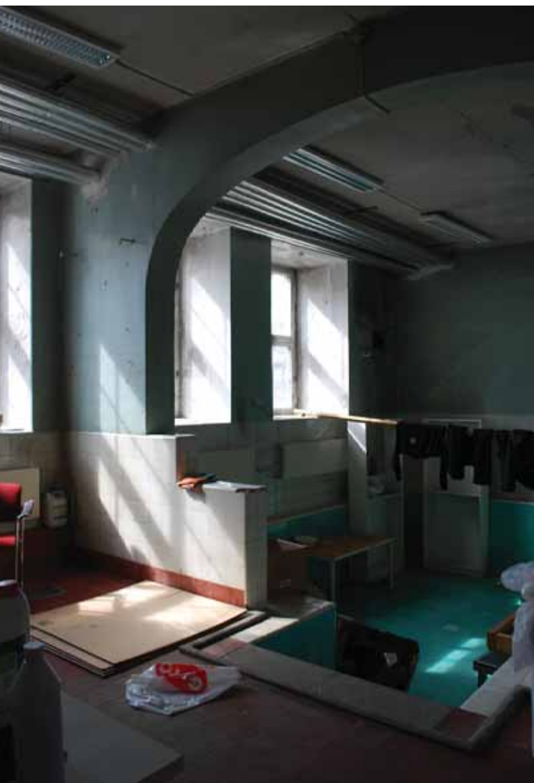
Svømmebassenget er godt bevart med vakre, autentiske fliser av høy kvalitet.
