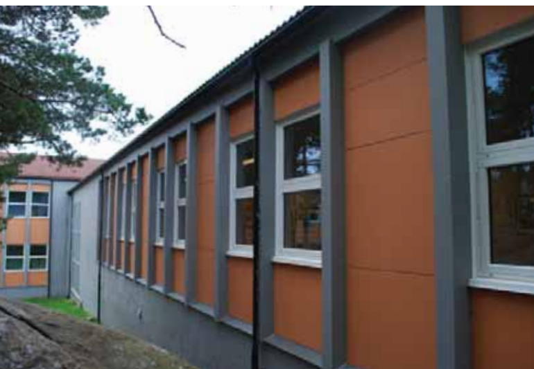
Fløy 1B: Nordre fasade med eksponerte betongsøyler.
