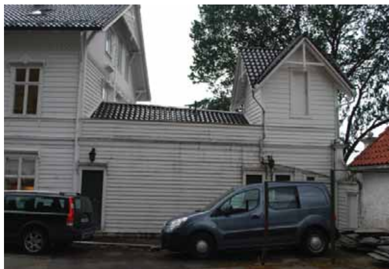
Toalettbygningens østre fasade.
