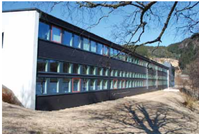
Klasseromsfløyens fasade mot Kalandsvatnet i sør-vest. Fasadens horisontalitet er svekket med ny fargesetting av karmen.
