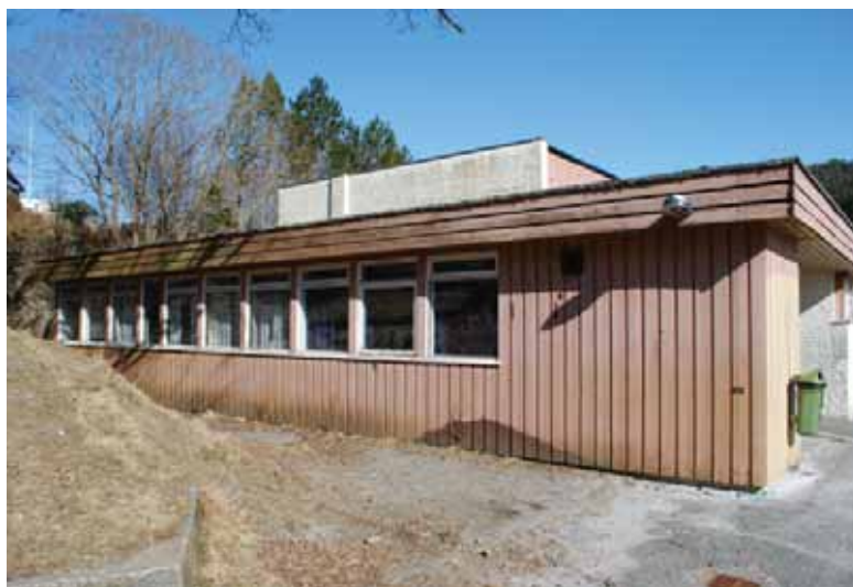
Gymnastikkbygningens fasade mot nord.
