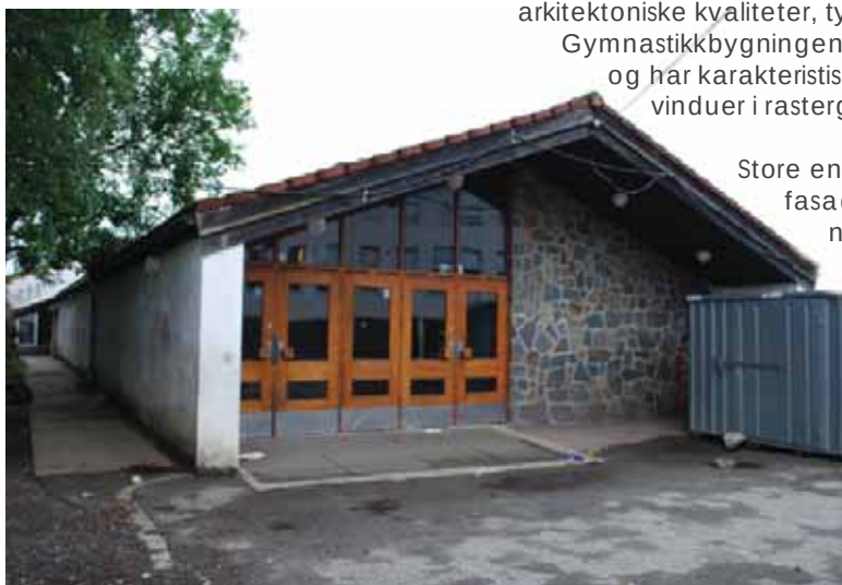
Gymnastikkbygningens nordre fasade med tilbaketrukket leskur, tidstypiske teakdører og steinvegger.
