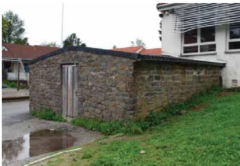
Oppført i stein, trolig den eldste bygningen i anlegget.
