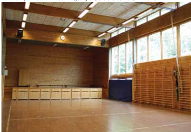
Tidstypisk gymnastikksal med scene. Synlige betongsøyler i vegg.
