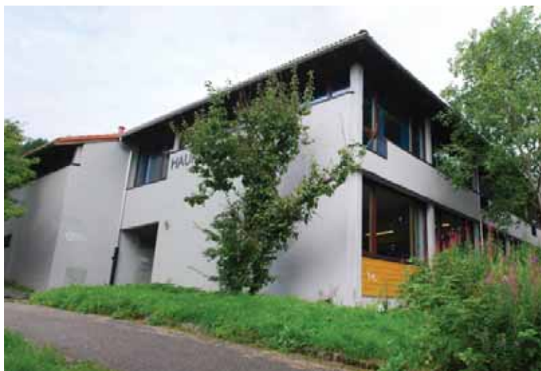
Fløy C fra sør-vest. Relativt tett endevegg mot sør i massiv betong.
