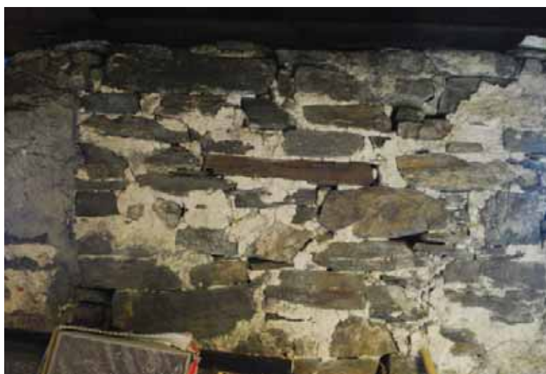
Detalj murverk, synlig på innsiden.
