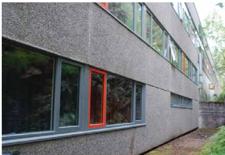
Fasaden mot skogen i nord med vindusbånd.
