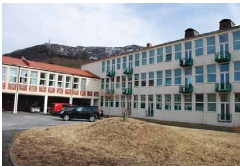
Nordre og østre fløy. Serviceboligene i østfløyen har fått balkonger og balkongdører.
