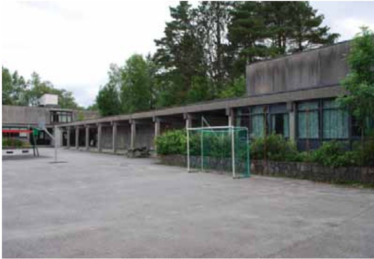
Gymnastikkbygningen til høyre er koblet til hovedbygningen med et leskur.
