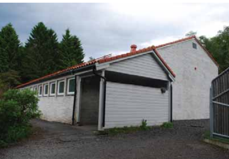
Gymnastikk/vaktmesterbolig sett fra nord-vest.
