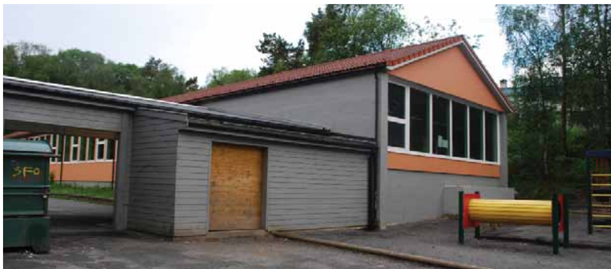
Fløy C sett fra nord-øst.
