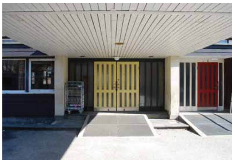
Inngang i hovedbyggets fasade mot øst.
