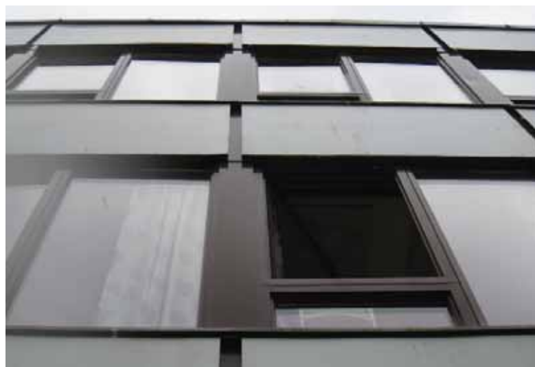
Yttervegger i platekledd stenderverk med vindusbånd.
