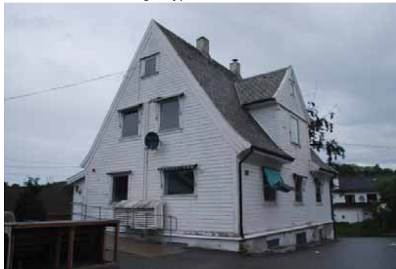
Boligen er meget godt bevart eksteriørt, med opprinnelig skifertak og detaljeringer. Vinder skiftet.
