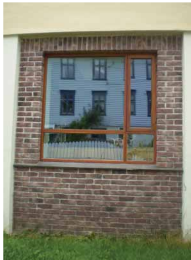
Autentisk teakvindu og tegl i sørfløyens sokkeletasje.
