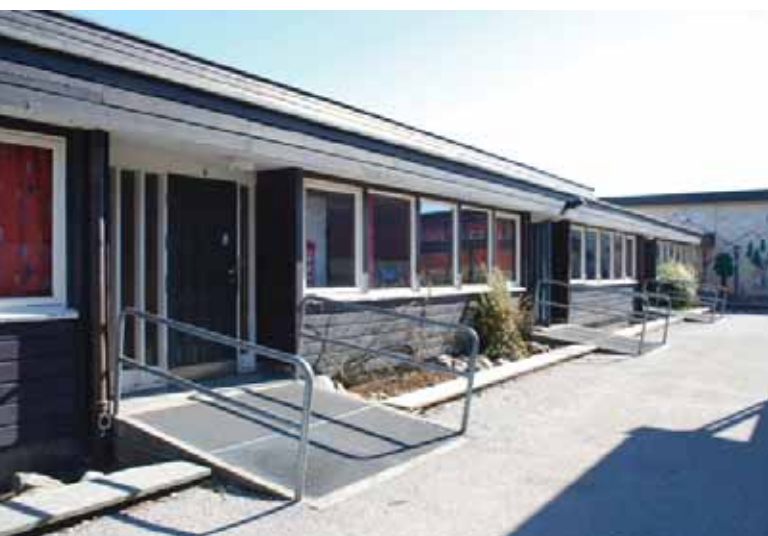
Hovedbyggets fasade mot øst. Inngangsparti til hvert enkelt klassrom.
