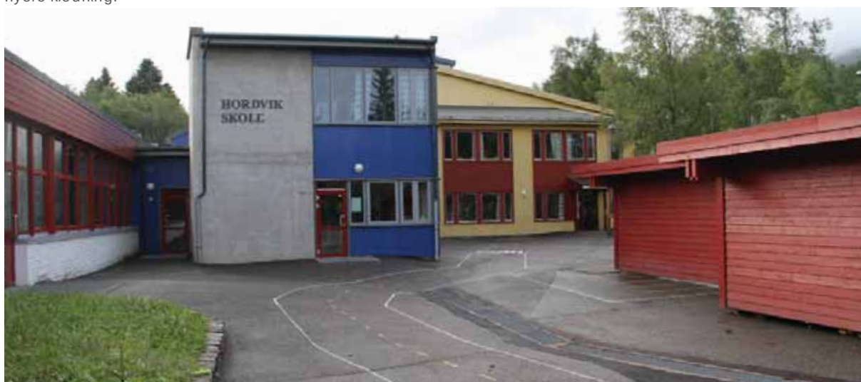
Hovedbygningen helt til venstre, mellombygg (2007), paviljong(1999) og leskur(1977-79).
