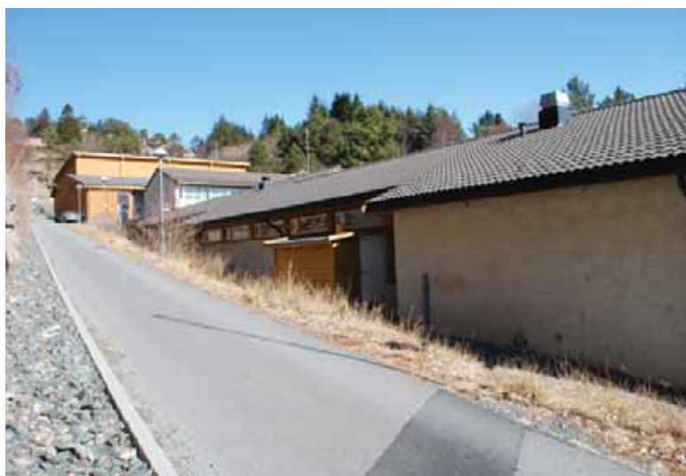
Krokeide skoles fasader mot vest. Baksiden av klasseromsfløyen, med betongvegger, vender ut mot veien.
