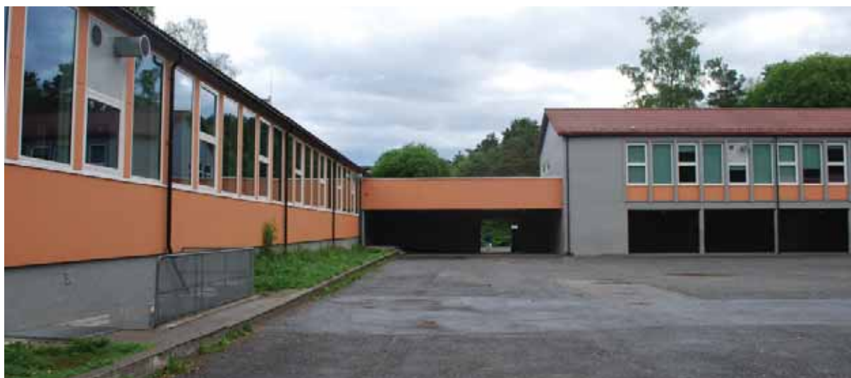
Fløy C til venstre og fløy B til høyre. Fløy C er enklere i utforming enn de andre fløyene, uten betongsøyler.
