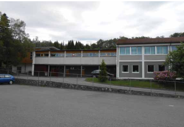
Mellombygg sør (1967/2009) og bygg sør (1961): Opprinnelige fasader mot vest.
