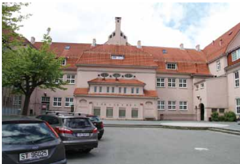
Hovedfløyens fasade mot øst. Framskutt midtparti med ulike volumer og markant ventilasjonspipe på taket.
