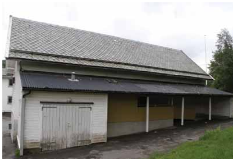
Gamleskolens nordvestlige fasade, med nyere tilbygg og universelt utformet inngangsparti.
