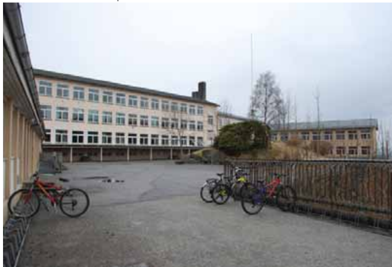
1954-anlegget, bygg 1B og 1C.
