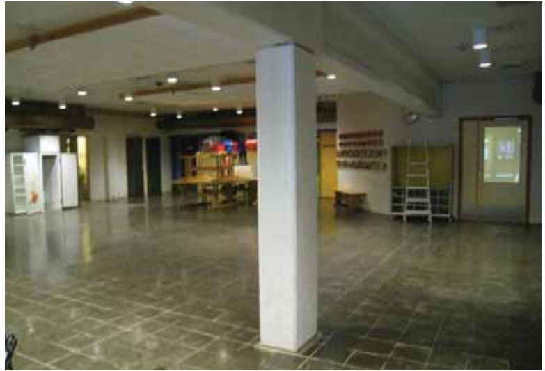
Ekspontert konstruksjon og originalt gulv i foaje i første etasje.
