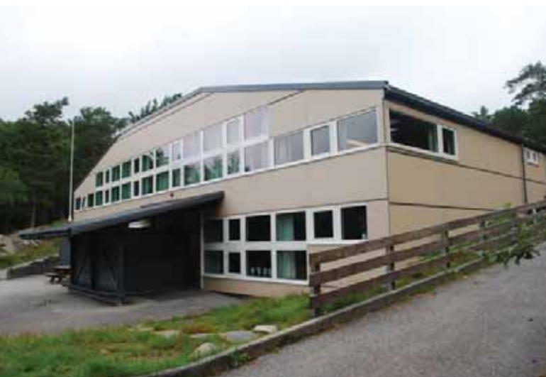
Storåsen (1975) har sokkeletasje mot sør. Innganger med overbygg.
