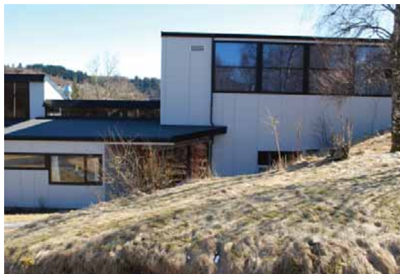
Hovedbygget er satt sammen av ulike volumer. Gymnastikksalen til høyre.
