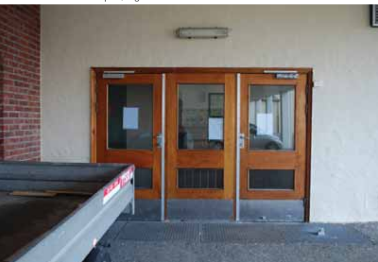
Ett sett opprinnelige teakdører bevart, i østfløyen.
