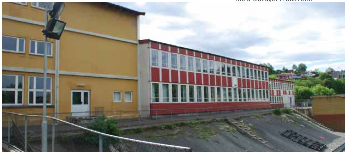
1956-bygget til venstre med vinduer jevnt fordelt og 1966-fløyene til høyre vinduer i med rastergrid.
