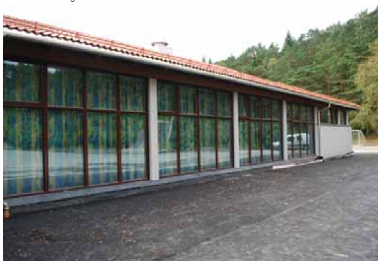
Fløy B, fasade mot nord. Store vindusflater, lesbare søyler.
