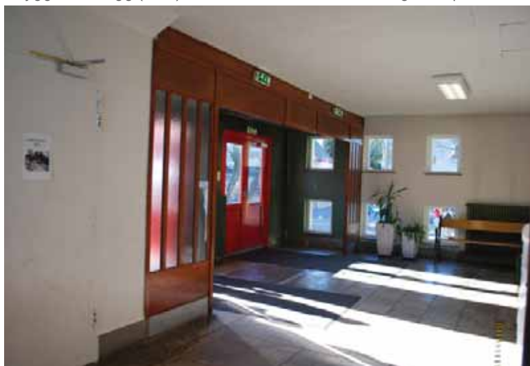
Tilbygget i øst fra 1939, inngangsparti med autentiske fastfelt og skiferfliser med gode, opprinnelige materialkvaliteter.
