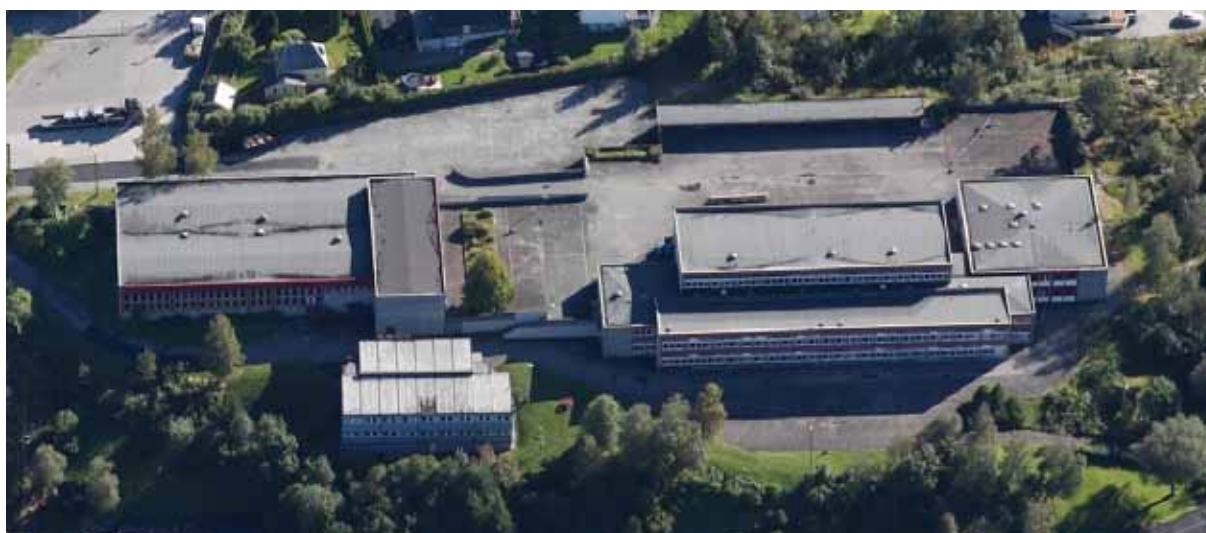
Flyfoto 2: viser anlegget sett fra vest (Foto: Bergen kommune).
