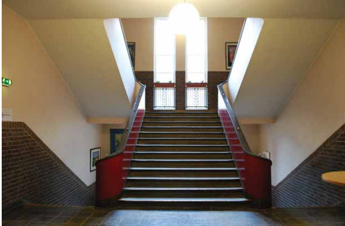
Den vakre hovedtrappen sentralt i bygningen. Et bredere trappeløp avløses av to smalere trapper. Rekkverket er massivt, med buede hjørner i funksjonalistisk formspråk.
