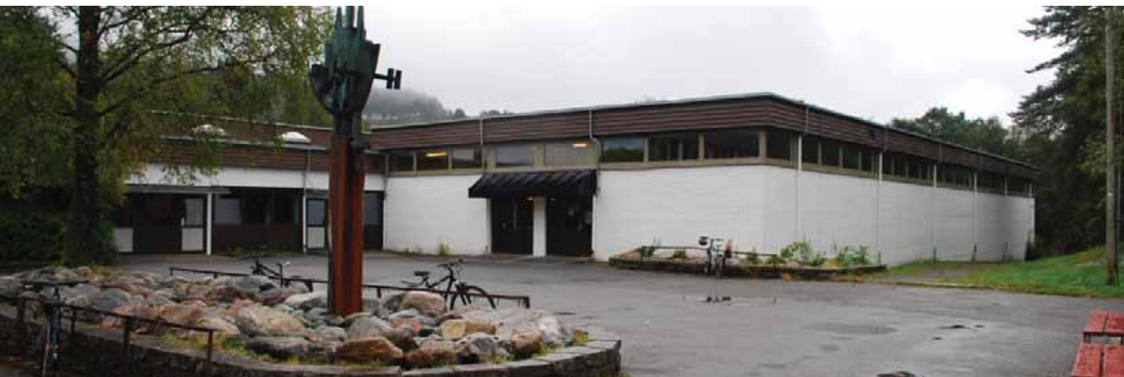
Svømmehall og garderober (lavere del) sett fra skoleplassen.
