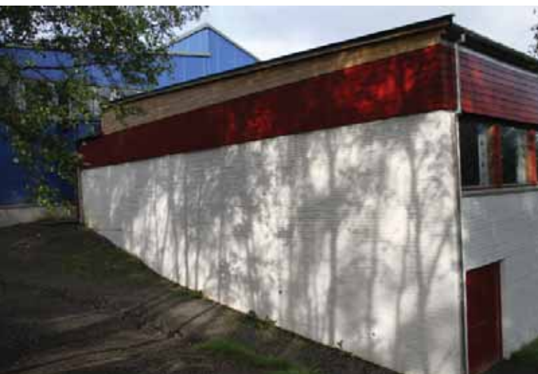
Fasade mot sør-øst. Lukket fasade.
