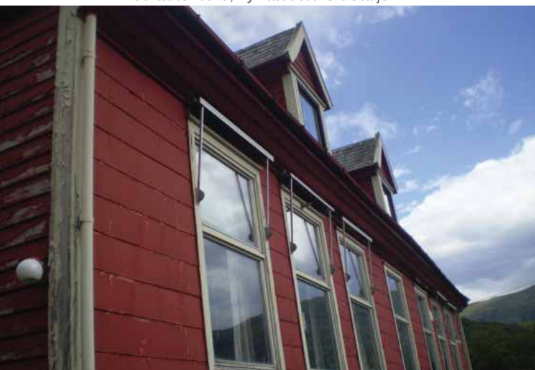
Gamleskolens nordfasade kledd i malte metallplater. Nye vinduer med annen inndeling enn opprinnelige + markiser.
