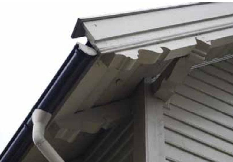
Takutsikk med utskårne sperrender.
