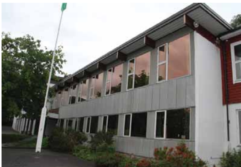
1979-delens fasade mot øst: Utkragende tak og bæring, platekledde vegger og store vindusflater.
