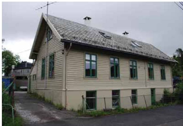
Fra veien i sør fremstår skolen som opprinnelig. Krysspostvinduer.
