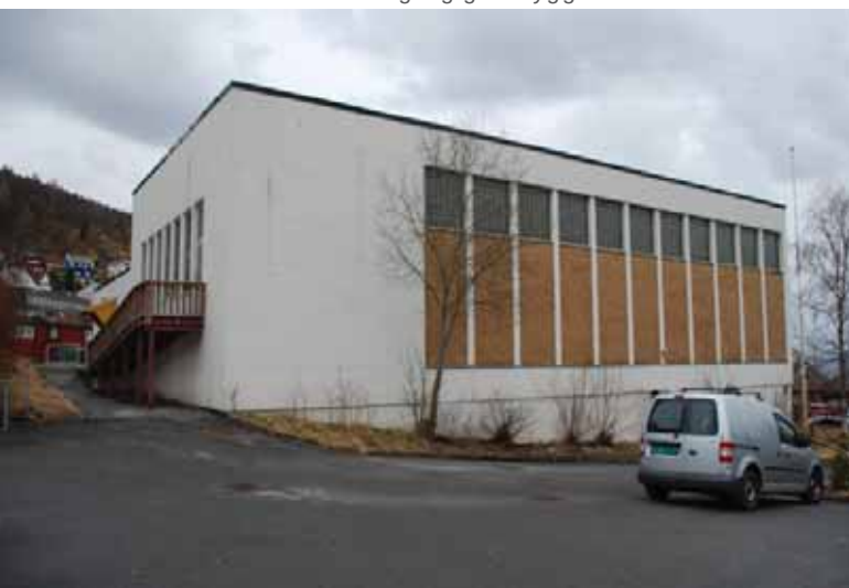
Idrettsbygget fra sør-øst.
