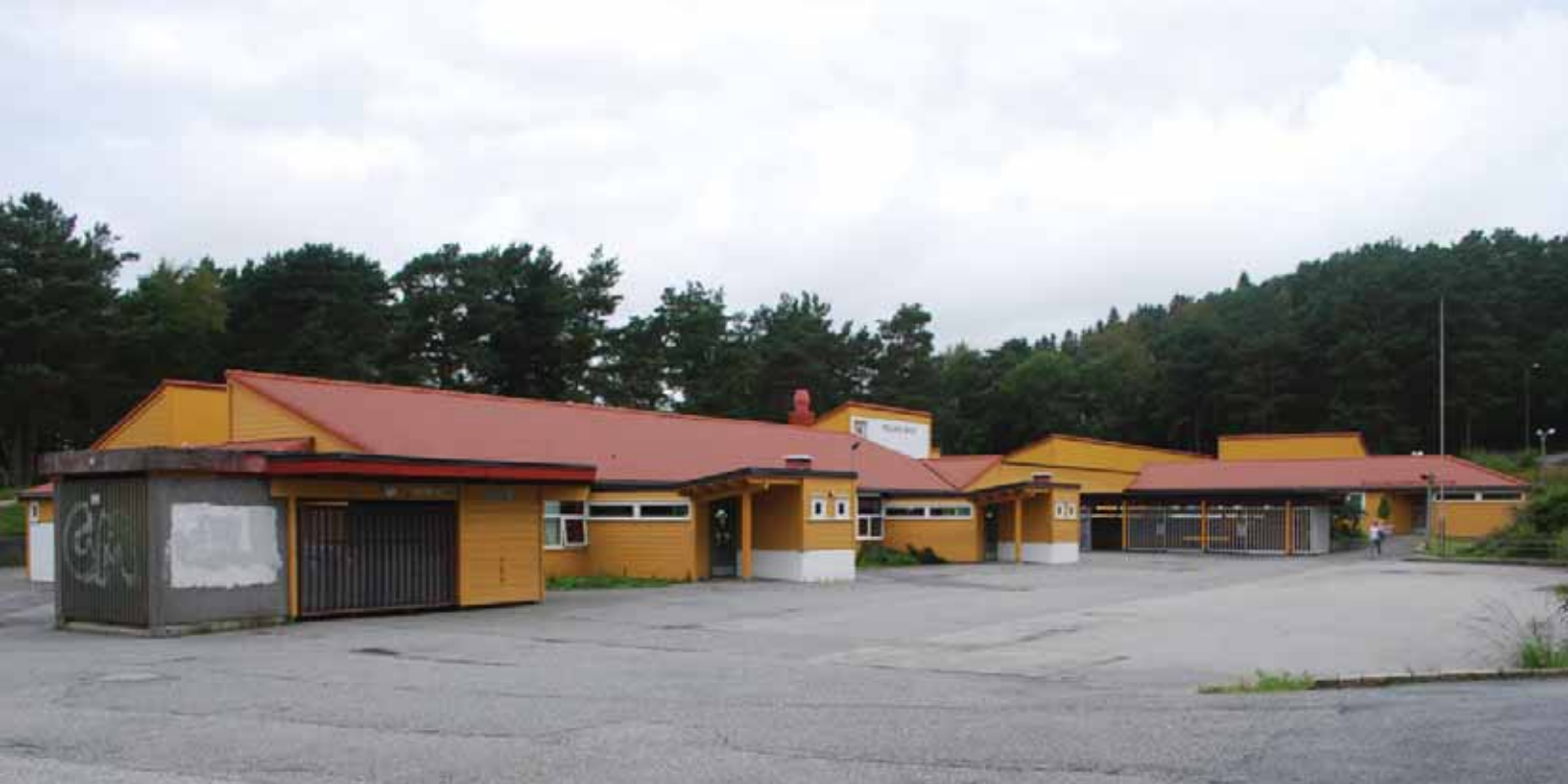
Kjerneskolens, østre og søndre fasade, sett fra skoleplassen. Bygningsmassen er brutt opp i volumer for å skape menneskelig skala.
