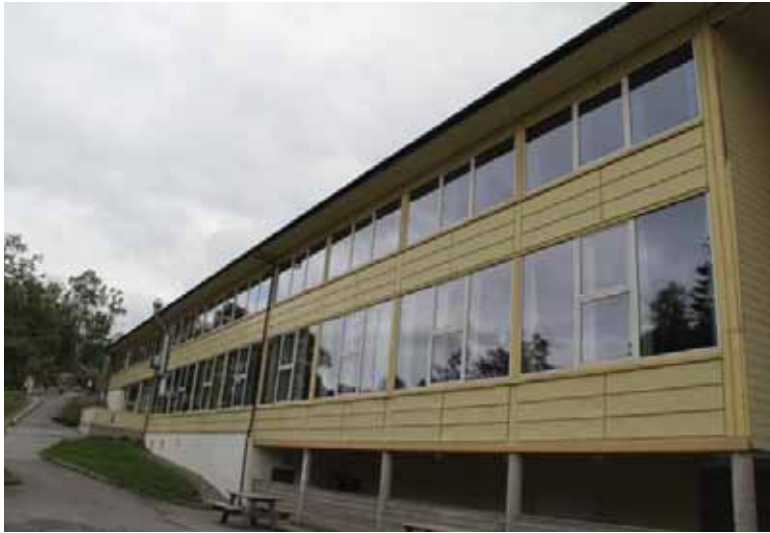
1970/1999-delens fasade mot skoleplassen/sørvest. Kan inneholde deler av administrasjonsfløy fra 1970. Tilføyer fra 1999 tilpasser seg 1970-delen, med vindusbånd og fasadeplater.
