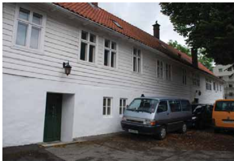
Sløydbygningens vestre fasade mot tunet.
