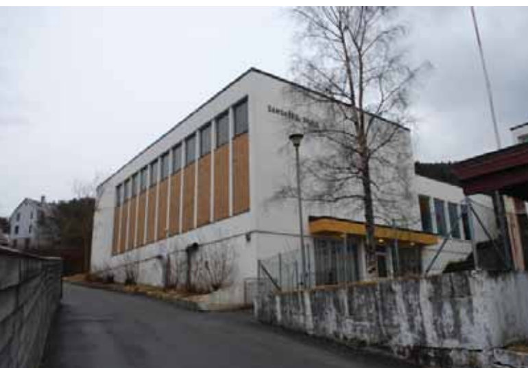
Idrettsbygget fra nord-øst. Høyt vindusbånd i ytterfasden, forblendet med tegl og glassbyggerstein.
