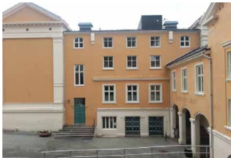
Hovedbyggets fasade mot skoleplassen i nord-øst, med tilbygg fra 1930-årene (midterste del av fasade + fløy til høyre)
