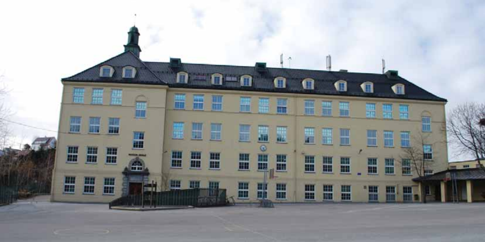
Klasseromsfløyen fra skoleplassen i øst. Siderisallitt i sør med inngangsparti og tårnhjelm. Vinduene er rytmisk fordelt i fasaden.
