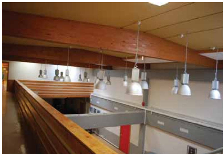
Sentralt rom med mesanin. Opprinnelig mer åpent, med studiesenter og åpent bibliotek og leserom på mesaninen. Flere vegger er satt opp, både i andre etasje og på mesanin, for å avdele. Eksponerte bjelker i limtre og betongelement.
