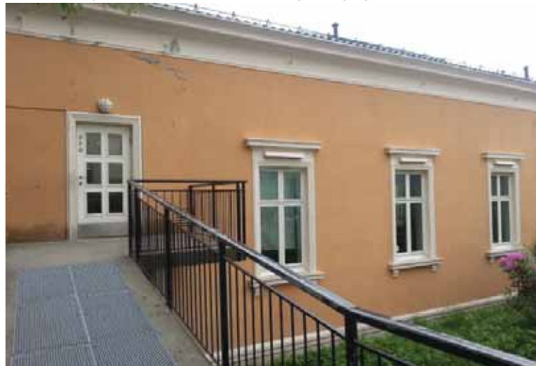
1933-fløyens fasade mot nord-øst. Nyere dør og bro.
