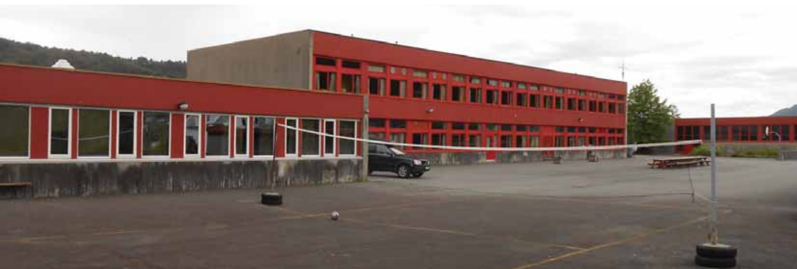
Blokk C og B sett fra skoleplassen i vest. Blokk A lengst til venstre.
