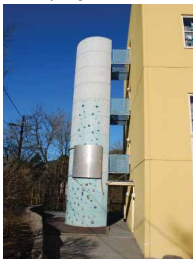
Sylinderformet trapperom i betong på tilbyggets sørvegg (1997).
