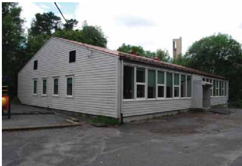
Klasseromspaviljongen. Nå er endeveggene kledd med tre og har fått vinduer.
