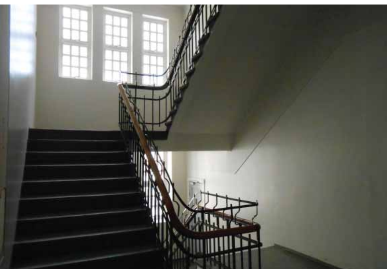
To hovedtrapper, med trinn i slipt terrasso og metallrekkverk.
