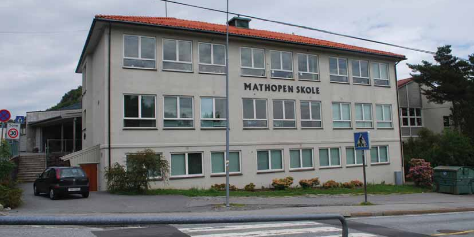
Hovedbygget (1956) er relativt godt bevart. Nye vinduer med ny vindusinndeling.
