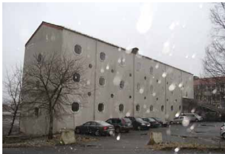
Høyblokkens fasader mot nord og øst.
