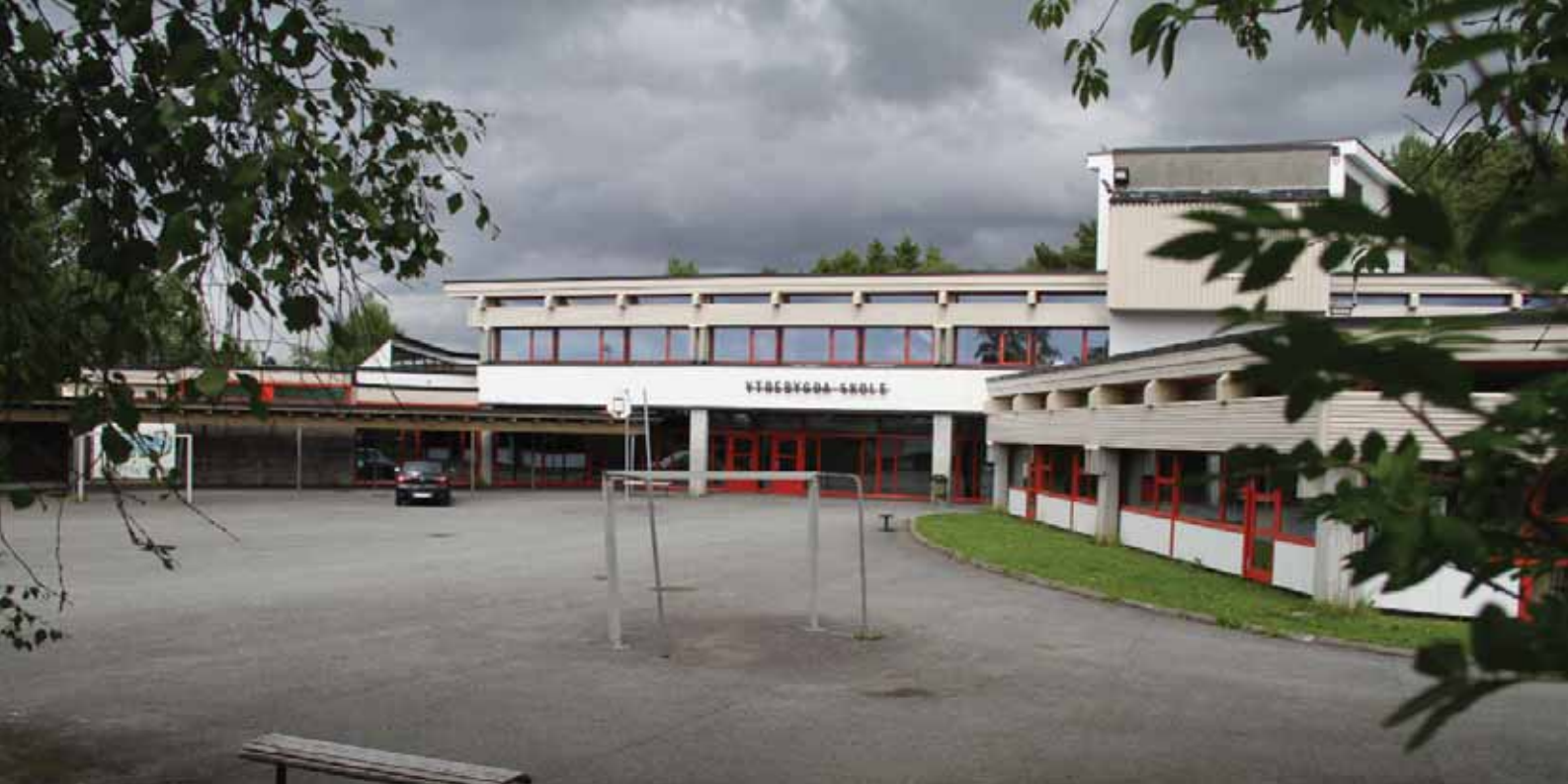
Hovedbygget sett fra sør.
