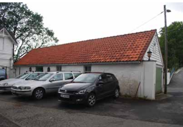
Vognhuset sett fra sør-øst.
