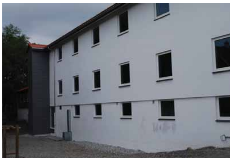
Klasseromsfløyens fasader mot nord-vest. Rigid fasade. Nyere heis/ventilasjonsrom til venstre.
