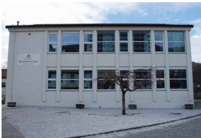
Administrasjonsbygget (1971) vindusbånd og utenpåliggende pilastre.
