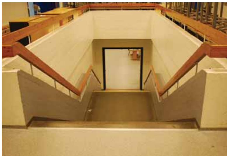
Et av to trapperom. Plasstøpt betong i rekkverk.
