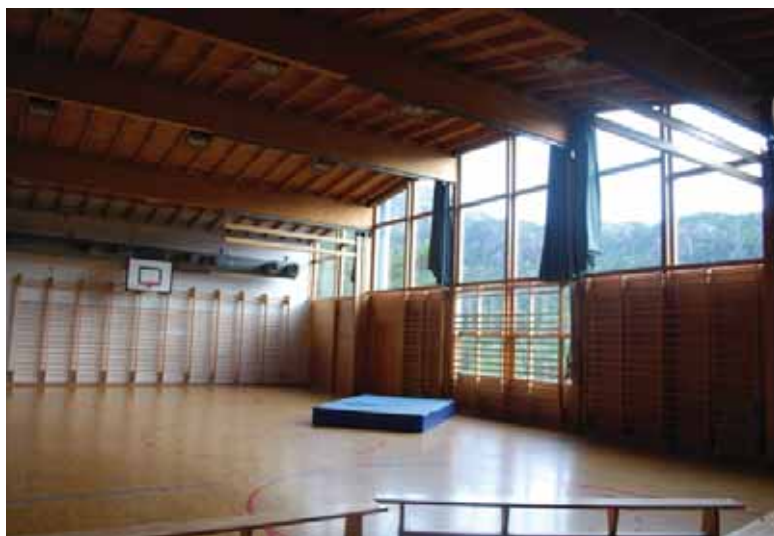
Gymnastikksalen har buet tak som tar opp fjellformasjonen.
