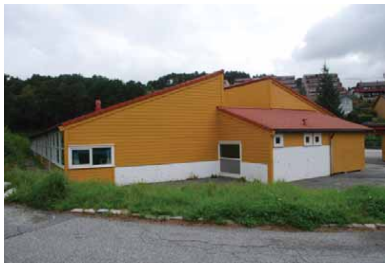
Kjerneskolens søndre fasade. Takene er trukket langt ned, helt ned til vindusbåndene.
