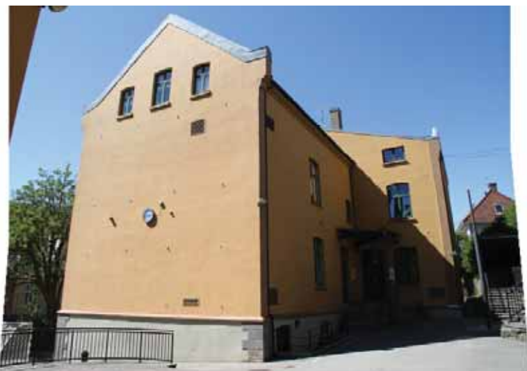
Bygg nord sett fra øst.
