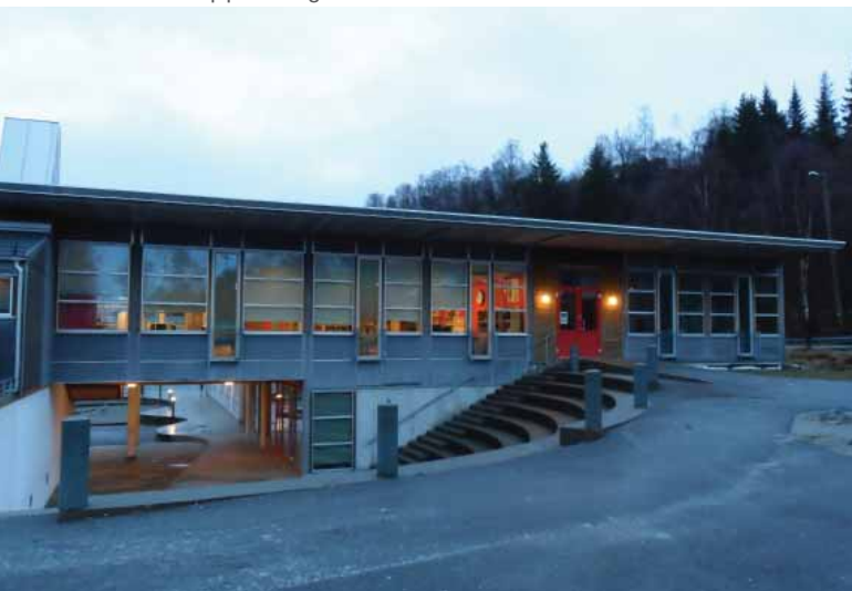
Mellombygg nord (1967/2009): Ny fasade mot skoleplassen i sør.
