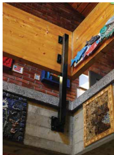
Rekkverk med kraftige dimensjoner.
