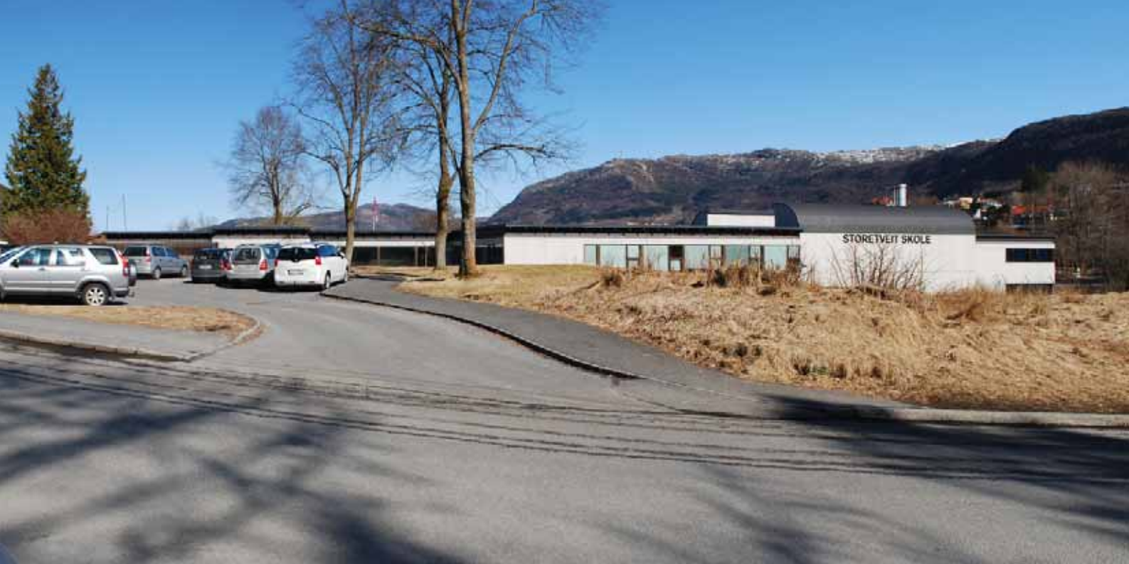
Skoleanlegget sett fra sør.
