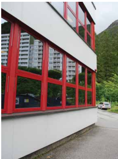
Vindusbånd på hovedbygget.
