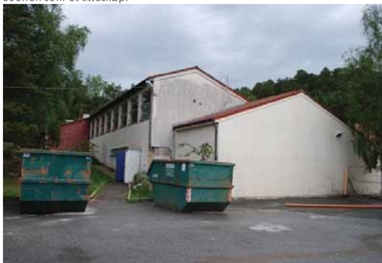
Gymnastikkbygningen er sammensatt av tre volumer, gymsalen, i midten, er høyest, med scenen som et mindre volum i sør.
