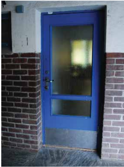
Gamle dører og vinduer i leskuret. Skiferplate i vinduet går igjen i samtlige vinduer i 1956 og 1968-delen.
