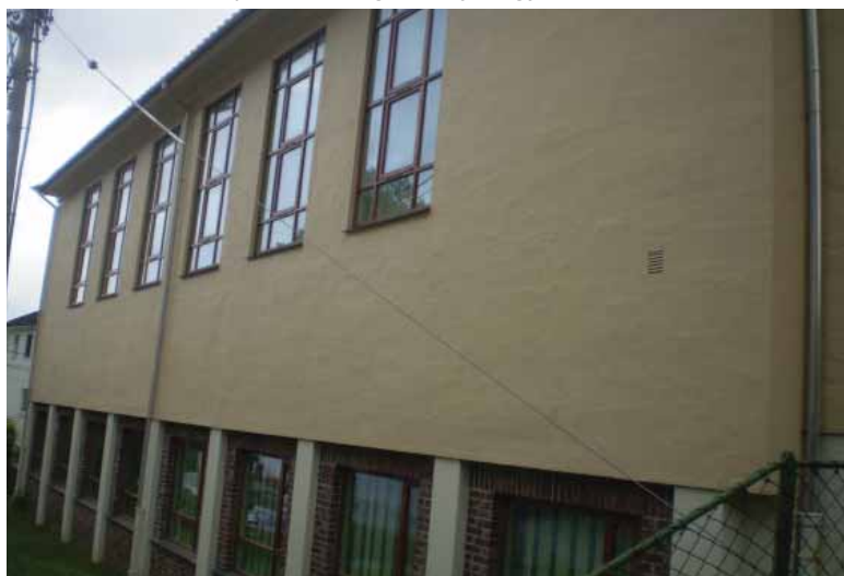
Sørfløyens fasade mot veien. Originale vinduer.
