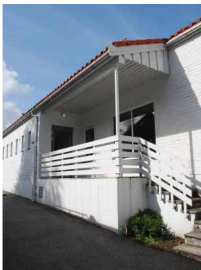
Inngang til vaktmesterbolig, nå SFO, fra Hunstadsvingen i øst.
