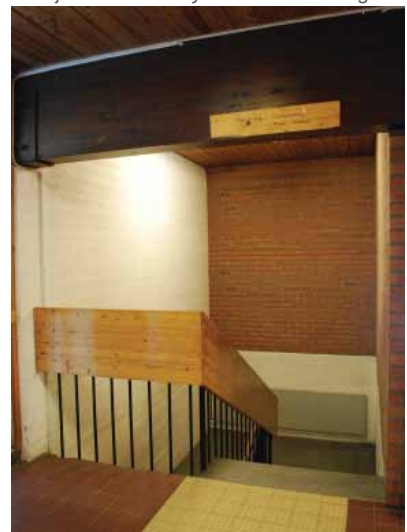
Trapp i gymnastikkbygget (3), tegl, betong og karakteristisk rekkverk.
