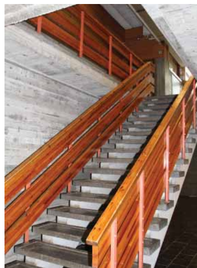
Trapp med svevende trinn i slipt terrasso. Tidstypisk rekkverk.
