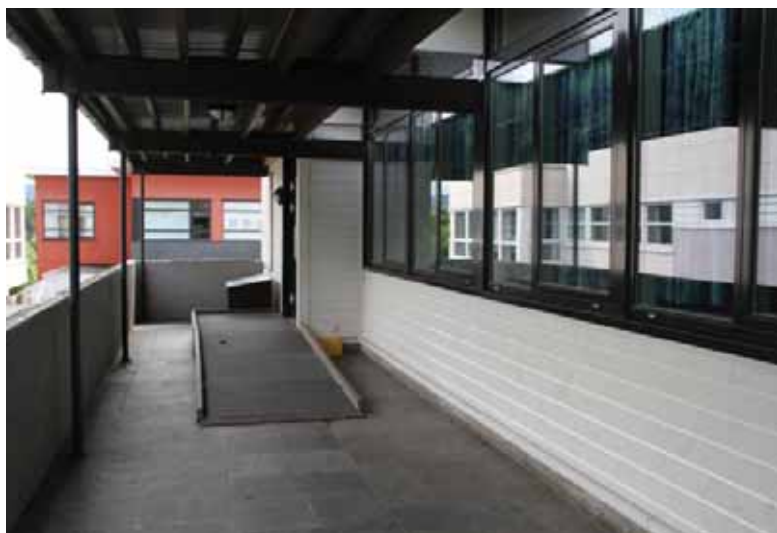
Undervisningsblokken (1971), leskur og innganger.
