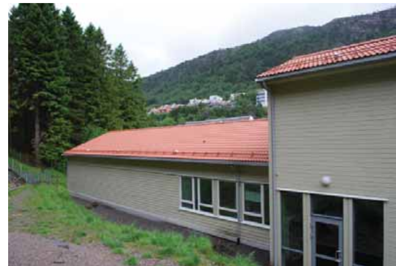
Baksiden: Tilbygg til høyre, ventilasjonsrom oppe og korridorrampe nede. Samme materialitet som det opprinnelige.
