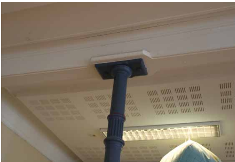
Bygg sør: Søyler og bjelke.
