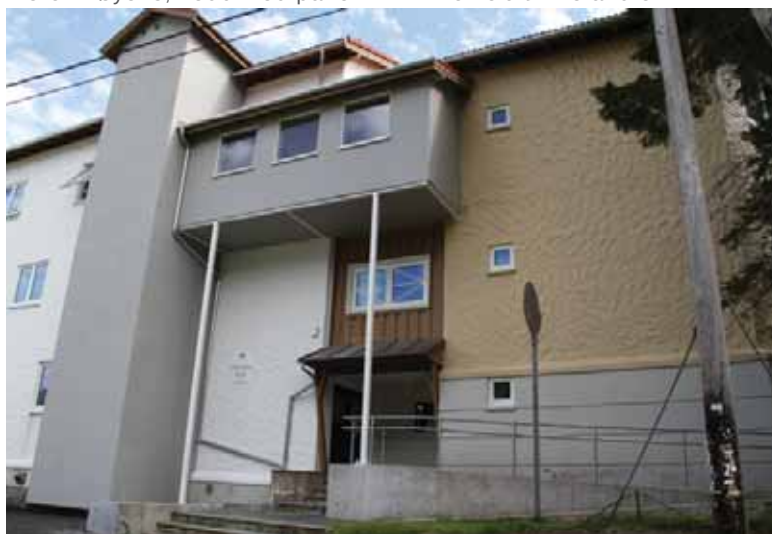
Nyere heistilbygg på vestfasaden. Deler av bygget dekker trapperommet, og virker skjemmende på den ellers godt bevarte fasaden.
