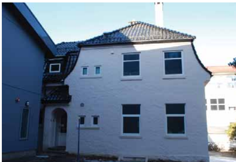
Vaktmesterboligen (1917) fasade mot øst. Mansardtak. Autentisk dør i inngang til venstre.
