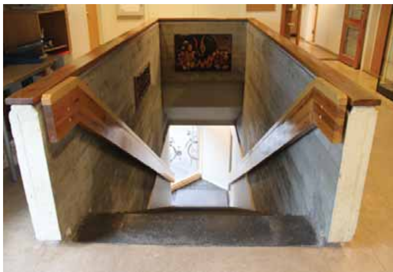
Trapperom sett fra andre etasje. Støpt betong.
