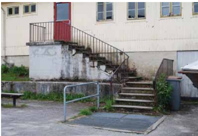
Trapp i samme stil som 1958/byggets utvendige trapper.
