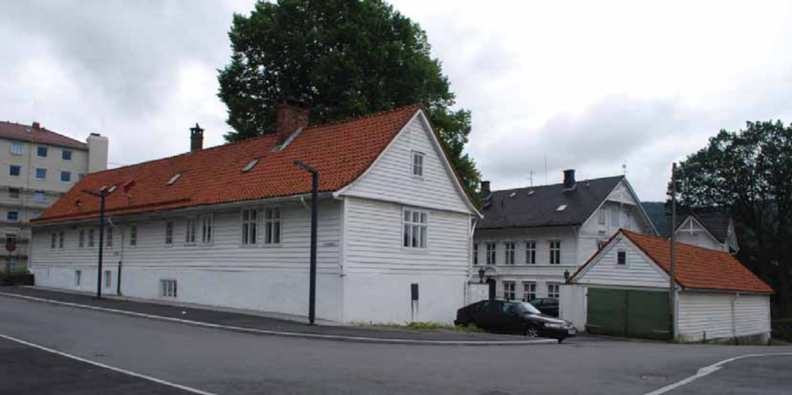
Tunet sett fra nord-øst; sløydbygningen (3) til venstre, vognhuset (4) til høyre og hovedhuset (1) med svart tak bakenfor.
