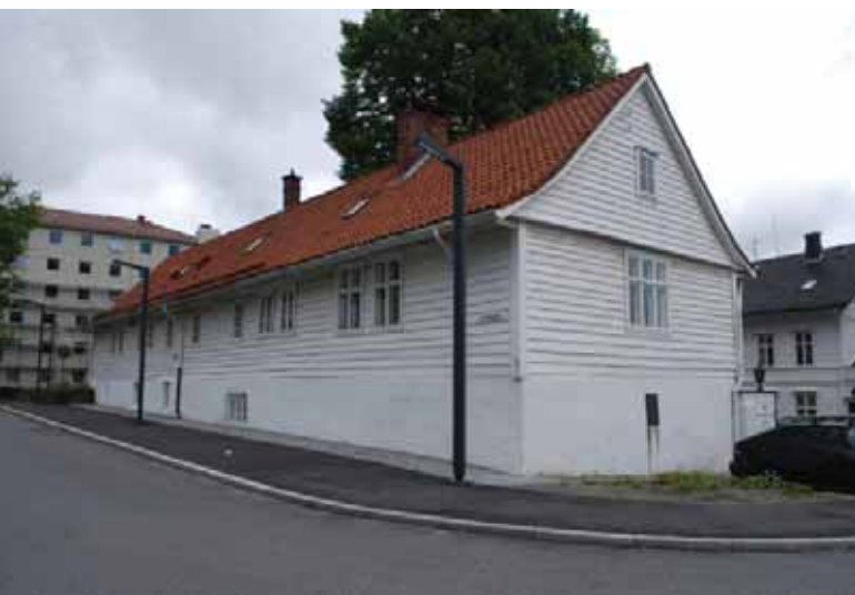
Sløydbygningen sett fra nord-øst.
