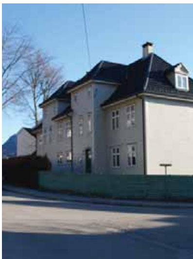
Leilighetsblokk fra 1920 sett fra sør-vest.
