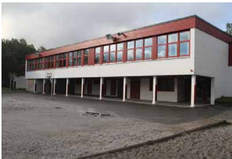
Fasade mot nord-vest, midterste del. Inntrukket leskur med innganger.
