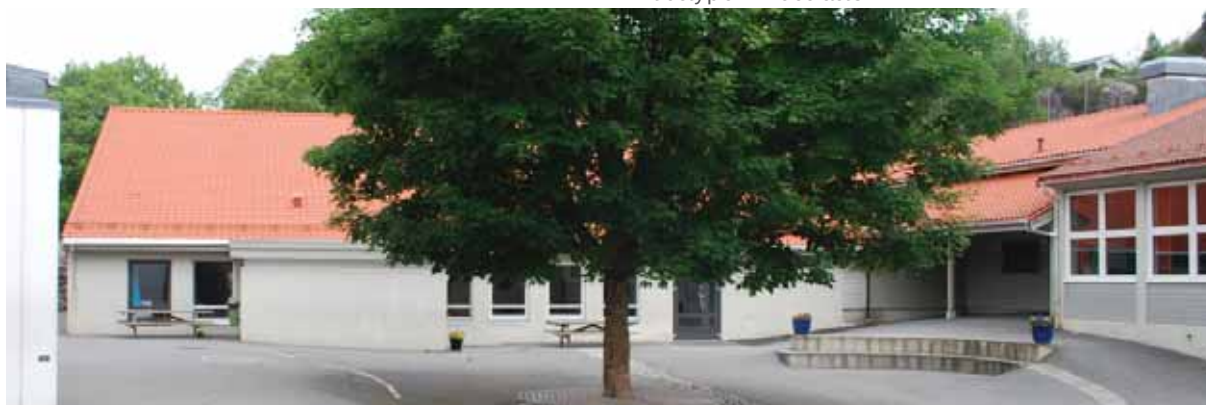
Gymnastikkfløyen og deler av klasseromsfløyen (1963) sett fra skoleplassen i sør. Bygget sammen i 2004.
