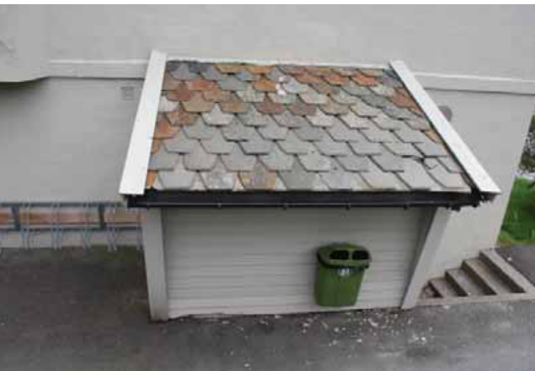
Bevart overbygg til biingang med autentisk skifertak.
