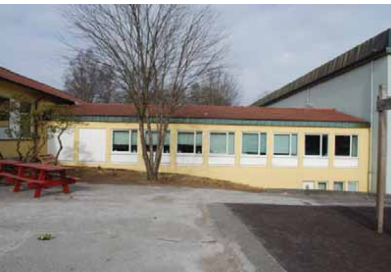
Bygg B har koppertekking i gesimsen.
