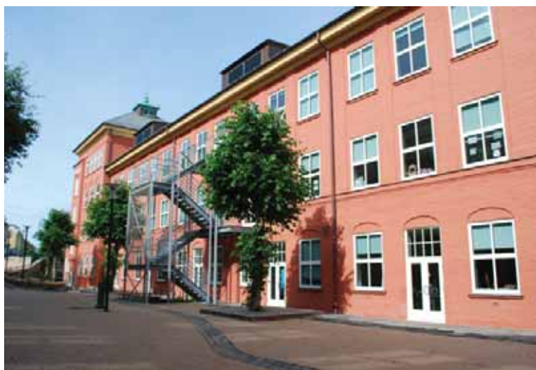
Nyere nødutganger; balkongdører til klasserom i første etg. og utenpåliggende trapperom til andre og tredje etg.
