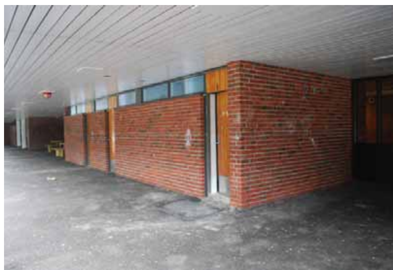
Teglkerne i leskur. Toaletter med opprinnelige dører.
