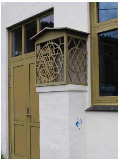
Ornamentikk på sør-østre fasade på klasseromsfløyen (1952).
