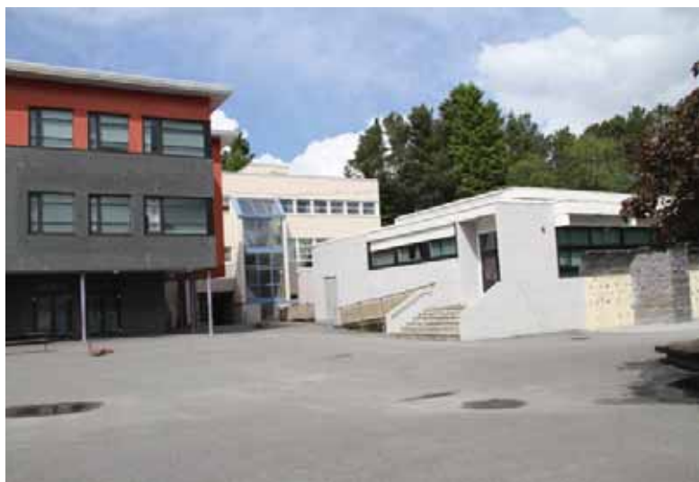
Nybygget (2004), tilskuddbygget (1995) og gymnastikkblokken (1971).
