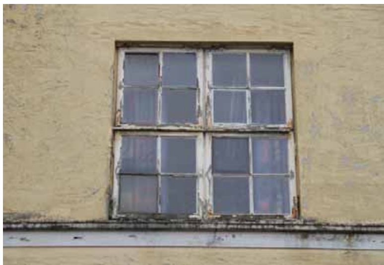
Originale vinduer i hovedfløyens fasade.
