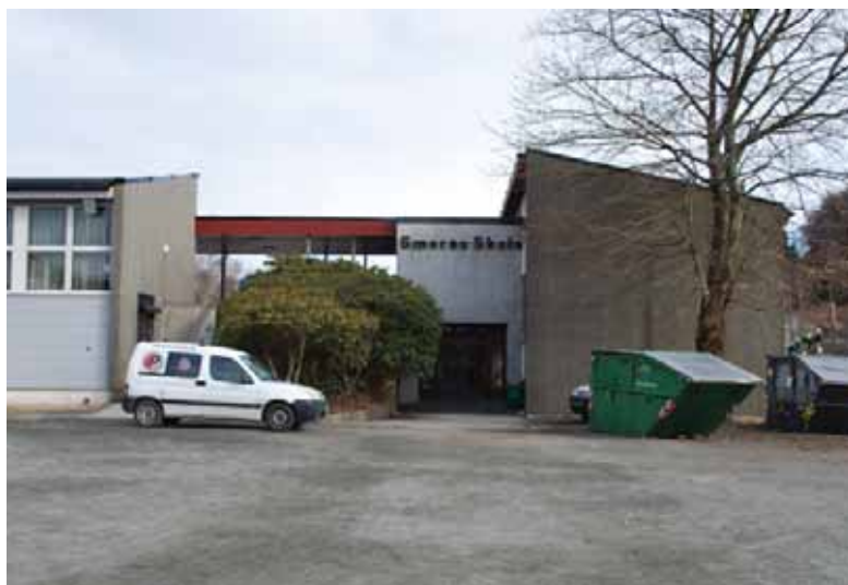
Deler av fasade mot sør-vest. Gjennomgang til skoleplass via trapp.
