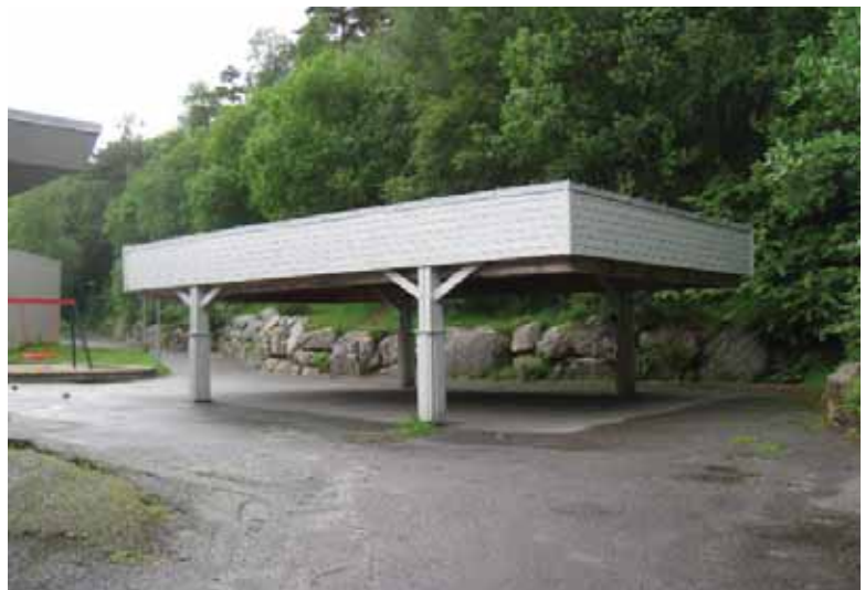
Leskur i nord er et kraftig, flatt tak opplagret på søyler. Utført i tre.
