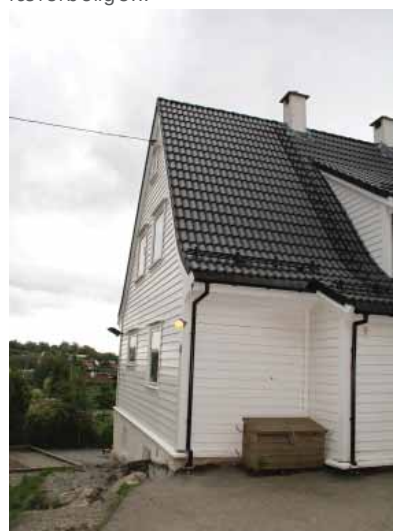
Lærerboligens fasade mot nord-øst.
