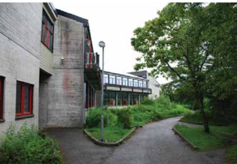
Anleggets fasade mot nord og vest er i to etasjer.
