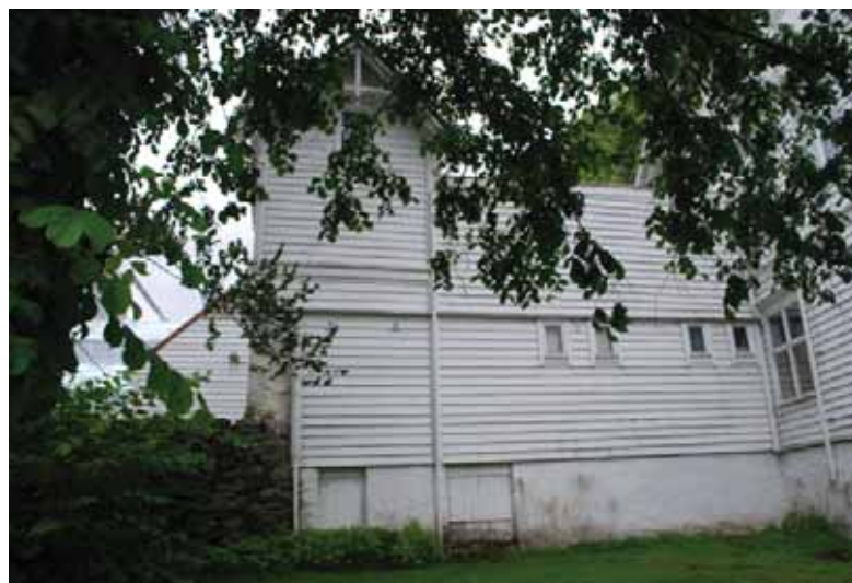
Toalettbygningens vestre fasade.
