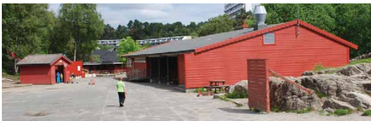
Tilskuddsbygg I (1976): Modulbygg i trekonstruksjoner. Bygget på langs fasaden i vest.
