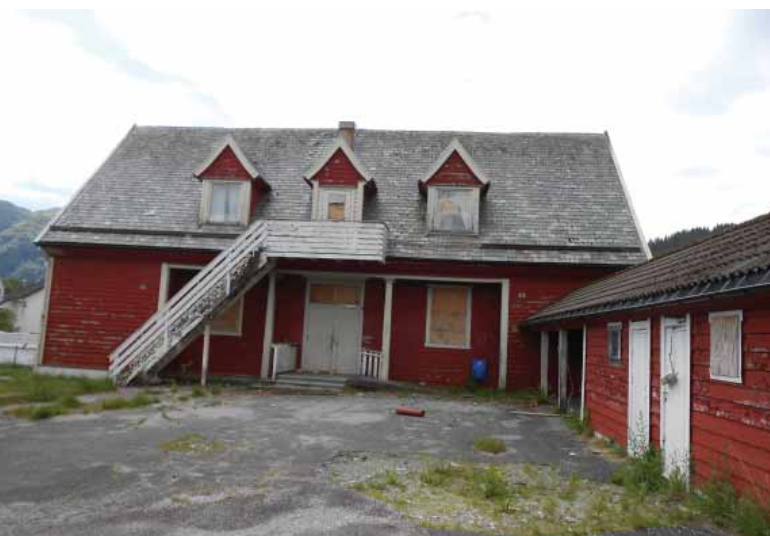
Gamleskolens fasade mot nord. Inntrukket inngangsparti med autentiske, nyklassistiske detaljer.
