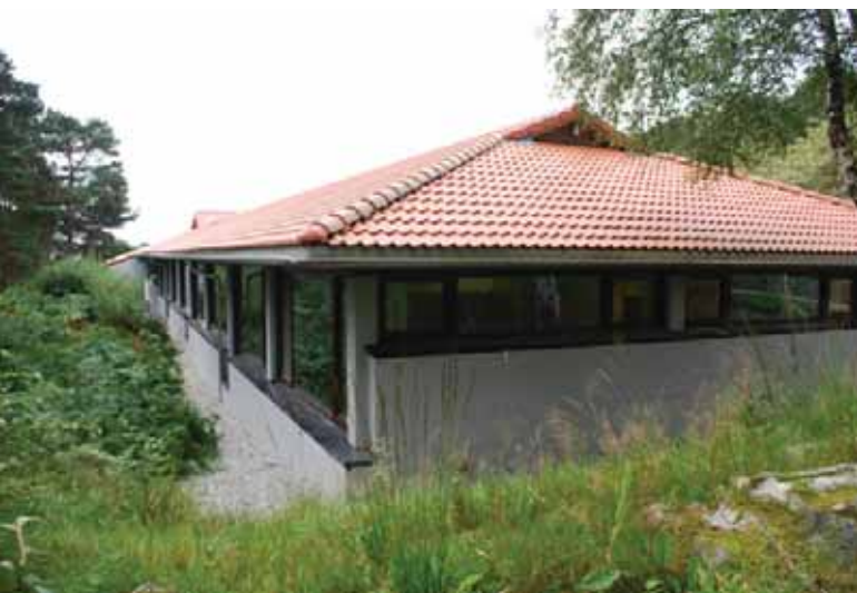
Fløy C fra nord-øst. Vindusbånd og lesbar konstruksjon.
