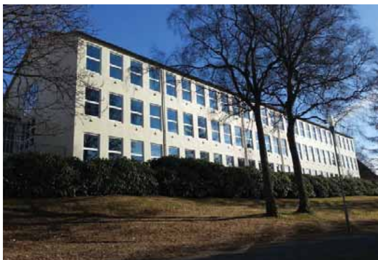
Klasseromsfløy 1a (1961): Fasade mot Tveitevannet i vest. Vinduene i klasseromsfløyen er jevnt fordelt i fasaden.
