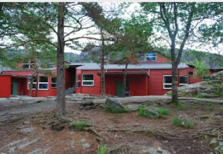
Figur 15: Loddefjord skole har et variert fasadeuttrykk med irregulært takform og ulike vindusstørrelser.
