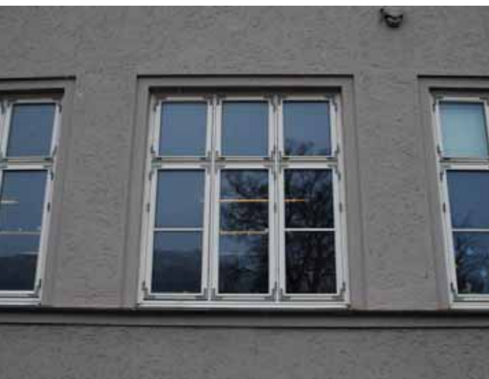
Vinduene er artikulert med puss- og dybdevariasjoner.
