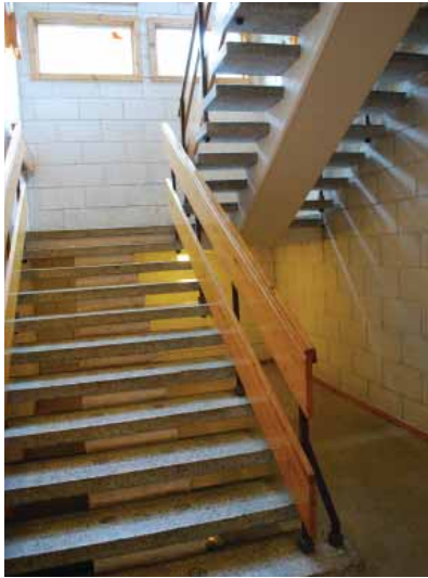
Svevende trappetrinn i slipt terrasso på sentral vange i betong.
