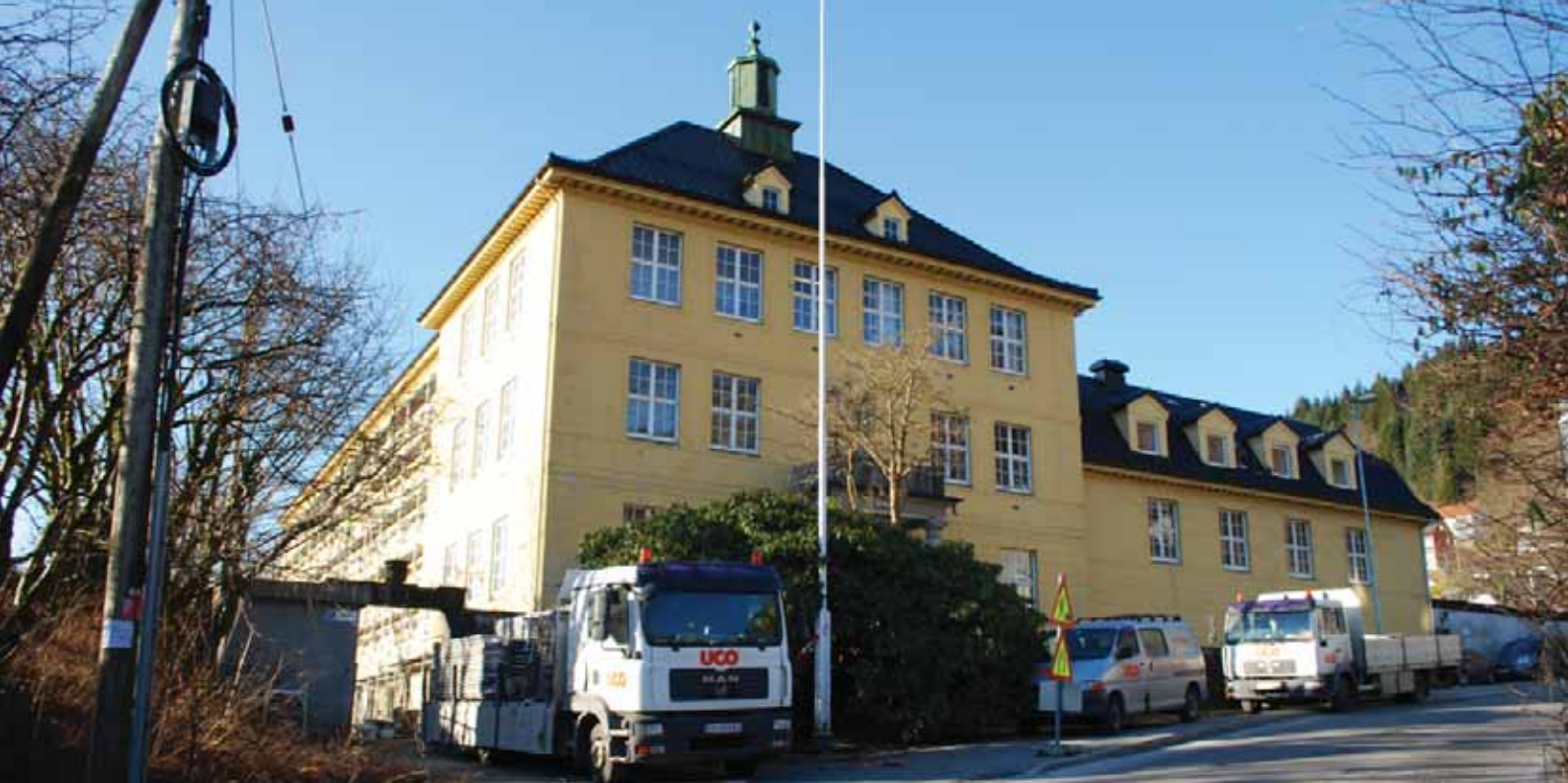
Minde skole sett fra nord-øst. Hovedfasader. Klasseromsfløyens siderisallitt med hovedinngang bak buskene og tårnhjelm. Gymsallfløyen til høyre som et lavere volum.
