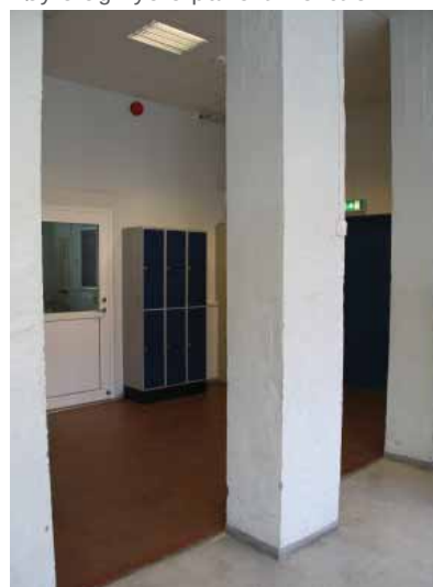
Opprinnelig vegg, med opprinnelig korridor med gamle teglfliser innenfor.
