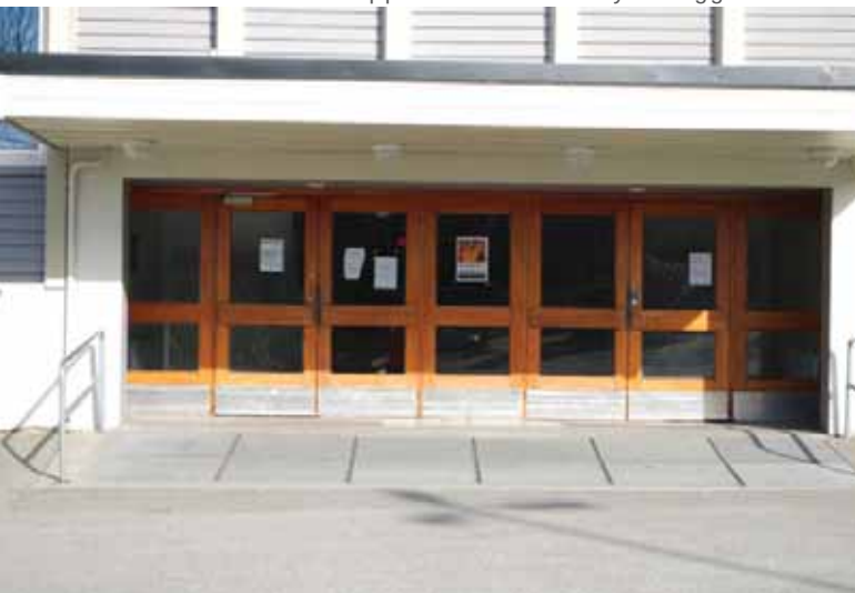
Trolig originale tredører i hovedinngangen. Flere innganger på anlegget har bevarte dører.
