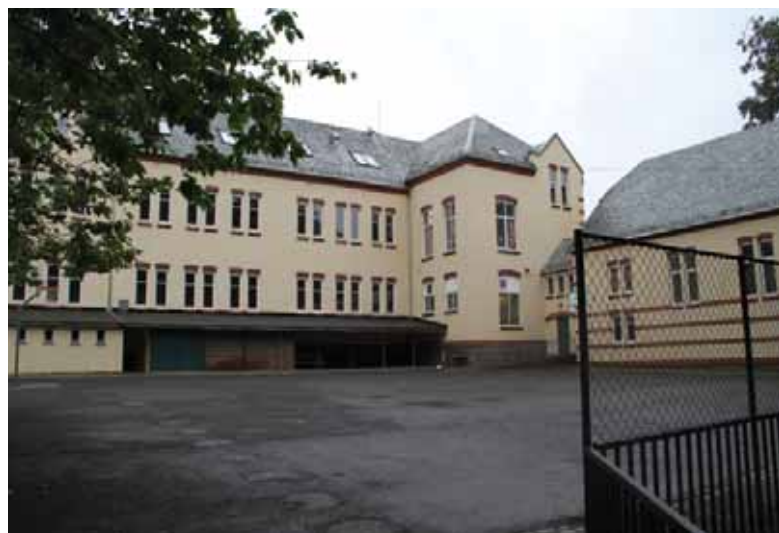
Fasade mot skolegården er enklere i utforming og detaljering. Leskur i kjelleretasje.
