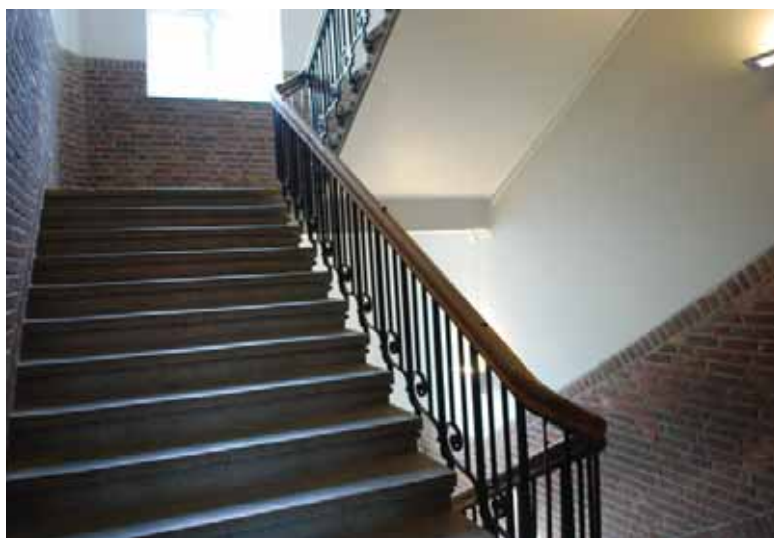
Trapperommene er meget godt bevart, med autentisk tegl i brystning, trinn i slipt terrasso og flott smijernsrekkverk.
