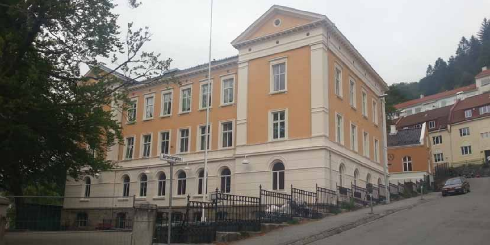
Hovedbygningen sett fra sør.
