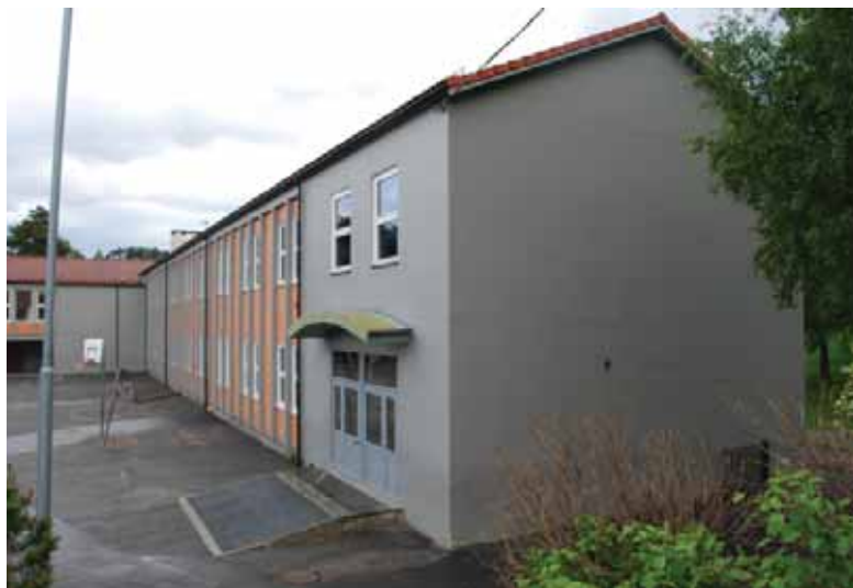
Fløy 1A: Massivt hjørneparti i betong i sør med inngang og trapperom. Buet baldakin.
