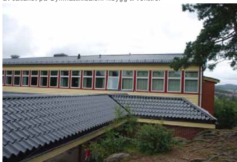
Leskuret har fått saltak med takplater som imiterer glasert takstein, isteden for flatt tak.
