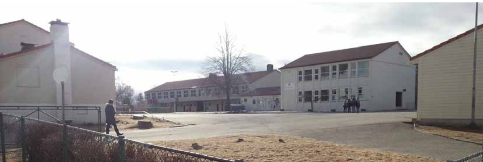
Skoleplassen med Slettebakken skole i midten (1), IB til venstre (4) og gymnastikksalen til høyre (2).
