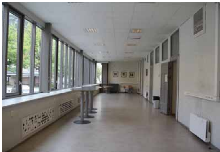
Ny korridor i glasstilbygg utenpå den gamle. Opprinnelig yttervegg til høyre.
