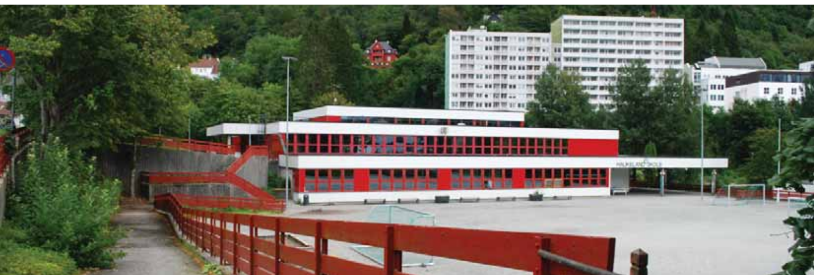
Hovedbyggets vestfasade. Bygningen består av tre flate volum som ligger oppå hverandre.
