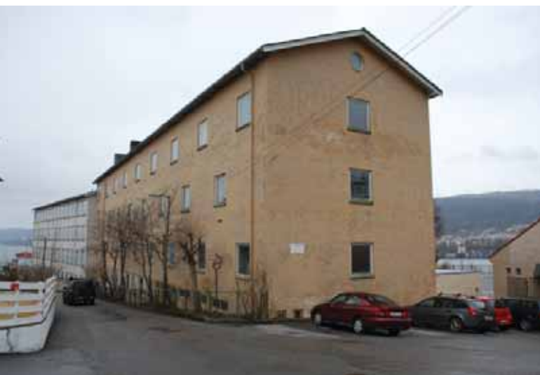
1954-anlegget, bygg 1A.
