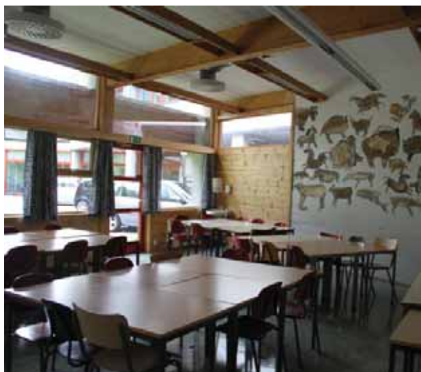
Opprinnelig studierom, i dag benyttet til klasserom. Eksponert konstruksjon, store laminatdragere foran vindu.
