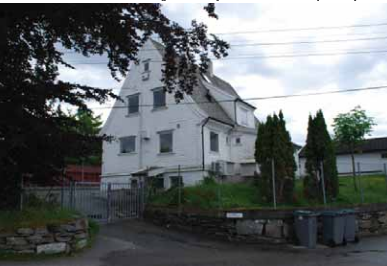
Den gamle Lærerboligen ligger like nord for det øvrige skoleanlegget.
