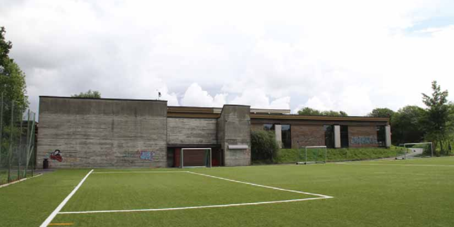
Idrettshallen sett fra nord-vest. Betong og teglvegger.
