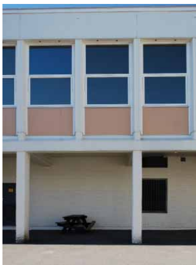
Østre fasade: Rastergrid og tilbaketrukket leskur. Lesbar konstruksjon.
