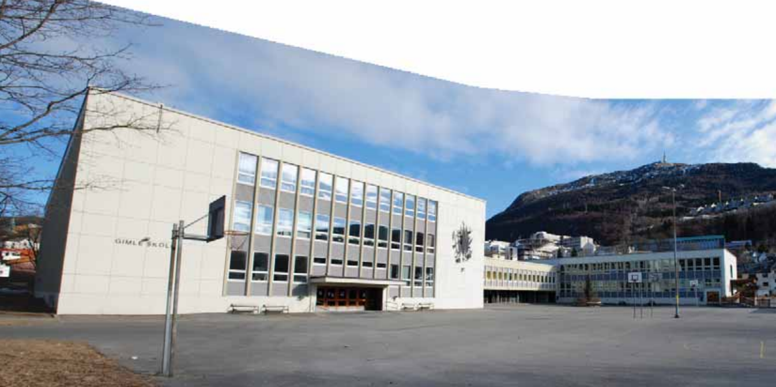
Hele anlegget sett fra sør-vest. Hovedbygningen til venstre og klasseromsfløyen til høyre er koblet sammen med en slankere bygning.
