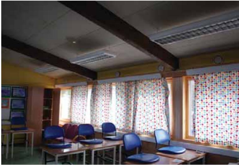
Skrå himling, overlys og synlige bjelker i klasserommene.
