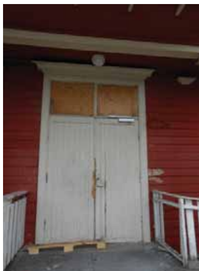
Overdekning med tannsnittbord. Deler av pilaster ses til venstre.
