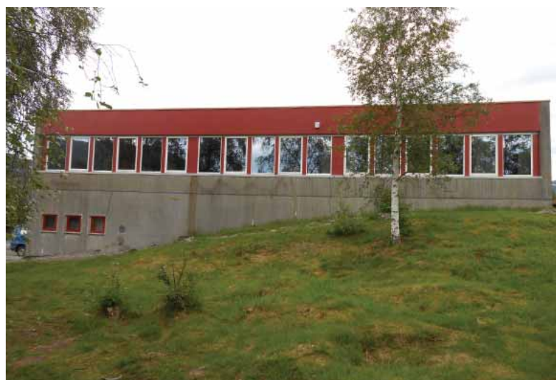
Blokk C: Fasade mot sør.
