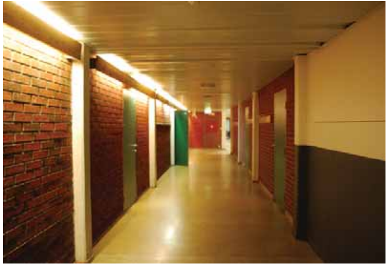
Anlegget har typisk midtkorridor, men med breddevariasjoner og forskyvninger. Eksponert søyler, betongvegger og tegl i interiør.
