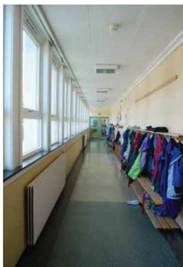
Korridor 3. etasje, kl.fløy (1966).
