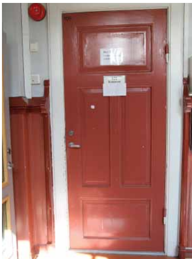
Bygg nord: Dører
