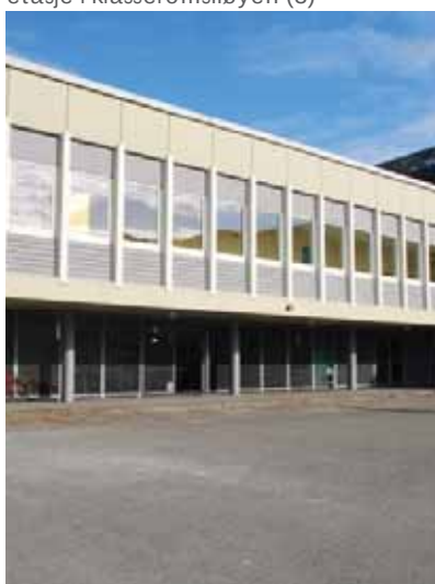
Mellombygningens fasade mot skoleplassen i sør.
