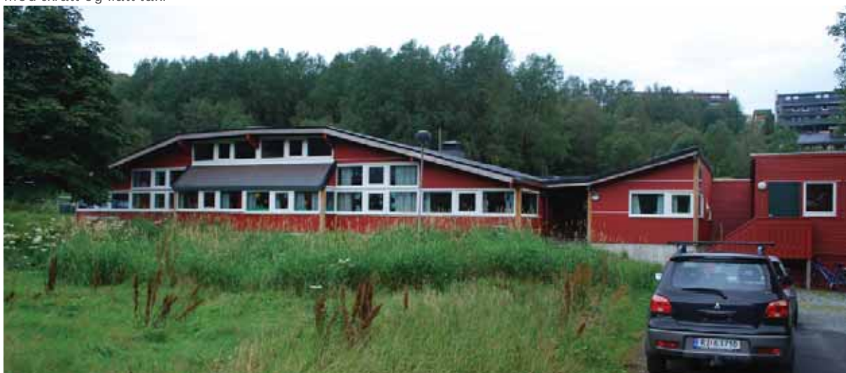
Kollåsen skole sett fra øst. Tilbygg helt til høyre med flatt tak.
