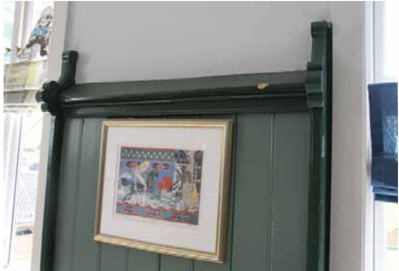
Bygg nord: Brystning i nygotikk.
