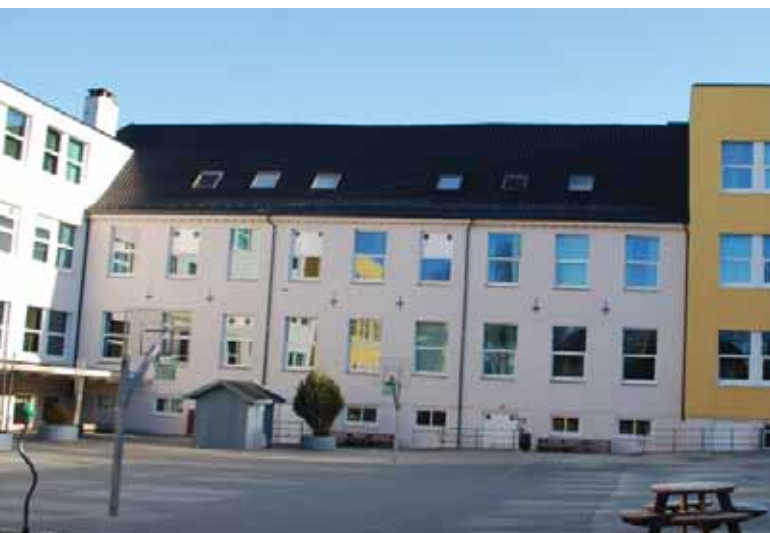
Klasseromsfløyen (1917) er tilbygget på flere sider, og opprinnelig valmtak og arker er fjernet.
