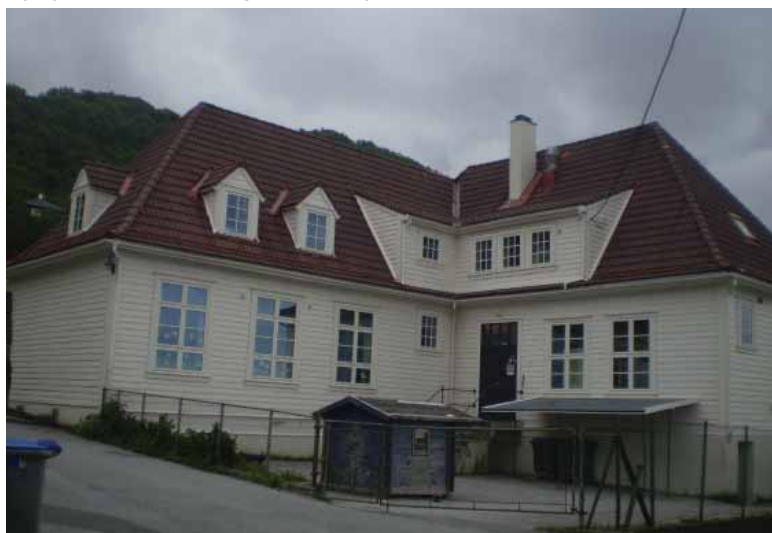
Gamleskolen fasader mot vest. Ved å sammenligne med bildet under, ser man at eksteriøret er godt bevart. Dør til venstre er byttet med vindu.
