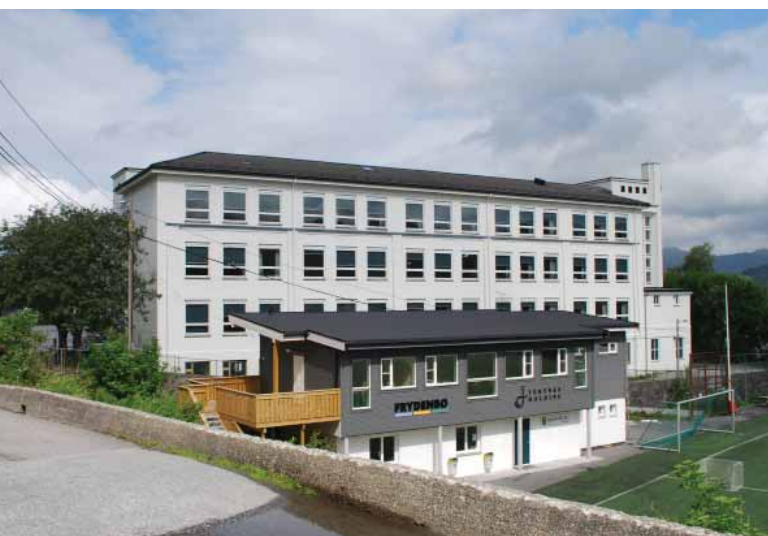
Hovedbyggets klasseromsfløy (1952) fra sør-øst.
