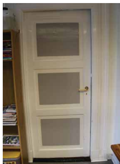
Opprinnelig dør og listverk i lærerboligen.
