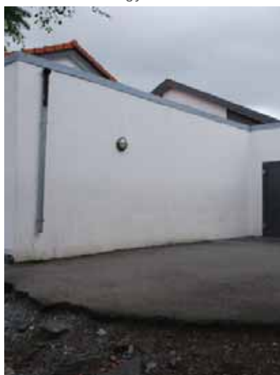
Sammenkobling (2004) av ny og opprinnelig fløy.
