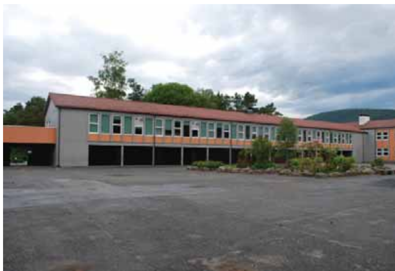
Fløy 1B: Eksponerte søyler i fasaden, tilbaketrukket leskur. Massive hjørnepartier i betong med trapperom.
