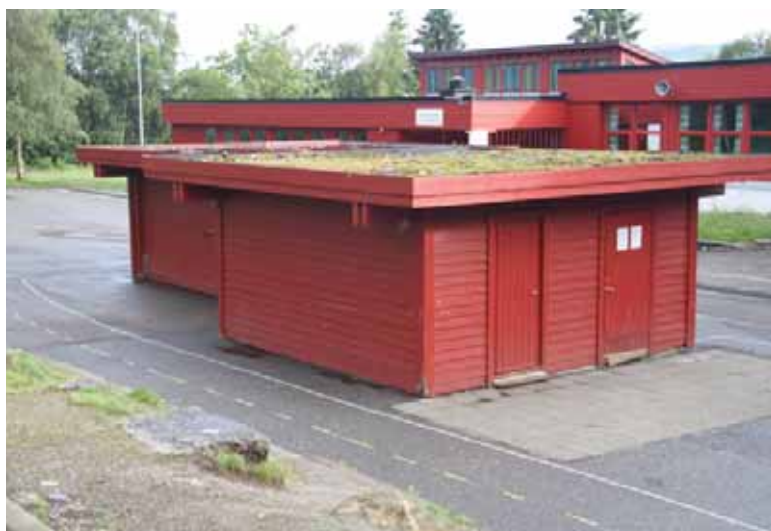
Leskurene står i stil med hovedbygningen. Opprinnelig kun overbygg, nyere kledning.
