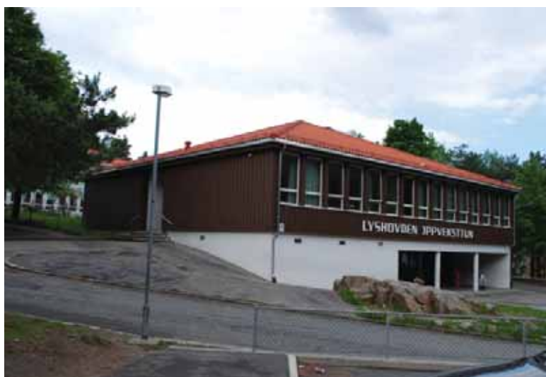
Tilskuddsbygg (1974) i én etasje og sokkel med tilbaketrukket leskur. Lik plan og fasade som paviljongene i hovedbygget. Åpne langfasader.
