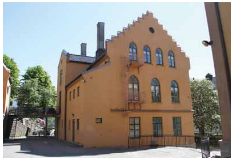
Bygg sør sett fra nord.
