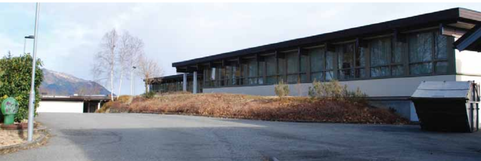
Anlegget sett fra sør.
