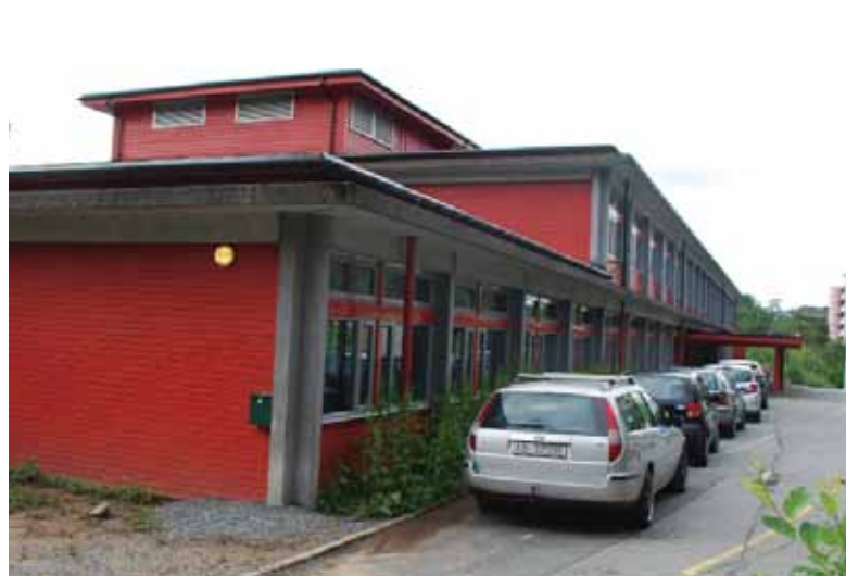
Fasade mot vest, med vindusbånd, søyler og dekker i grid.
