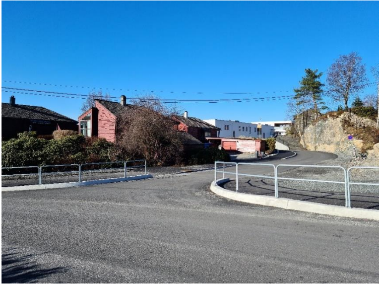
Figur 10: Ny tilkomst fra Sætervegen, etablert i forbindelse med realisering av prosjektet i Fanavegen 46-50. Kilde: Opus
