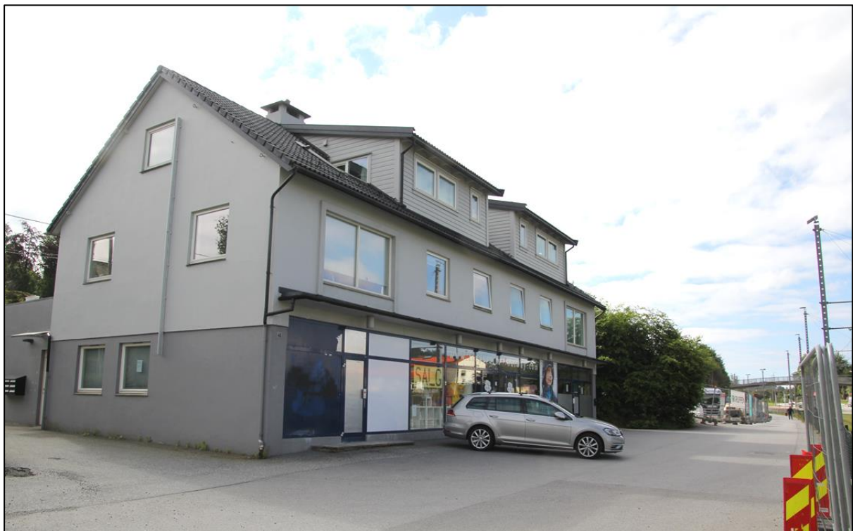
Figur 11: Vestlige del av planområdet som vil bli transformert. Dette arealet har lite innslag av biologisk mangfold. Fotografert mot sør 10.7.2019: Opus.
