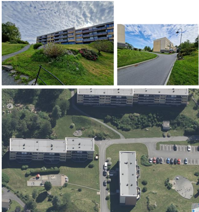
Figur 3-5 Skjold borettslag. Kilde bilder: 1881.no skråfoto (nederst) og Multiconsult.
