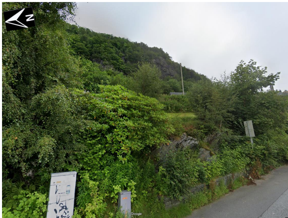
Figur 3-7: Utklipp fra Google Street View fra Haukelandsbakken mot øst viser at det er berg på dagen.
