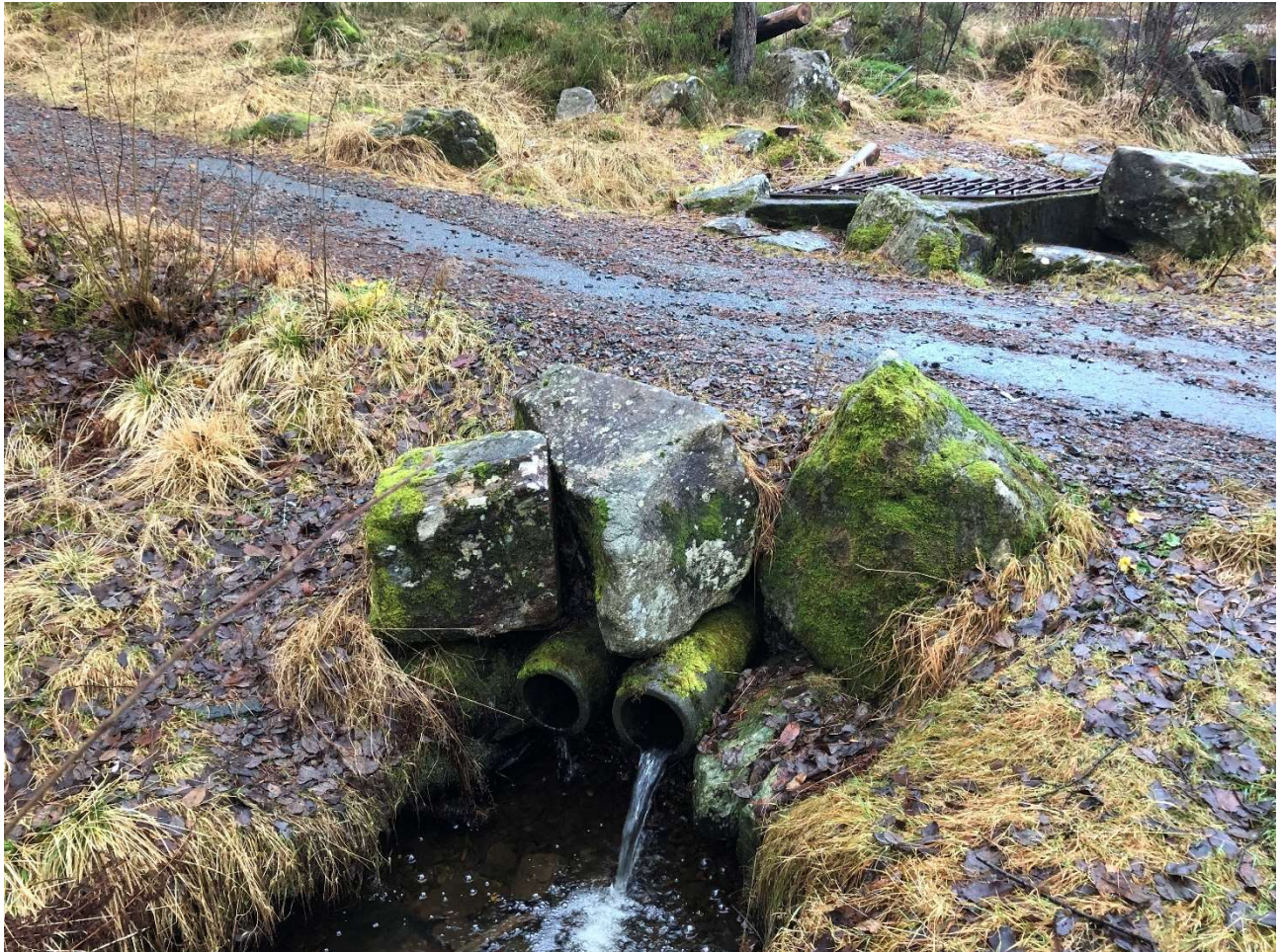
Figur 11 Bildet viser eksisterende bekk der den krysser gangvegen som går mellom Loddefjordlien og planområdet.
