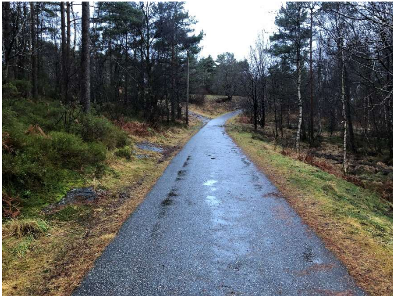
Figur 5 Eksisterende gangveg får tilrenning av overvann fra skråningen øst for Haugatun barnehage.
