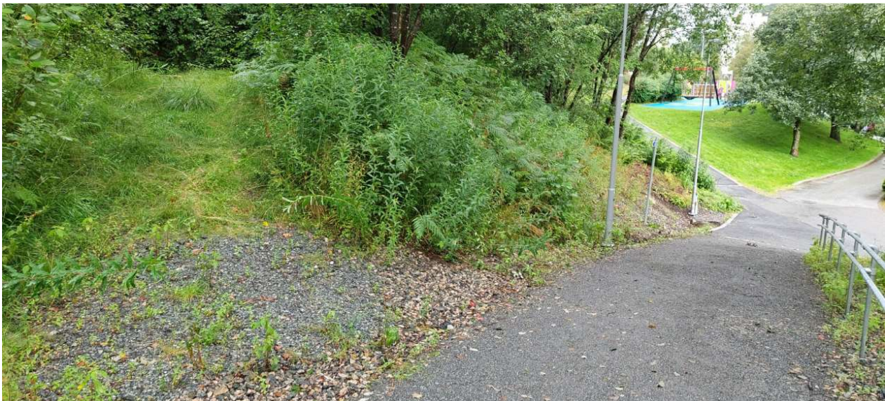
Figur 13 Eksisterende bekkeinntak skimtes oppe til venstre i bildet. Ved flom kan vann stue seg opp og renne nedover mot blokkbebyggelse. Mulig tiltak kan f.eks være avskjærende grøft langs asfaltert veg som leder vannet i retning Vestkanten/Bjørndalspollen.
