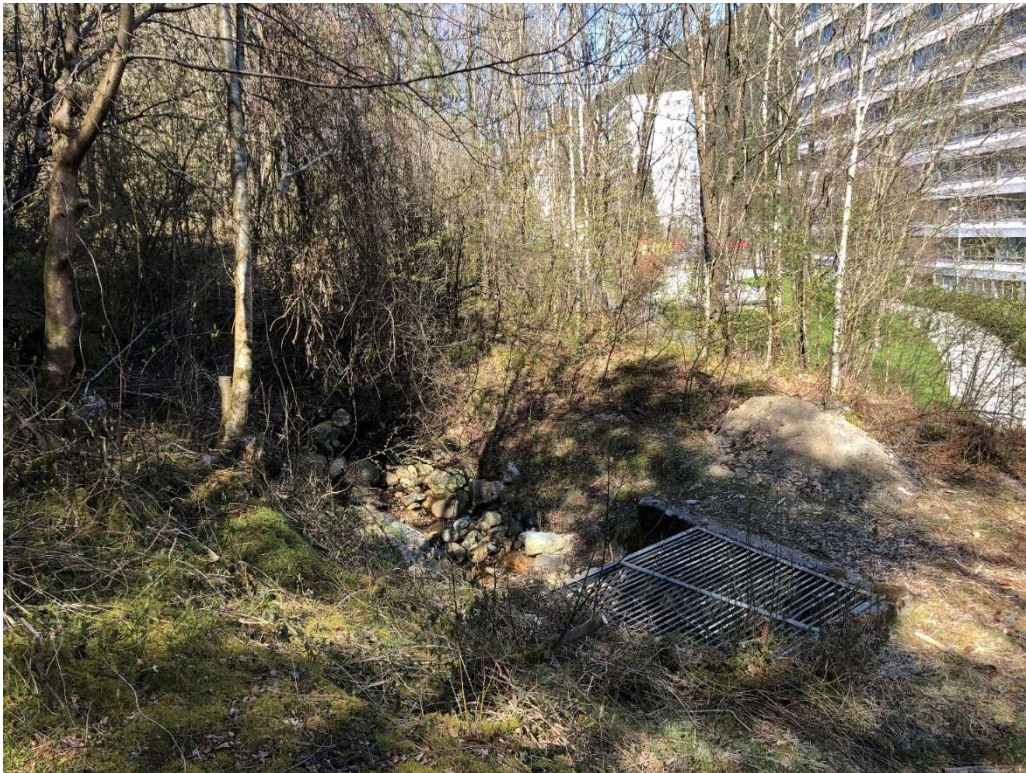
Figur 12 Eksisterende bekkeløp og bekkeinntak nedstrøms planområdet. Her går bekk inn i kommunal OV300-ledning.
