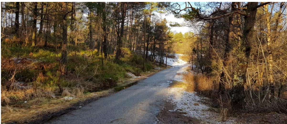
Figur 3: Eksisterende gangveinett i området, sett fra sør. Område 3 på høyre side, område 4 på venstre side
