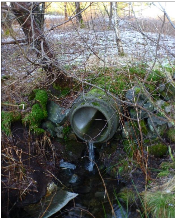
Figur 22. Øverste kulvert i område 3.
