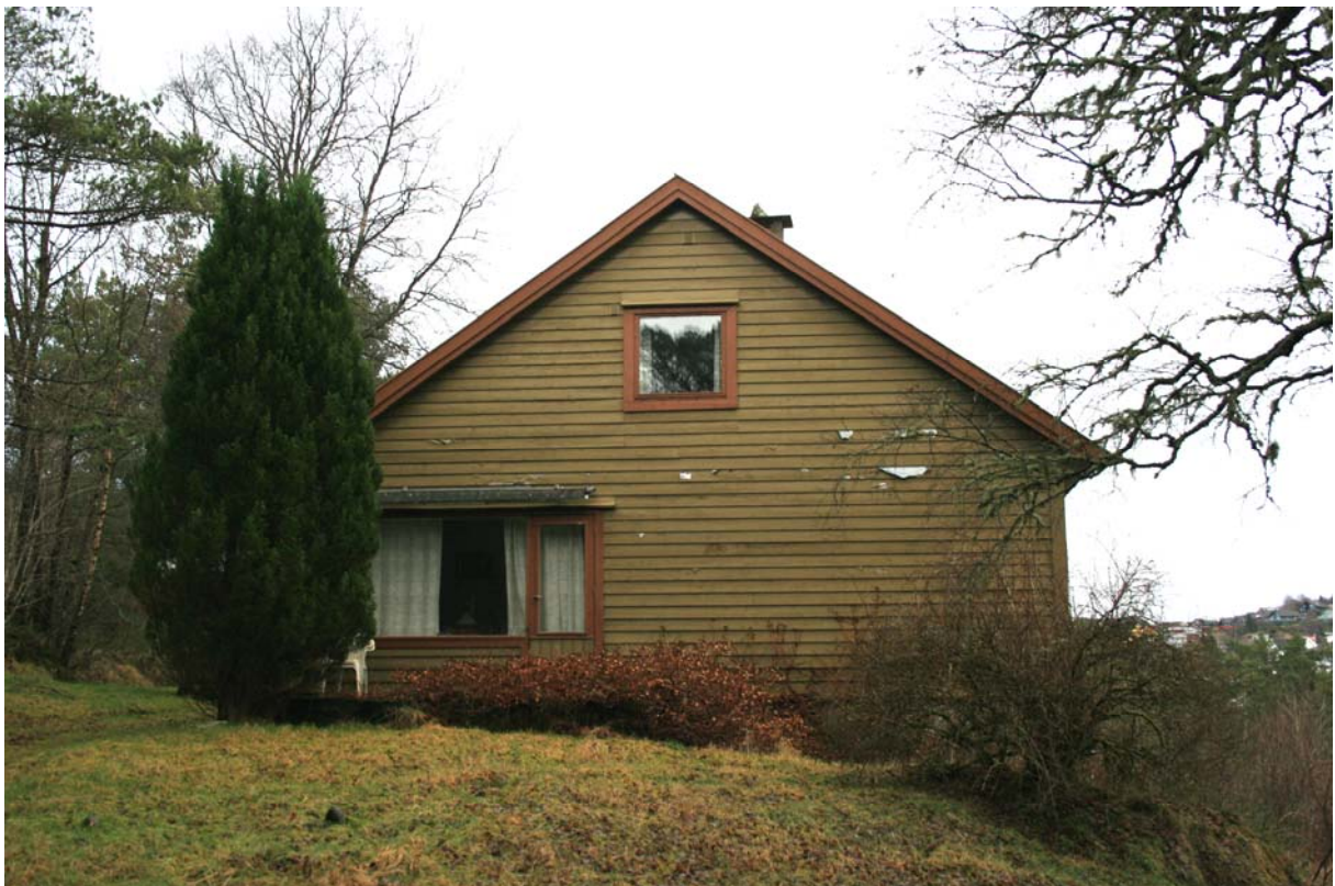
Enebolig på g/bnr 39/8. Søndre fasade.
