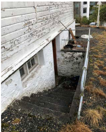
Figur 21 Kjellerinngang på vestsiden av bygget. Sett mot sør.
