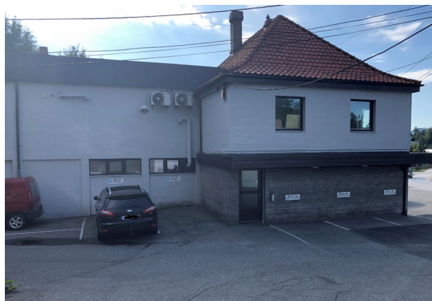
Figur 6-8 Nordvestlig del av bygget sett mot sørøst.
