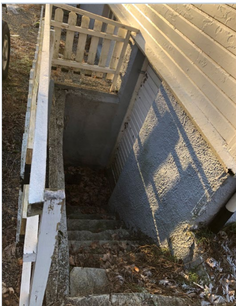
Figur 6-22 Trapp til kjellerinngang på østsiden av huset.
