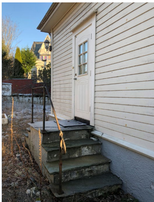
Figur 6-20 Trapp med skiferheller og støpejerns-rekkverk på vestsiden av huset. Døren er nyere.
