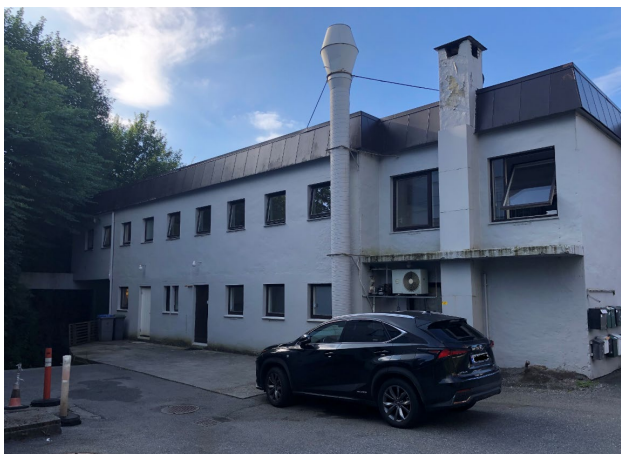
Figur 6-7 Baksiden av tilbygget sett mot sørøst.
