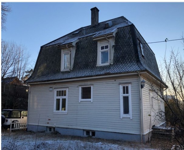
Figur 6-18 Boligen sett mot sør.
