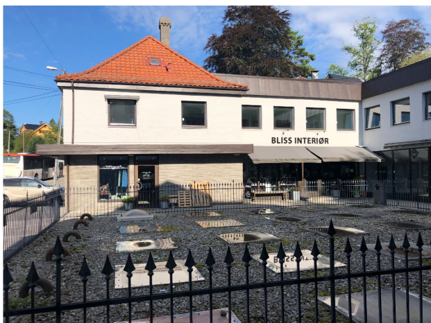
Figur 6-5 Nordvestlig del av bygget sett mot nordvest med lysinnslippsvinduene på bakken i framgrunnen.
