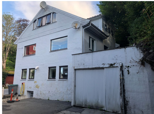
Figur 6-27 Garasje på baksiden av bygget, sett mot nord.
