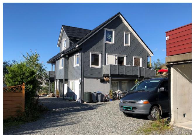
Figur 5-8 Nyere enebolig i Paradishøgda 2A.
