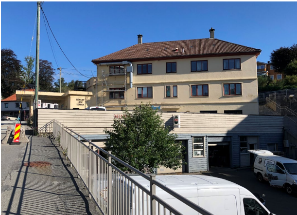
Figur 5-9 Næringsbygg i Sandbrekkevegen 1.
