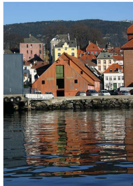
Bjøreboden. Sammen med Nøsteboden ved Nøstetorget er dette én av to gjenværende boder i Nøstebukten i dag. Opprinnelig lå bodene tett langs sjølinjen også i dette området, med en klar logisk plassering i forhold til bruk, vær, vind og tomteforhold.
