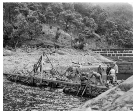
Tre generasjoner dammer; den fremste fra mølledriften, den andre fra 1854 bygget i for byens første vannverk, den tredje fra 1881. I dag ligger alle disse under vann i og med at byggingen av Svartediksdammen i 1953 hevet vannspeilet med 11 meter. Svartediksdammen er et statlig listeført teknisk kulturminne. (Foto: Marcus UiB/ ubb-bs-ok-13209.)
