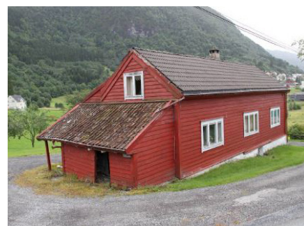
Bevart lemmestov og løe i det skrånende terrenget på Skuggestranda, og lemmestov på Seim vitner begge om det gamle jordbrukssamfunnet. Lemmestovene har høy kulturminneverdi både som en etterhvert sjelden bygningstype og som eksempel på en eldre bygningstradisjon.
