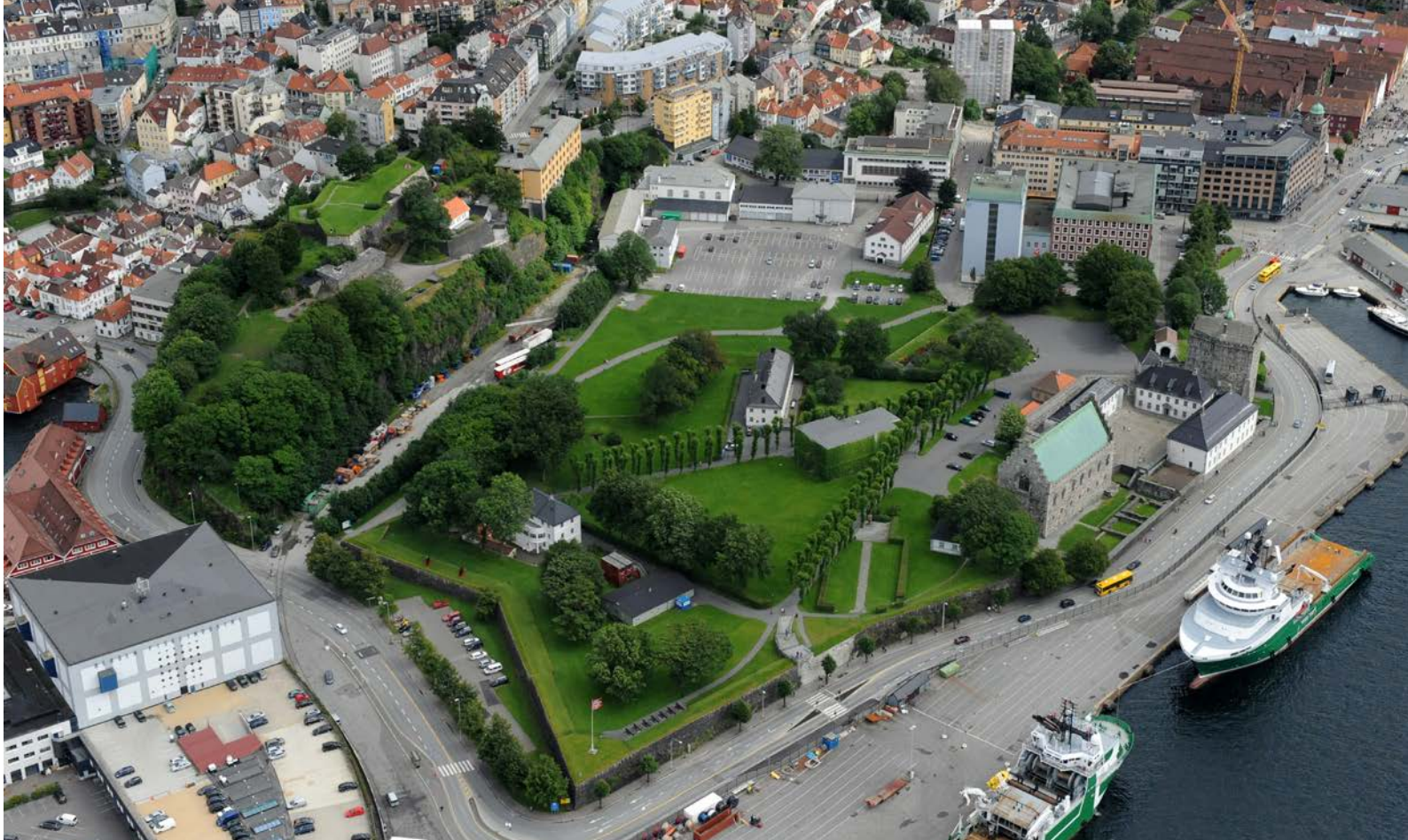
Bergenhus festning, Holmen: Når kongssetet ble flyttet fra Alrekstad ble det etablert her ved innseilingen til Vågen. Ringmuren ble bygget for å beskytte trehusbebyggelsen og den voksende byen, som lå tett på langs hele østsiden av Vågen, mot brann og fiender.
