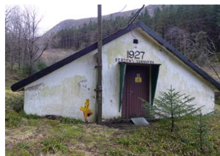
Utrangert pumpestasjon ved Kobbeltveit i Våkendalen.
