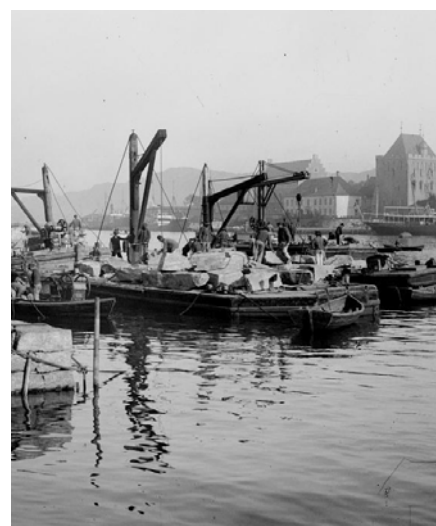
Utbyggingen av steinkaier i Bergen startet på begynnelsen av 1900-tallet. Da fikk man en transformasjon av Vågen fra et sjøbodmiljø til et kaimiljø. Kilde: ubb-bros-02026_md Fundamentering av pakkhus mel 1901 og 1910
