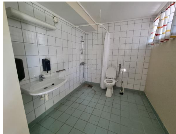
Bilde nr. 2.27 Fliser på gulv og vegger på baderom.
