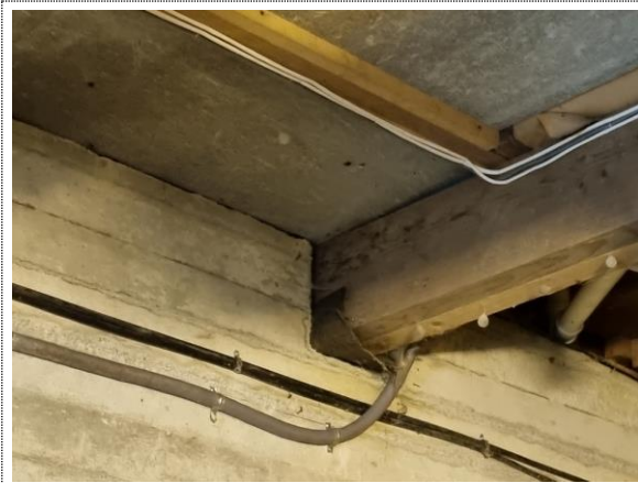
Bilde nr. 2.07 Innfestning av drager under bjelkelaget mellom U.etg og 1.etg.
