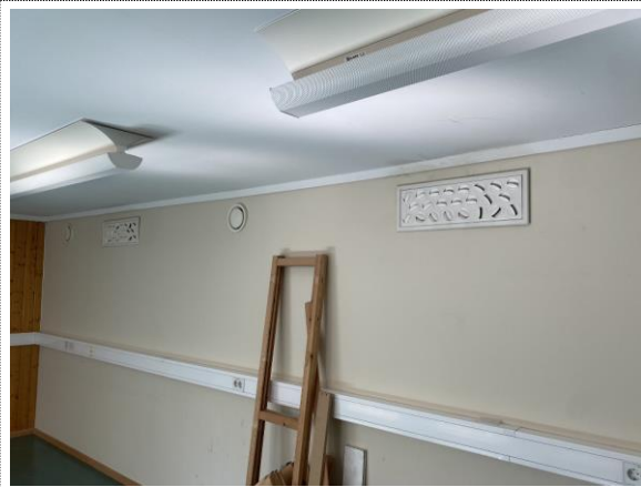
Bilde nr. 2.23 Gipsvegg med slett overflate, antatt fra ombygging.
