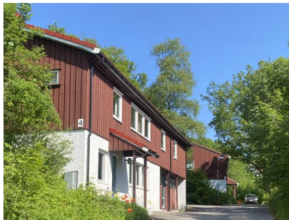
Bilde nr. 2.01 Oversiktsbilde av bygg 4
