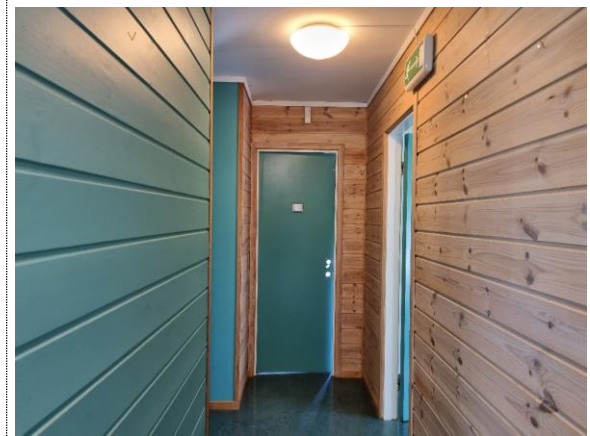
Bilde nr. 2.26 Innervegger med malt og beiset trepanel.
