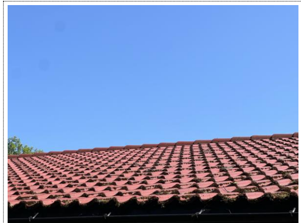
Bilde nr. 2.38 Yttertak, takstein i rød teglstein.
