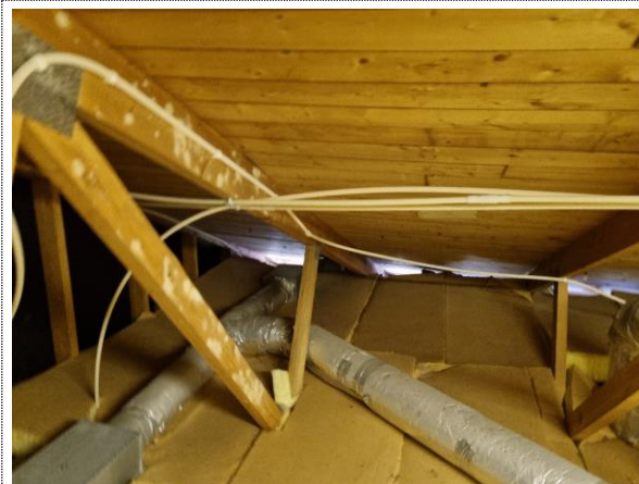
Bilde nr. 2.31 Kaldt loft. Isolasjon over bjelkelag.
