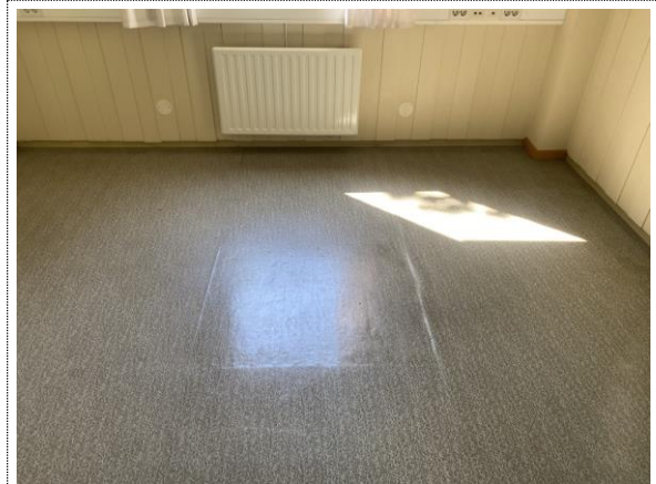
Bilde nr. 2.32 Gulvoverflate av banebelegg.
