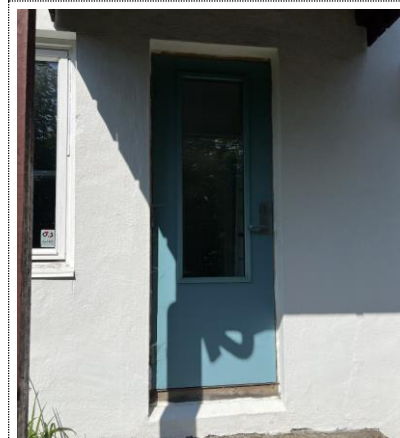
Bilde nr. 2.18 Smal inngangsdør i aluminium.
