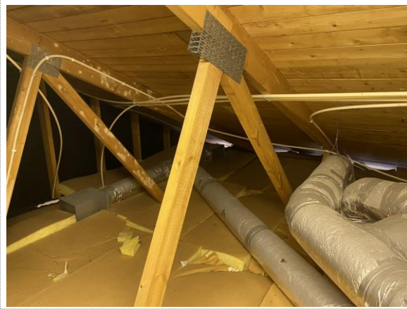
Bilde nr. 2.41 Liggende bord tilhørende yttertak.
