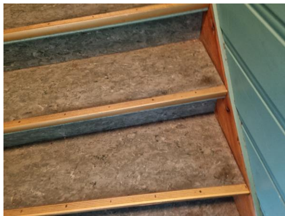
Bilde nr. 2.45 Innvendig trapp, linoleumsbelegg.
