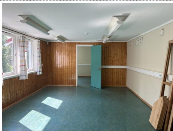
Bilde nr. 2.35 Gulvoverflate av banebelegg og himling av gips.
