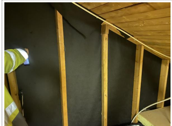
Bilde nr. 2.40 Gavlvegg på kald loft.
