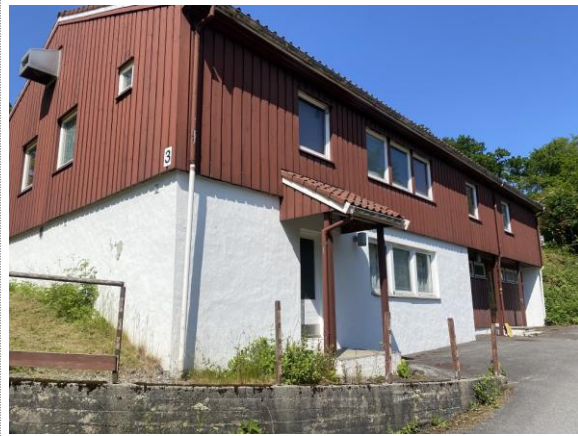
Bilde nr. 2.43 Takrenner, malte nedløp.
