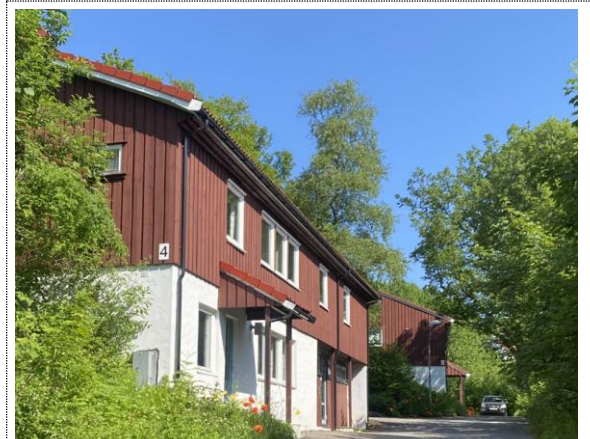
Bilde nr. 2.08 Yttervegger på bygget. Betong med murpuss i U.etg. og trekledning i 1.etg.
