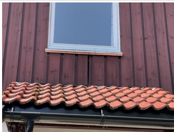
Bilde nr. 2.39 Tak på overbygg, takstein i rød teglstein.
