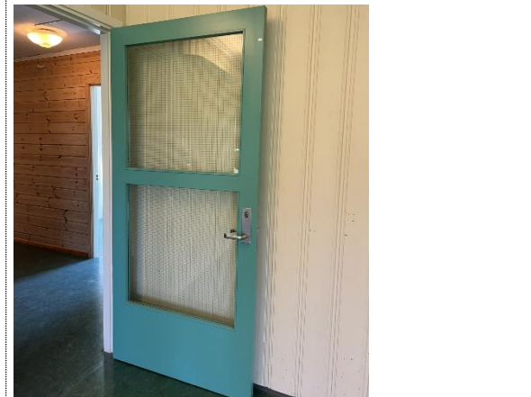
Bilde nr. 2.28 Laminert innerdør med glassfelt.
