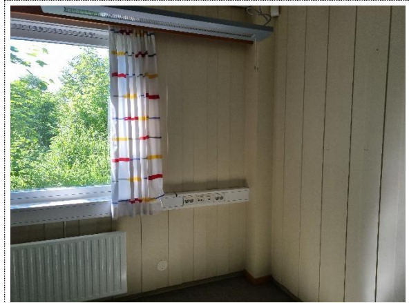
Bilde nr. 2.24 Innervegg med malt panel.
