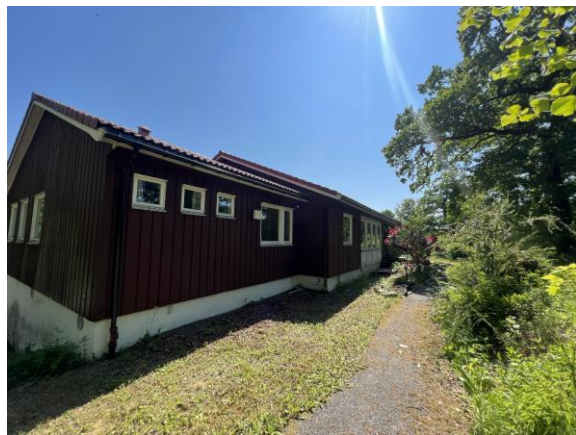
Bilde nr. 7.02 Området bak bygget.
