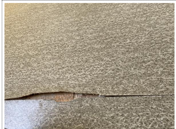
Bilde nr. 2.34 Gulvoverflate av banebelegg, belegget slipper overflaten.
