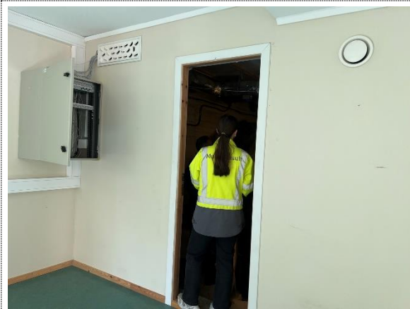
Bilde nr. 2.05 Betongvegg fra bilde nr. 2.04. påforet mot innredet del av bygget.
