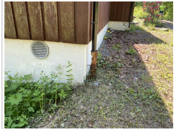
Bilde nr. 2.44 Nedløp ned i grunnen
