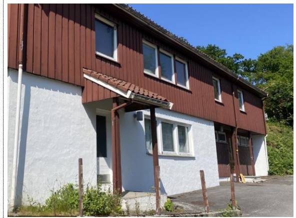
Bilde nr. 2.46 Overbygg til ytterdør, og utkraget del av 1.etg danner et overbygg over hovedinngangsdør i U.etg
