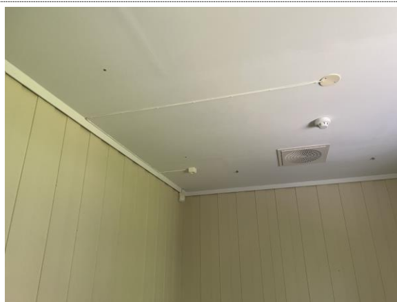
Bilde nr. 2.37 Himling av gips.
