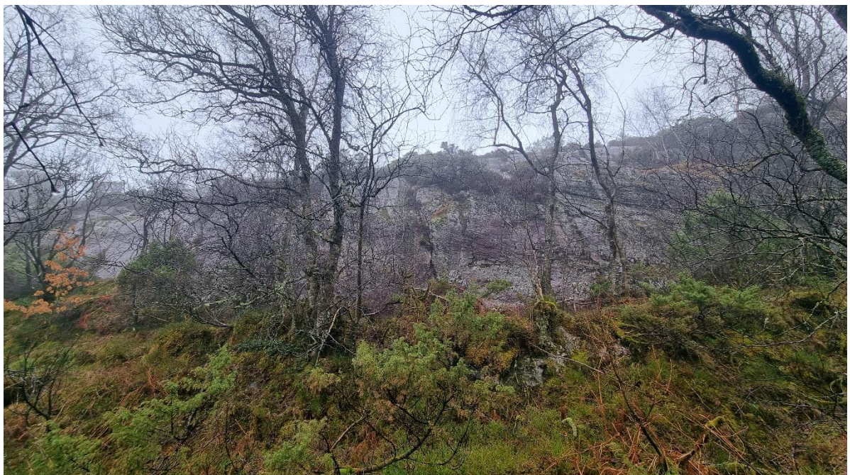
Figur 3: Deler av bergskråning hvor det er aktuelt med rensk, spredte kamstålbolter og muligens steinsprangnett. Bildet er tatt mot nordvest innenfor eksisterende hensynssone H301, i overgangen mellom område regulert til friområde og uteoppholdsareal.
