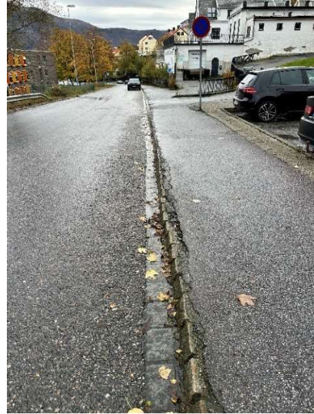
Figur 62: Parkering tett på eksisterende fortau, sør for eksisterende veg
