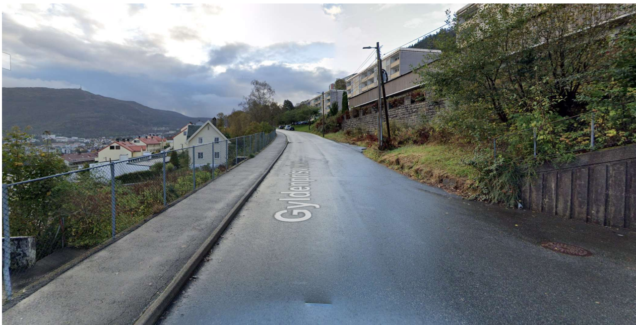
Figur 59 Gyldenprisvegen etter Frydenbølien holdeplass. Fortauet ligger på en høy mur langs gaten oppover. På motsatt side er det rom for utvidelse i grøntareal.
