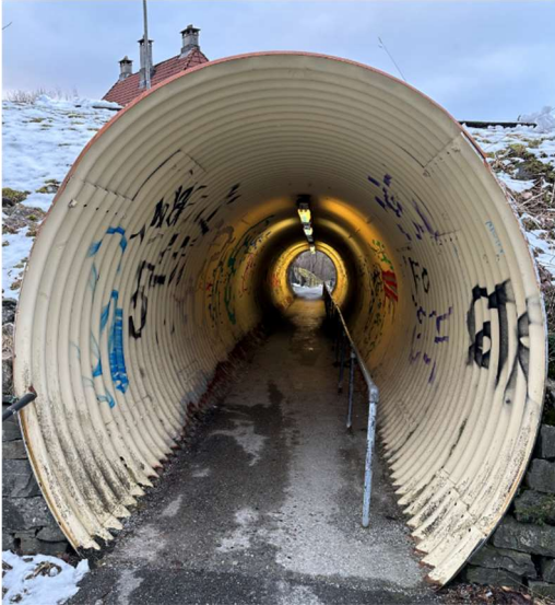
Figur 103: Oversiktsbilde innside kulvert
