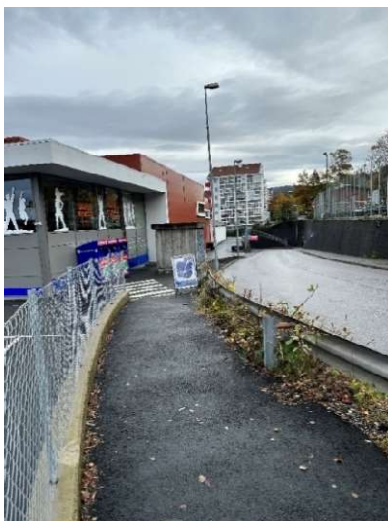
Figur 66: Trafo og mur tett opptil
