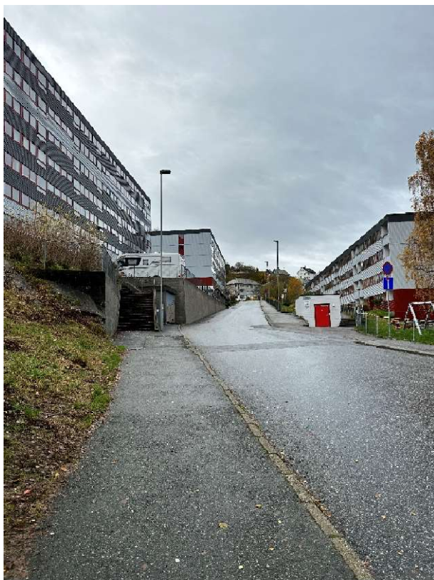
Figur 31 Dagens situasjon i bunn av Frydenbølien. Sett mot Gabriel Tischendorfs vei. Eksisterende trafo på venstre side av vegen og bosskur på høyre side av vegen (med rød dør)
