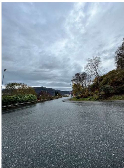
Figur 28: Frydenbølien med fortau på sørsiden av veien i kryssområdet. Utflytende kryss
