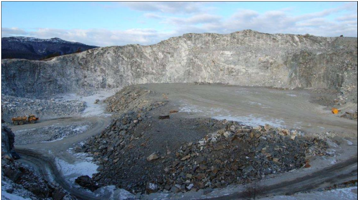
Figur 5: Bilde av bruddet sett mot nord. Foto tatt: vinter 2013 (Foto: NCC)
