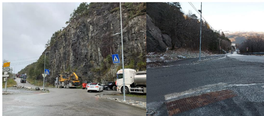
Figur 3 Dagens adkomst til NCCs anlegg. Overgangsfelt er slitt vekk.
