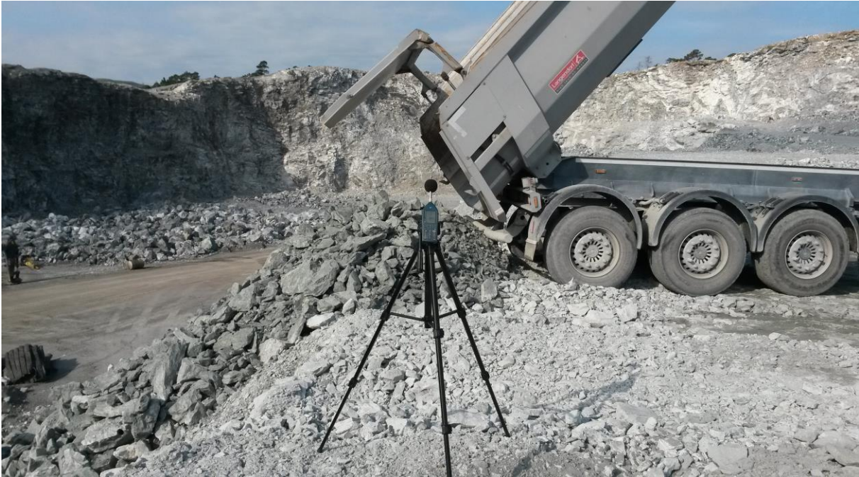
Figur 5-2: Tipping av masser i dagbruddet. Foto: AsplanViak.
