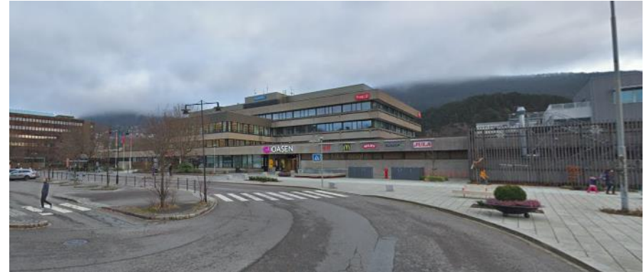
Eksisterende fasade mot vest på Oasen kjøpesenter framstår som lukket.
