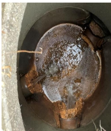
Figur 6-8: Bilde ned i kum i skytebanen. Mye jernutfelling tyder på sigevannspåvirkning. Det var ikke farge på vannet eller lukt i kummen ved åpning av den.
