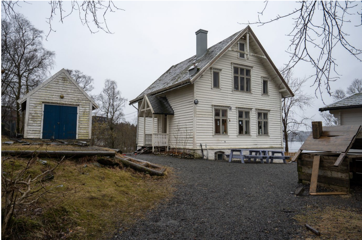
Figur 4: Bygget som ble totalskadet i en brann 4. mai 2019.
