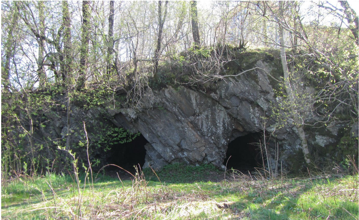
Figur 5: Inngang til dekningsrom
