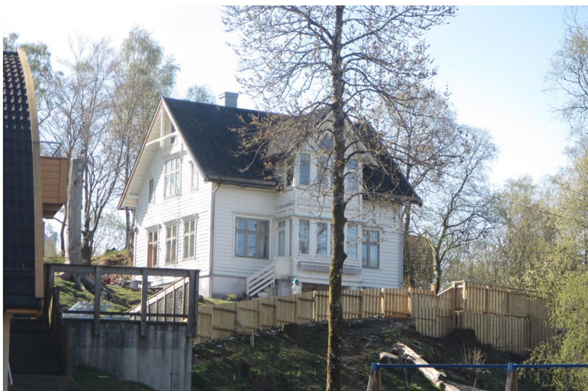
Figur 10: Bygningen før den brant ned i 2019.
