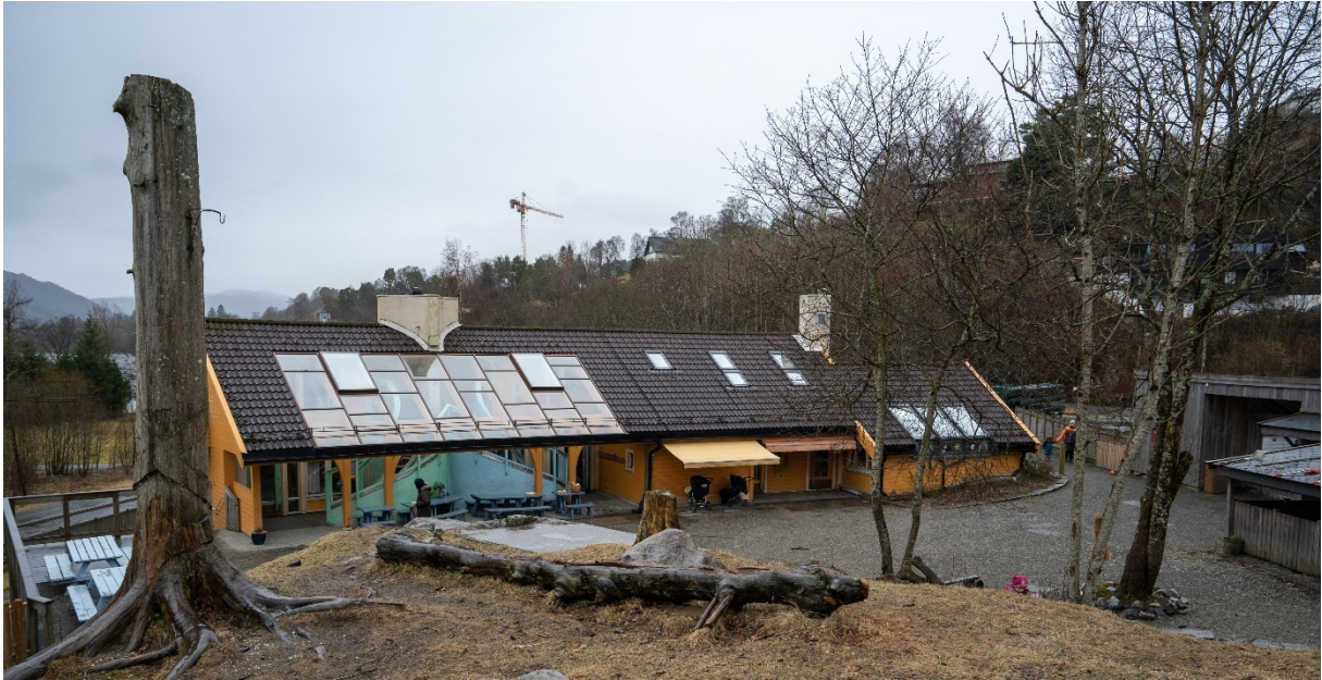
Figur 19: Barnehagen sett fra vest. Legg merke til det overdekte utvendige trapperommet.
