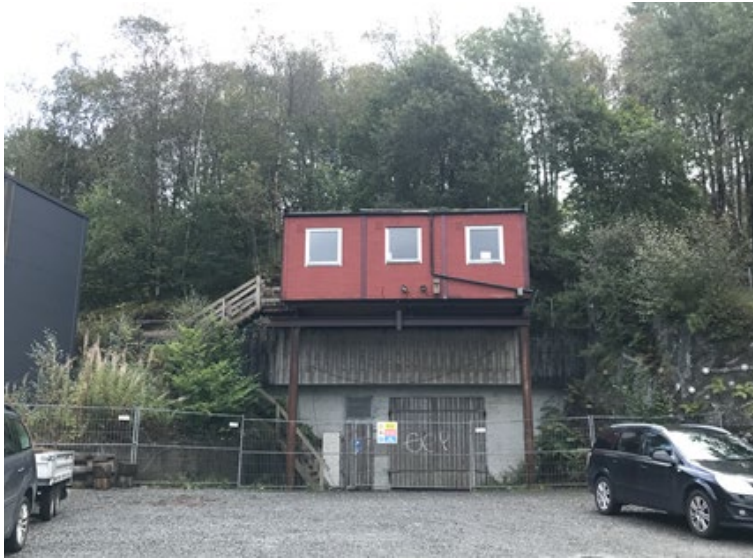
Figur 26: Anleggsbrakke for VA-anlegg i fjell.
