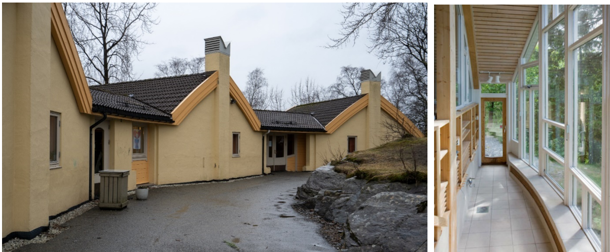
Figur 9: Småbarnstrinnet sett fra sør og klimasonen for forvarming/kjøling av luft Kilde: Foto av klimasone: Arkitektgruppen Hus..
