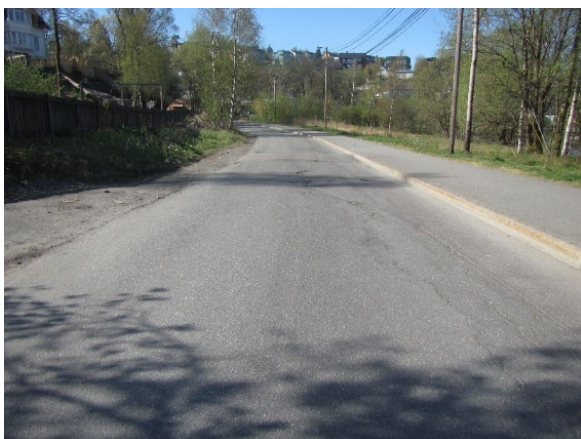
Strekningen ved Harald Skjolds veg er opparbeidet med fortau.
