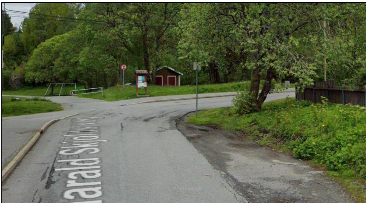
Figur 3-2 Sykkelfelt avsluttes før høyresvingen og treet i innerkurve.
