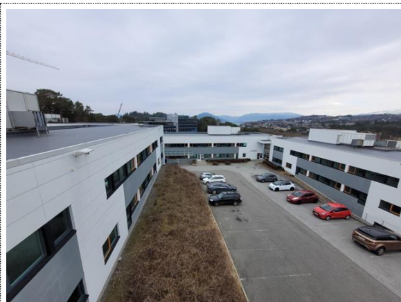
Bilde nr. 2.02 Oversiktsbilde mellom bygg F og H
