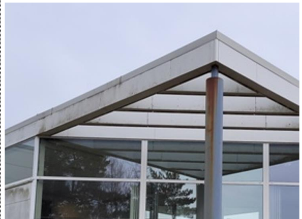
Bilde nr. 2.70 Skjermtak og tilhørende stålbering
