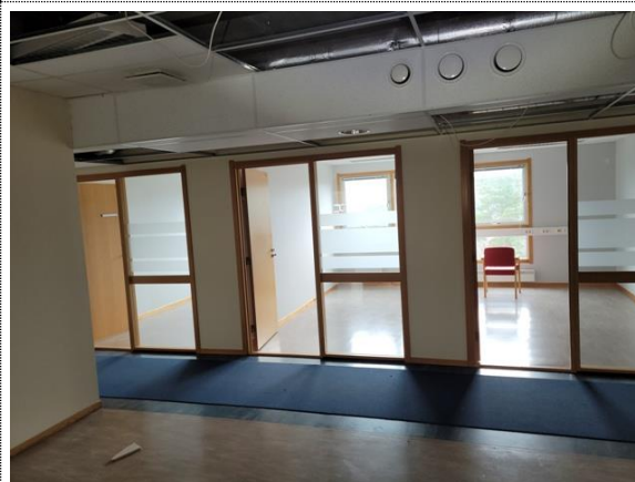
Bilde nr. 2.40 Innervegger
