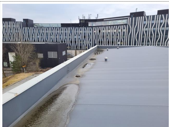
Bilde nr. 2.55 Yttertak bygg A
