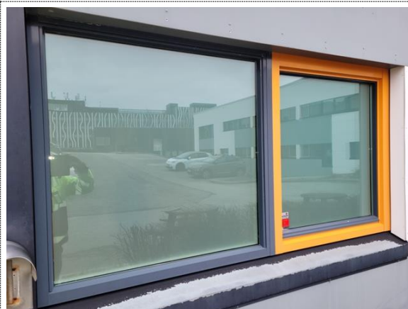
Bilde nr. 2.28 Vindu og vannbrett utvendig side
