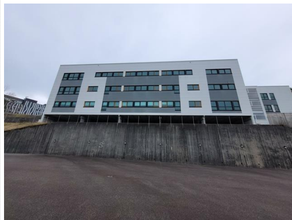
Bilde nr. 7.07 Støttemur mot fylling
