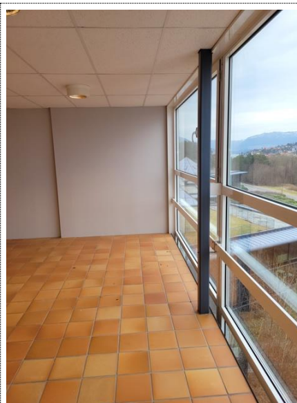
Bilde nr. 2.30 Glassfasade innvendig
