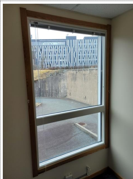
Bilde nr. 2.38 Innvendig solavskjerming
