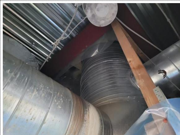
Bilde nr. 2.60 Utett dampsperre rundt ventilasjonskanal bygg E
