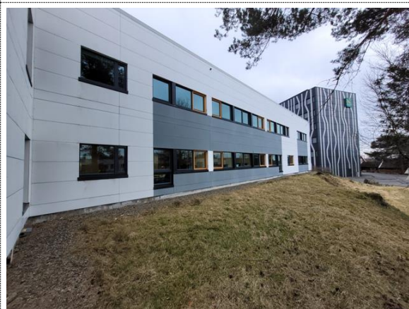
Bilde nr. 2.06 Fasade mot øst
