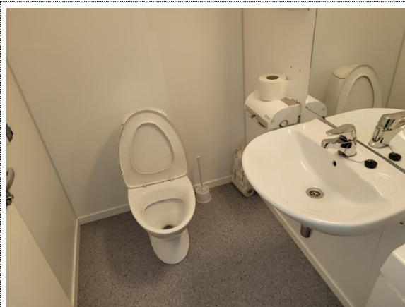
Bilde nr. 2.42 Innervegger toalett.
