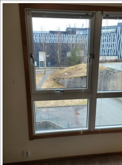
Bilde nr. 2.26 Vindu innvendig side
