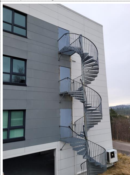
Bilde nr. 2.68 Rømningstrapp bygg H
