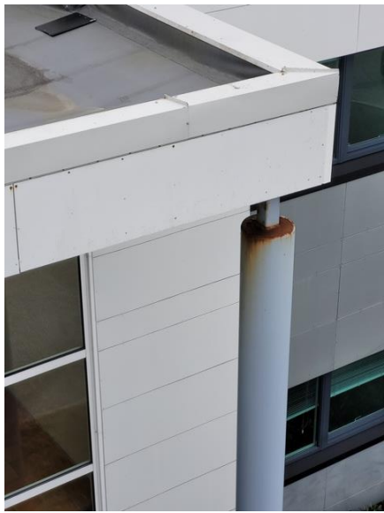
Bilde nr. 2.71 Stålstolpe for utkraget tak
