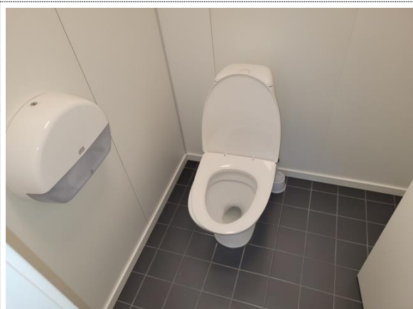
Bilde nr. 2.41 Innervegger toalett.
