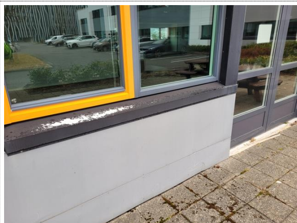
Bilde nr. 2.27 Vindu og vannbrett utvendig side
