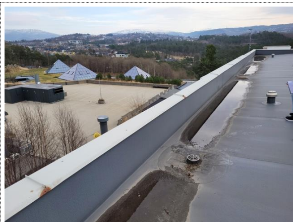
Bilde nr. 2.56 Yttertak bygg D
