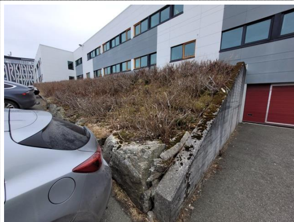
Bilde nr. 7.07 Støttemur mot fylling
