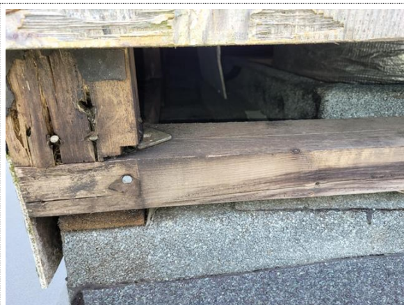
Bilde nr. 2.23 Råteskader i bindingsverk teknisk rom på tak
