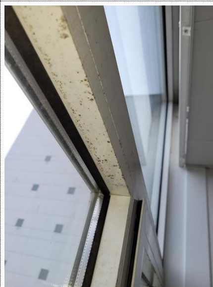
Bilde nr. 2.32 Glassfasade med muggvekst på alukarm
