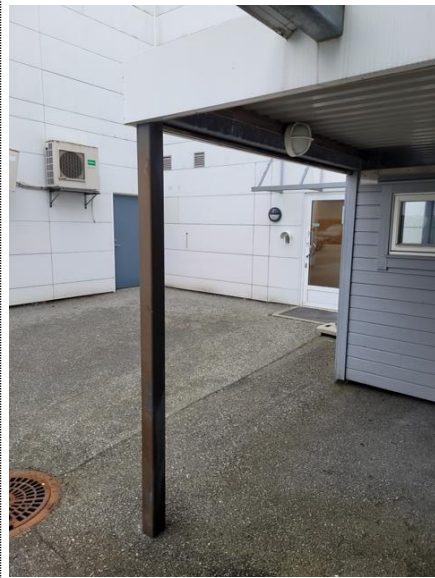
Bilde nr. 2.70 Skjermtak og tilhørende stålbering
