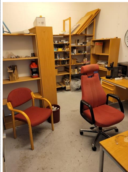
Bilde nr. 2.08 Kjellervegger i vaktmesterkontor
