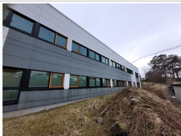
Bilde nr. 2.05 Fasade mot nord
