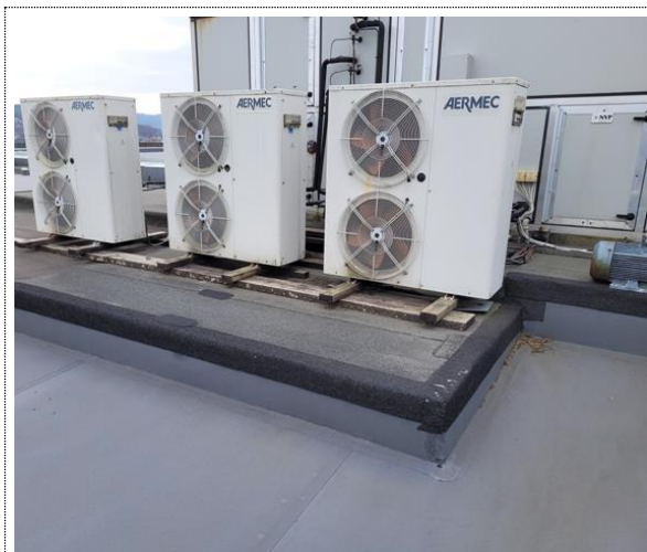
Bilde nr. 3.11 Luftbehandlingsanlegg blokk C og D
