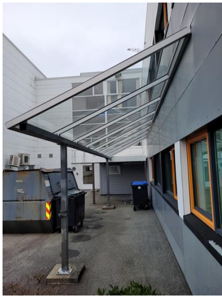
Bilde nr. 2.69 Skjermtak og tilhørende stålbering
