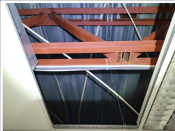
Bilde nr. 2.12 Stålbæring i underkant av Q-dekke.
