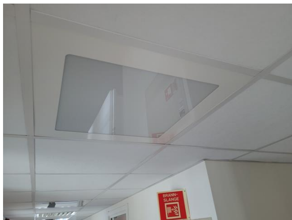
Bilde nr. 4.07 Eksempel på lysarmature
