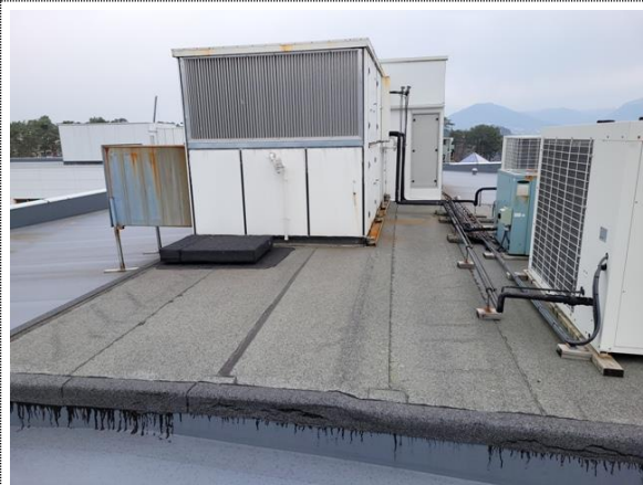
Bilde nr. 2.58 Yttertak og ventilasjonsrom på tak bygg H
