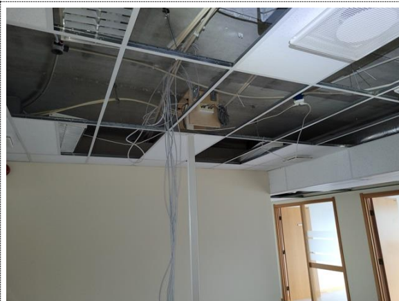
Bilde nr. 2.48 Hulldekker sett fra oversiden av teknisk himling
