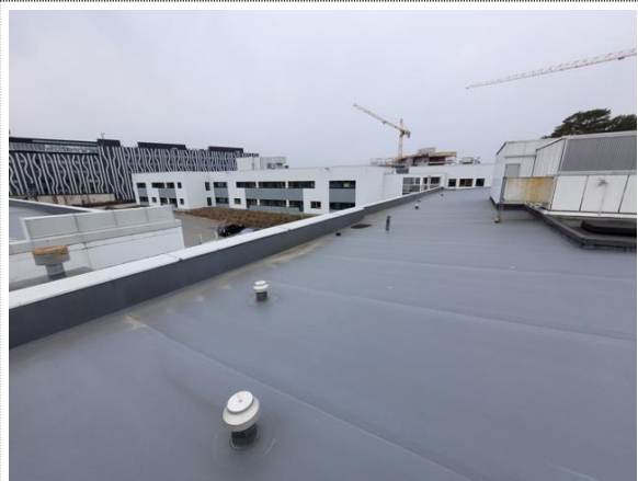
Bilde nr. 2.57 Yttertak bygg G
