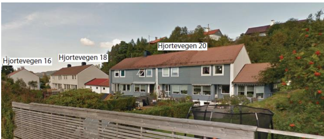
Figur 3-22 Hjortevegen 18 og 20 midt og til høyre i bilde. Lengst til venstre Hjortevegen 16. Foto: TAG arkitekter
