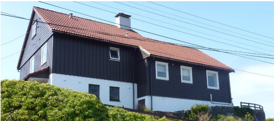
Hjortevegen 15, gnr. 40 bnr. 544. Enebolig fra 1957. Boligen har saltak, ettfagsvindu og en kombinasjon av enkel, liggende kledning og stående kledning. Foto: Multiconsult
