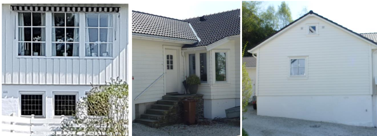
Figur 3-18 Utsnitt som viser vindu i front med sprosser og vindu i blyglass i kjelleretasje. Utsnitt av fasade i nordøst med inngangsparti og vindu med sprosser. Foto: Multiconsult
