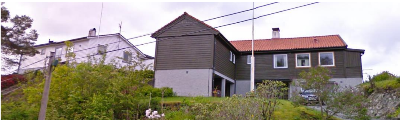
Figur 3-30 Dyrhaugen 35 gnr. 40 bnr. 747, til venstre er en enebolig fra 1964 med saltak og en utstikker med valmtak, enkel, liggende kledning og ettfagsvindu. Til høyre Dyrhaugen 33 gnr. 40 bnr. 746, enebolig fra 1964 med saltak og enkel, liggende kledning, ettfagsvindu. Foto fra https://www.google.com/maps
