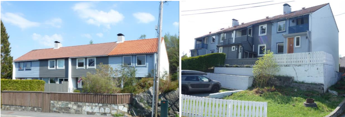
Figur 3-21 Hjortevegen 16, gnr. 40 bnr. 583 mfl. Til venstre front mot sørvest, til høyre front mot nordøst og Hjortevegen 14. Rekkehus fra 1958 i tre etasjer. Rekkehuset har saltak, enkel, liggende kledning og ettfagsvindu.
