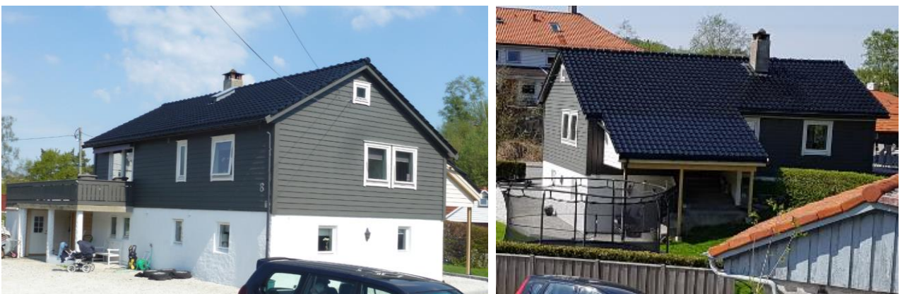
Figur 3-25 Hjortevegen 8, gnr. 40 bnr. 53. Enebolig med to etasjer fra 1957. Boligen har saltak, enkel, liggende kledning og ettfagsvindu. Foto: Multiconsult
